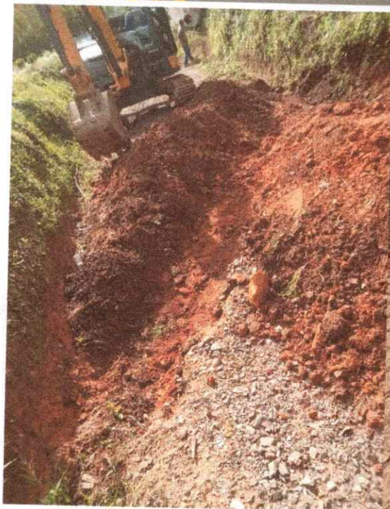
Excavación en tierra
