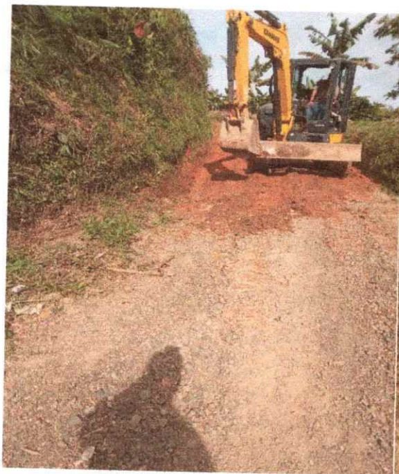
Cunetas en tierra
