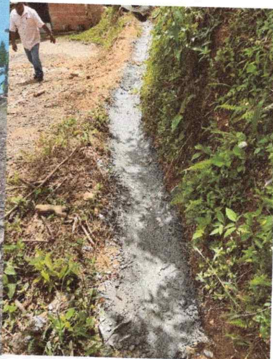
Cuneta en concreto
