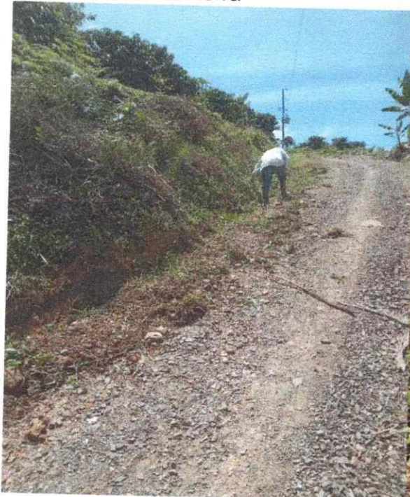
Cuneta en Tierra
