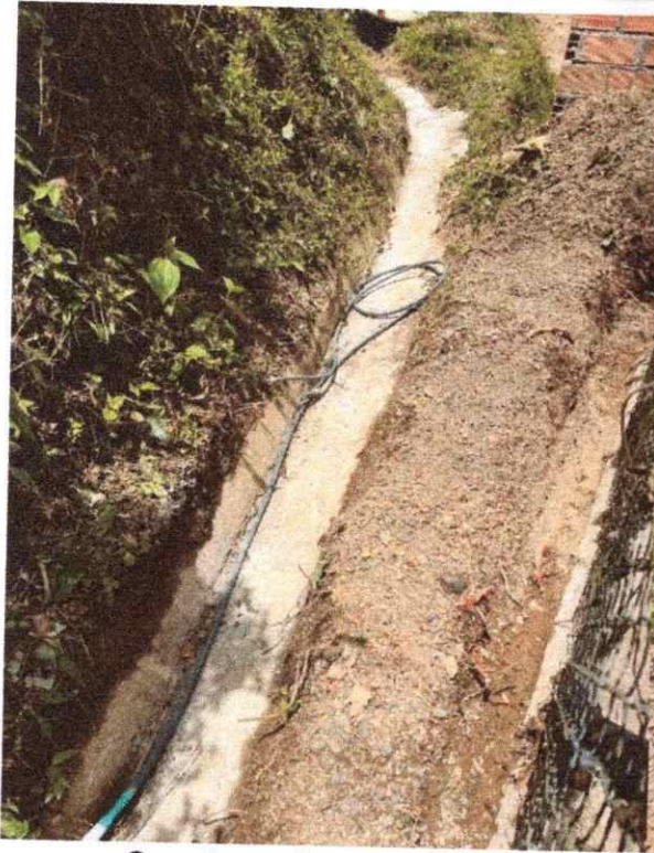
Cuneta en Concreto
