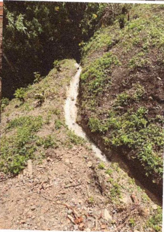
Cuneta en concreto
