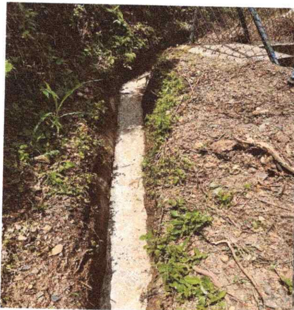
Cuneta en concreto
