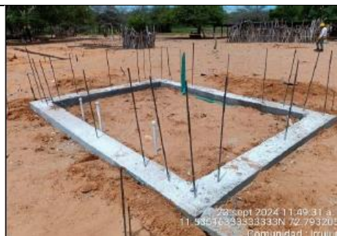
4.Caseta planta de tratamiento - Comunidad Irrujunai
