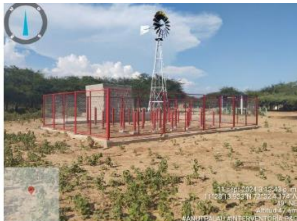
48. Seguimiento de obra. (comunidad ANUTPALAU) Vista general del cerramiento para paneles solares.
