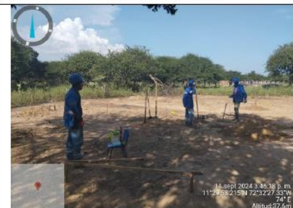
49. Seguimiento de obra. (comunidad KOUSHALAIN) Inicio de trazado y excavaciones del cerramiento para paneles solares.
