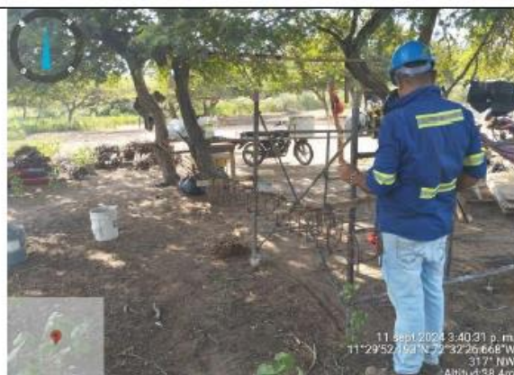
50. Seguimiento de obra. (comunidad KOUSHALAIN) Armado acero de refuerzo de vigas de cimentación del cerramiento.
