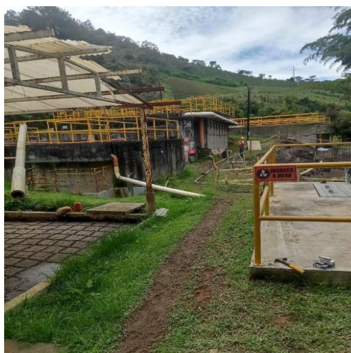
Fotografía 22. instalación de señalización
