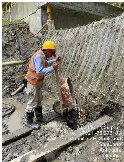
Fotografía 6. Vaciado de concreto de 21 Mpa para construcción de pilotes de 30 cms de diámetro.
