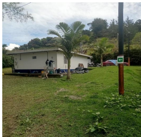
Fotografía 24. Instalación de señalización
