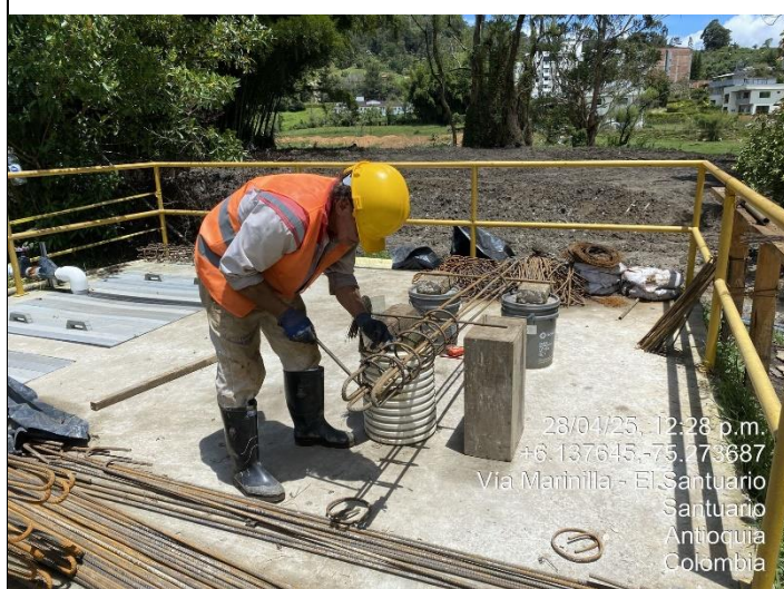
Fotografía 2. Armado y figuración de acero de refuerzo para pilotes.
