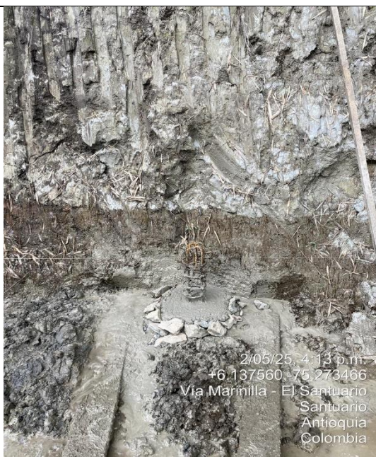
Fotografía 8. Construcción de pilotes E5 de tanque 1 con acero de refuerzo.
