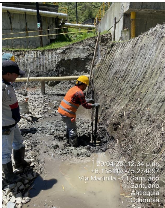
Fotografía 5. Excavación Manual de pilotes de 30 cms de diámetro y dos metros de profundidad según diseños estructurales.
