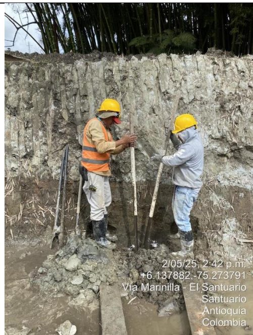
Fotografía 4. Excavación Manual de pilotes de 30 cms de diámetro y dos metros de profundidad según diseños estructurales. Pilote E4 de tanque 1.
