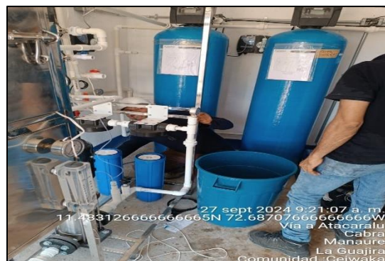
Ilustración 17. Equipo de osmosis - Comunidad Ceiwaca Fuente: Elaboración propia.
