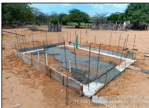
Ilustración 34. Solado de losa contrapiso para caseta - Comunidad Irrujunai
