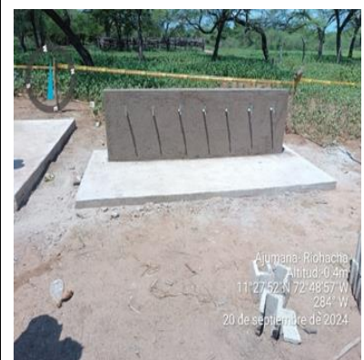
24. Comunidad Ajumana: Construcción de punto de suministro para agua tratada
