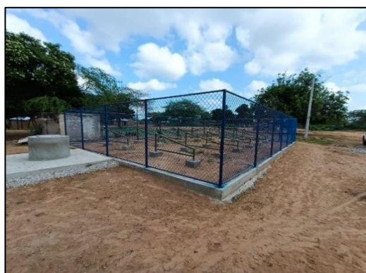
Ilustración 19: Cerramiento para paneles - Comunidad Ceiwaca Fuente: Elaboración propia.
