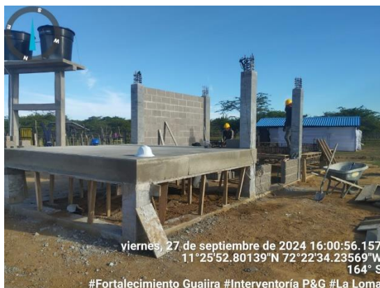
67. Se funde placa de tanques Esp. 12 cm y viga aérea 20x30 concreto de 3000 PSI CASETA comunidad La Loma .
