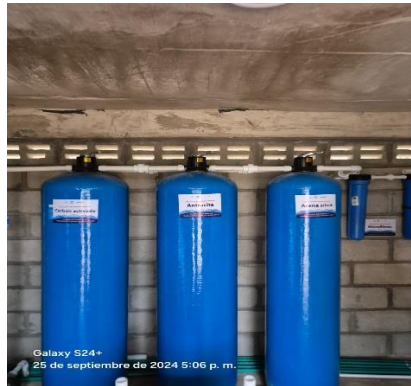
20.Comunidad de Ketpana: instalación de tanques de filtración.
