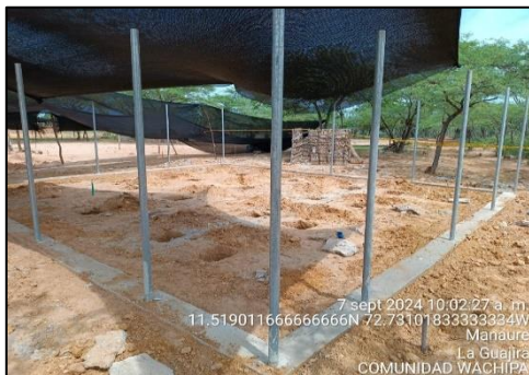
Ilustración 35. Cerramiento para paneles - Comunidad Wachipa.
