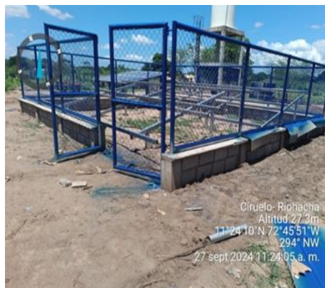
23.Comunidad Ciruelo I: Construcción para zapatas y viga de cimentación en el cerramiento.
