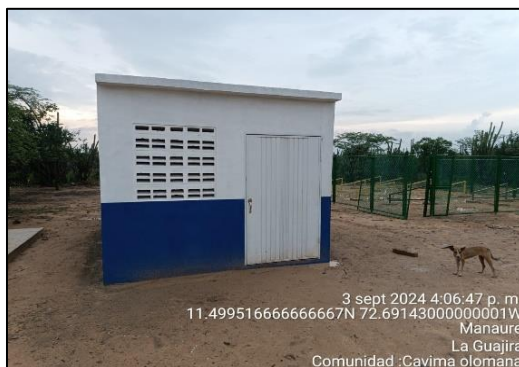
Ilustración 15. Caseta planta de tratamiento- Comunidad Cavima olomana Fuente: Elaboración propia.
