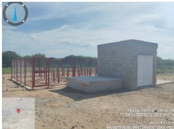
47. Seguimiento de obra. (comunidad ANUTPALAU) Vista general de la caseta y las placas de los tanques.
