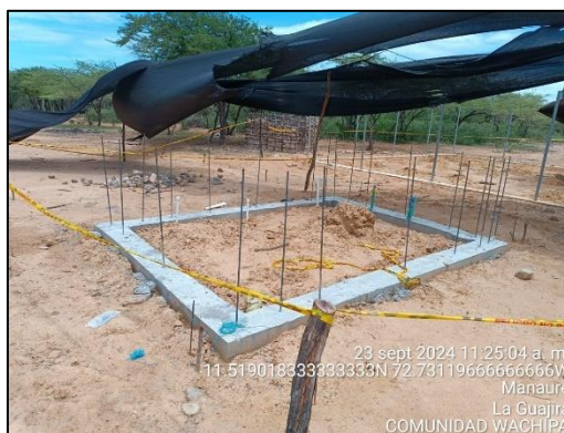
Ilustración 39. Viga de cimentación caseta- Comunidad Wachipa.
