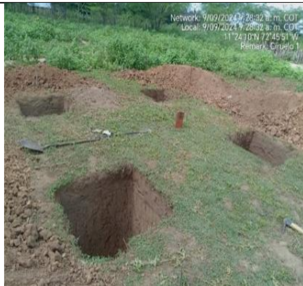
22.Comunidad Ciruelo I: Excavación de zapatas para caseta.
