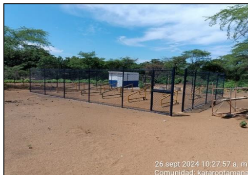
Ilustración 11. Cerramiento para paneles - Comunidad Kararoptamana Fuente: Elaboración propia.
