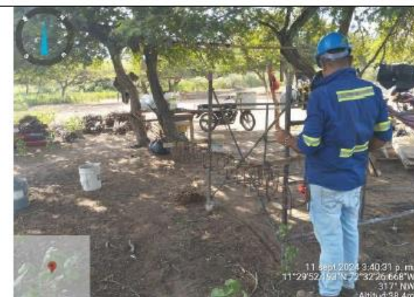
50. Seguimiento de obra. (comunidad KOUSHALAIN) Armado acero de refuerzo de vigas de cimentación del cerramiento.
