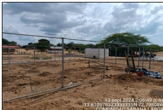
Ilustración 26. Estructura para paneles - Comunidad Sabana larga Fuente: Elaboración propia.
