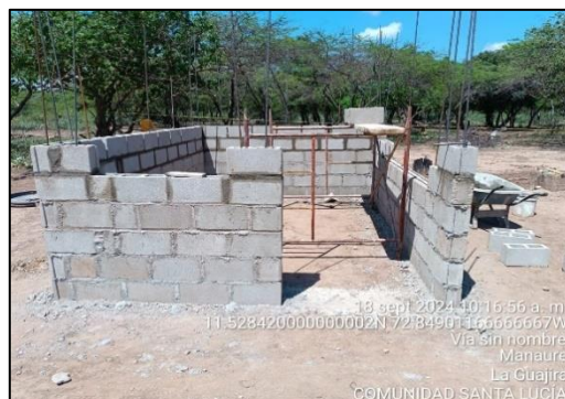
Ilustración 31. Mampostería caseta - Comunidad Santa Lucia
