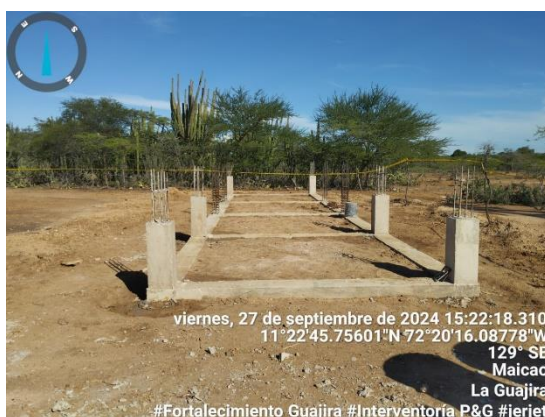
67. Se funde placa de tanques Esp. 12 cm y viga aérea 20x30 concreto de 3000 PSI CASETA comunidad La Loma .
