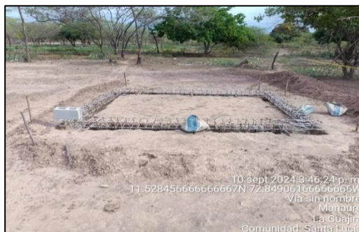
Ilustración 30. Viga de cimentación caseta - Comunidad Santa Lucia
