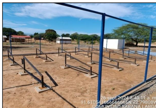
Ilustración 27. Estructura para paneles - Comunidad Sabana larga Fuente: Elaboración propia.
