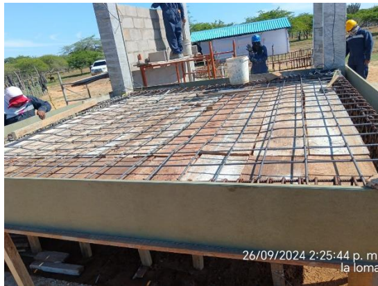
65. Instalación de acero para placa de tanques Esp. 12 cm comunidad La Loma .
