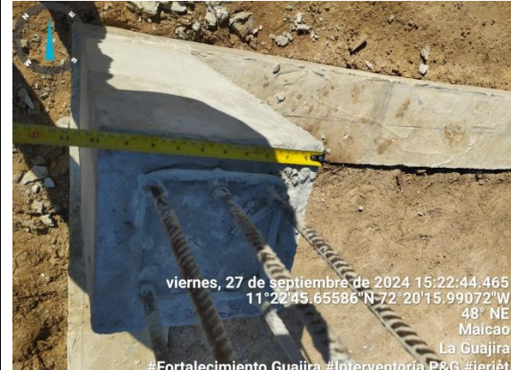
68. Se verifican dimensiones de viga aérea y placa de CASETA comunidad La Loma .
