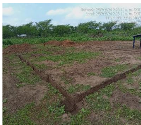
23.Comunidad Ciruelo I: Construcción para zapatas y viga de cimentación en el cerramiento.
