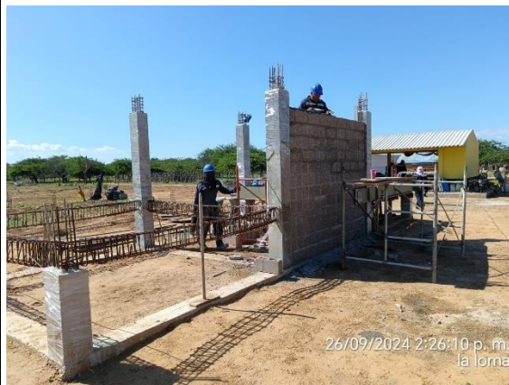
66. Levantamiento de muros de mampostería en bloque abujardado CASETA comunidad La Loma .
