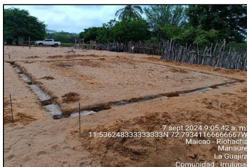
Ilustración 32. Cerramiento para paneles - Comunidad Irrujunai
