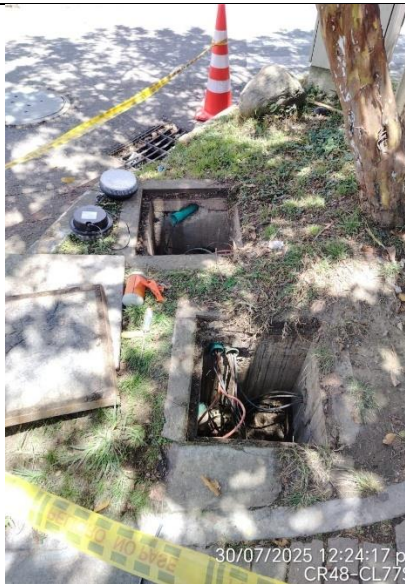
Instalación cable acometida a través de canalizaciones
