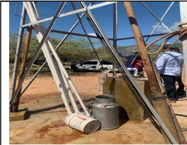
Foto 3: 30/11/23 (Wososopo), trabajos de actividades técnicas para el diagnóstico de las infraestructuras
