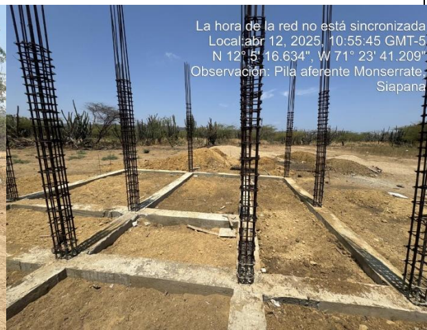
Fotografía 4. Armado de acero de refuerzo para columnas.
