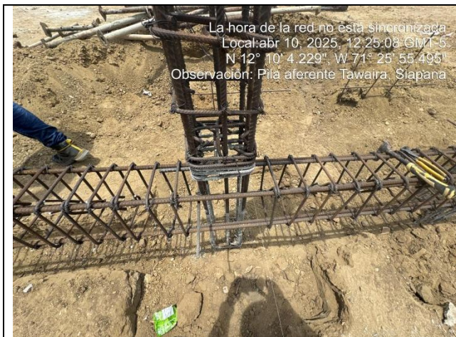
Fotografía 3. Armado de acero de refuerzo para vigas de cimentación y columnas..
