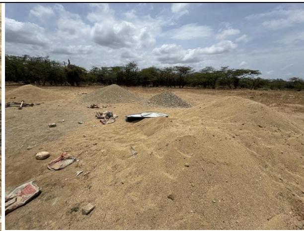
Fotografía 4. Acopio de materiales.
