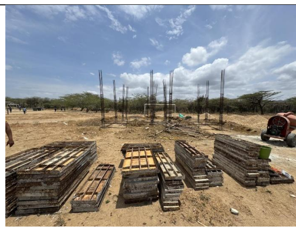
Fotografía 2. Acopio de formaletas para vigas y columnas.
