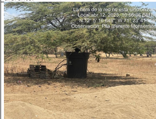
Fotografía 3. Acopio de materiales.
