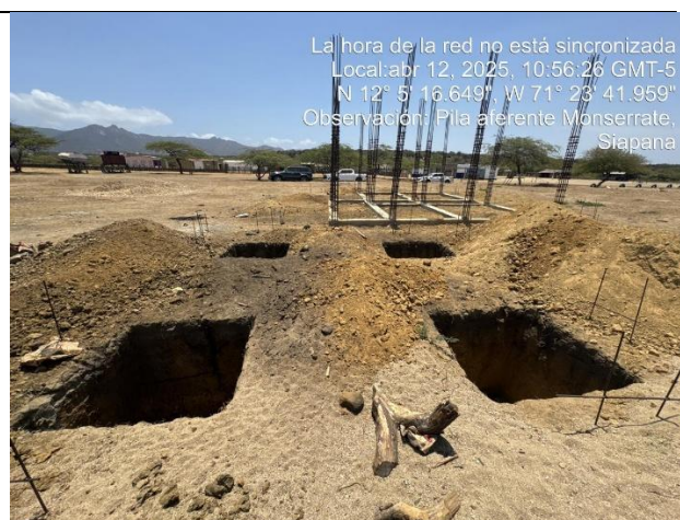
Fotografía 2. Excavación de zapatas.
