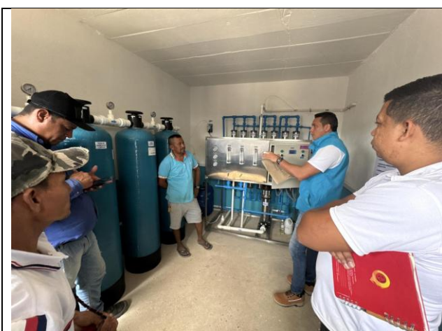
Fotografía 1. Capacitación técnica del sistema de osmosis inversa.
