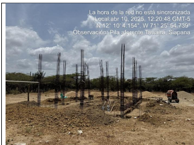
Fotografía 1. Estado de construcción de pila aferente.
