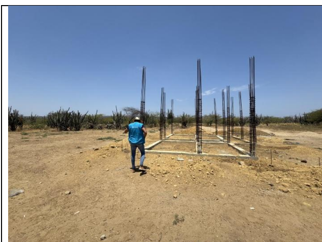
Fotografía 1. Estado de construcción de pila aferente.
