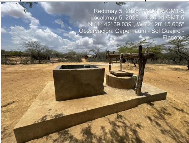
Fotografía 6. Sistema de captación de la comunidad de Capernaum.
