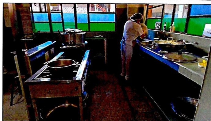
FOTOGRAFÍA No. 2 EDIFICACIONES E INSTALACIONES
