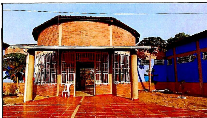
FOTOGRAFÍA No. 1 EDIFICACIONES E INSTALACIONES
