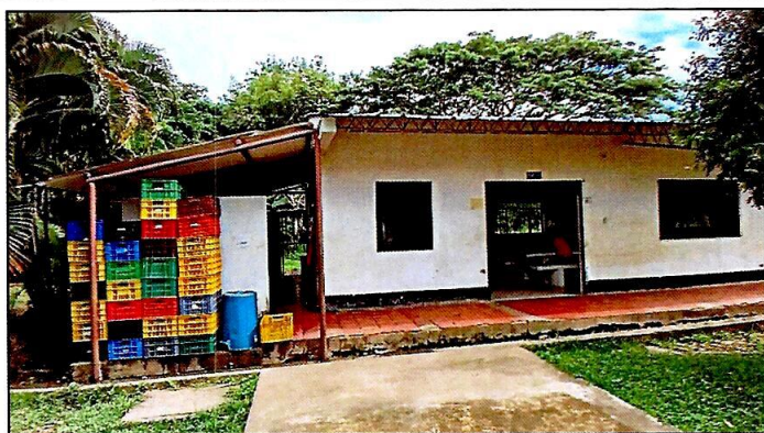
FOTOGRAFÍA No. 1 EDIFICACIONES E INSTALACIONES
