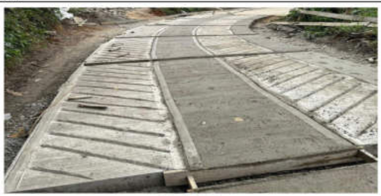
CONSTRUCCIÓN POR FASE
