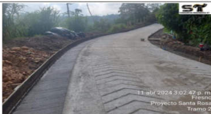
Construcción de plaza huella K0+425 y K0+464.
