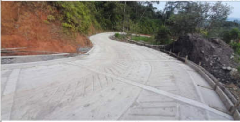
CONSTRUCCIÓN POR FASE
