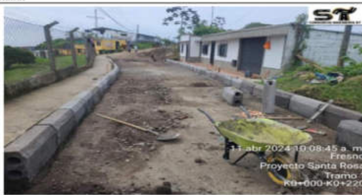
Instalación de bordillos prefabricados laterales para pavimento rígido tramo 1 K0+220 y K0+190.
