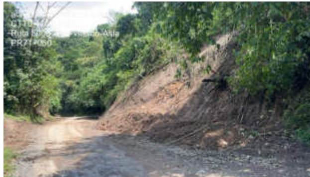
Figura 3 Derrumbe PR71+050
