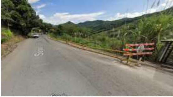
Imagen 2. Lugar de ejecución muro de contención PR54+850
