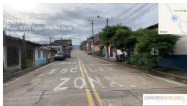
Figura 11 Pintura realizada por el contratista de obra PR75+050
