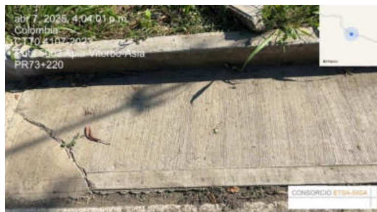
Figura 3 Cuneta fracturada
