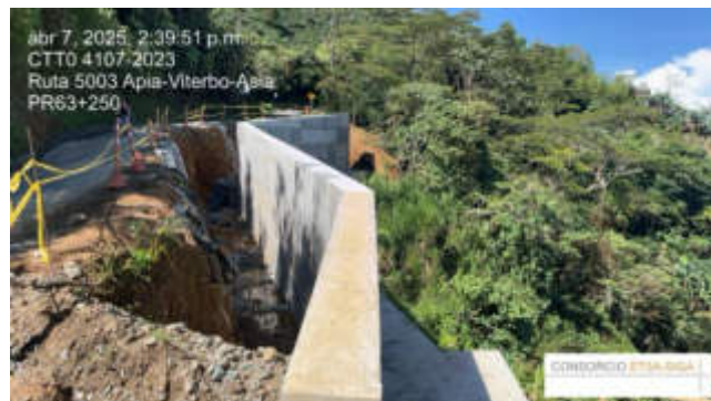
Figura 4 Frente muro de contención actualmente PR63+250
