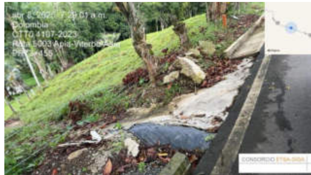
Figura 7 Disipador pendiente Sector Los Rosales PR73+455
