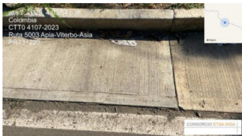
Figura 2 Cuneta fisurada
