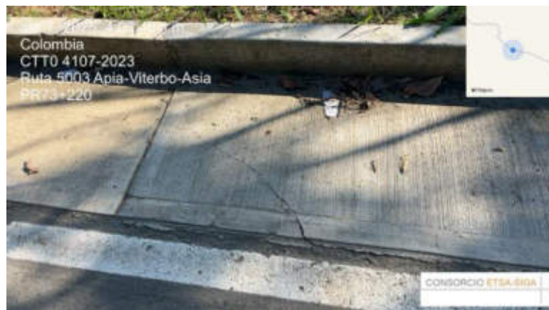
Figura 1 Cuneta fracturada
