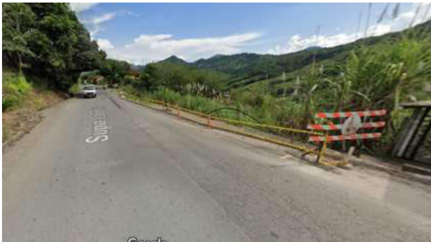
Imagen 2. Lugar de ejecución muro de contención PR54+850
