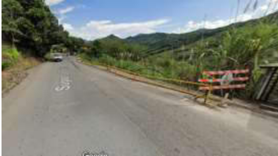
Imagen 2. Lugar de ejecución muro de contención PR54+850
