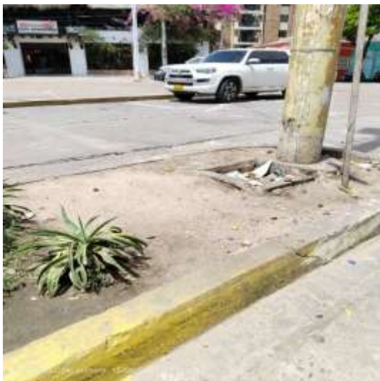
Foto 5: Zona afectada por la presencia de residuos sólidos en los separadores.
