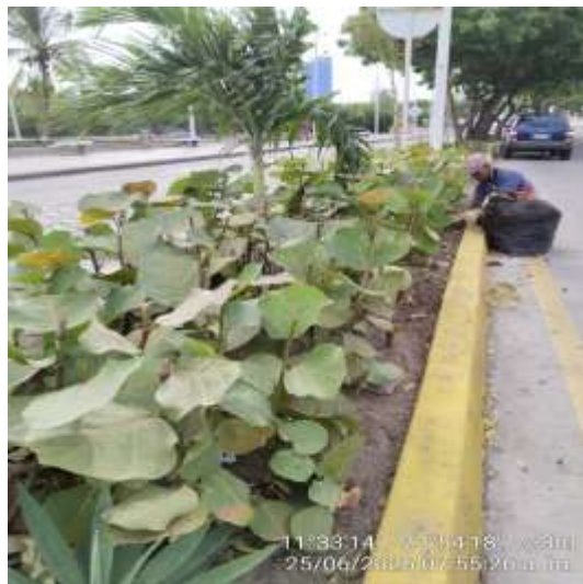
Foto 16: Trabajos de mantenimiento de las jardineras (limpieza y deshierbe).
