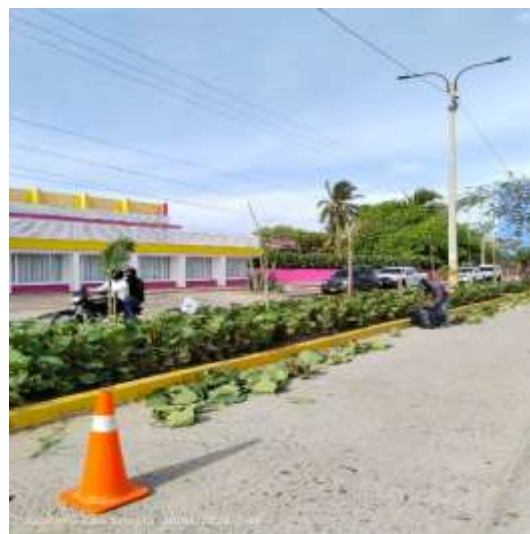
Foto 14: Medidas de seguridad en la realización de los trabajos de mantenimiento de las jardineras
