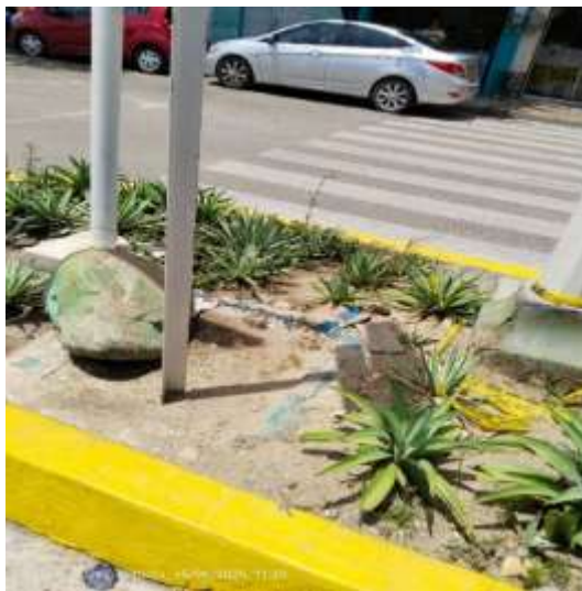
Foto 6: Presencia de residuos sólidos en los separadores.
