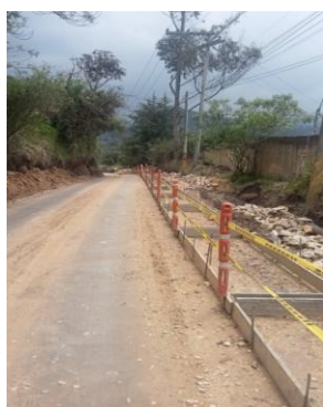
Ilustración 8. Encofrado para construcción concreto ciclópeo.
