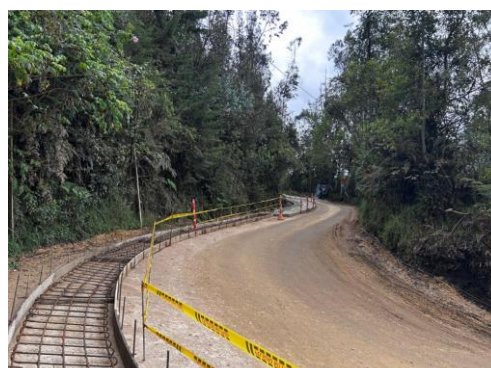
Ilustración 11. Encofrado y colocación de acero para concreto reforzado.
