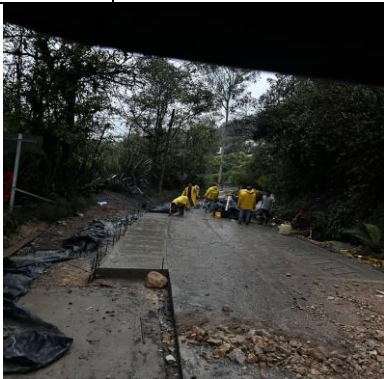
Ilustración 19. Cubriendo los materiales en obra por las constantes lluvias.
