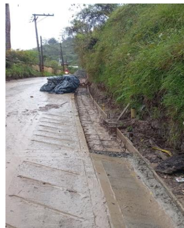
Ilustración 18. Encofrado y armado de acero cuneta
