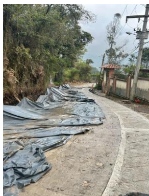
Ilustración 19. Cubriendo los materiales en obra por las constantes lluvias.
