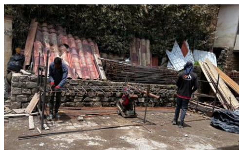
Ilustración 12. Figurado y armado de acero de refuerzo
