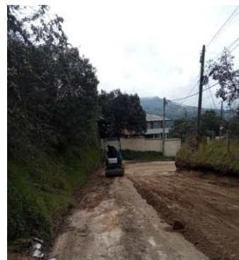
Ilustración 6. Compactación del terreno
