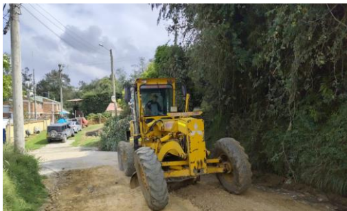
Ilustración 3. Conformación del tramo.
