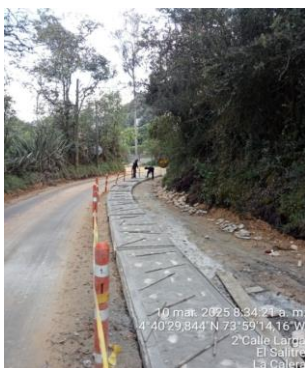
Ilustración 9. Construcción de concreto ciclópeo.
