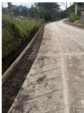
Ilustración 14. Armado de cunetas.
