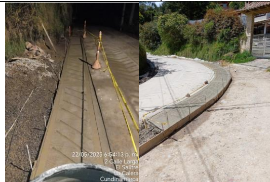
Ilustración 16. Construcción concreto reforzado
