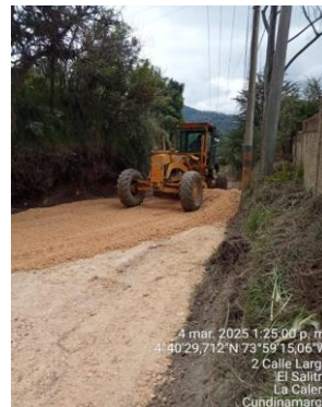
Ilustración 5. Conformación y afirmado.
