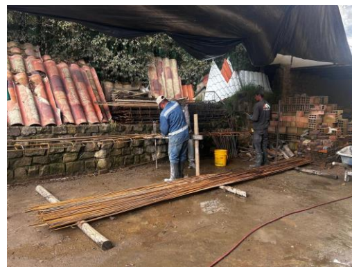
Ilustración 17. Suministro y figurado de acero de refuerzo.
