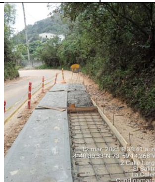
Ilustración 10. Construcción de concreto reforzado
