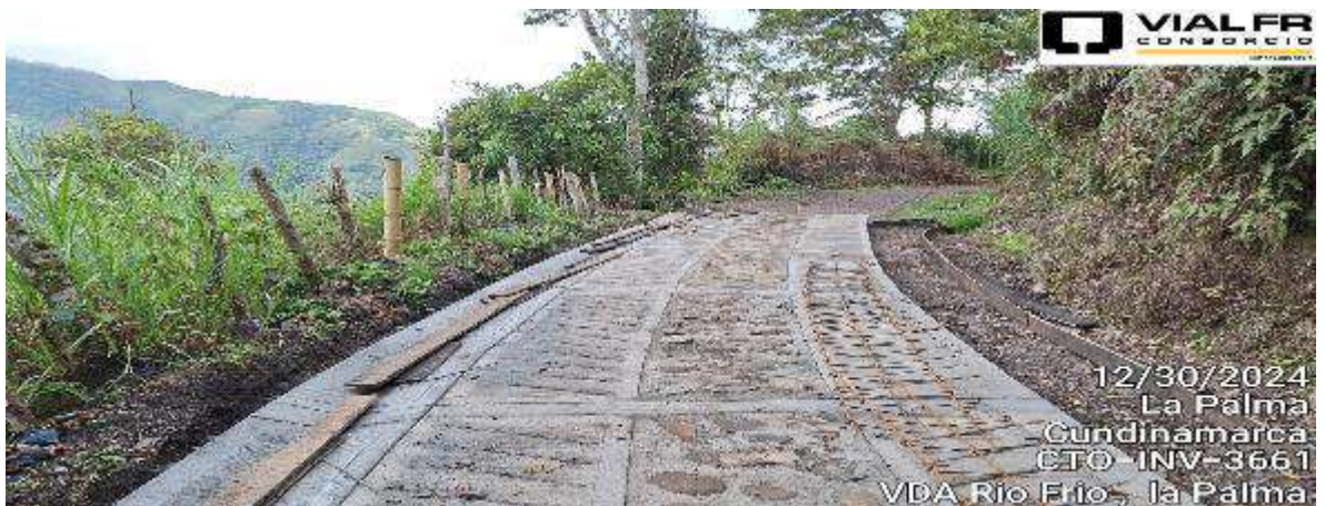
AVANCE DE OBRA
