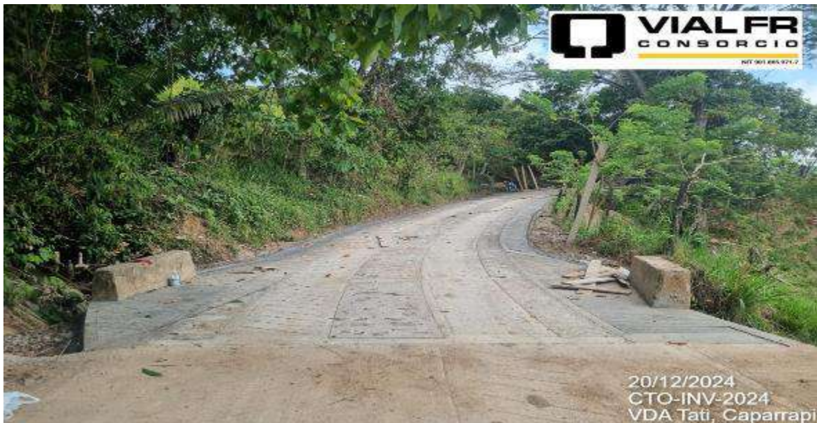
AVANCE DE OBRA
