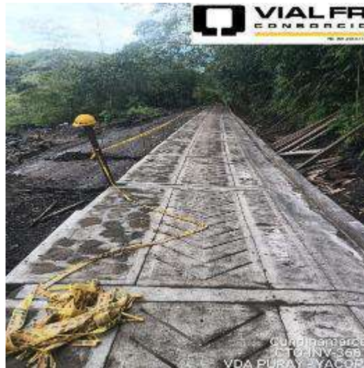
AVANCE DE OBRA
