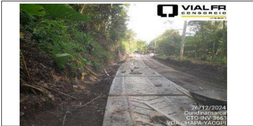
AVANCE DE OBRA
