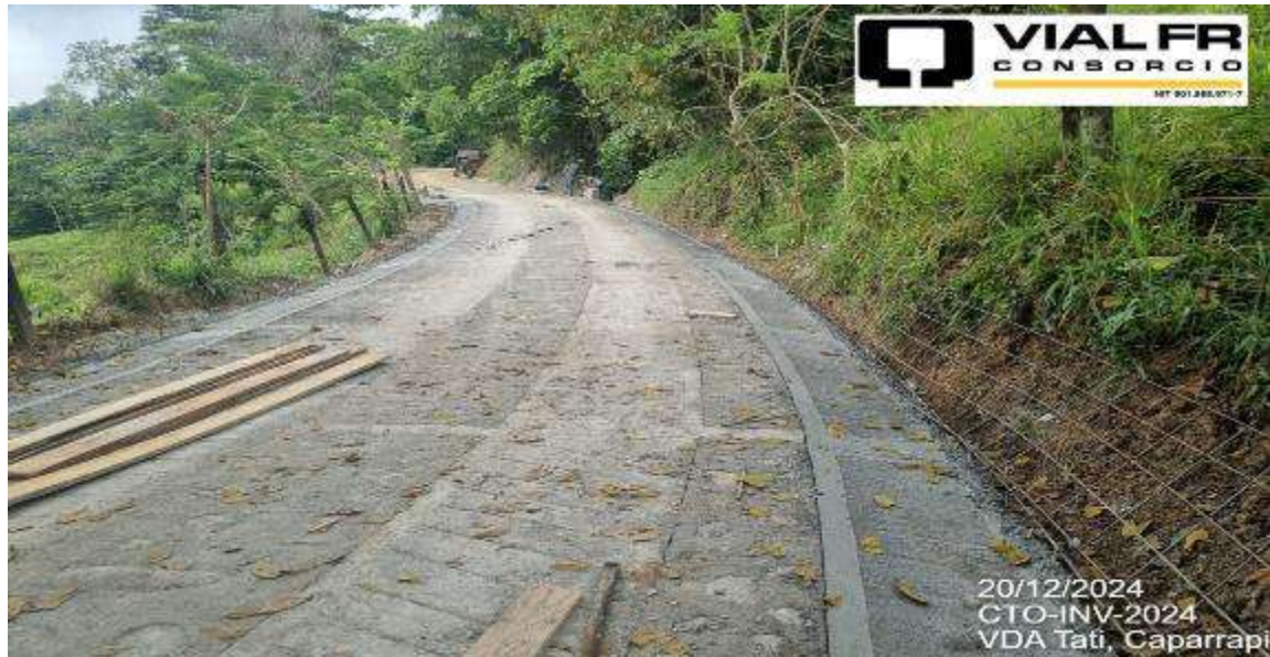
AVANCE DE OBRA
