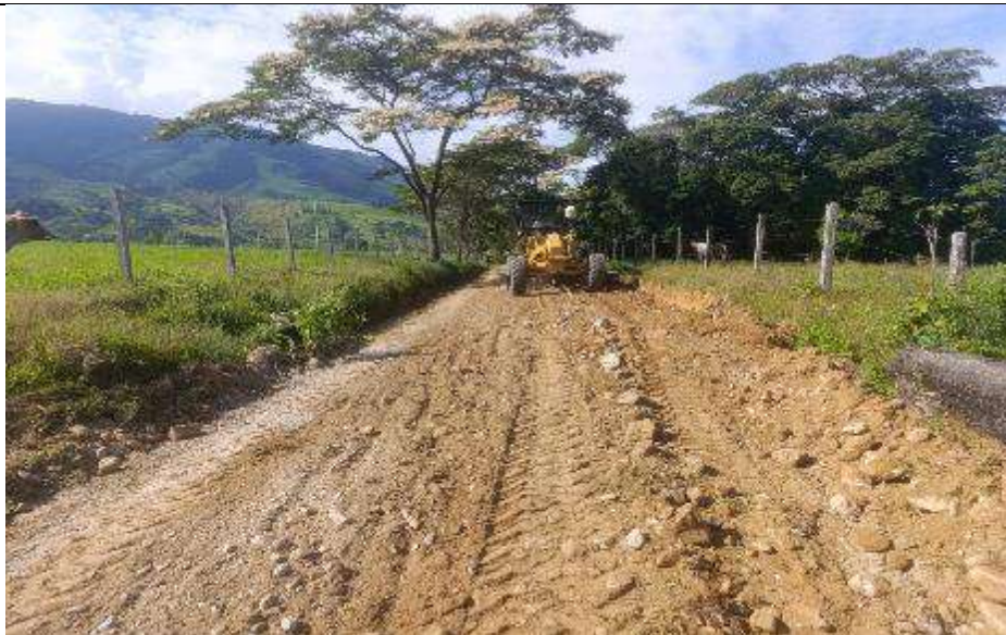
NIVELACIÓN Y CONFORMACIÓN DE CALZADA.
