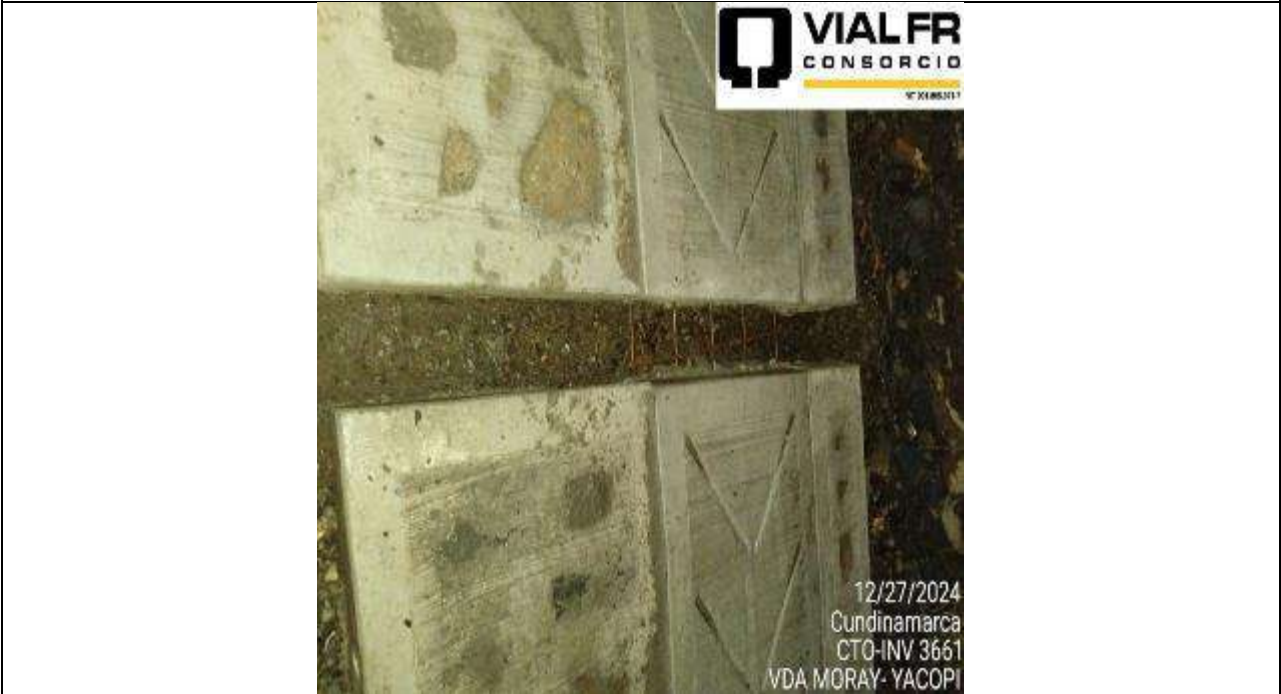
EXCAVACION DE VIGA RIOSTRA
