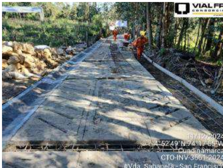
Avance general de obra con corte al 11-dic. Vda Sabaneta, San Francisco
