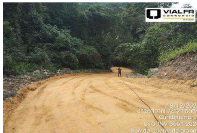
Avance general de obra con corte al 18-dic. Vda Quebrada Grande, San Antonio del Tequendama
