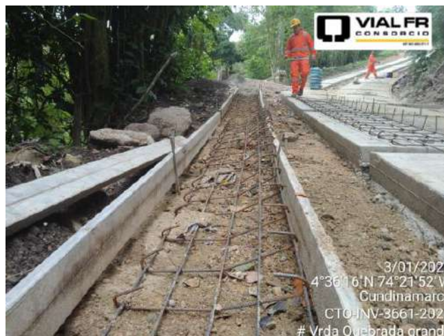
Avance general de obra con corte al 30-dic. Vda Quebrada Grande, San Antonio del Tequendama
