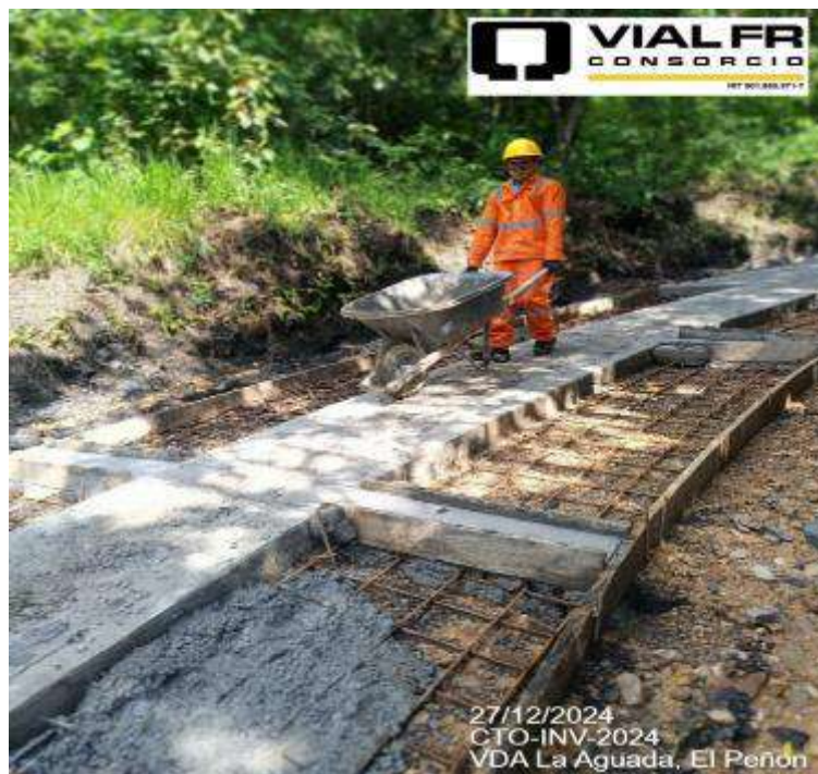
CONCRETO PARA HUELLAS
