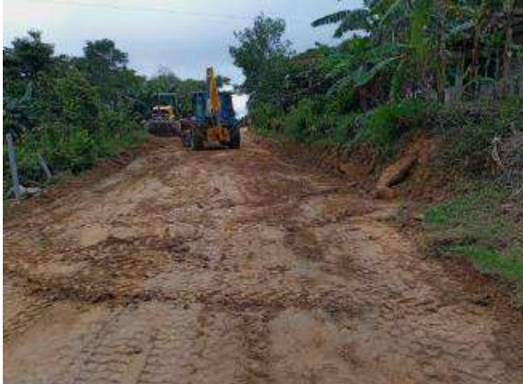
Extensión, conformación y compactación del terreno del tramo a intervenir. Vda Pulisito, Pulí
