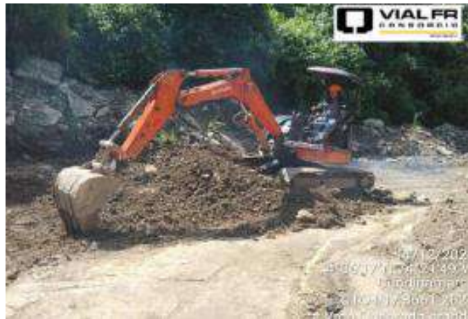
Avance general de obra con corte al 11-dic. Vda Quebrada Grande, San Antonio del Tequendama
