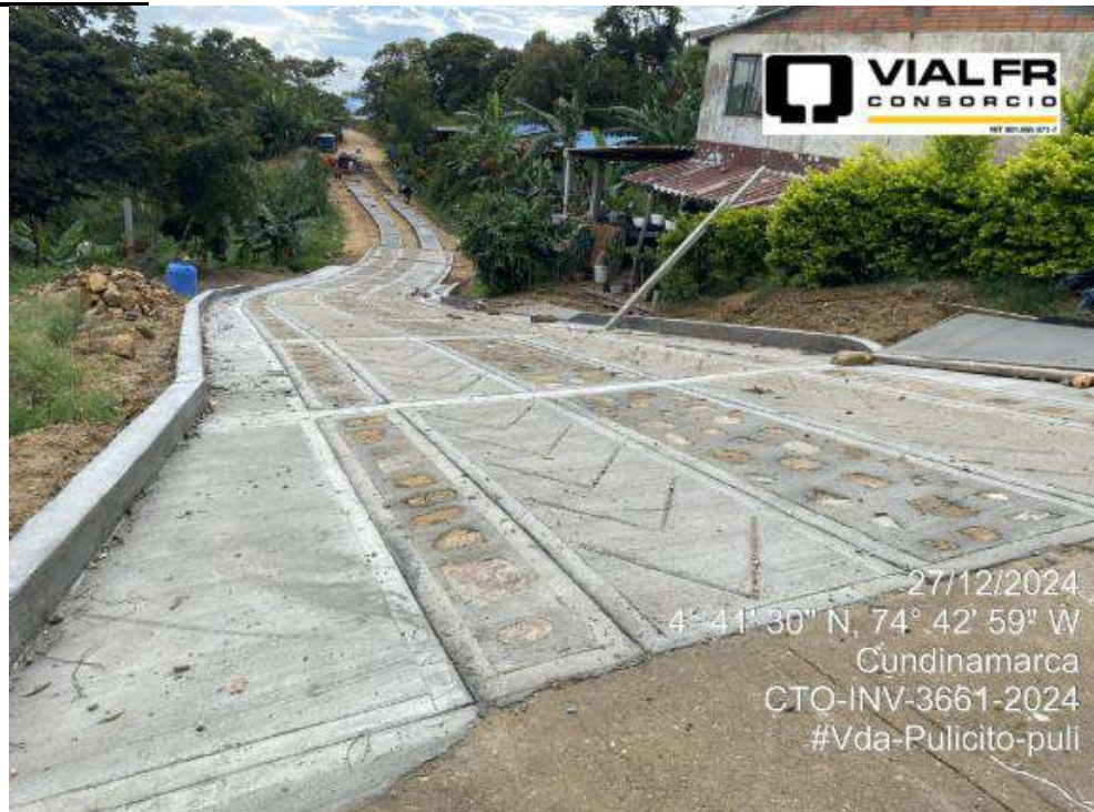
Estado actual del tramo a intervenir. Vda Pulisito, Pulí
