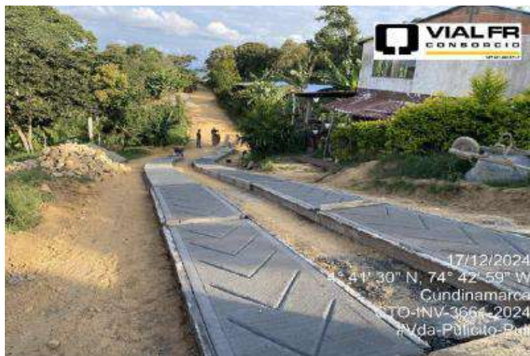
Avance general de obra con corte al 17-dic. Vda Pulisito, Pulí
