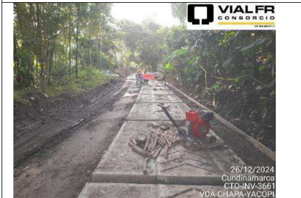
CONSTRUCCION DE PLACA HUELLA A MEDIA CALZADA
