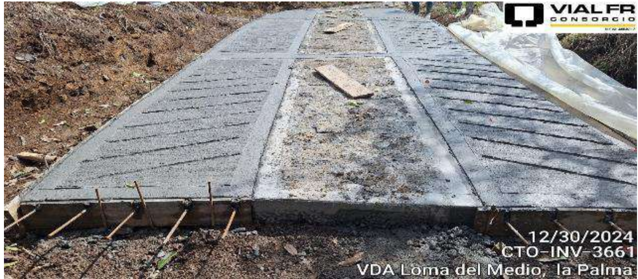
AVANCE DE OBRA
