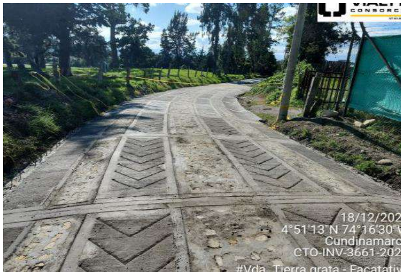
Avance general de obra con corte al 18-dic. Vda Tierra Grata, Facatativá
