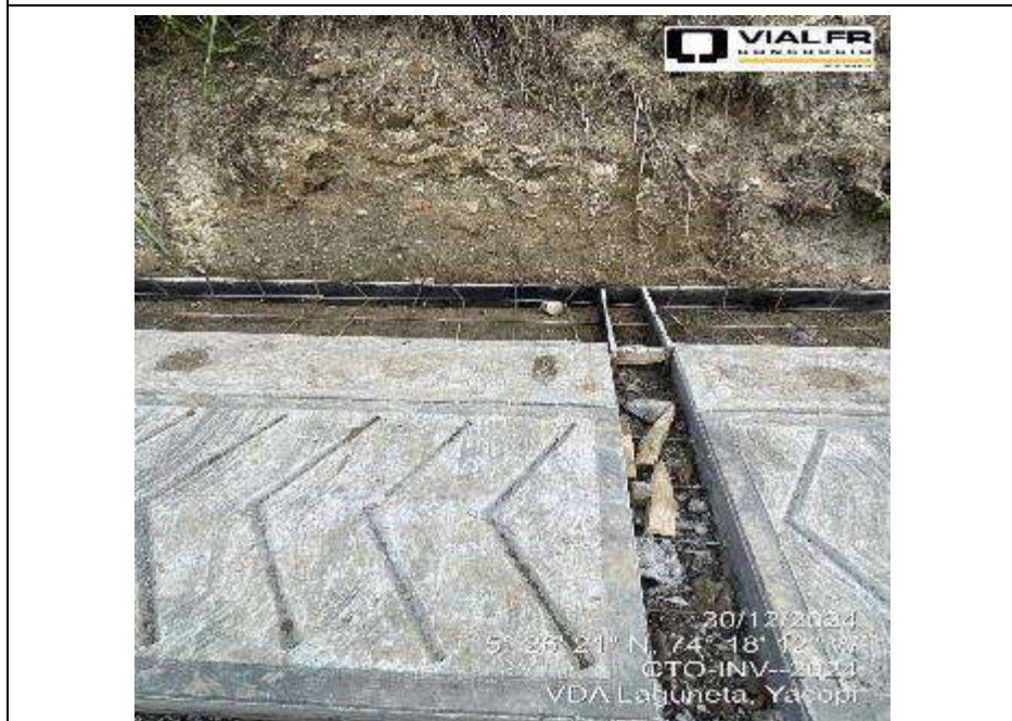
EXCAVACION PARA VIGA RIOSTRA
