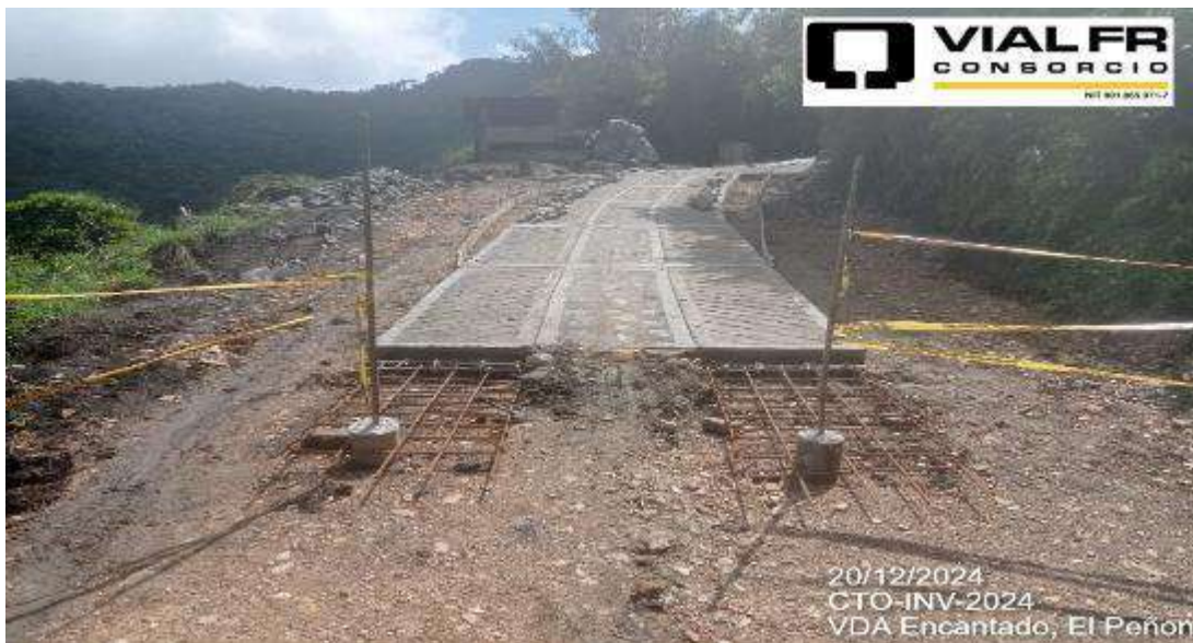
AVANCE DE OBRA
