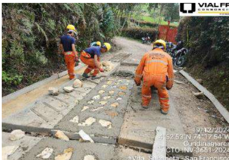
Avance general de obra con corte al 20-dic. Vda Sabaneta, San Francisco
