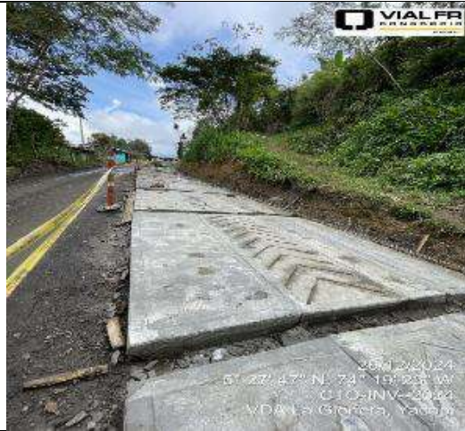
AVANCE DE OBRA
