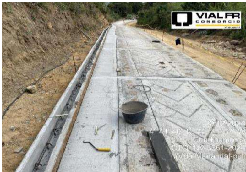
Avance general de obra con corte al 22-dic. Vda Manantial, Pulí
