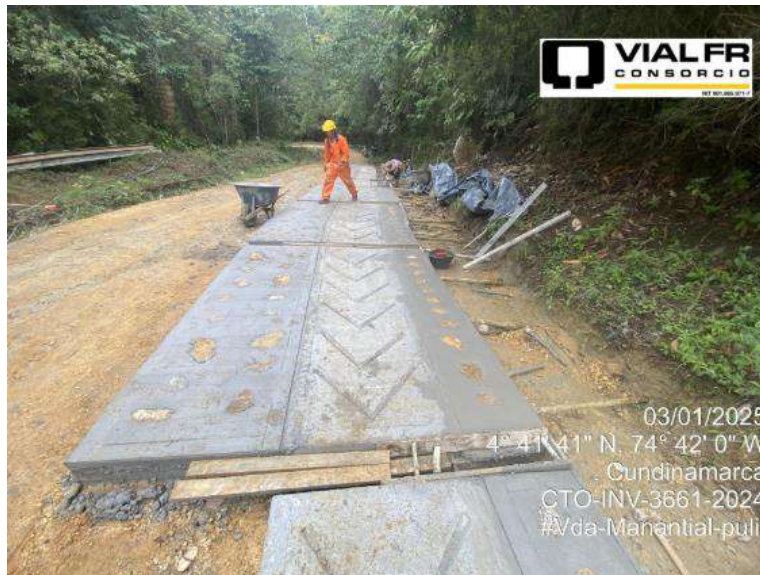
Avance general de obra con corte al 30-dic. Vda Manantial, Pulí
