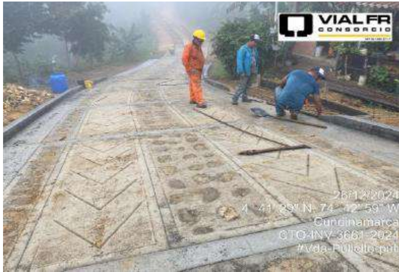
Avance general de obra con corte al 26-dic. Vda Pulisito, Pulí
