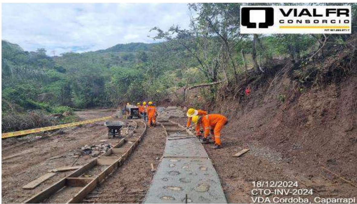
CONSTRUCCION DE CENTROS CICLOPEOS
