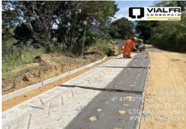
Avance general de obra con corte al 18-dic. Vda Manantial, Pulí
