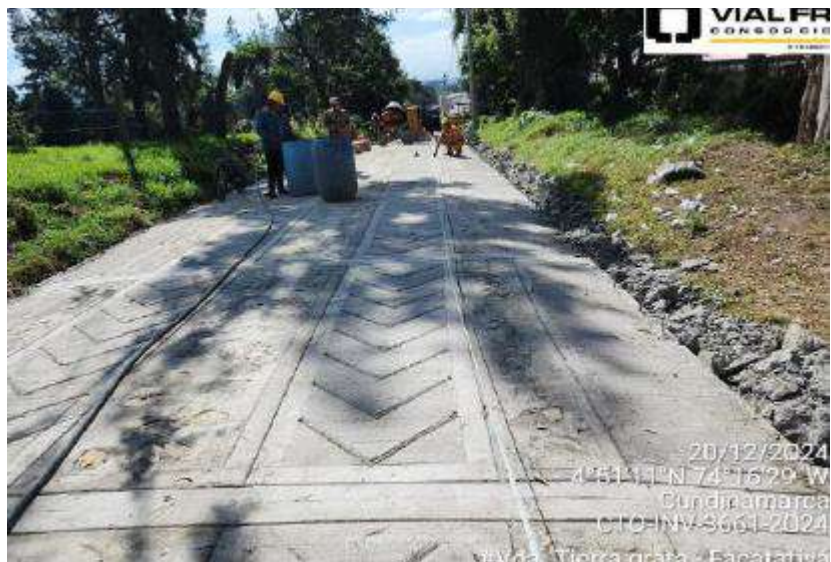
Avance general de obra con corte al 20-dic. Vda Tierra Grata, Facatativá
