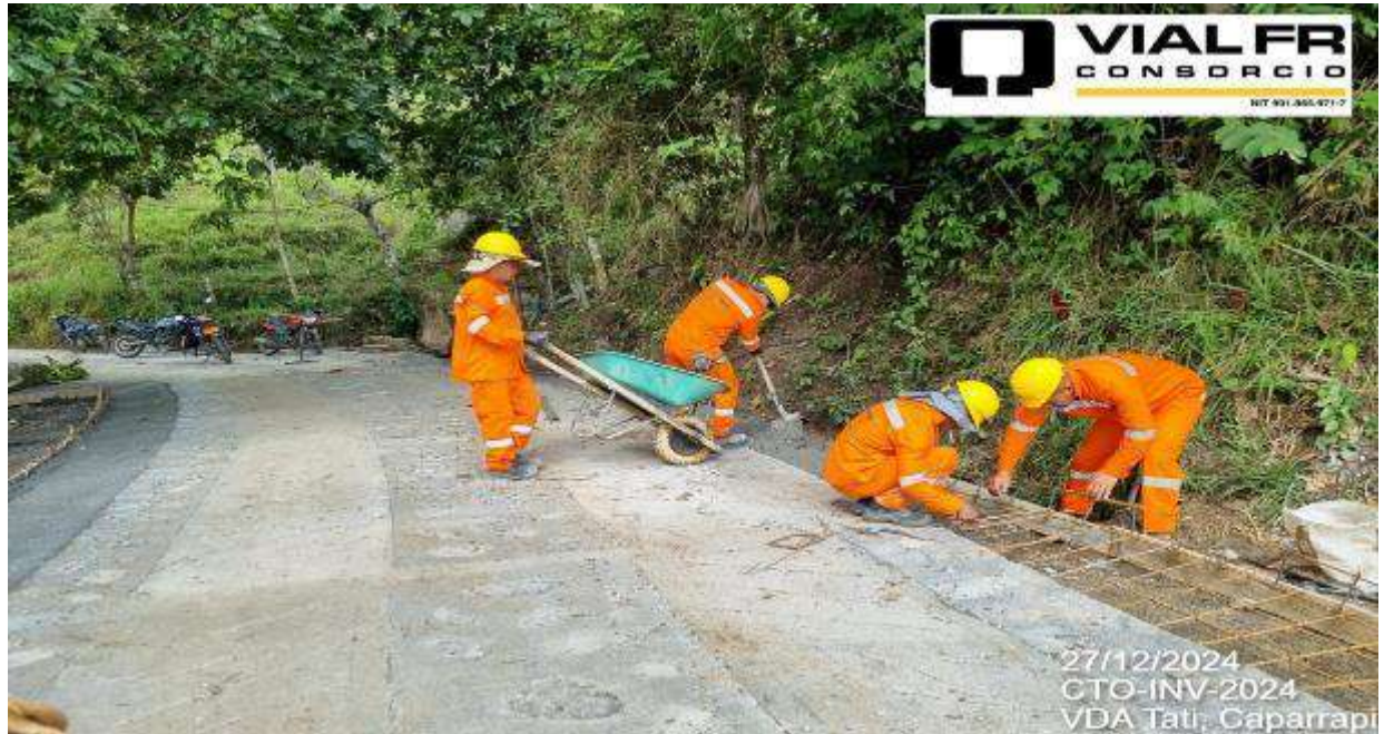
ARMADO DE HIERRO EN CUNETA
