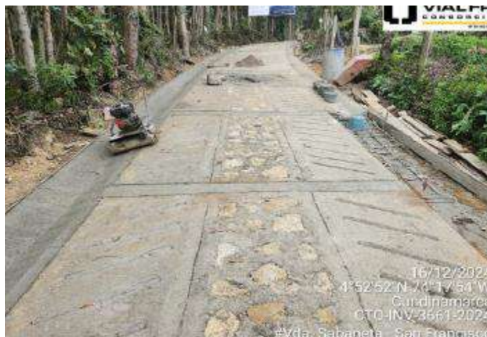
Avance general de obra con corte al 17-dic. Vda Sabaneta, San Francisco
