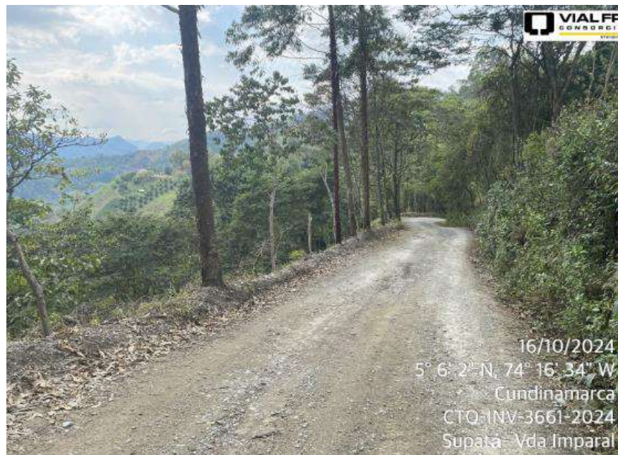
Estado inicial del tramo a intervenir. Vda El Imparal, Supatá
