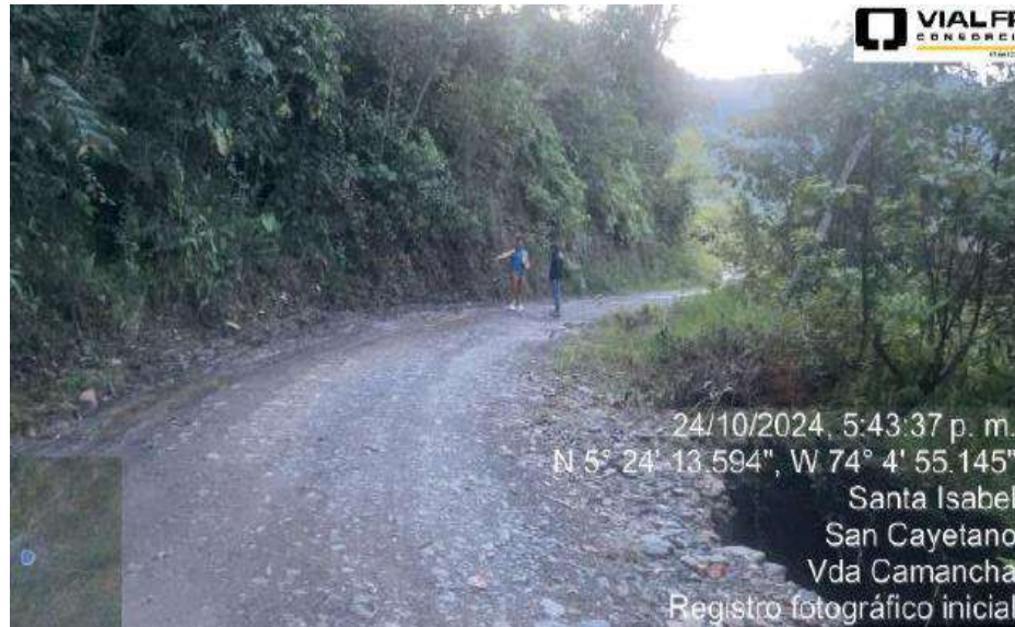
Estado inicial del tramo a intervenir. Vda Camancha, San Cayetano
