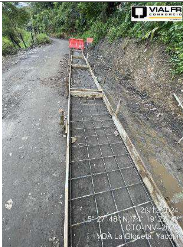
FORMALETA DE HUELLAS EN CONCRETO ESTRUCTURAL
