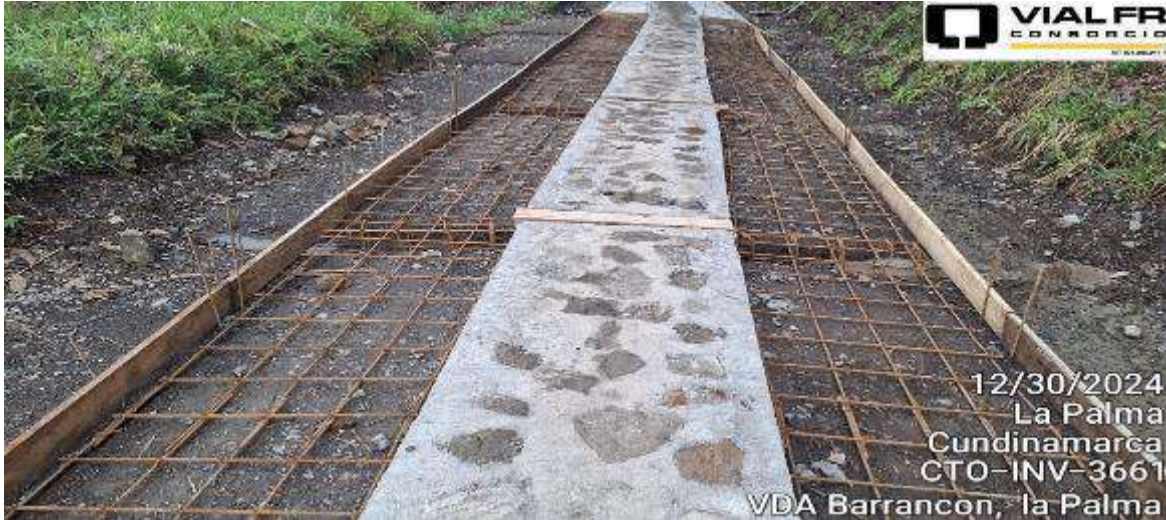
HIERRO PARA HUELLAS DE CONCRETO REFORZADO
