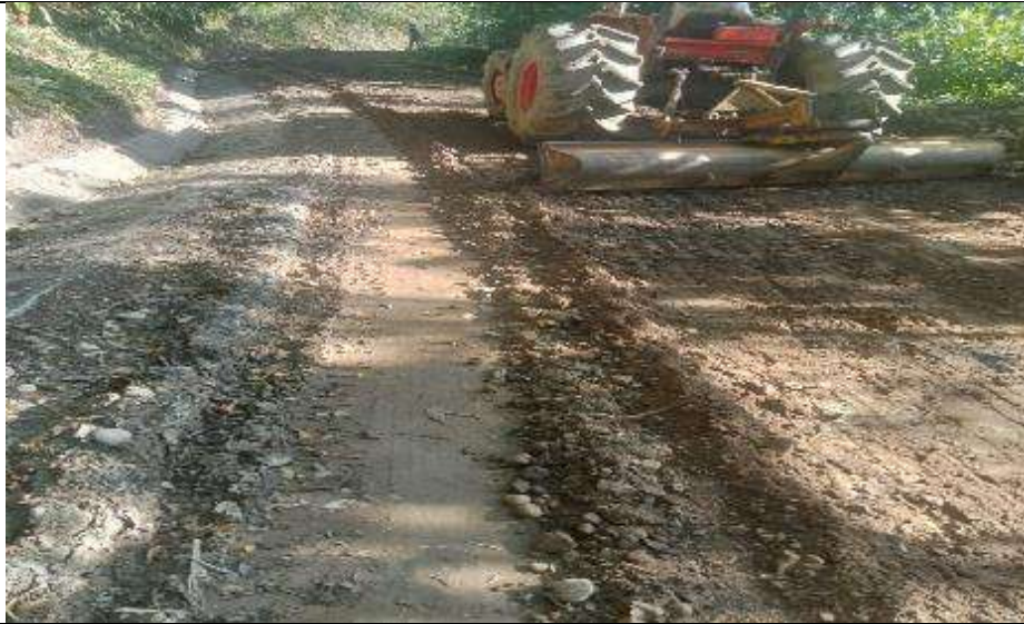
INSTALACIÓN DE SUBBASE GRANULAR
