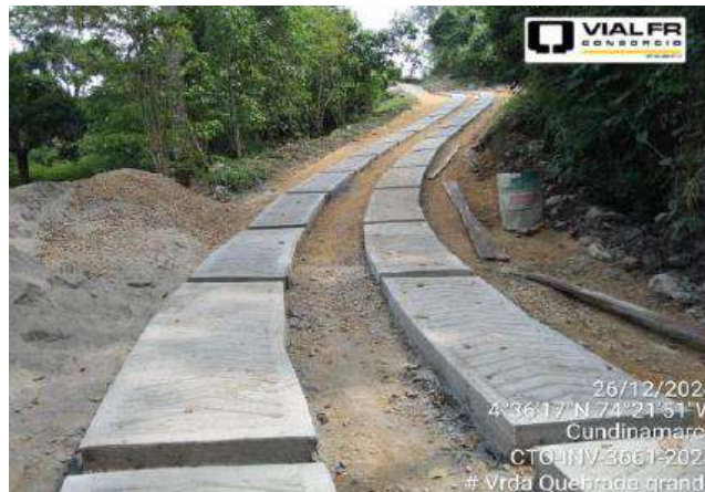
Avance general de obra con corte al 26-dic. Vda Quebrada Grande, San Antonio del Tequendama
