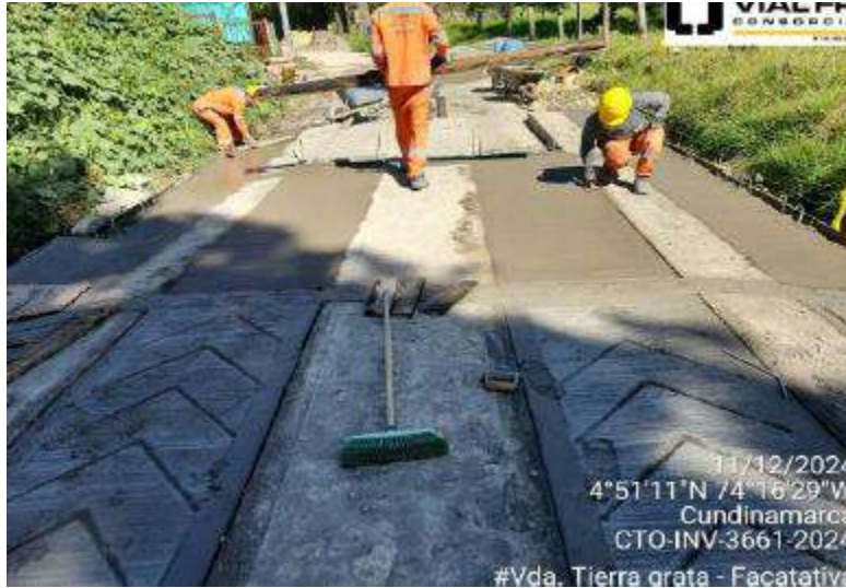
Avance general de obra con corte al 11-dic. Vda Tierra Grata, Facatativá
