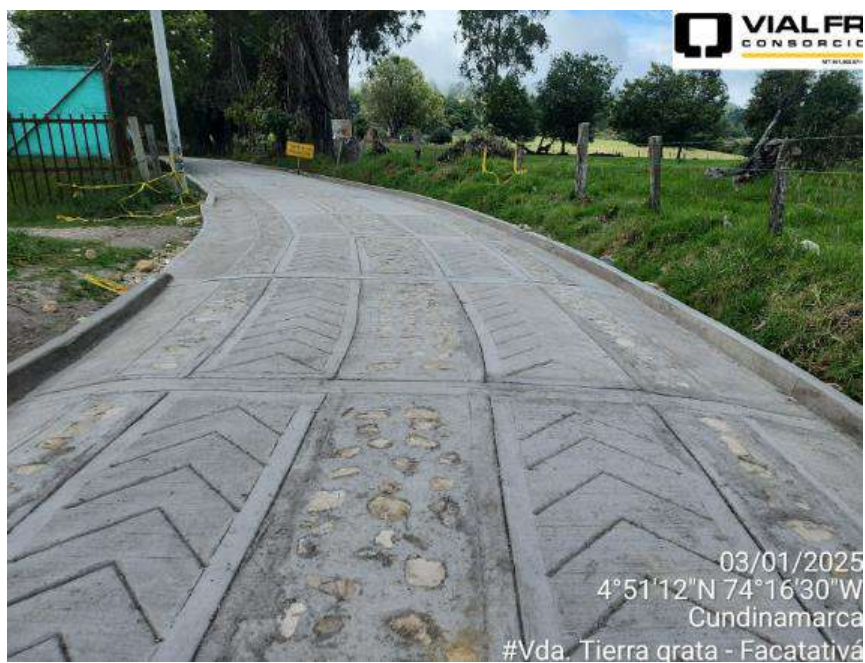
Avance general de obra con corte al 30-dic. Vda Tierra Grata, Facatativá
