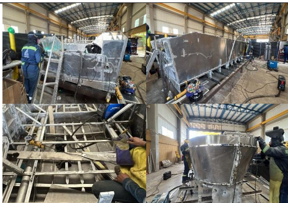
Foto No. 61 a 64 – Bote No. 5 refuerzos, forro del casco y espejo
