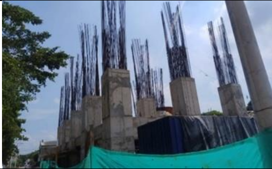
Fotografía No. 37 Desencofre de columnas.
