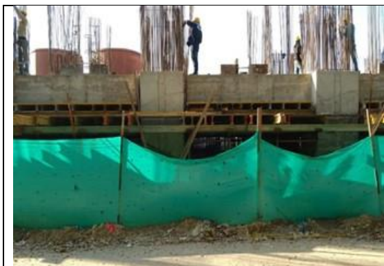
Fotografía No. 11 Acero para columnas.
