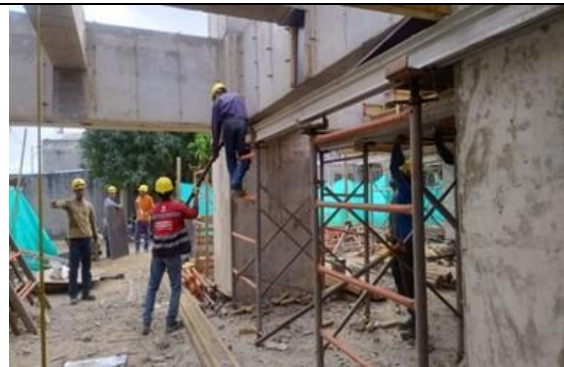
Fotografía No. 39 Armado de acero para columnas.
