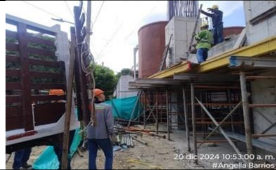
Fotografía No. 38 Retiro de andamios de carga
