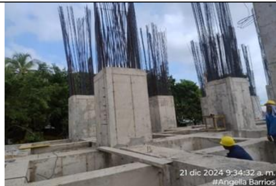
Fotografía No. 40 Armado de acero para columnas.
