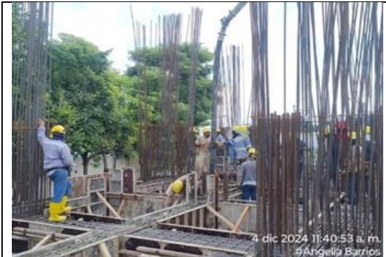
Fotografía No. 5 Fundación de vigas.
