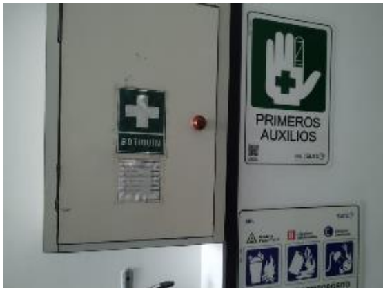
Fotografía No. 48 Botiquín del pasillo primer piso
