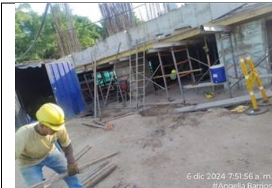
Fotografía No. 9 Desenfofre de vigas.
