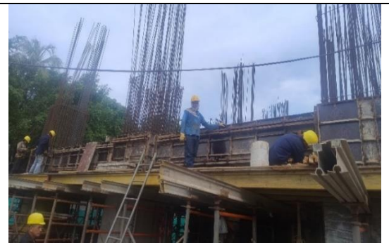
Fotografía No. 2 Encofrado para vigas.
