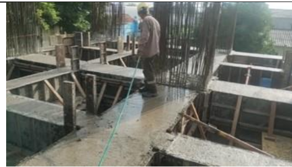
Fotografía No. 8 Fundación de vigas.
