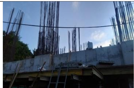
Fotografía No. 10 Desenfofre de vigas.
