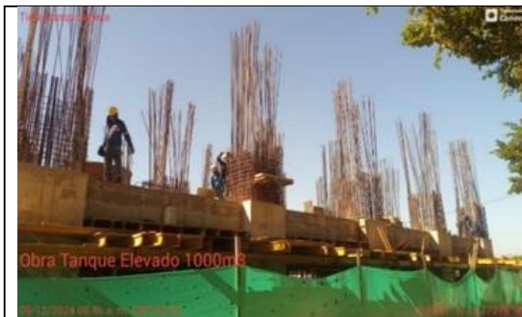
Fotografía No. 13 Acero para columnas.
