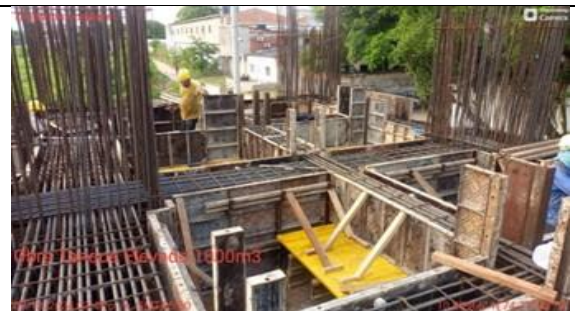
Fotografía No. 4 Encofrado para vigas.
