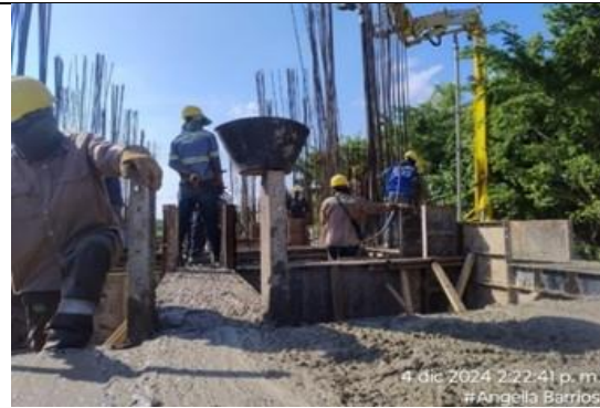
Fotografía No. 6 Fundación de vigas.
