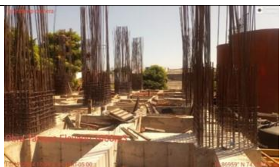
Fotografía No. 16 Acero para columnas
