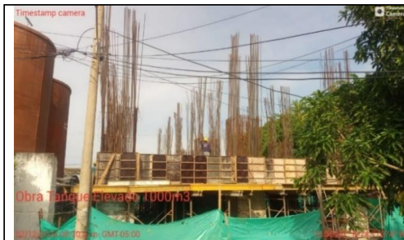
Fotografía No. 1 Encofrado para vigas.
