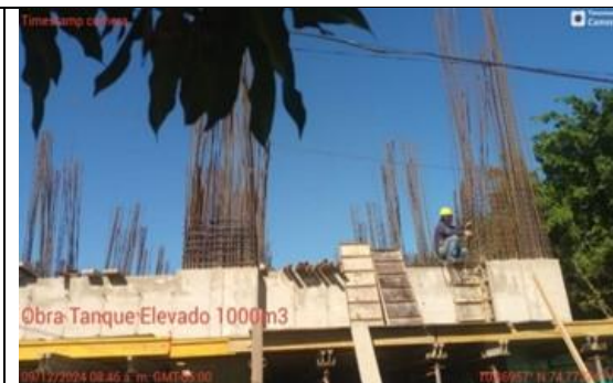
Fotografía No. 14 Acero para columnas
