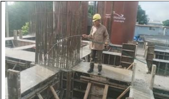
Fotografía No. 7 Fundación de vigas.
