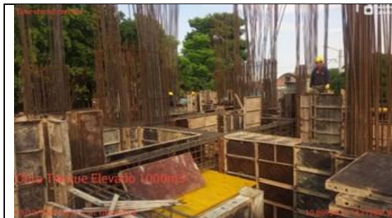
Fotografía No. 3 Encofrado para vigas.
