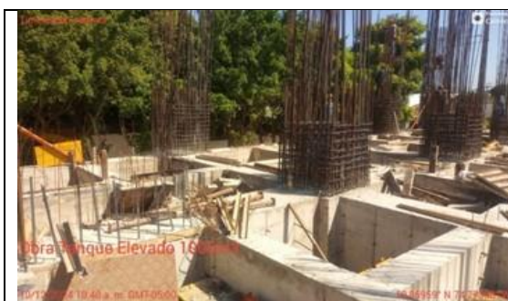
Fotografía No. 15 Acero para columnas.
