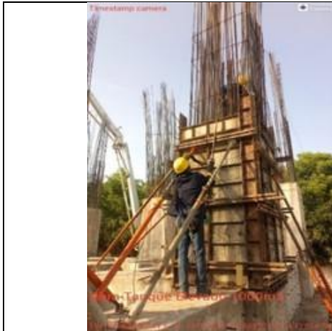
Fotografía No. 35 Verificación de encofrado.
