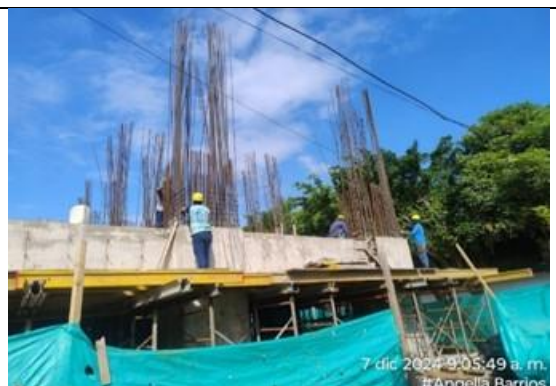
Fotografía No. 12 Acero para columnas
