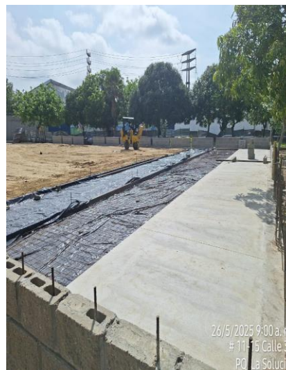
Armado de acero para placa de cancha
