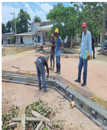
Vaciado de concreto de viga cimiento
