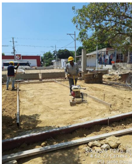
Compatacion de terreno para placa estampada de kiosko
