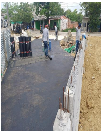
Impermeabilización de placa canal
