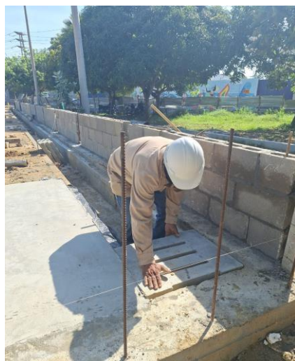
Instalación de tapas de cárcamo
