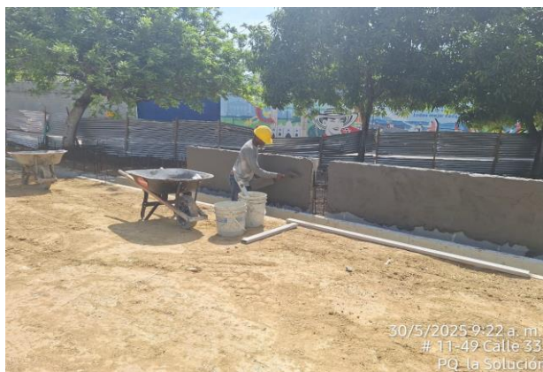
Pañete sobre muro bajo de muro de cerramiento
