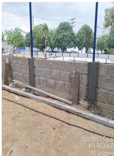
Vaciado de concreto de columneta
