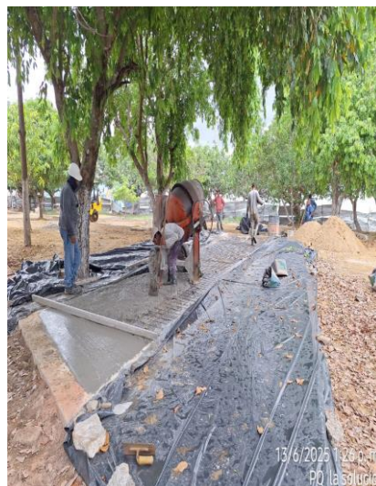
Vaciado de concreto de placa
