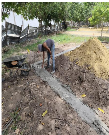
Vaciado de concreto de viga cimiento
