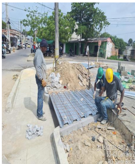
Armado de acero para
