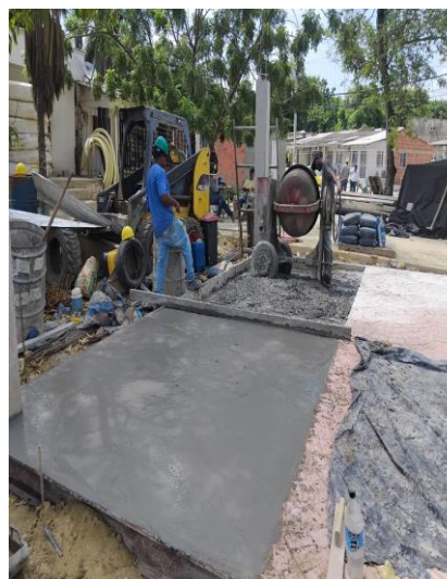
Vaciado de concreto para placa estampada
