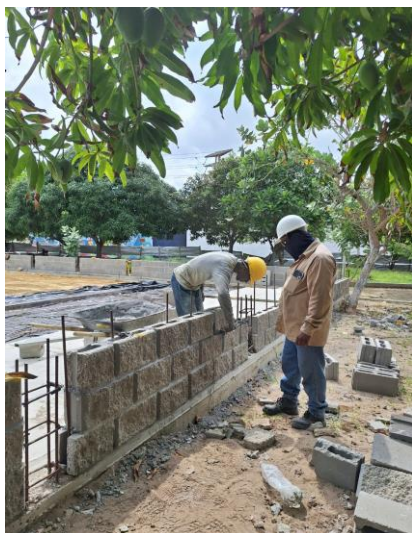
Levante de muro bajo de cerramiento
