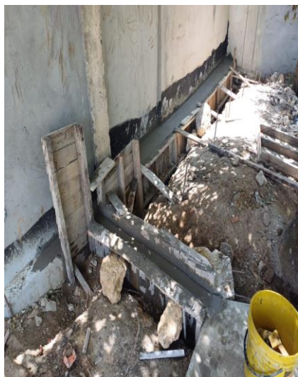
Vaciado de concreto para viga
