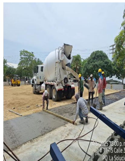
Armado de acero y vaciado de concreto para placa de cancha
