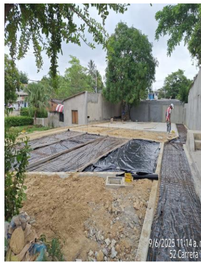
Armado de acero para placa estampada
