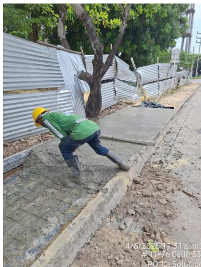
Vaciado de concreto para placa de cancha
