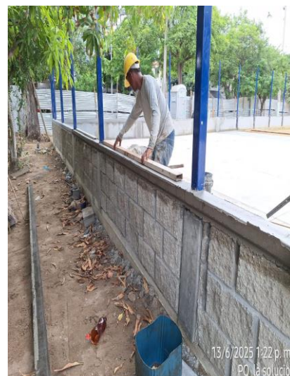
Vaciado de concreto de alfajias
