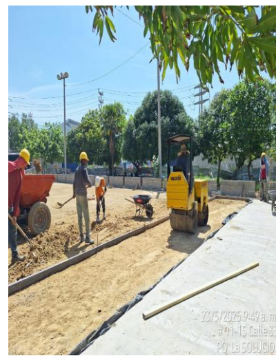
Compactación de terreno para placa de cancha
