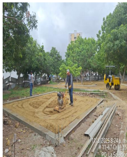
Compactación de relleno de material seleccionado de placa
