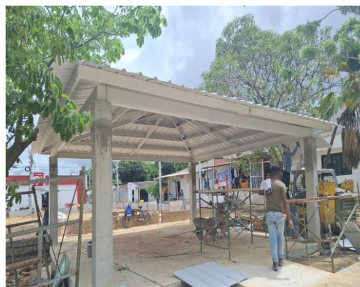
Construcción de kiosko
