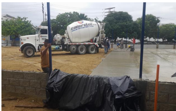
Vaciado de concreto de placa de cancha
