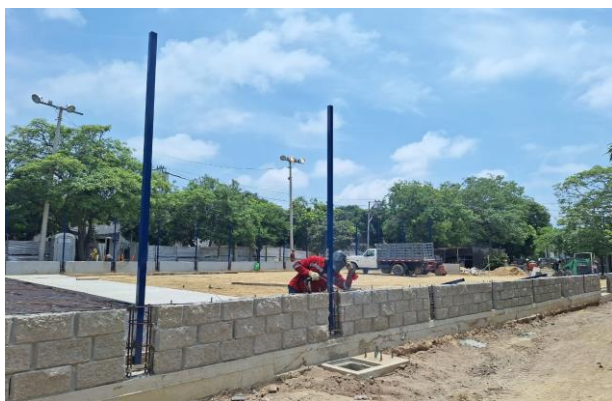
Instalación de postes de malla de cerramiento de cancha
