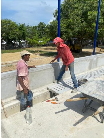
Instalación de tapas de cárcamo
