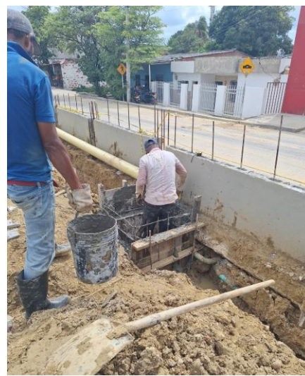
Vaciado de concreto de caja registro de filtro de cancha
