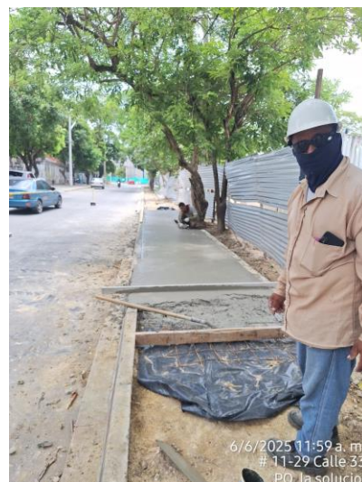
Vaciado de concreto de andén estampado
