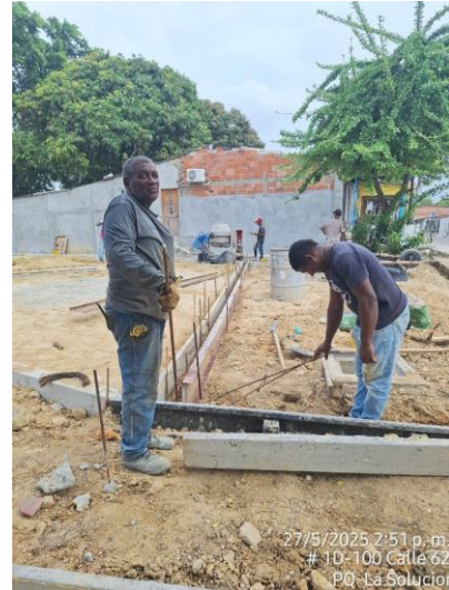
Armado de acero y encofrado para viga cemento
