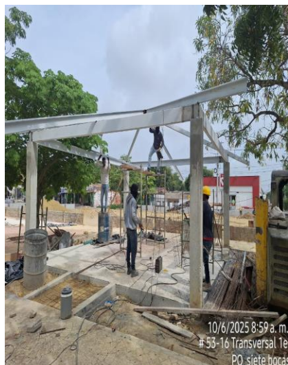
Construcción de kiosko
