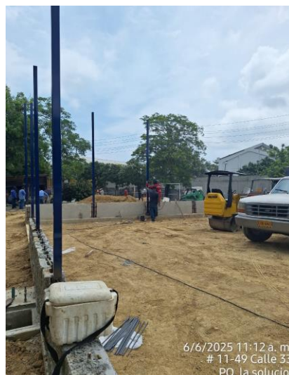
Instalación de postes de malla
