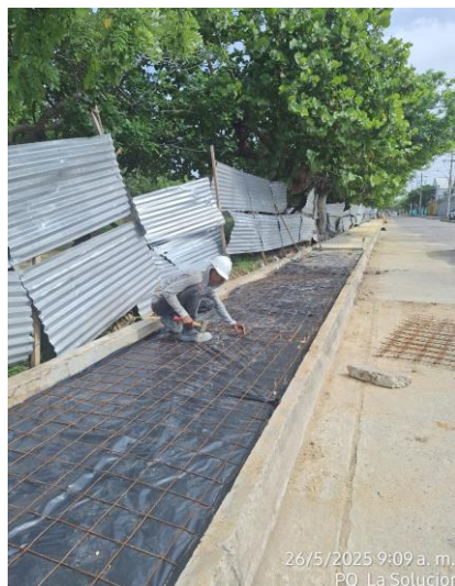
Armado de acero y vaciado de concreto para anden estampado
