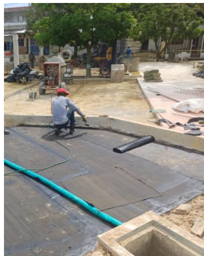
Impermeabilización de placa canal
