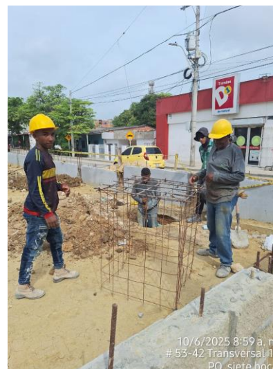
Armado de acero para registro de filtro de cancha
