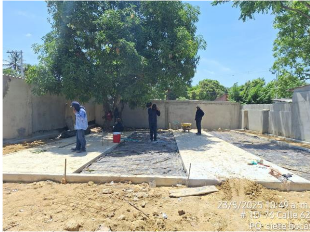
Compactación de relleno seleccionado, armado de acero y encofrado para placa
