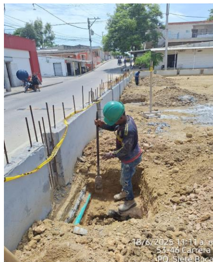
Excavación de caja registro de filtro de cancha
