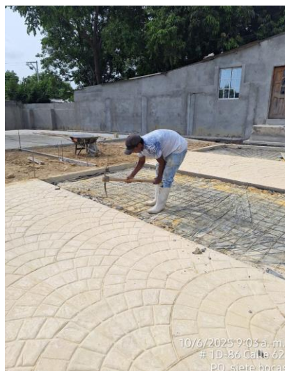
Armado de acero para placa estampada
