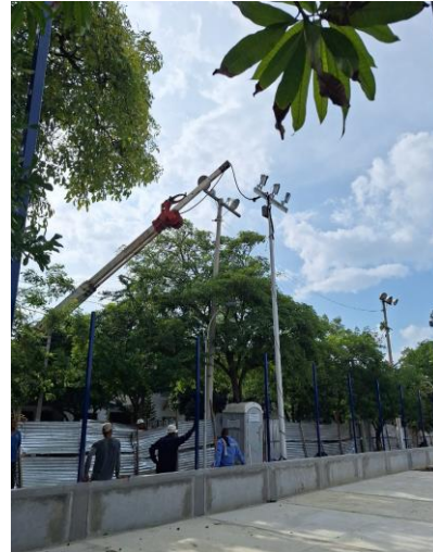
Instalación de postes de alumbrado publico
