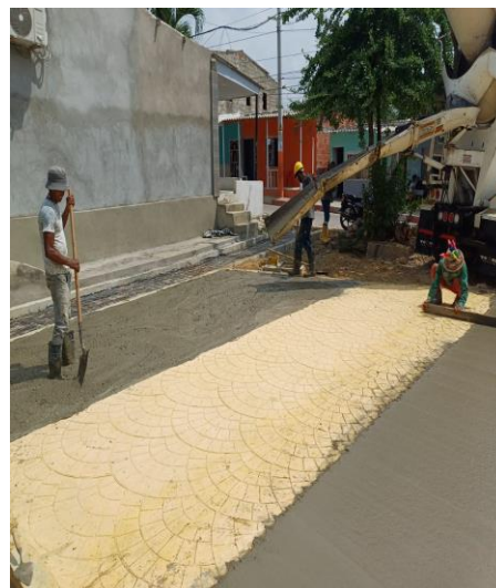
Vaciado de concreto de placa estampada
