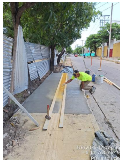
Vaciado de concreto para placa de cancha
