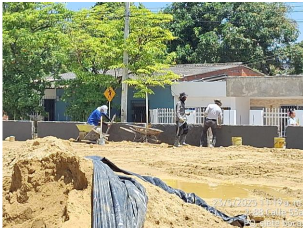
Pañete sobre muro bajo de cerramiento
