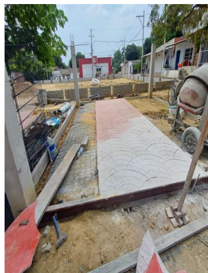
Vaciado de concreto para placa estampada de kiosko
