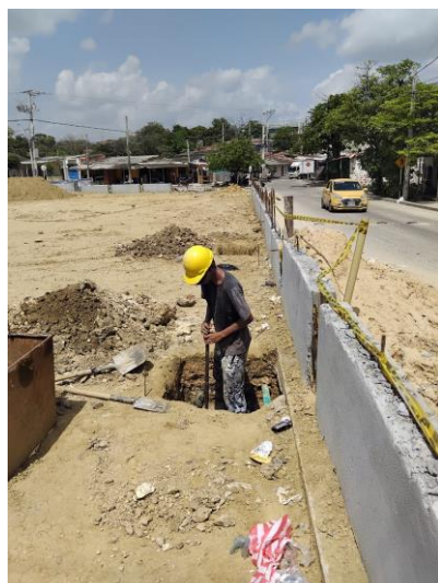
Excavación para registro de filtro de cancha
