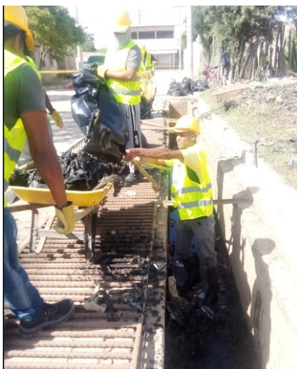
RETIRO DE SEDIMENTOS DE CANAL EN CONCRETO
