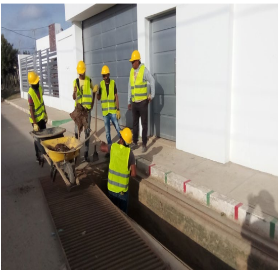
LIMPIEZA DE CANALES DE CONCRETO
