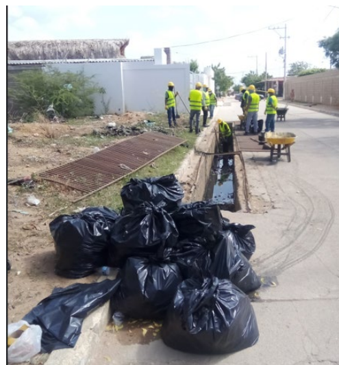
LIMPIEZA DE CANAL DE CONCRETO
