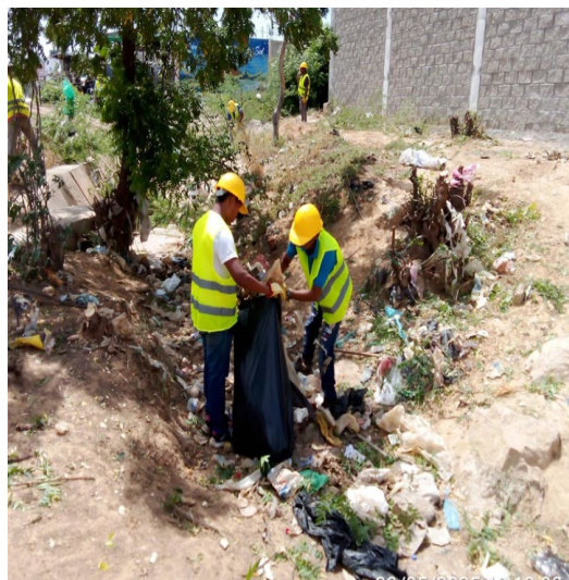
LIMPIEZA DE ARROYO Y CAUCE
