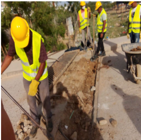
LIMPIEZA A CANAL EN CONCRETO TOTALMENTE ONSTRUIDO
