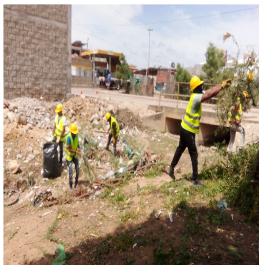
DISPOSICION DE DESECHOS, PARA LUEGO LLEVARLOS A SU LUGAR FINAL DE ACOPIO
