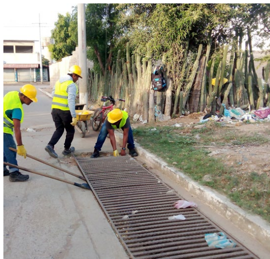
MANTENIMIENTO DE REJILLAS
