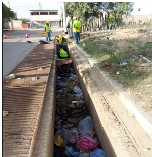
LIMPIEZA DE CANALES DE CONCRETO
