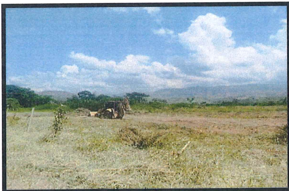
1.2 Descapote e=0,20m a máquina incluye retiro material
