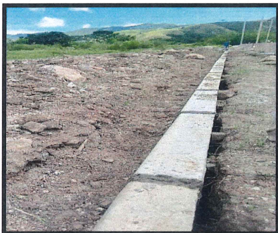
4.5 Suministro e instalación de bordillos prefabricados
