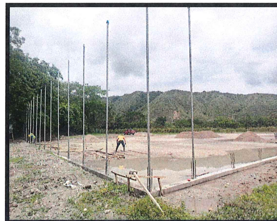
5.5 Tubería Galvanizada
