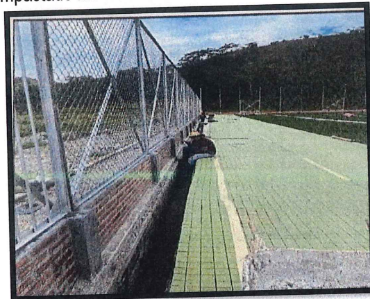
3.1 Construcción cuneta perimetral
