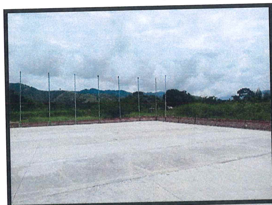
4.1 Placa de piso en concreto 3000 PSI
