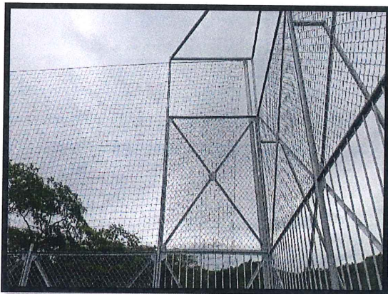
5.10 Suministro e instalación de malla de cerramiento en Nylon
