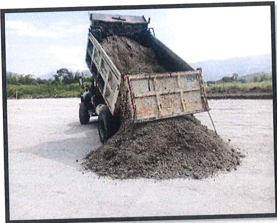
2.3 Relleno con recebo compactado mecánicamente
