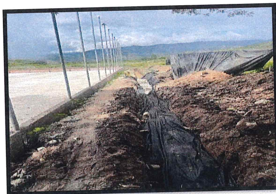
3.4 Construcción de filtros laterales recubrimiento en geotextil
