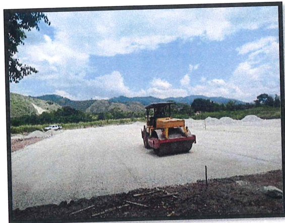
2.3 Relleno con recebo compactado mecánicamente
