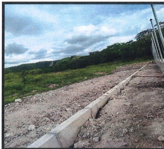
4.5 Suministro e instalación de bordillos prefabricados
