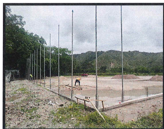
5.5 Tubería Galvanizada
