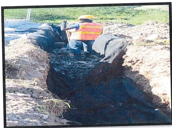
3.4 Construcción de filtros laterales recubrimiento en geotextil
