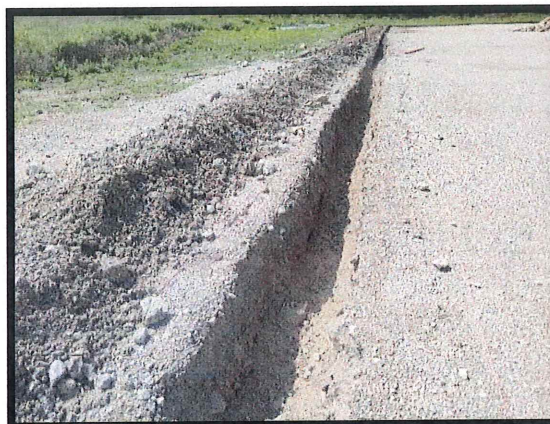
2.1 Excavación manual
