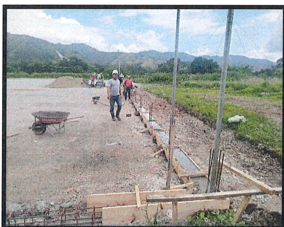
5.2 Concreto 3000 PSI viga de cimentación
