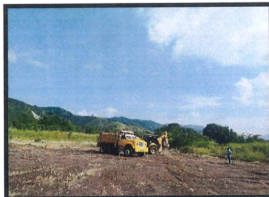
Retiro de material sobrante
