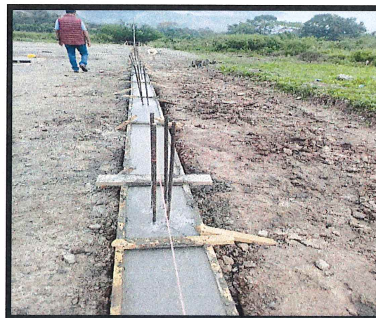
5.2 Concreto 3000 PSI viga de cimentación
