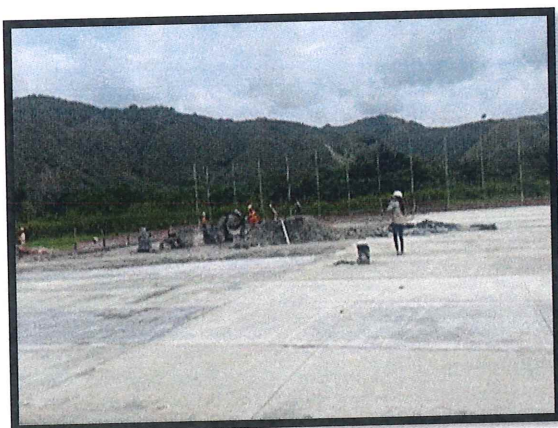
4.1 Placa de piso en concreto 3000 PSI
