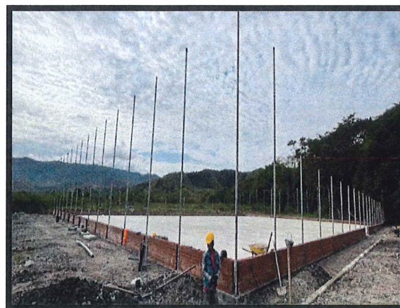
5.3 Muro cerramiento en ladrillo
