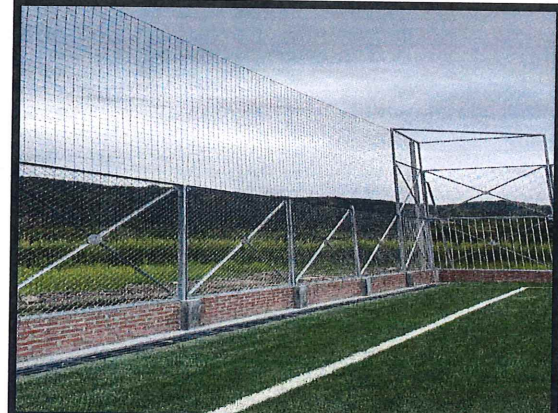
5.10 Suministro e instalación de malla de cerramiento en Nylon
