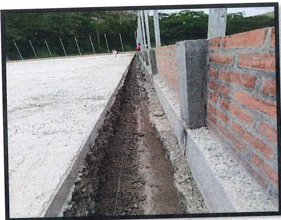
3.1 Construcción cuneta perimetral
