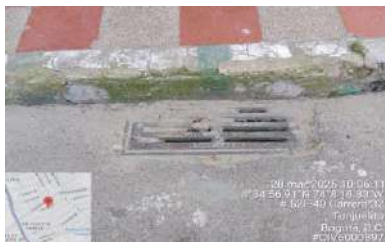
ANTES DE LA INTERVENCIÓN
