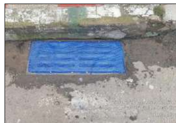
DURANTE LA INTERVENCIÓN
