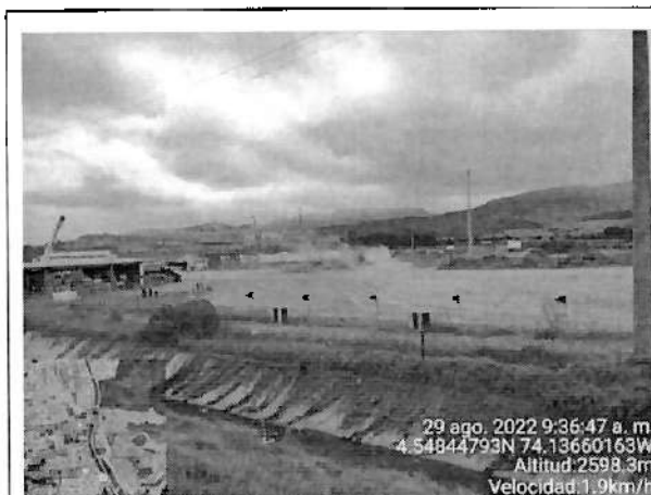
Fotografía No. 3. Punto de acopio temporal de residuos aprovechables. Cemex Colombia S.A. Fuente. Visita Técnica del 29 de agosto de 2022 – SCASP, RCD.
