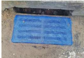
DURANTE LA INTERVENCIÓN
