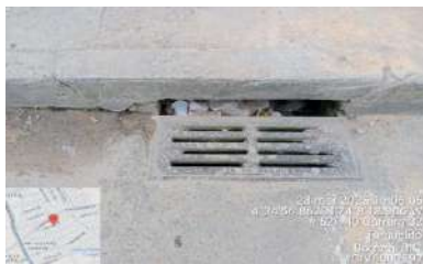
ANTES DE LA INTERVENCIÓN
