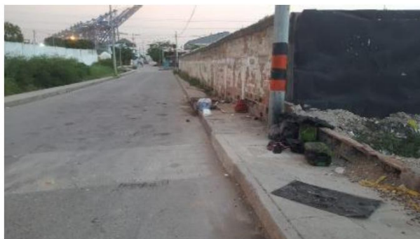
Imagen 9. Residuos industriales en la esquina principal, los cuales suponemos son de la empresa Aceites de Cartagena S.A.S., ya que es la ubicada en el sector.
