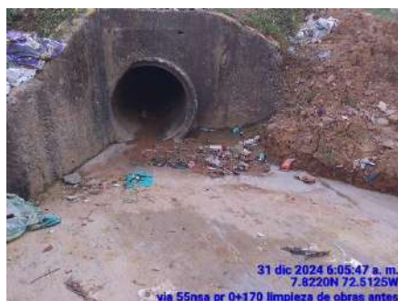
LIMPIEZA DE OBRAS (ANTES)
