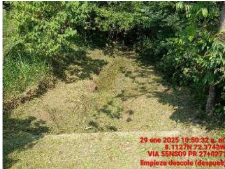
LIMPIEZA DE DESCOLE (DESPUES)
