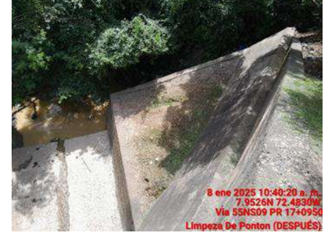
LIMPIEZA DE PONTON (DESPUES)
