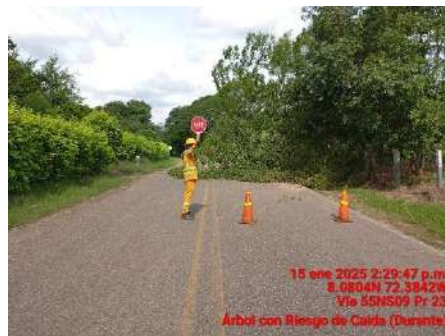
RETIRO DE ARBOL CON RIESGO (DURANTE)
