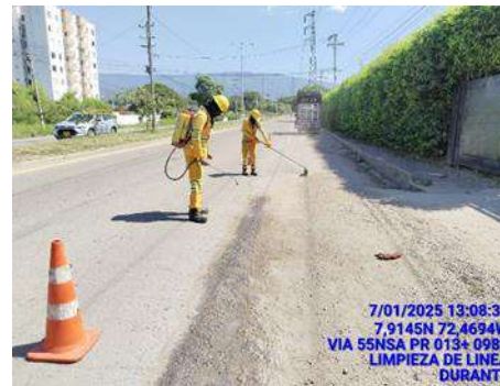
LIMPIEZA DE LINEA (DURANTE)
