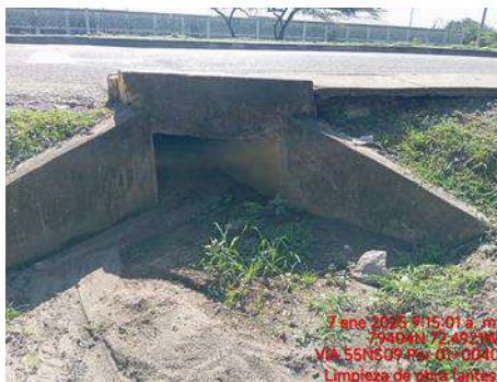
LIMPIEZA DE OBRA(ANTES)
