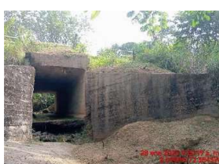
LIMPIEZA DE OBRA (DESPUES)
