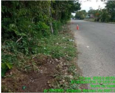
LIMPIEZA DE BERMAS (ANTES)
