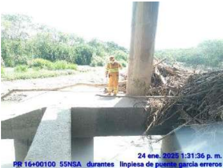
LIMPIEZA DE Puentes (DURANTE)
