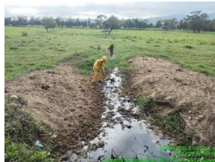
LIMPIEZA DE DESCOLE (DURANTE)
