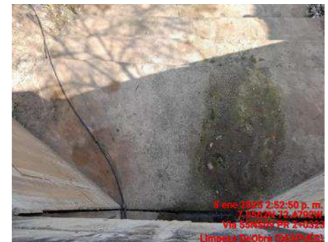
LIMPIEZA DE OBRA (DESPUES)
