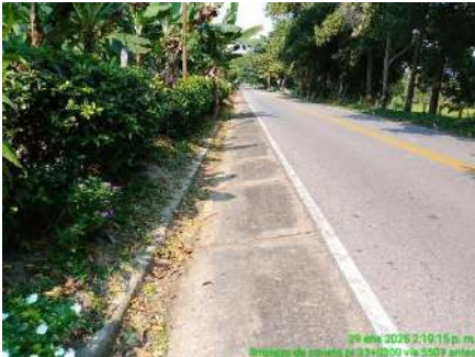
LIMPIEZA DE CUNETAS (ANTES)
