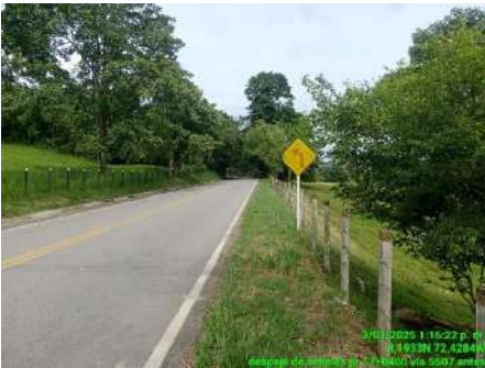
DESPEJE DE SEÑALES (ANTES)
