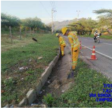
LIMPIEZA DE CUNETA (DURANTE)
