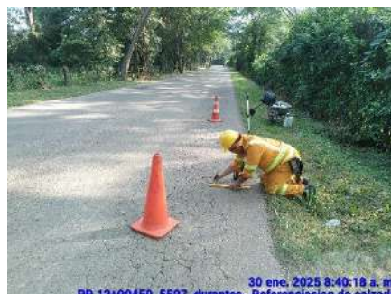
REFERENCIACION DE CALZADA (DURANTE)
