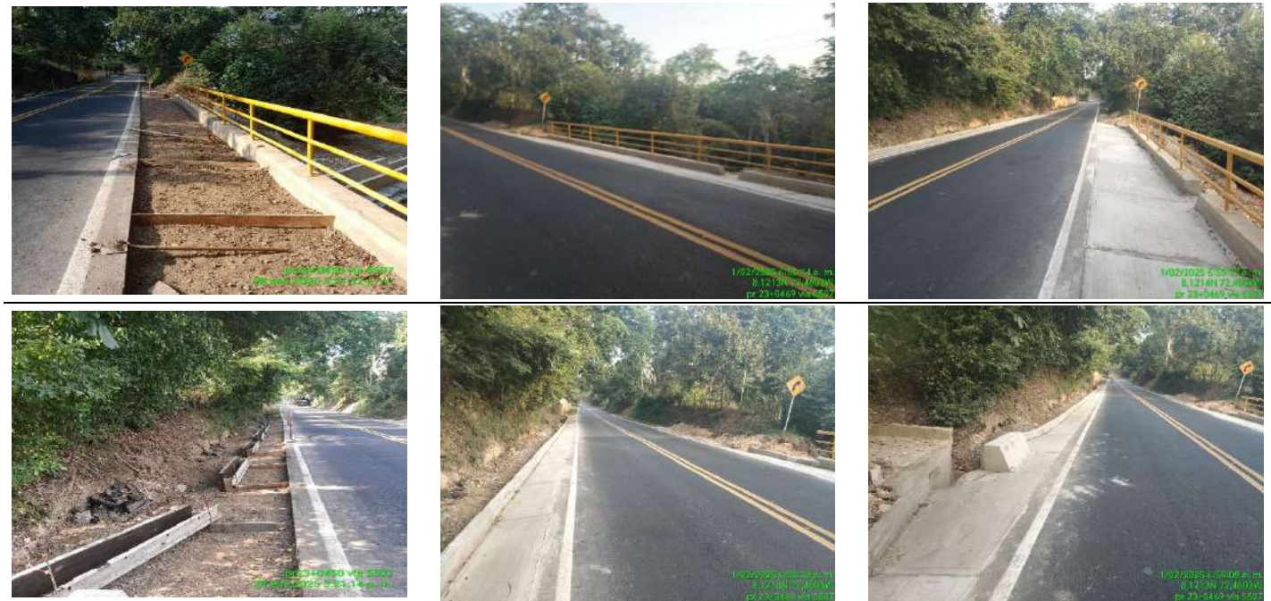
Registro de construcción de cuneta en concreto en ambas márgenes en el PR 23 + 0458 de la vía 5507. Contrato 2471/2023 y adicionales.
