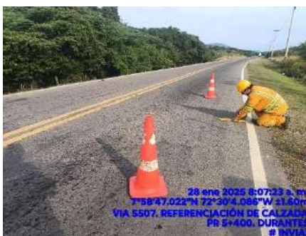
REFERENCIACION DE CALZADA (DURANTE)
