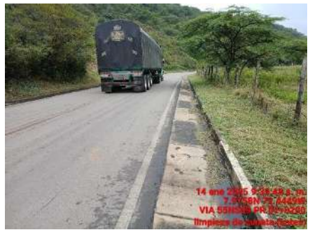
LIMPIEZA DE CUNETAS (ANTES)
