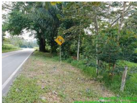
DESPEJE DE SEÑALES (ANTES)
