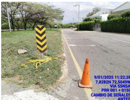
CAMBIO DE SEÑALES (DESPUES)
