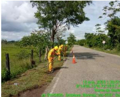
LIMPIEZA DE BERMAS (DURANTE)
