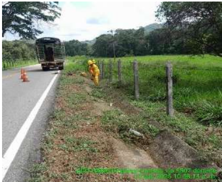
LIMPIEZA DE CUNETAS (DURANTE)
