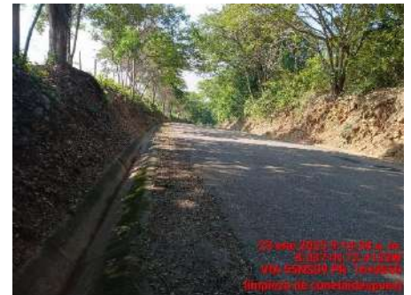
LIMPIEZA DE DESCOLE (DESPUES)
