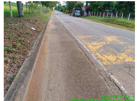
LIMPIEZA DE CUNETA (DESPUES)
