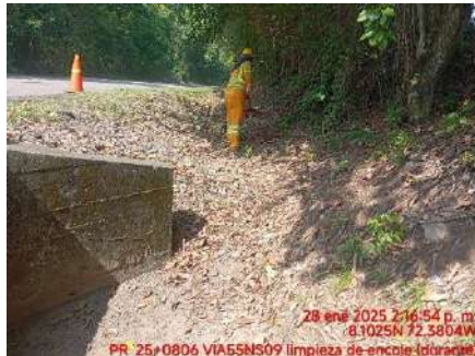
LIMPIEZA DE DESCOLE (DURANTE)
