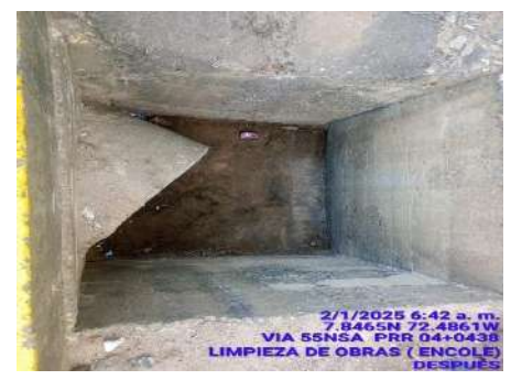
LIMPIEZA DE OBRAS (DESPUES)
