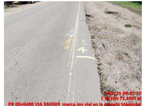
MARCACION VIAL (DESPUES)
