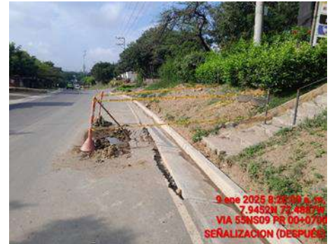
SEÑALIZACION SITIOS CRITICOS (DESPUES)
