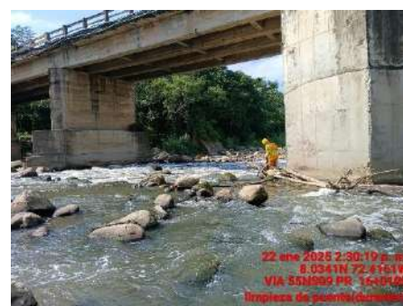
RETIRO DE ARBOL CON RIESGO (DURANTE)
