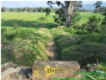
LIMPIEZA DE DESCOLE (DESPUES)
