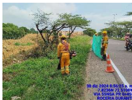
LIMPIEZA DE CUNETAS (DURANTE)
