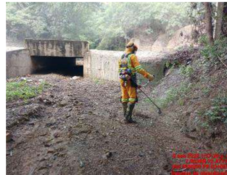
LIMPIEZA DE OBRA (DURANTE)
