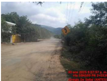
ARREGLO DE SEÑALES (ANTES)
