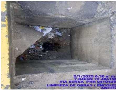
LIMPIEZA DE OBRAS (ANTES)
