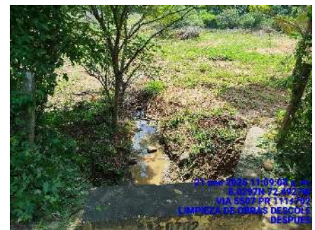
LIMPIEZA DE OBRAS (DESPUES)
