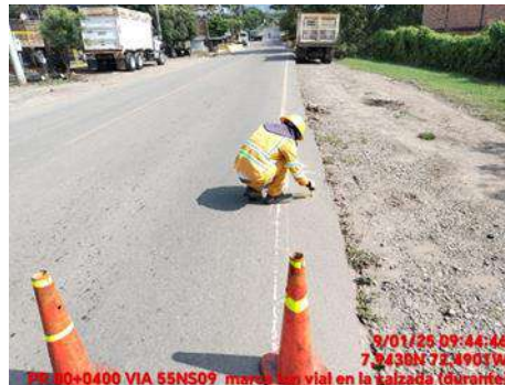
MARCACION VIAL (DURANTE)
