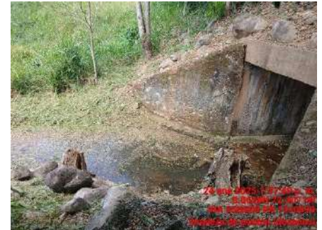
LIMPIEZA DE PONTON (DESPUES)
