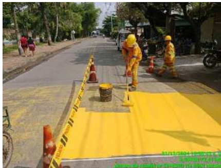
PINTURA DE RESALTOS (DURANTE)
