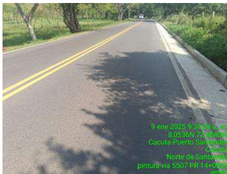
MARCACION VIAL (ANTES)
