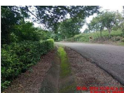
LIMPIEZA DE CUNETAS (DESPUES)
