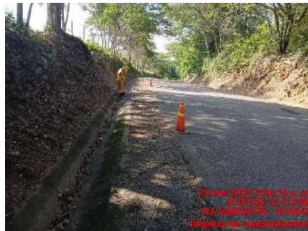
LIMPIEZA DE DESCOLE (DURANTE)
