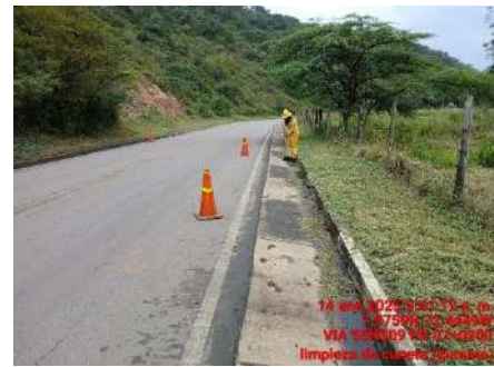
LIMPIEZA DE CUNETAS (DURANTE)
