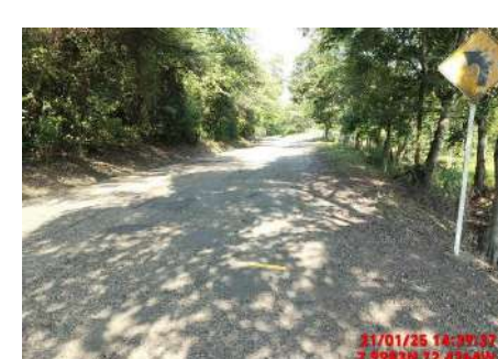
LIMPIEZA DE CUNETA (DESPUES)
