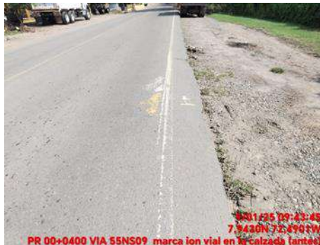
MARCACION VIAL (ANTES)
