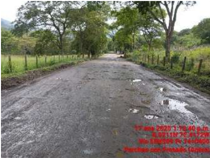
LIMPIEZA DE CUNETAS (ANTES)
