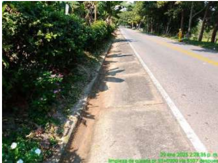
LIMPIEZA DE CUNETAS (DESPUES)
