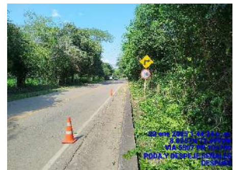
PODA Y DESPEJE DE SEÑALES (DESPUES)
