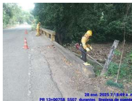
LIMPIEZA DE PUENTES (DURANTE)
