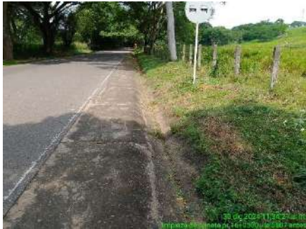
LIMPIEZA DE CUNETAS (ANTES)
