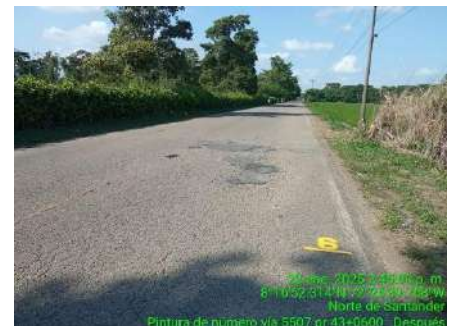
REFERENCIACION DE CALZADA (DESPUES)
