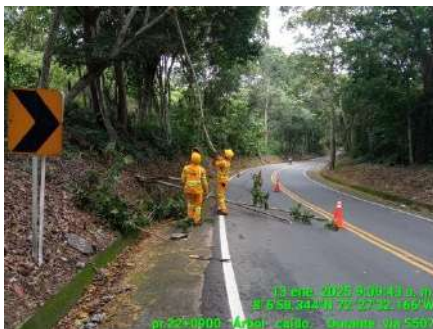
RETIRO DE ARBOL (DURANTE)
