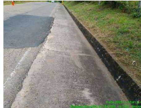
LIMPIEZA DE CUNETA (DESPUES)
