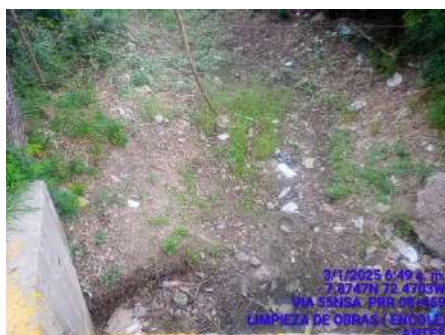
LIMPIEZA DE OBRAS (ANTES)
