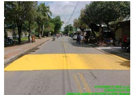
PINTURA DE RESALTOS (DESPUES)
