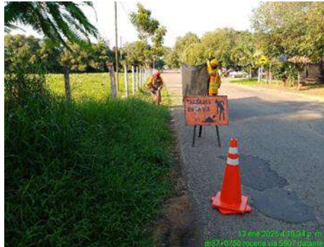
SEGUIMIENTO USO DE BARRERA DE SEGURIDAD
