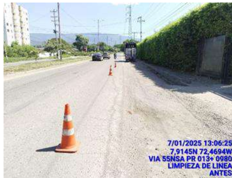
LIMPIEZA DE LINEA (ANTES)
