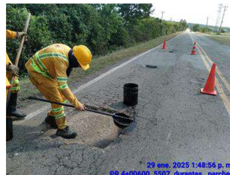
SEGUIMIENTO CORRECTA SEÑALIZACION VIAL
