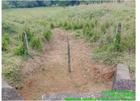
LIMPIEZA DE ENCOLES Y DESCOLES (DESPUES)
