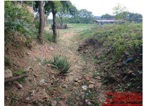
LIMPIEZA DESCOLE (DESPUES)
