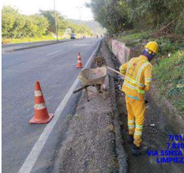
LIMPIEZA DE CUNETA (DURANTE)
