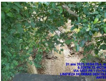
LIMPIEZA DE OBRAS (ANTES)
