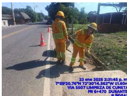
LIMPIEZA DE CUNETAS (DURANTE)
