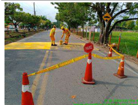
SEGUIMIENTO CORRECTA SEÑALIZACION VIAL
