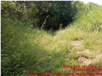
LIMPIEZA DE DESCOLE (ANTES)
