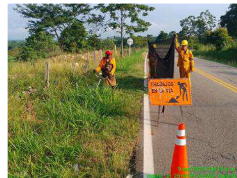
SEGUIMIENTO USO DE BARRERA DE SEGURIDAD
