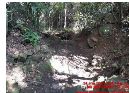
LIMPIEZA DE DESCOLE (DESPUES)
