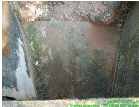
LIMPIEZA DE ESCOLE (DESPUES)
