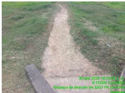
LIMPIEZA DE DESCOLE (DESPUES)
