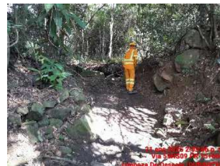
LIMPIEZA DE DESCOLE (DURANTE)
