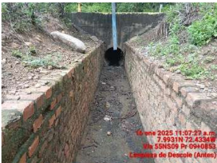
LIMPIEZA DE DESCOLE (ANTES)
