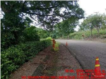
LIMPIEZA DE CUNETAS (DURANTE)
