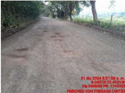
LIMPIEZA DE ZANJA CORONACION (ANTES)
