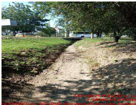
LIMPIEZA DE ENCOLE (ANTES)
