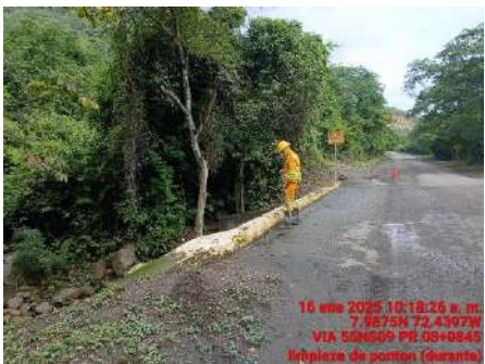
LIMPIEZA DE PONTON (DURANTE)
