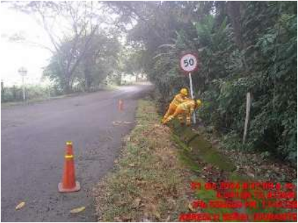
LIMPIEZA DE PUENTES (DURANTE)
