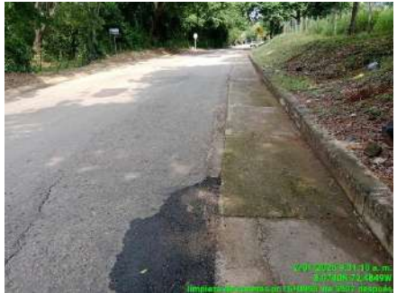
LIMPIEZA DE CUNETAS (DESPUES)
