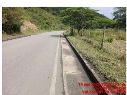
LIMPIEZA DE CUNETAS (DESPUES)
