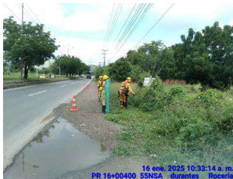
SEGUIMIENTO USO DE BARRERA DE SEGURIDAD
