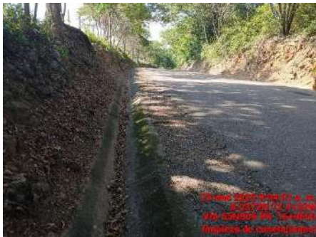
LIMPIEZA DE DESCOLE (ANTES)
