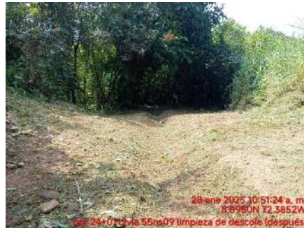
LIMPIEZA DE DESCOLE (DESPUES)
