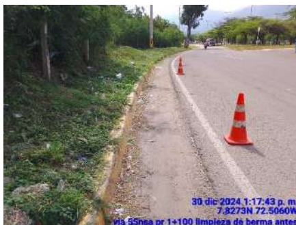
LIMPIEZA DE OBRAS (ANTES)
