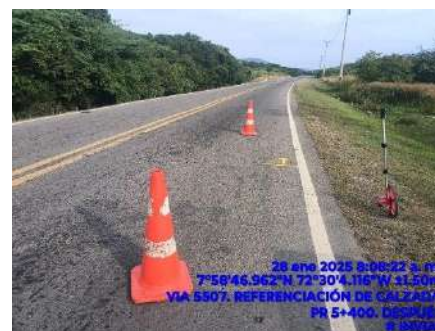
REFERENCIACION DE CALZADA (DESPUES)
