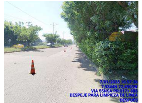
DESPEJE DE RAMAS Y LIMPIEZA (DESPUES)
