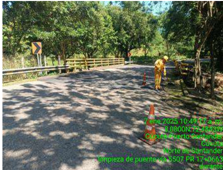
LIMPIEZA DE PUENTE (DURANTE)
