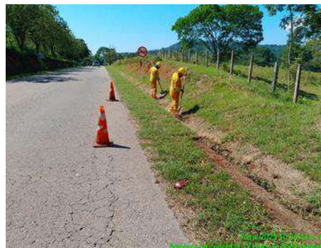
LIMPIEZA DE CUNETAS (DURANTE)
