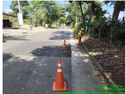
LIMPIEZA DE CUNETAS (DURANTE)
