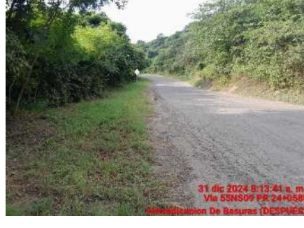
LIMPIEZA DE CUNETA (DESPUES)
