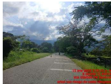
RETIRO DE ARBOL CON RIESGO (DESPUES)
