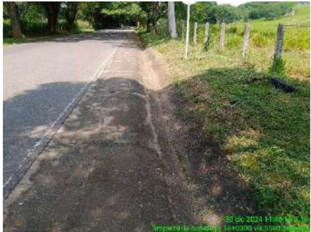
LIMPIEZA DE CUNETAS (DESPUES)
