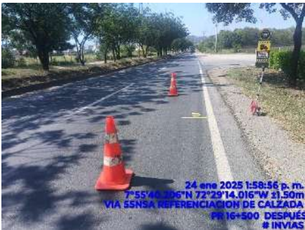
REFERENCIACION DE CALZADA (DESPUES)
