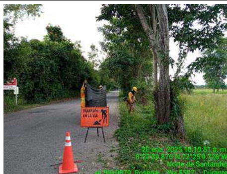
SEGUIMIENTO USO DE BARRERA DE SEGURIDAD
