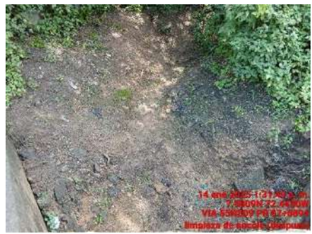
LIMPIEZA DE DESCOLE (DESPUES)
