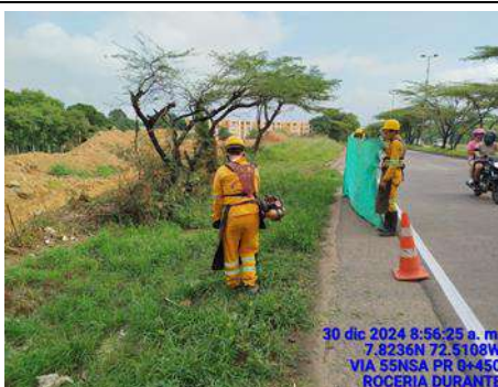
SEGUIMIENTO USO DE BARRERA DE SEGURIDAD
