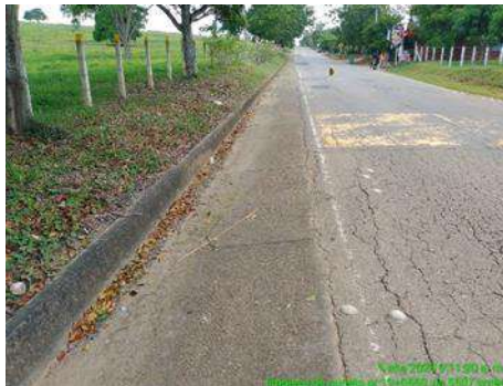
LIMPIEZA DE CUNETA (ANTES)
