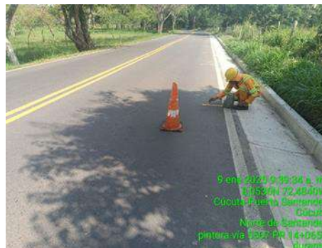
MARCACION VIAL (DURANTE)
