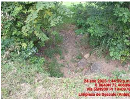
LIMPIEZA DE DESCOLE (ANTES)
