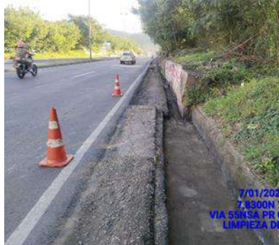
LIMPIEZA DE CUNETA (DESPUES)
