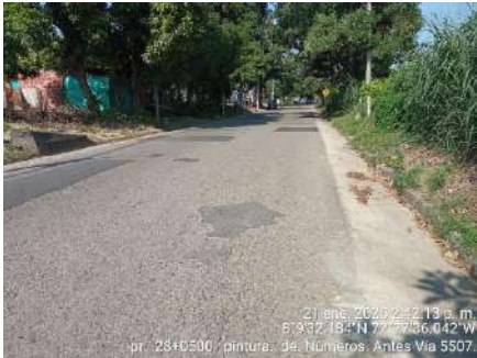
REFERENCIACION DE LA CALZADA (ANTES)
