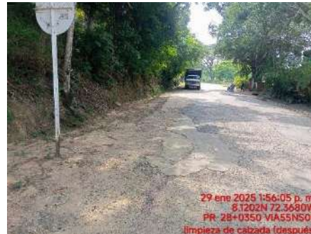
LIMPIEZA DE CALZADA (DESPUES)
