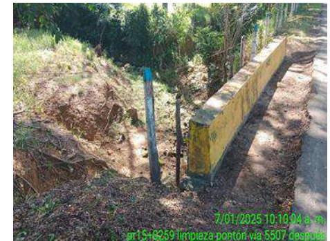
LIMPIEZA DE PONTON (DESPUES)
