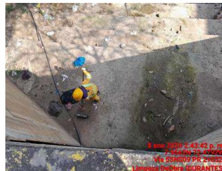
LIMPIEZA DE OBRA (DURANTE)
