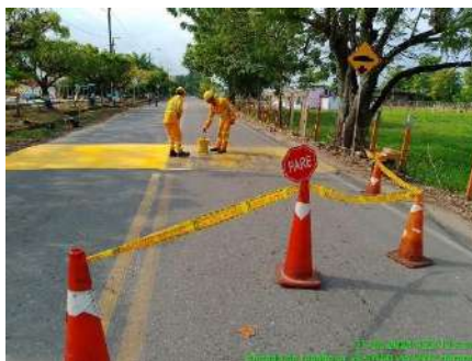
PINTURA DE RESALTOS (DURANTE)
