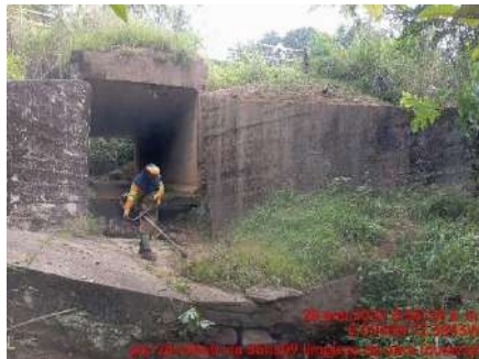
LIMPIEZA DE OBRA (DURANTE)
