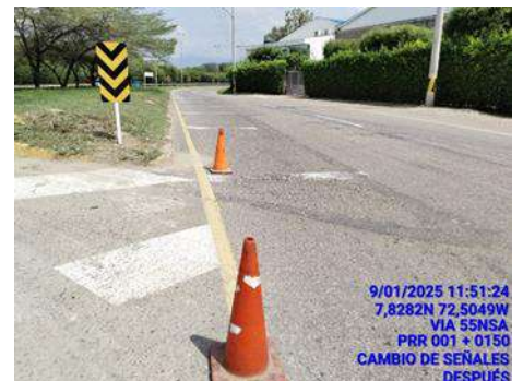
CAMBIO DE SEÑALES (DESPUES)
