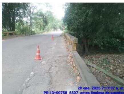
LIMPIEZA DE PUENTES (ANTES)
