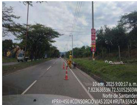
INSPECCION CORRECTO USO DE SEÑALIZACION EN ACTIVIDADES
