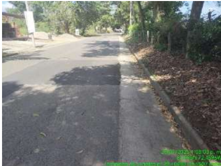
LIMPIEZA DE CUNETAS (ANTES)
