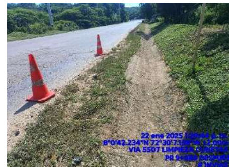
LIMPIEZA DE CUNETAS (DESPUES)
