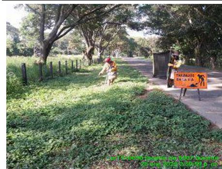
SEGUIMIENTO USO DE BARRERA DE SEGURIDAD
