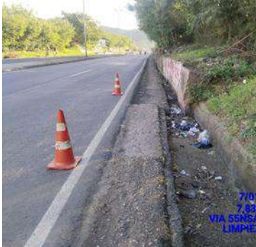
LIMPIEZA DE CUNETA (ANTES)
