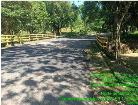
LIMPIEZA DE PUENTE (ANTES)
