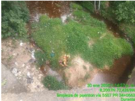
LIMPIEZA DE PONTON (DURANTE)
