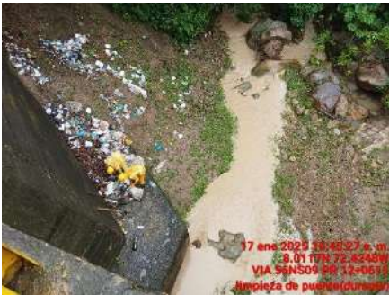
LIMPIEZA DE PONTON (DURANTE)
