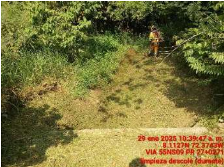
LIMPIEZA DE DESCOLE (DURANTE)
