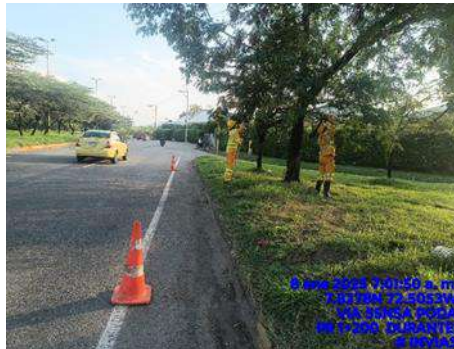
DESPEJE DE SEÑAL VIAL (DURANTE)
