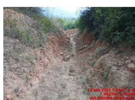
LIMPIEZA DE ZANJAS DE CORONACION (DESPUES)
