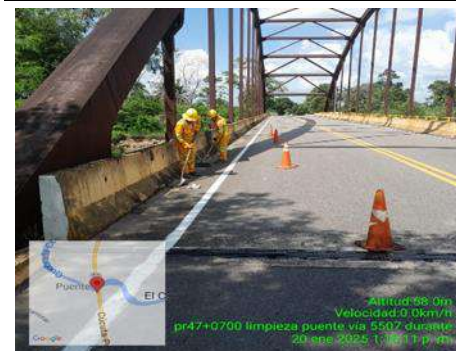
SEGUIMIENTO CORRECTA SEÑALIZACION VIAL
