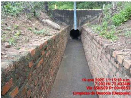
LIMPIEZA DE DESCOLE (DESPUES)
