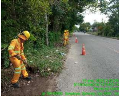
LIMPIEZA DE BERMAS (DURANTE)
