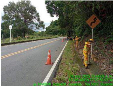
SEGUIMIENTO CORRECTA SEÑALIZACION VIAL
