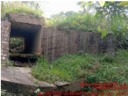
LIMPIEZA DE OBRA (ANTES)
