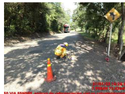
LIMPIEZA DE CUNETA (DURANTE)
