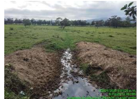
LIMPIEZA DE DESCOLE (DESPUES)
