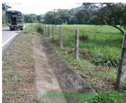
LIMPIEZA DE CUNETAS (DESPUES)
