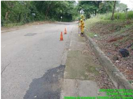
LIMPIEZA DE CUNETAS (DURANTE)
