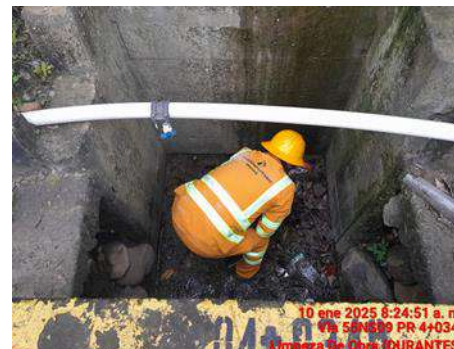
LIMPIEZA DE OBRA (DURANTE)
