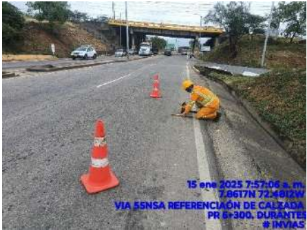
REFERENCIACION DE CALZADA (DURANTE)
