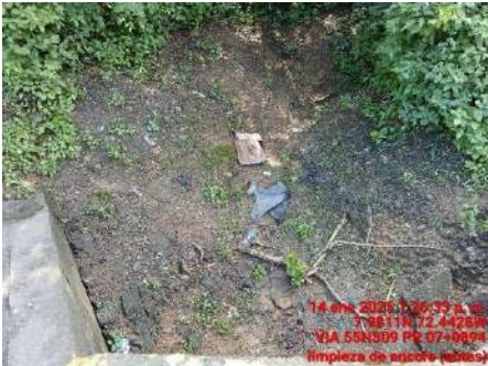
LIMPIEZA DE DESCOLE (ANTES)
