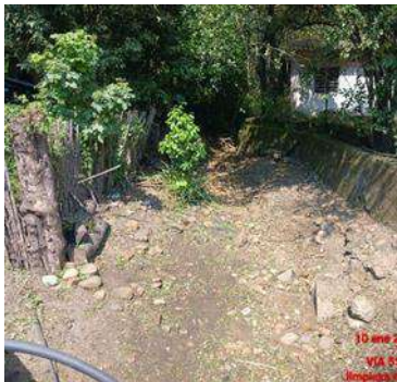
LIMPIEZA DE ENCOLE (DESPUES)
