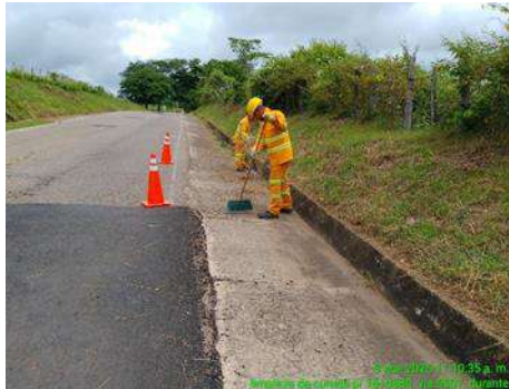
LIMPIEZA DE CUNETA (DURANTE)
