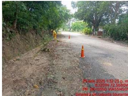
LIMPIEZA DE CALZADA (DURANTE)
