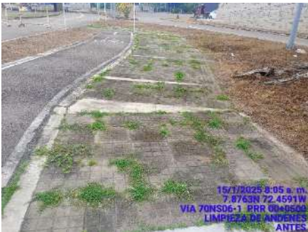
LIMPIEZA DE ANDENES (ANTES)
