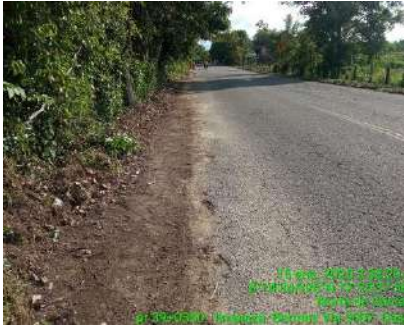
LIMPIEZA DE BERMAS (DESPUES)
