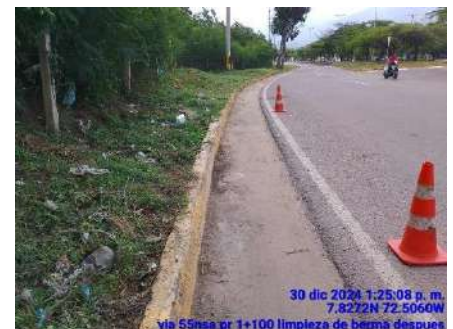
LIMPIEZA DE OBRAS (DESPUES)
