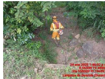
LIMPIEZA DE DESCOLE (DURANTE)
