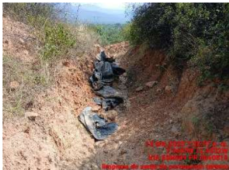
LIMPIEZA DE ZANJAS DE CORONACION (ANTES)
