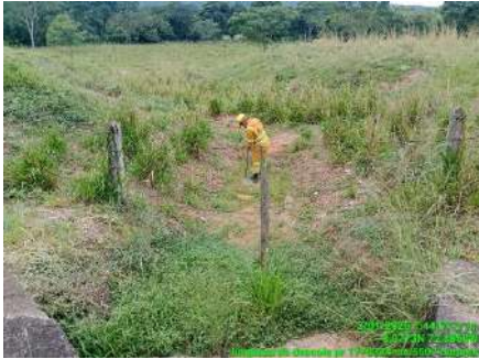
LIMPIEZA DE ENCOLES Y DESCOLES (DURANTE)
