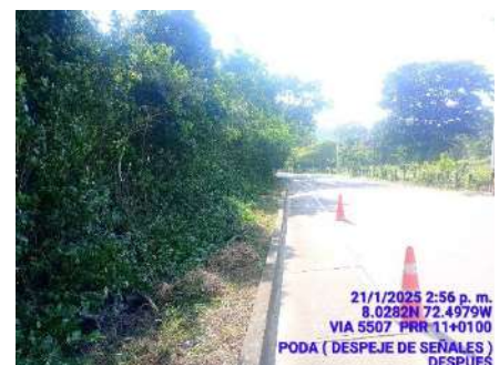
DESPEJE DE SEÑALES (DESPUES)
