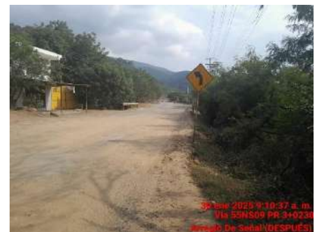
ARREGLO DE SEÑALES (DESPUES)
