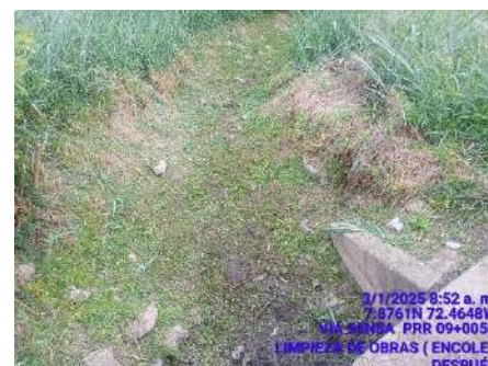
LIMPIEZA DE OBRAS (DESPUES)
