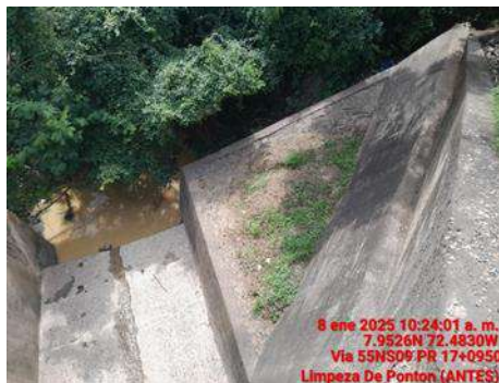
LIMPIEZA DE PONTON (ANTES)
