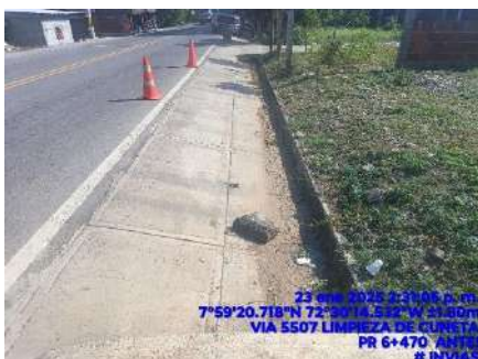
LIMPIEZA DE CUNETAS (ANTES)
