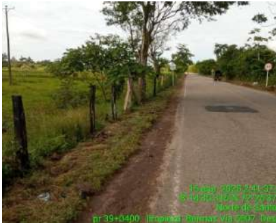
LIMPIEZA DE BERMAS (DESPUES)
