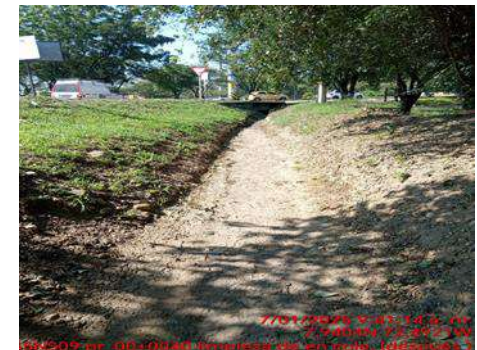
LIMPIEZA DE ENCOLE (DESPUES)
