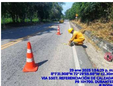
REFERENCIACION DE CALZADA (DURANTE)
