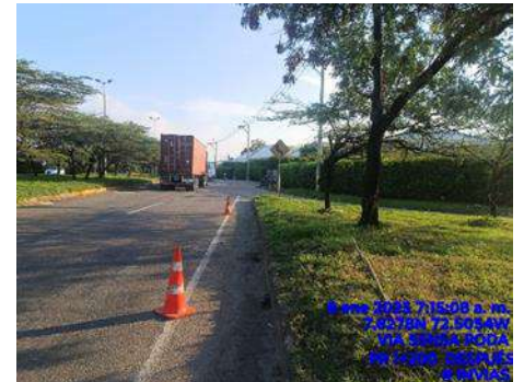
DESPEJE DE SEÑAL VIAL (DESPUES)
