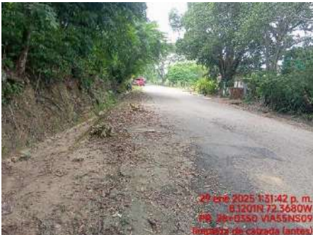
LIMPIEZA DE CALZADA (ANTES)
