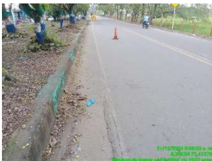
LIMPIEZA DE BERMAS (ANTES)
