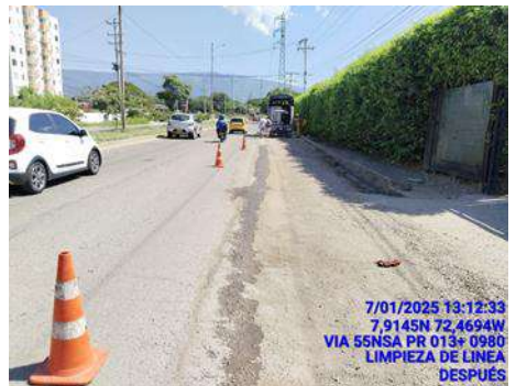
LIMPIEZA DE LINEA (DESPUES)
