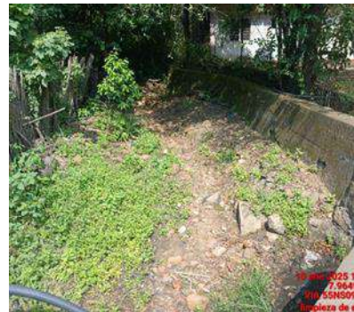
LIMPIEZA DE ENCOLE (ANTES)
