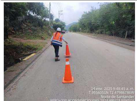
ACOMPÑAMIENTO EN LA VIA, SEÑALIZACION VIAL
