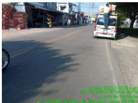
REFERENCIACION DE LA CALZADA (ANTES)
