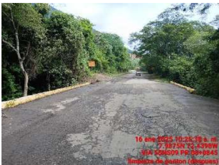
LIMPIEZA DE PONTON (DESPUES)
