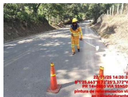
RETIRO DE ARBOL CON RIESGO (DURANTE)
