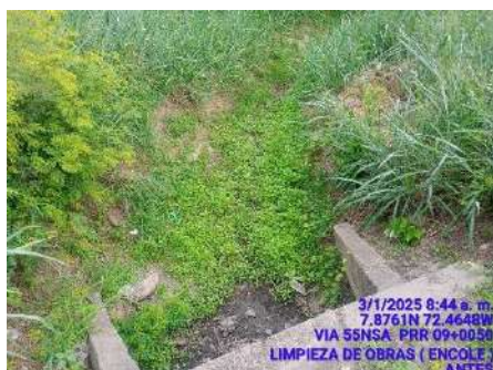
LIMPIEZA DE OBRAS (ANTES)
