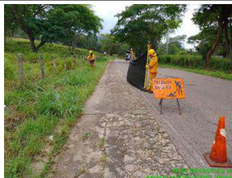
SEGUIMIENTO USO DE BARRERA DE SEGURIDAD EN LAS ACTIVIDADES DE ROCERIA.
