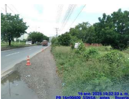
INSTALACION DE SEÑALES (ANTES)
