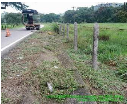
LIMPIEZA DE CUNETAS (ANTES)
