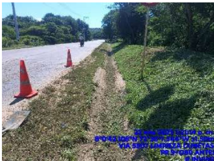
LIMPIEZA DE CUNETAS (ANTES)
