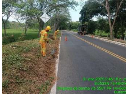
LIMPIEZA DE BERMAS (DURANTE)
