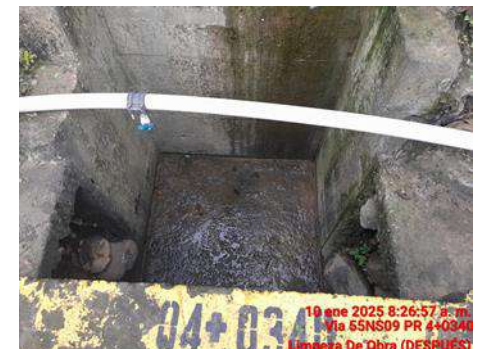
LIMPIEZA DE OBRA (DESPUES)
