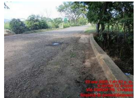
LIMPIEZA DE PONTON (DESPUES)
