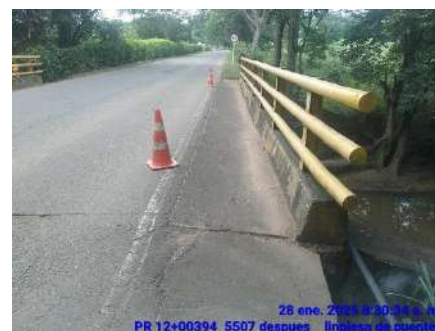
LIMPIEZA DE PUENTES (DESPUES)
