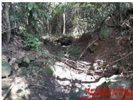
LIMPIEZA DE DESCOLE (ANTES)
