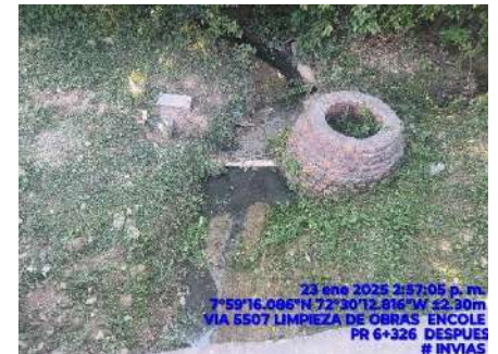
LIMPIEZA DE OBRAS (DESPUES)
