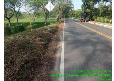
LIMPIEZA DE BERMAS (DESPUES)
