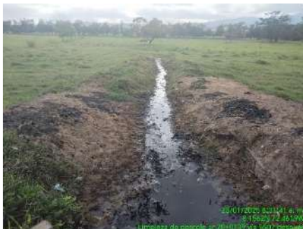
LIMPIEZA DE DESCOLE (ANTES)
