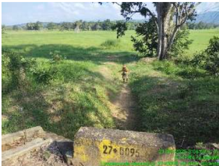
LIMPIEZA DE DESCOLE (DURANTE)
