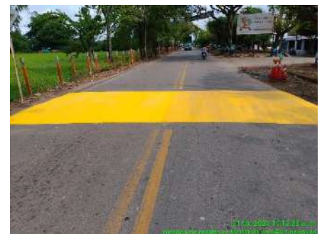
PINTURA DE RESALTOS (DESPUES)
