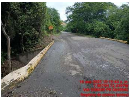
LIMPIEZA DE PONTON (ANTES)
