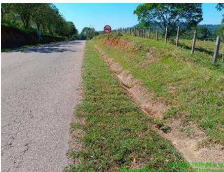
LIMPIEZA DE CUNETAS (ANTES)
