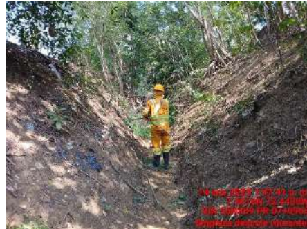
LIMPIEZA DE DESCOLE (DURANTE)
