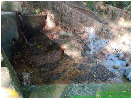
LIMPIEZA DE OBRAS (ANTES)
