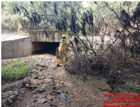
LIMPIEZA DE OBRA (ANTES)
