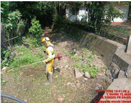
LIMPIEZA DE ENCOLE (DURANTE)
