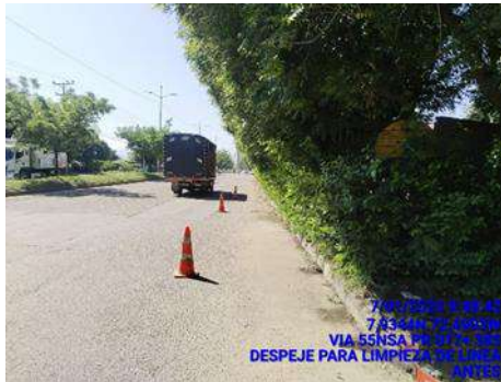
DESPEJE DE RAMAS Y LIMPIEZA (ANTES)
