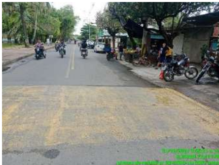
PINTURA DE RESALTOS (ANTES)
