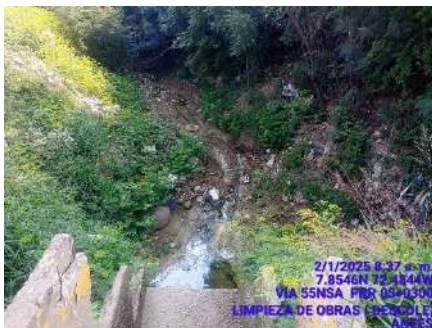
LIMPIEZA DE OBRAS (ANTES)
