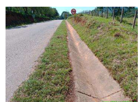
LIMPIEZA DE CUNETAS (DESPUES)
