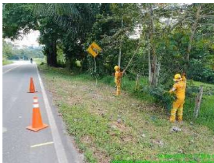
RETIRO DE ARBOL (DURANTE)
