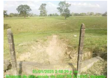
LIMPIEZA DE OBRAS (DESPUES)
