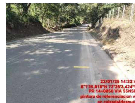
RETIRO DE ARBOL CON RIESGO (DESPUES)
