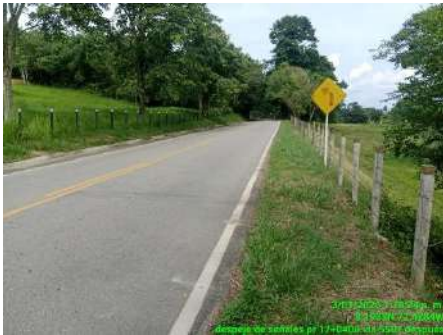
DESPEJE DE SEÑALES (DESPUES)
