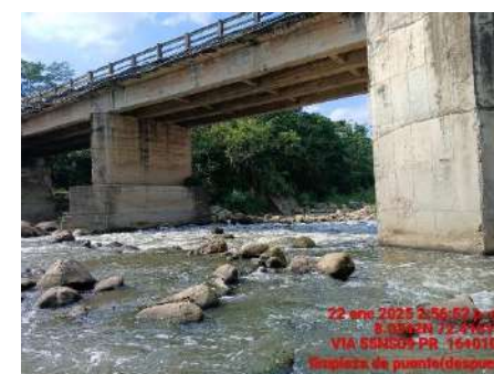
RETIRO DE ARBOL CON RIESGO (DESPUES)
