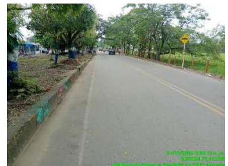
LIMPIEZA DE BERMAS (DESPUES)
