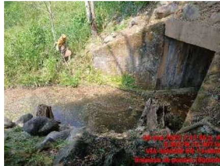
LIMPIEZA DE PONTON (DURANTE)
