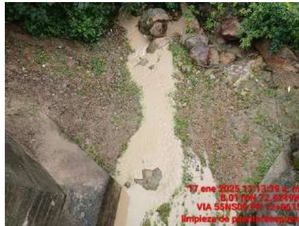
LIMPIEZA DE PONTON (DESPUES)
