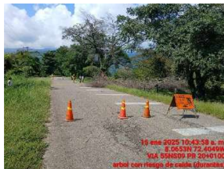
RETIRO DE ARBOL CON RIESGO (DURANTE)
