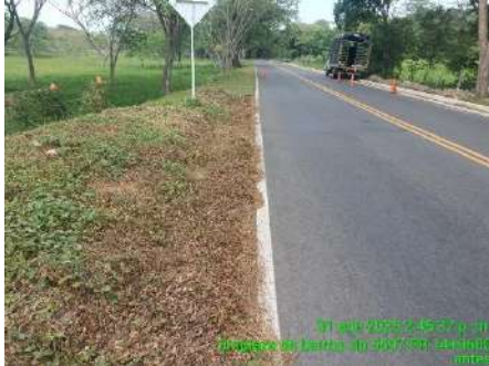
LIMPIEZA DE BERMAS (ANTES)
