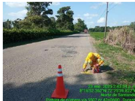
REFERENCIACION DE CALZADA (DURANTE)
