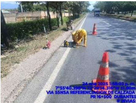
REFERENCIACION DE CALZADA (DURANTE)
