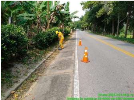
LIMPIEZA DE CUNETAS (DURANTE)
