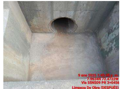
LIMPIEZA DE OBRA (DESPUES)
