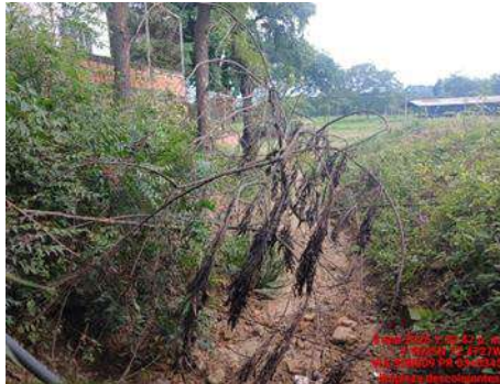
LIMPIEZA DESCOLE (ANTES)
