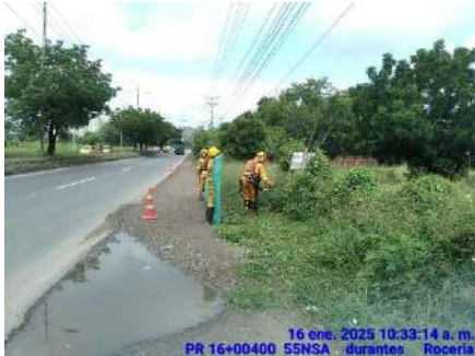
INSTALACION DE SEÑALES (DURANTE)
