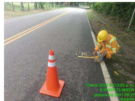
SEGUIMIENTO CORRECTA SEÑALIZACION VIAL
