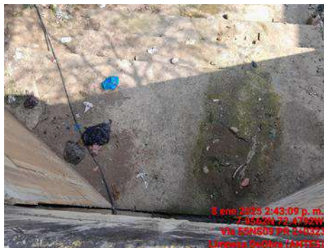
LIMPIEZA DE OBRA (ANTES)
