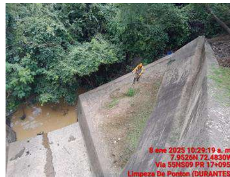
LIMPIEZA DE PONTON (DURANTE)
