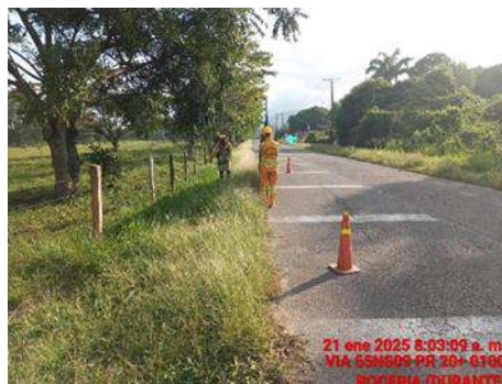
SEGUIMIENTO USO DE BARRERA DE SEGURIDAD
