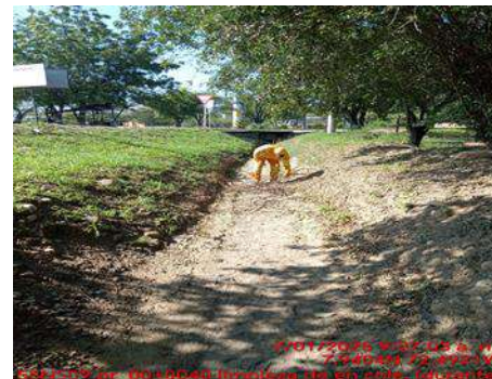
LIMPIEZA DE ENCOLE (DURANTE)
