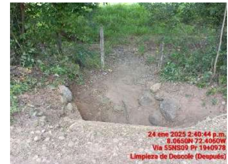
LIMPIEZA DE DESCOLE (DESPUES)
