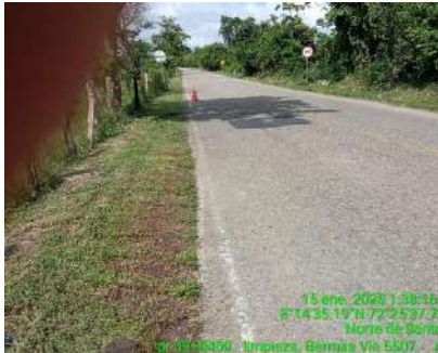
LIMPIEZA DE BERMAS (ANTES)
