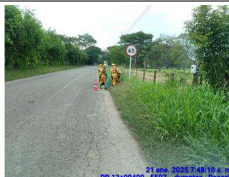
SEGUIMIENTO USO DE BARRERA DE SEGURIDAD
