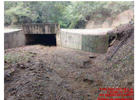
LIMPIEZA DE OBRA (DESPUES)
