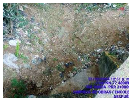
LIMPIEZA DE OBRAS (DESPUES)
