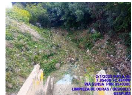
LIMPIEZA DE OBRAS (DESPUES)
