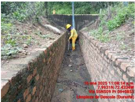
LIMPIEZA DE DESCOLE (DURANTE)
