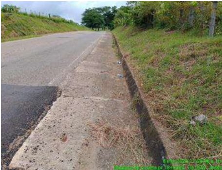
LIMPIEZA DE CUNETA (ANTES)
