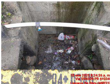
LIMPIEZA DE OBRA (ANTES)
