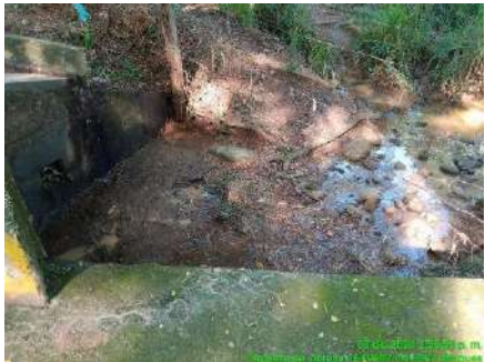
LIMPIEZA DE OBRAS (DESPUES)
