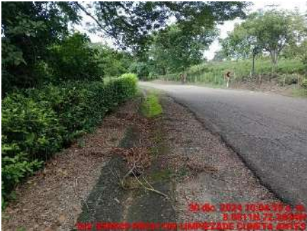
LIMPIEZA DE CUNETAS (ANTES)
