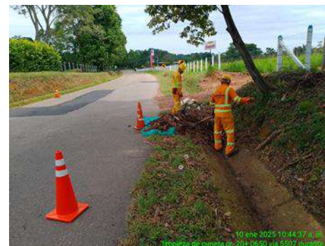
SEGUIMIENTO CORRECTA SEÑALIZACION VIAL
