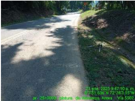
REFERENCIACION DE LA CALZADA (ANTES)
