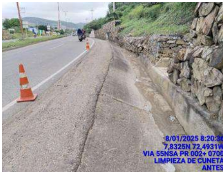
LIMPIEZA DE CUNETA (ANTES)
