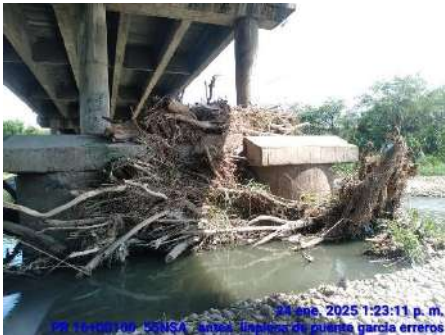
LIMPIEZA DE Puentes (ANTES)
