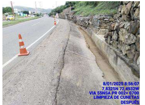
LIMPIEZA DE CUNETA (DESPUES)
