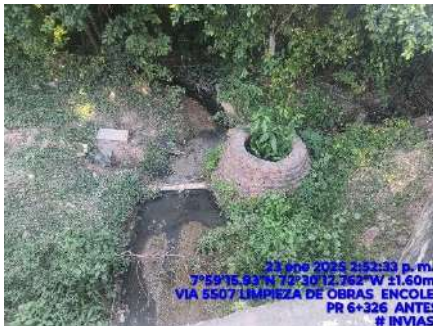
LIMPIEZA DE OBRAS (ANTES)
