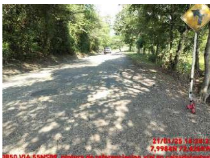
LIMPIEZA DE CUNETA (ANTES)
