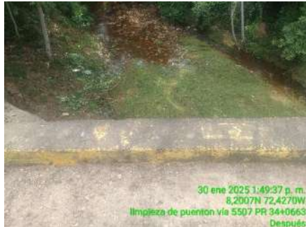
LIMPIEZA DE PONTON (DESPUES)
