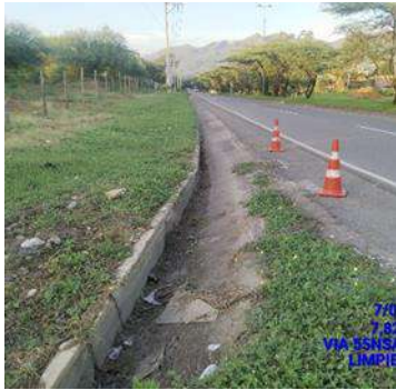
LIMPIEZA DE CUNETA (ANTES)
