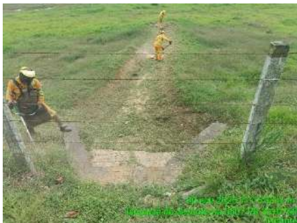
LIMPIEZA DE DESCOLE (DURANTE)
