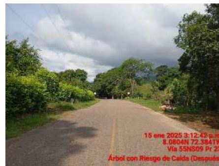
RETIRO DE ARBOL CON RIESGO (DESPUES)
