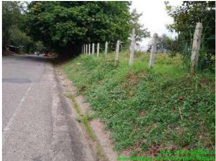
RETIRO DE SEÑAL (DESPUES)
