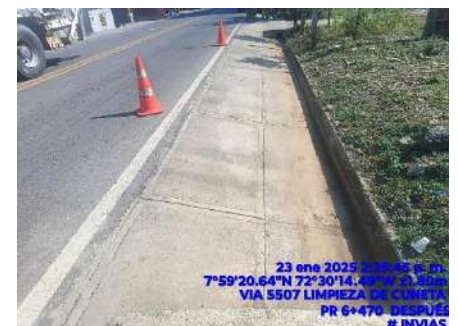
LIMPIEZA DE CUNETAS (DESPUES)
