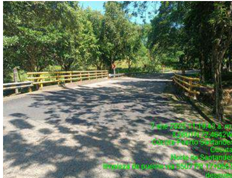
LIMPIEZA DE PUENTE (DESPUES)
