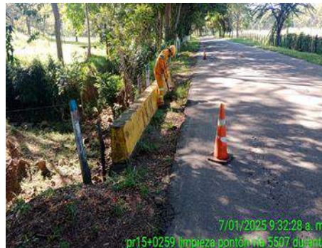
LIMPIEZA DE PONTON (DURANTE)
