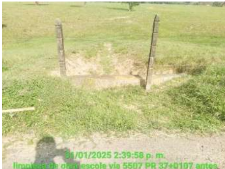
LIMPIEZA DE OBRAS (ANTES)
