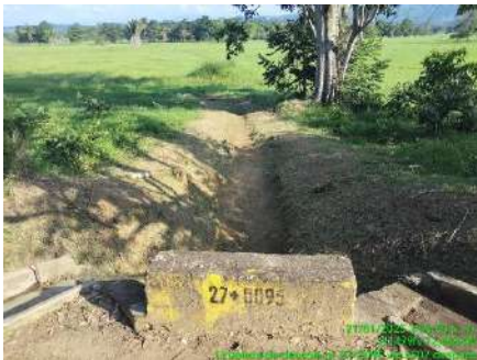
LIMPIEZA DE DESCOLE (ANTES)
