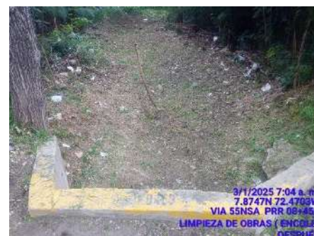
LIMPIEZA DE OBRAS (DESPUES)
