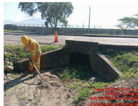
LIMPIEZA DE OBRA (DURANTE)
