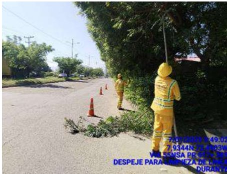
DESPEJE DE RAMAS Y LIMPIEZA (DURANTE)
