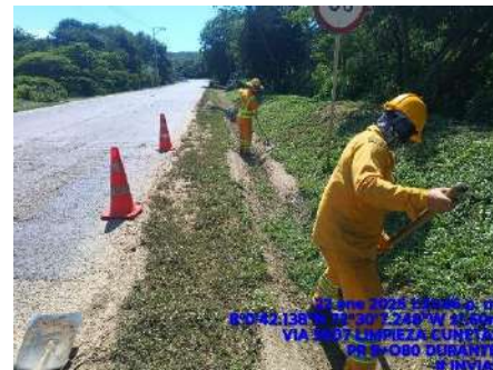
LIMPIEZA DE CUNETAS (DURANTE)
