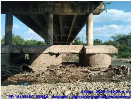
LIMPIEZA DE Puentes (DESPUES)
