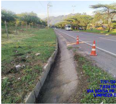
LIMPIEZA DE CUNETA (DESPUES)
