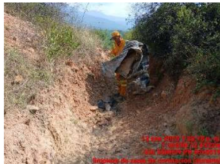
LIMPIEZA DE ZANJAS DE CORONACION (DURANTE)
