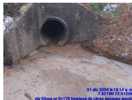
LIMPIEZA DE OBRAS (DESPUES)
