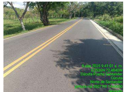
MARCACION VIAL (DESPUES)
