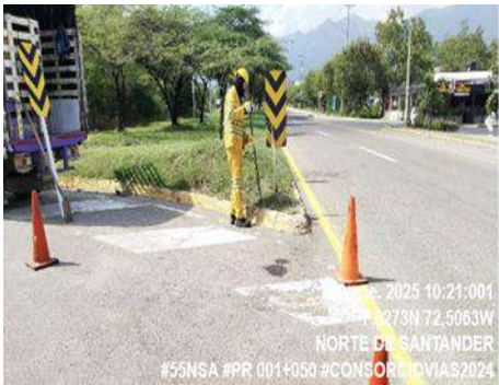
INSPECCION CORRECTO USO DE SEÑALIZACION EN ACTIVIDADES
