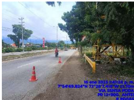
CARGADA DE VOLQUETA (ANTES)
