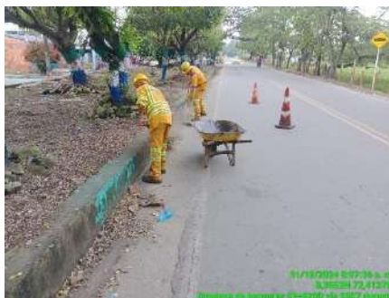
LIMPIEZA DE BERMAS (DURANTE)
