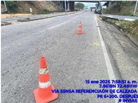
REFERENCIACION DE CALZADA (DESPUES)
