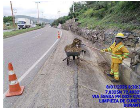
LIMPIEZA DE CUNETA (DURANTE)
