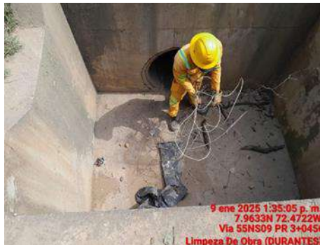
LIMPIEZA DE OBRA (DURANTE)
