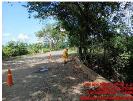
LIMPIEZA DE PONTON (DURANTE)
