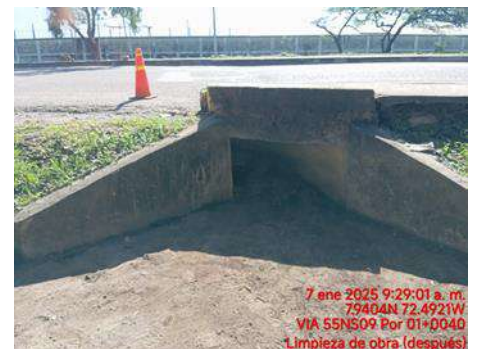
LIMPIEZA DE OBRA (DESPUES)
