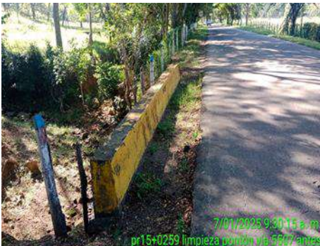
LIMPIEZA DE PONTON (ANTES)
