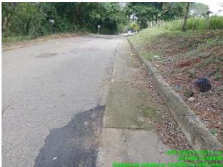
LIMPIEZA DE CUNETAS (ANTES)
