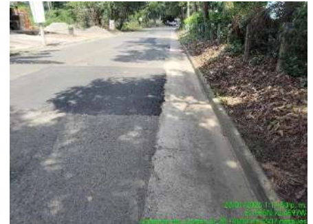
LIMPIEZA DE CUNETAS (DESPUES)
