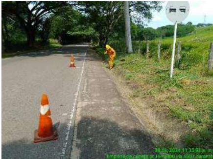
LIMPIEZA DE CUNETAS (DURANTE)
