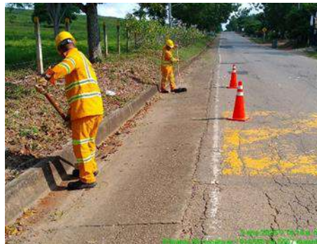
LIMPIEZA DE CUNETA (DURANTE)
