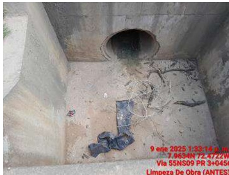
LIMPIEZA DE OBRA (ANTES)
