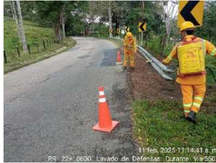
LIMPIEZA DE DEFENSA METÁLICA (DURANTE)
