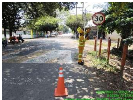
LIMPIEZA DE SEÑALES (DURANTE)
