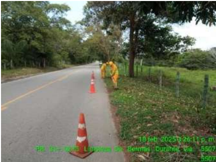
LIMPIEZA DE OBRAS (DURANTE)
