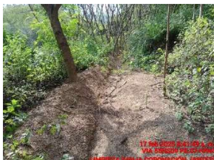
LIMPIEZA DE ZANJAS DE CORONACION (ANTES)
