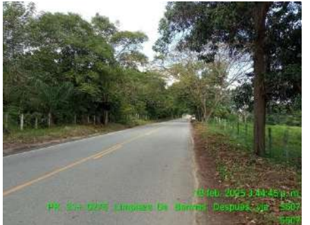
LIMPIEZA DE OBRAS (DESPUES)
