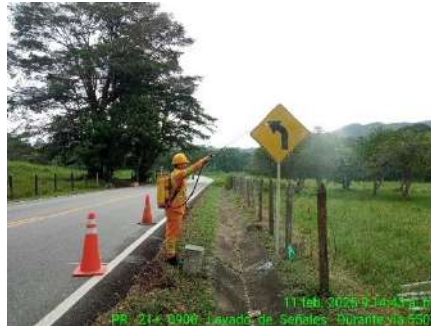
LIMPIEZA DE SEÑALES (DURANTE)
