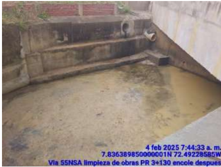
LIMPIEZA DE OBRAS (DESPUES)
