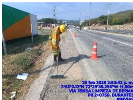
LIMPIEZA DE BERMA (DURANTE)
