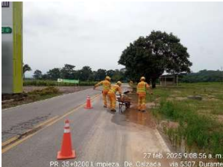
LIMPIEZA DE CALZADA (DURANTE)
