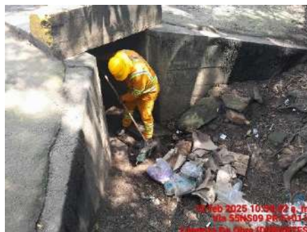
LIMPIEZA DE OBRAS (DURANTE)
