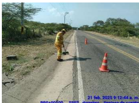
LIMPIEZA DE CUNETAS (DURANTE)
