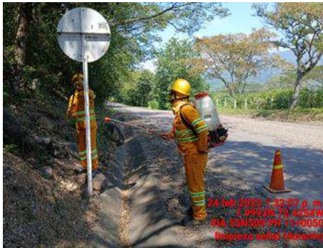
SEGUIMIENTO USO ADECUADO DE EPPS
