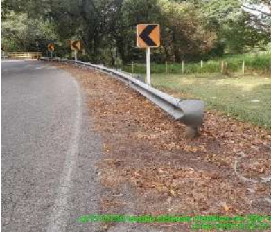
LIMPIEZA DE DEFENSAS METALICAS (DESPUES)
