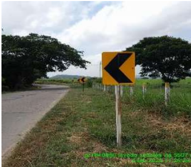
LIMPIEZA DE SEÑALES (ANTES)
