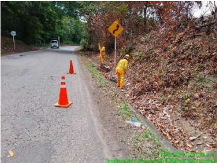
LIMPIEZA DE CUNETAS (DURANTE)
