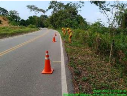
LIMPIEZA DE BERMAS (DURANTE)
