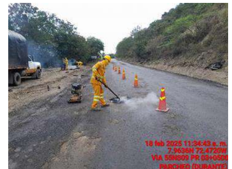
SEGUIMIENTO SEÑALIZACION VIAL ADECUADA
