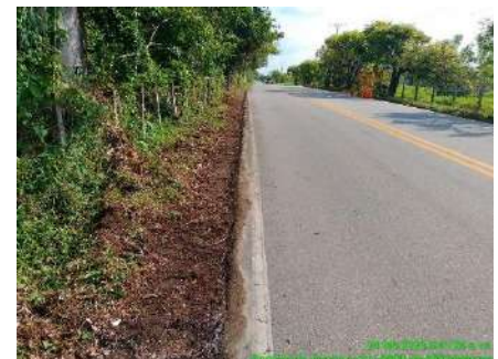
LIMPIEZA DE BERMA (DESPUES)
