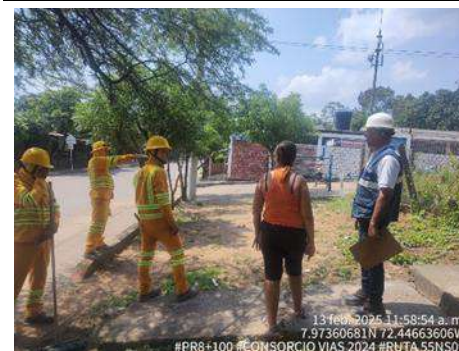
VERIFICANDO EL CUMPLIMIENTO DE LAS NORMAS SST
