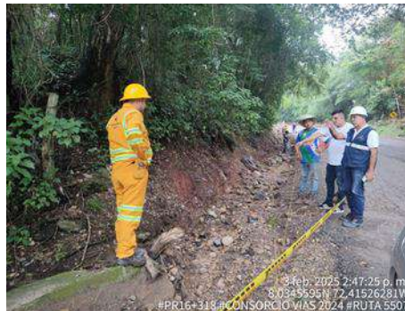
ACOMPAÑAMIENTO Y APOYO INSPECCION SITIOS CRITICOS
