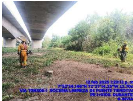
LIMPIEZA DE PUENTES (DURANTE)
