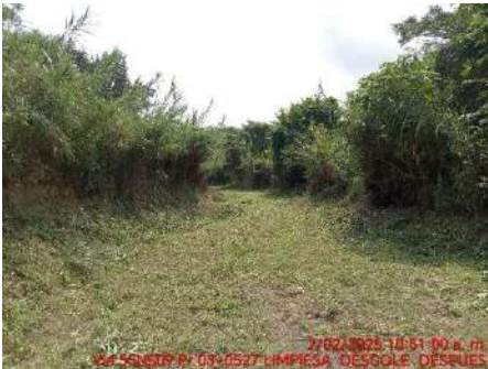
LIMPIEZA DE DESCOLE (DESPUES)
