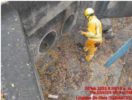
LIMPIEZA DE CALZADA (DURANTE)
