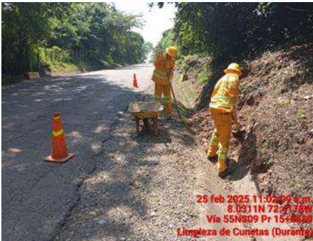
SEGUIMIENTO SEÑALIZACION VIAL ADECUADA
