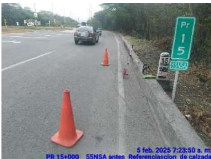
REFERENCIACION DE CALZADA (ANTES)
