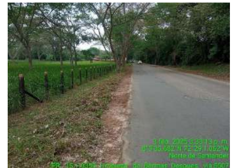
LIMPIEZA DE BERMA (DESPUES)
