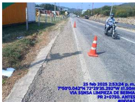
LIMPIEZA DE BERMA (ANTES)
