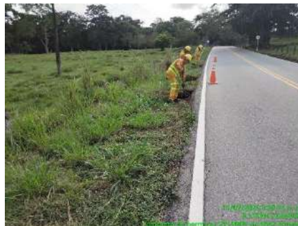
LIMPIEZA DE BERMA (DURANTE)
