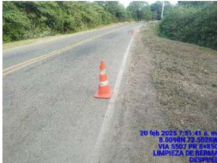
LIMPIEZA DE BERMA (DESPUES)
