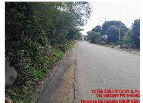
LIMPIEZA DE CUNETAS (DESPUES)
