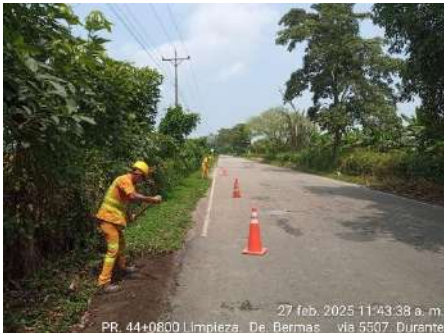
LIMPIEZA DE BERMAS (DURANTE)
