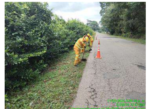
SEGUIMIENTO SEÑALIZACION VIAL ADECUADA
