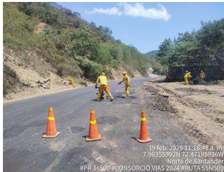
INSPECCION DEL CUMPLIMIENTO DE LAS NORMAS SST
