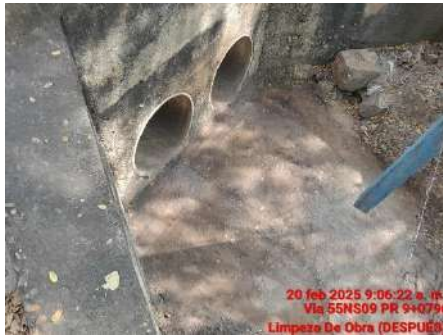
LIMPIEZA DE CALZADA (DESPUES)
