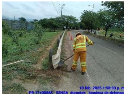
LIMPIEZA DE DEFENSAS METALICAS (DURANTE)
