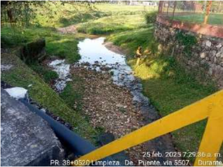
LIMPIEZA DE PUENTES (DURANTE)
