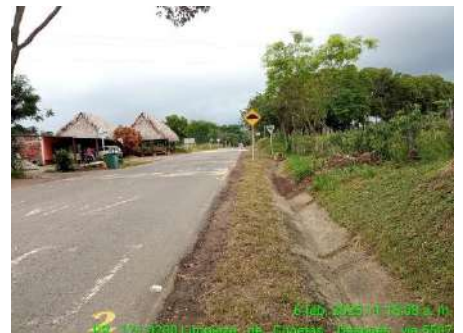
LIMPIEZA DE OBRAS (DESPUES)
