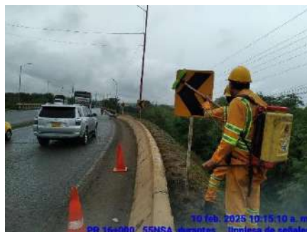
LIMPIEZA DE SEÑALES (DURANTE)
