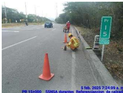
REFERENCIACION DE CALZADA (DURANTE)
