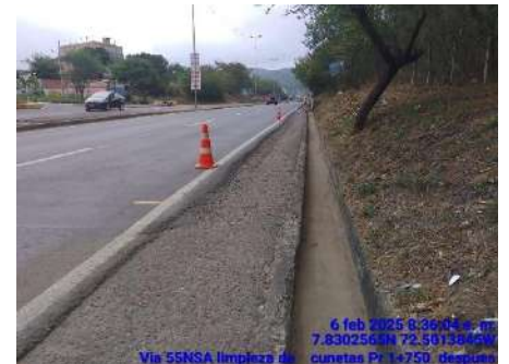
LIMPIEZA DE CUNETAS (DESPUES)
