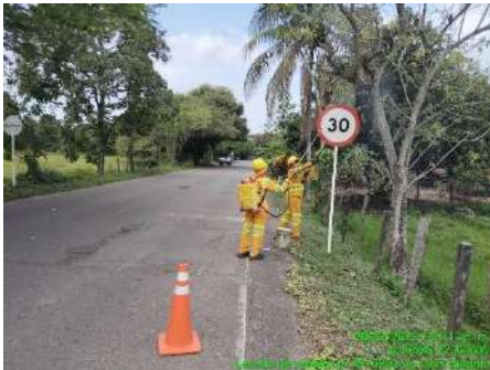
LIMPIEZA DE SEÑALES (DURANTE)
