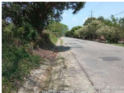
LIMPIEZA DE CUNETAS (ANTES)
