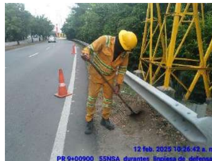
LIMPIEZA DE DEFENSAS METALICAS (DURANTE)
