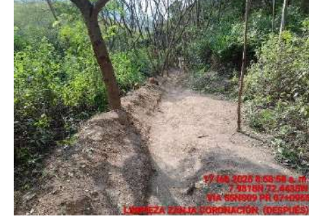
LIMPIEZA DE ZANJAS DE CORONACION (DESPUES)
