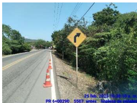
LIMPIEZA DE SEÑALES (ANTES)
