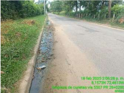
LIMPIEZA DE CUNETAS (ANTES)
