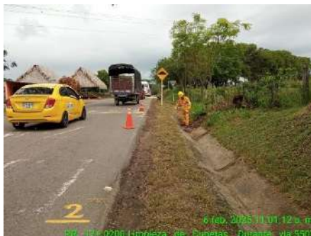
LIMPIEZA DE OBRAS (DURANTE)
