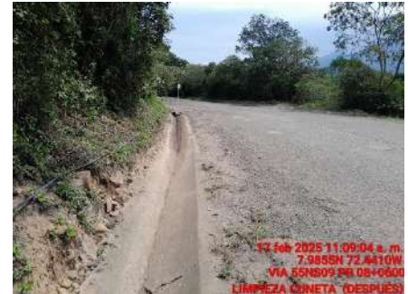
LIMPIEZA DE CUNETAS (DESPUES)
