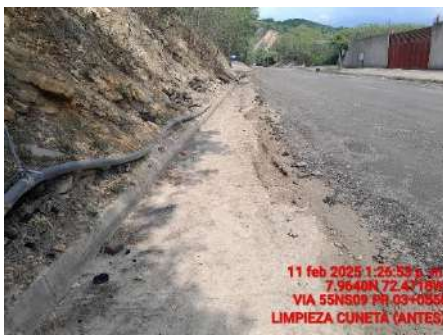
LIMPIEZA DE CUNETAS (ANTES)
