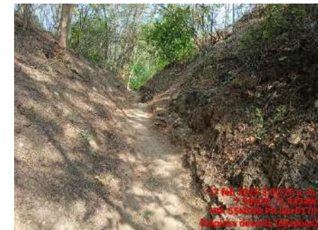
LIMPIEZA DE DESCOLE (DESPUES)
