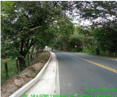
LIMPIEZA DE CUNETAS (DESPUES)
