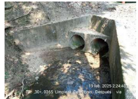
LIMPIEZA DE OBRAS (DESPUES)
