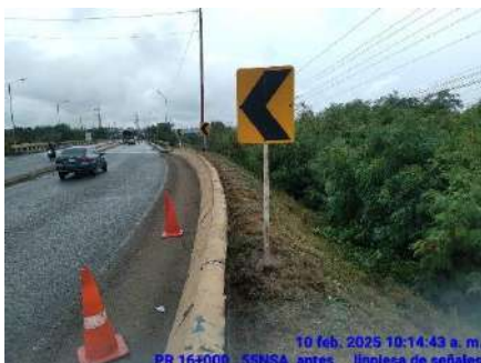
LIMPIEZA DE SEÑALES (ANTES)
