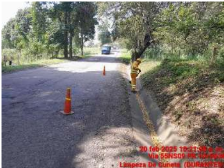
LIMPIEZA DE CUNETAS (DURANTE)
