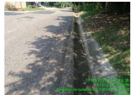
LIMPIEZA DE CUNETAS (DESPUES)
