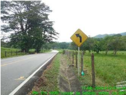
LIMPIEZA DE SEÑALES (ANTES)
