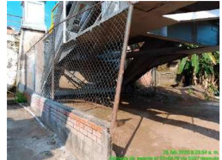
LIMPIEZA DE PUENTES (DESPUES)
