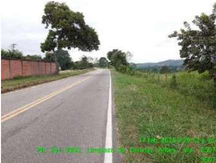
LIMPIEZA DE BERMA (ANTES)
