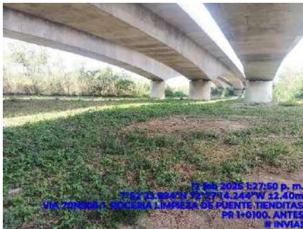
LIMPIEZA DE PUENTES (ANTES)
