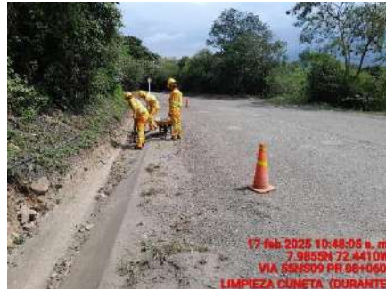
LIMPIEZA DE CUNETAS (DURANTE)
