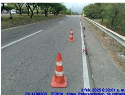
REFERENCIACION DE CALZADA (ANTES)
