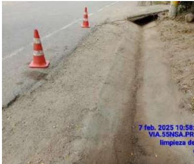
LIMPIEZA DE CUNETAS (DESPUES)
