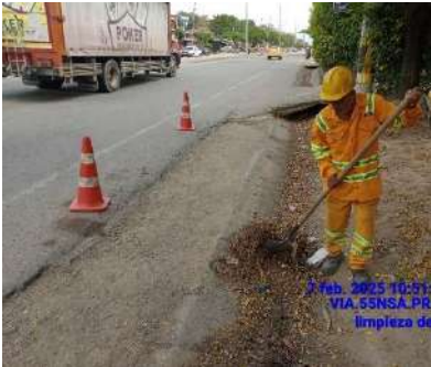
LIMPIEZA DE CUNETAS (DURANTE)
