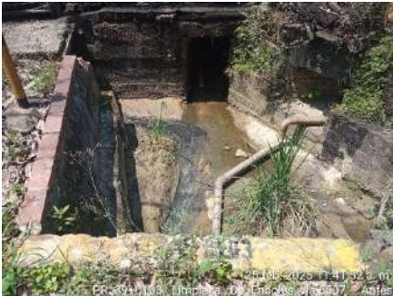
LIMPIEZA DE OBRAS (ANTES)
