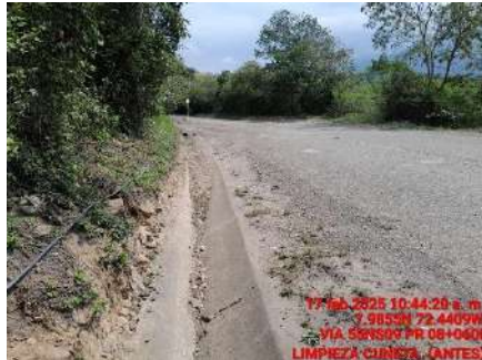
LIMPIEZA DE CUNETAS (ANTES)
