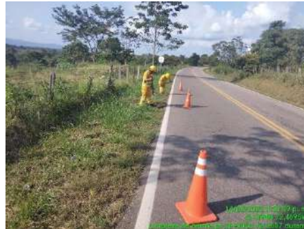
LIMPIEZA DE BERMAS (DURANTE)
