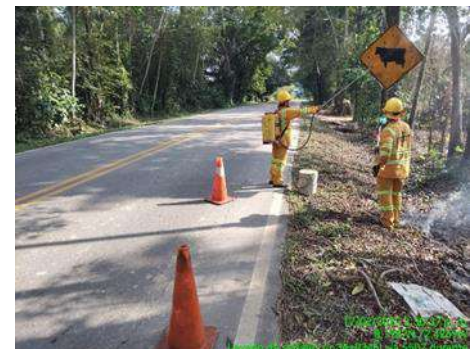
SEGUIMIENTO SEÑALIZACION VIAL ADECUADA
