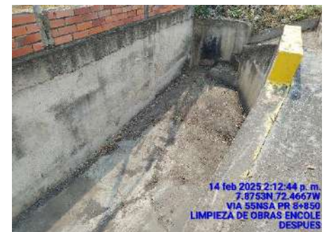
LIMPIEZA DE ENCOLE (DESPUES)
