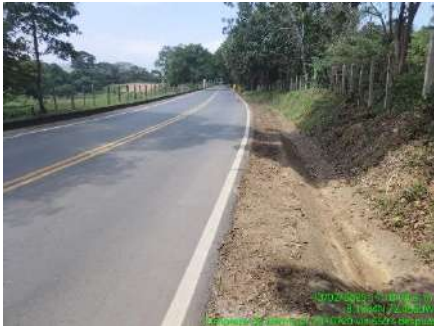
LIMPIEZA DE CUNETAS (DURANTE)
