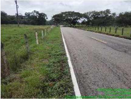
LIMPIEZA DE BERMAS (ANTES)
