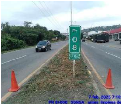
LIMPIEZA DE SEÑALES (ANTES)
