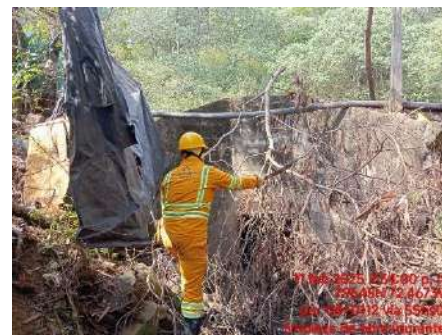
LIMPIEZA DE CUNETAS (DURANTE)
