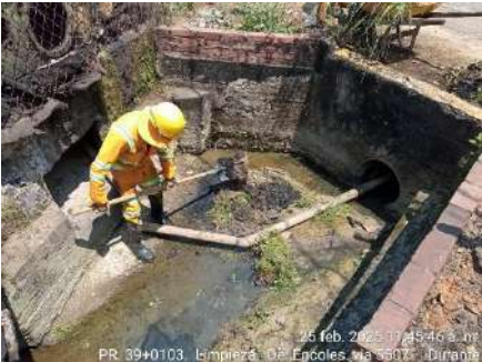
LIMPIEZA DE OBRAS (DURANTE)
