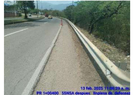
LIMPIEZA DE DEFENSAS METALICAS (DESPUES)
