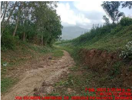
LIMPIEZA DE DESCOLE (DESPUES)
