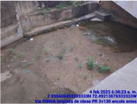
LIMPIEZA DE OBRAS (ANTES)
