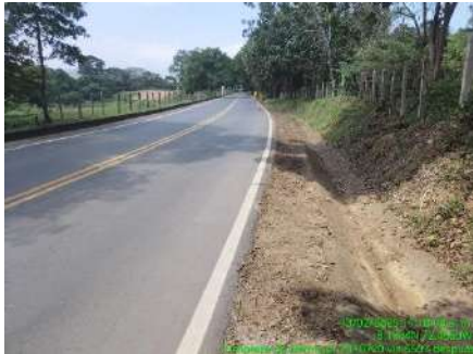
LIMPIEZA DE CUNETAS (DESPUES)
