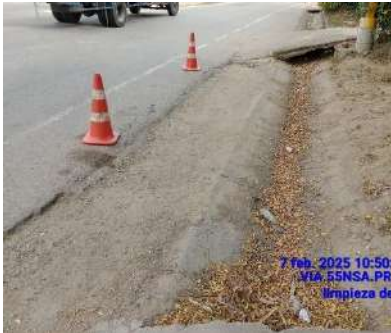
LIMPIEZA DE CUNETAS (ANTES)
