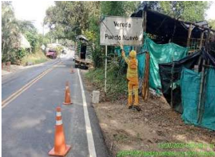
LIMPIEZA DE SEÑALES (ANTES)
