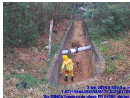
LIMPIEZA DE DESCOLE (DURANTE)
