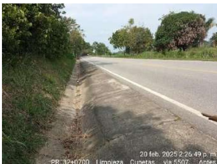
LIMPIEZA DE CUNETAS (ANTES)
