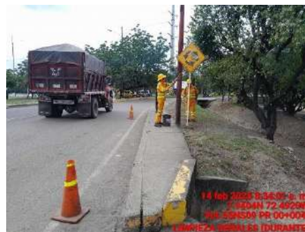
LIMPIEZA DE SEÑALES (DURANTE)
