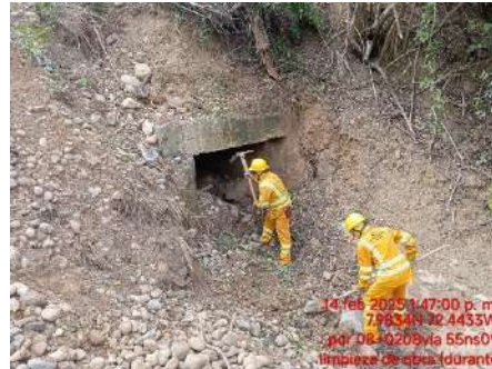
LIMPIEZA DE OBRAS (DURANTE)
