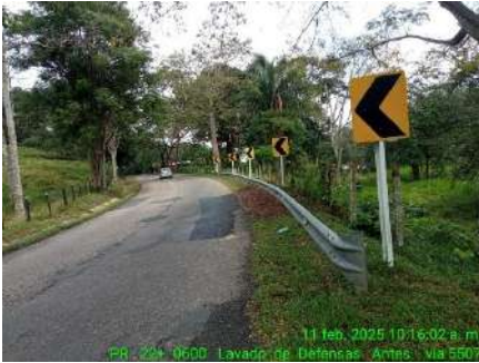
LIMPIEZA DE DEFENSA METÁLICA (ANTES)
