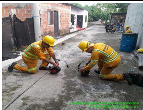
SEGUIMIENTO INSPECCION DE HERRAMIENTAS MECANICAS
