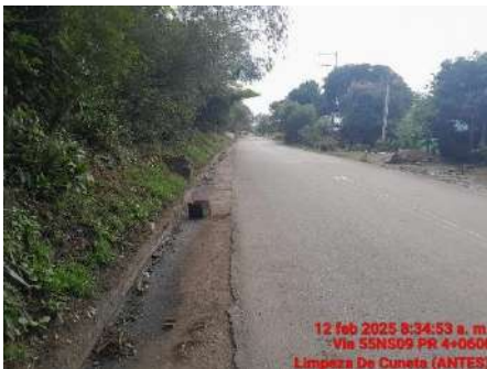
LIMPIEZA DE CUNETAS (ANTES)
