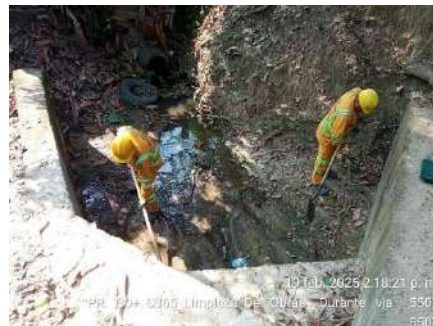
LIMPIEZA DE OBRAS (DURANTE)
