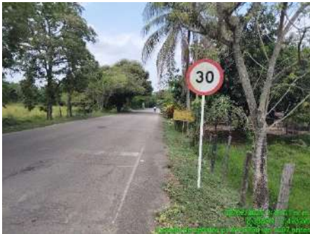
LIMPIEZA DE SEÑALES (ANTES)
