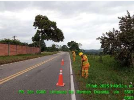
LIMPIEZA DE BERMA (DURANTE)
