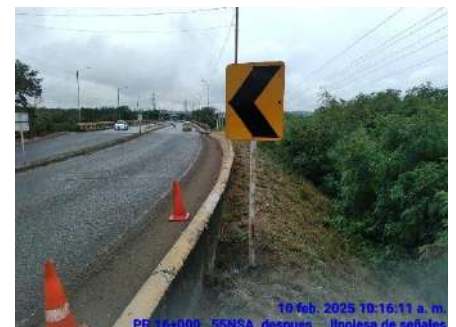
LIMPIEZA DE SEÑALES (DESPUES)
