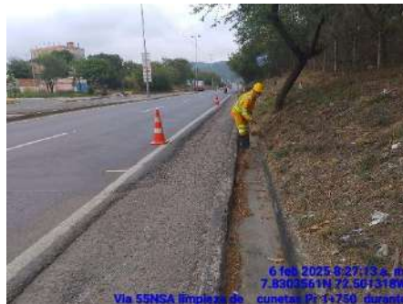
LIMPIEZA DE CUNETAS (DURANTE)
