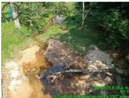
LIMPIEZA DE PONTON (ANTES)
