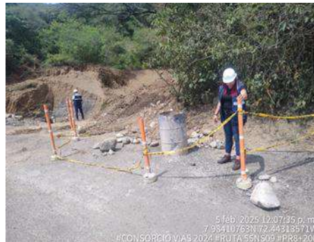
INSPECCION DE SEÑALIZACION EN LA VIA
