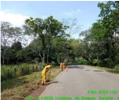
LIMPIEZA DE BERMAS (DURANTE)
