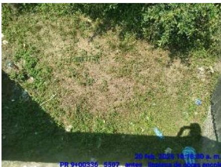
LIMPIEZA DE ENCOLE (ANTES)
