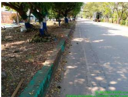
LIMPIEZA DE CUNETAS (ANTES)
