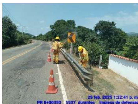
LIMPIEZA DE DEFENSAS METALICAS (DURANTE)
