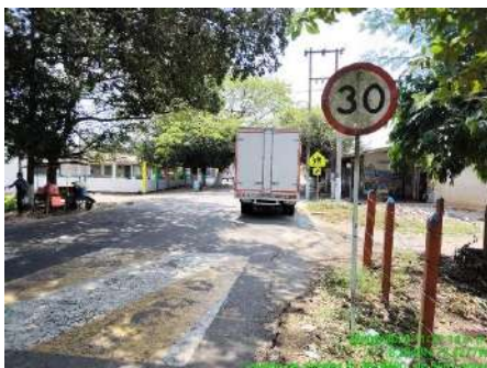
LIMPIEZA DE SEÑALES (ANTES)
