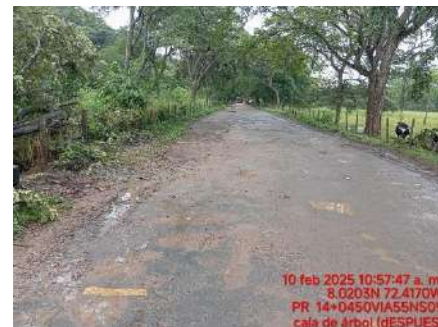
RETIRO DE ARBOL (DESPUES)
