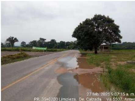
LIMPIEZA DE CALZADA (ANTES)
