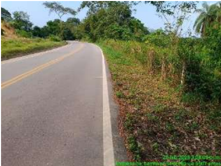
LIMPIEZA DE BERMAS (ANTES)
