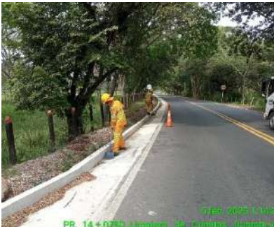
LIMPIEZA DE CUNETAS (DURANTE)
