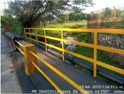
LIMPIEZA DE PUENTES (ANTES)
