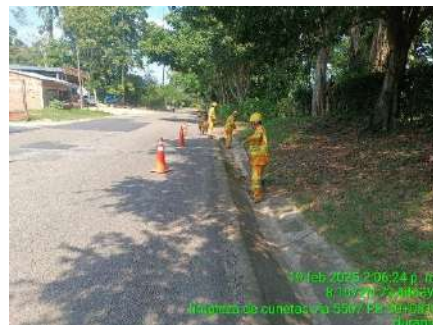
LIMPIEZA DE CUNETAS (DURANTE)
