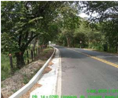
LIMPIEZA DE CUNETAS (ANTES)
