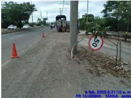
RETIRO DE SEÑAL (ANTES)
