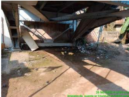
LIMPIEZA DE PUENTES (ANTES)
