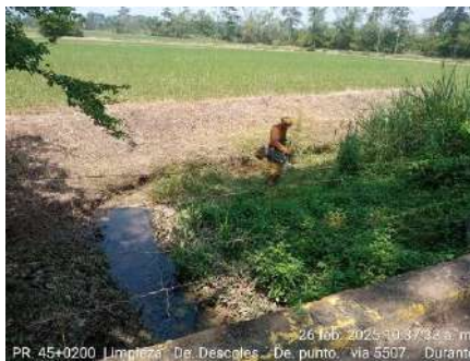
LIMPIEZA DE DESCOLE (DURANTE)
