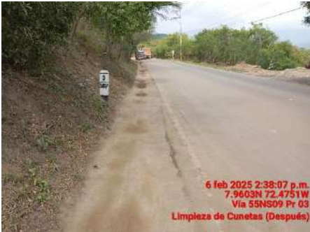
LIMPIEZA DE CUNETAS (DESPUES)
