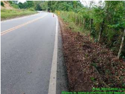
LIMPIEZA DE BERMAS (DESPUES)
