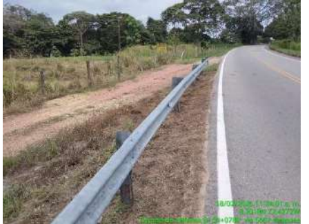
LIMPIEZA DE DEFENSAS METALICAS (DESPUES)
