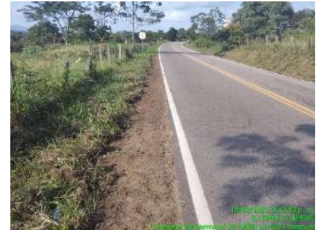
LIMPIEZA DE BERMAS (DESPUES)
