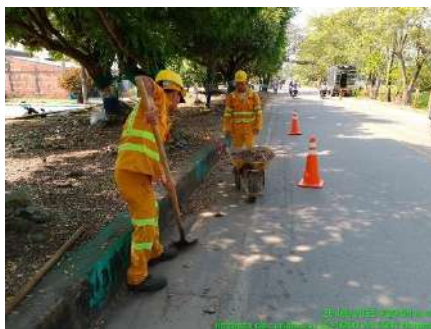
LIMPIEZA DE CUNETAS (DURANTE)
