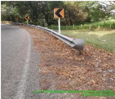
LIMPIEZA DE DEFENSAS METALICAS (ANTES)
