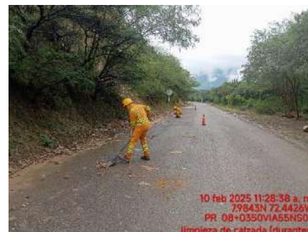
LIMPIEZA DE CALZADA (DURANTE)
