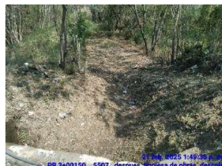
LIMPIEZA DE DESCOLE (DESPUES)
