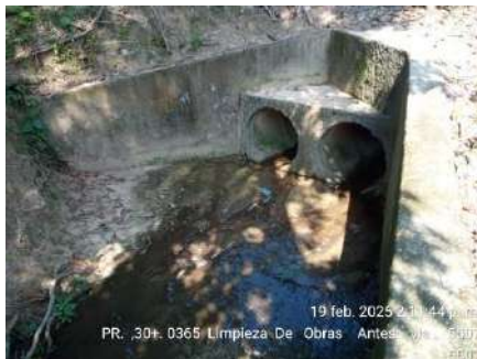
LIMPIEZA DE OBRAS (ANTES)
