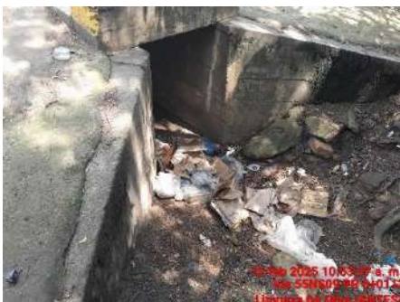
LIMPIEZA DE OBRAS (ANTES)
