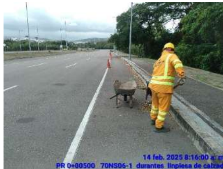
LIMPIEZA DE CALZADAS (DURANTE)
