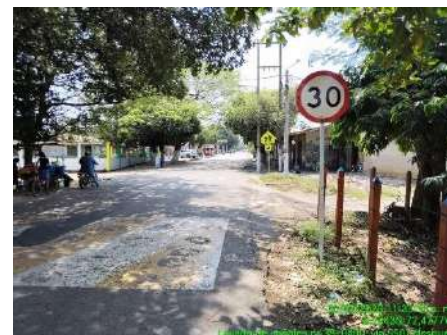
LIMPIEZA DE SEÑALES (DESPUES)
