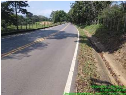
LIMPIEZA DE CUNETAS (ANTES)
