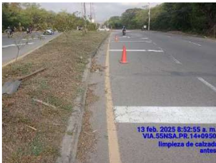
LIMPIEZA DE CALZADAS (ANTES)
