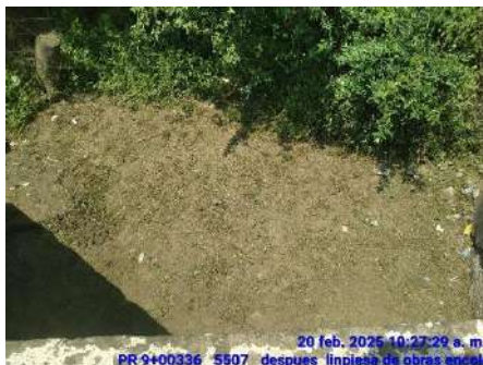
LIMPIEZA DE ENCOLE (DESPUES)
