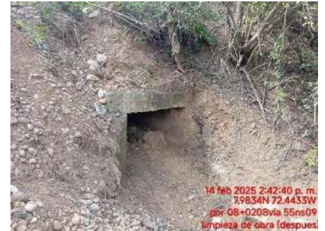
LIMPIEZA DE OBRAS (DESPUES)
