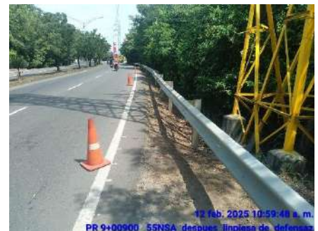
LIMPIEZA DE DEFENSAS METALICAS (DESPUES)
