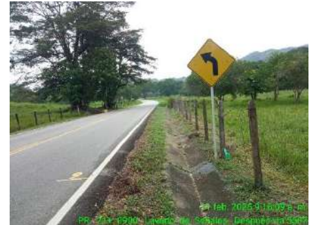
LIMPIEZA DE SEÑALES (DESPUES)
