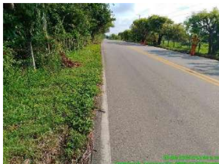
LIMPIEZA DE BERMA (ANTES)
