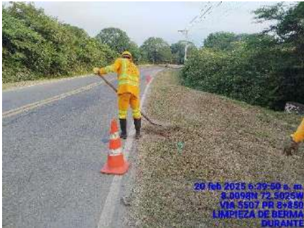
LIMPIEZA DE BERMA (DURANTE)
