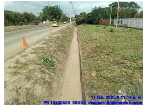
LIMPIEZA DE CUNETAS (DESPUES)
