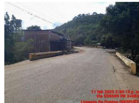
LIMPIEZA DE PONTON (DESPUES)
