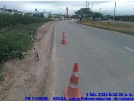
REFERENCIACION DE CALZADA (ANTES)
