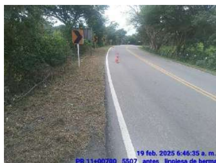
LIMPIEZA DE BERMAS (ANTES)
