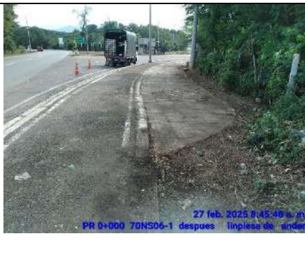
LIMPIEZA DE ANDENES (DESPUES)
