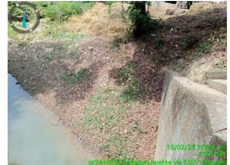
LIMPIEZA DE PUENTES (DESPUES)
