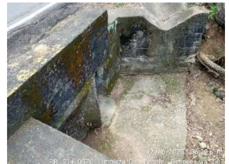
LIMPIEZA DE ENCOLE (DESPUES)
