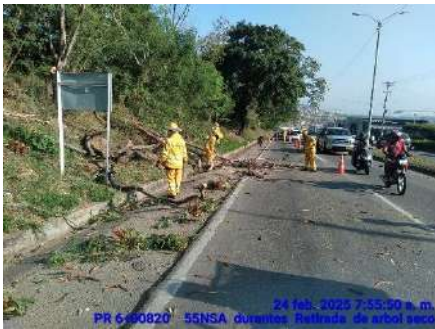
RETIRO DE ARBOL (DURANTE)
