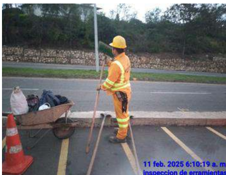
SEGUIMIENTO INSPECCION DE HERRAMIENTAS MANUALES
