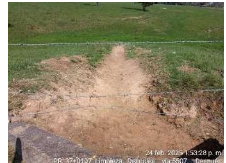
LIMPIEZA DE ENCOLE (DESPUES)
