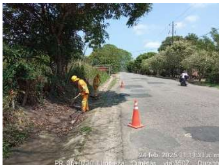
LIMPIEZA DE CUNETAS (DURANTE)
