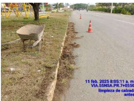
LIMPIEZA DE CALZADA (ANTES)
