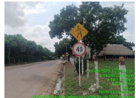
LIMPIEZA DE SEÑALES (DESPUES)
