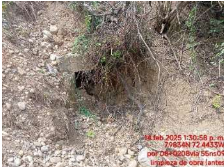
LIMPIEZA DE OBRAS (ANTES)
