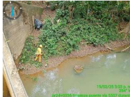
LIMPIEZA DE PUENTES (DURANTE)
