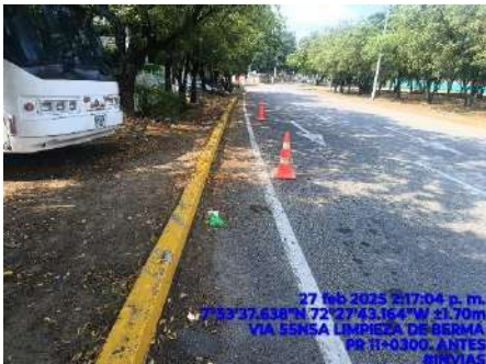
LIMPIEZA DE BERMAS (ANTES)
