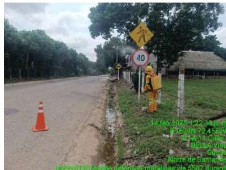
LIMPIEZA DE SEÑALES (DURANTE)
