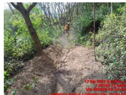
LIMPIEZA DE ZANJAS DE CORONACION (DURANTE)
