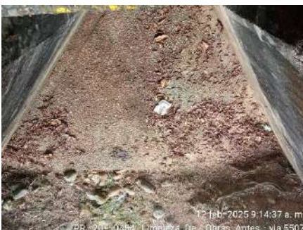
LIMPIEZA DE OBRAS (ANTES)
