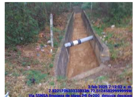
LIMPIEZA DE DESCOLE (DESPUES)
