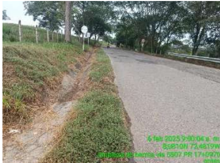
LIMPIEZA DE BERMAS (ANTES)
