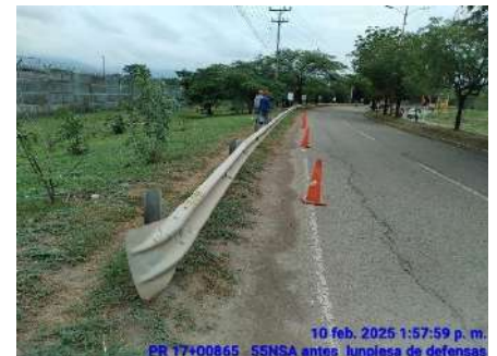
LIMPIEZA DE DEFENSAS METALICAS (DESPUES)
