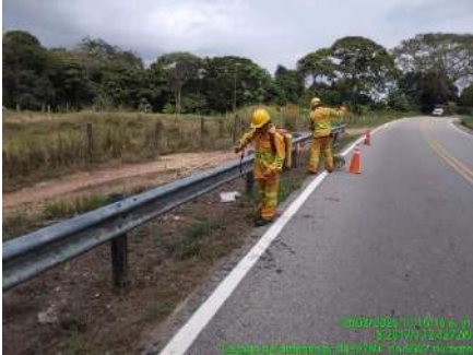
LIMPIEZA DE DEFENSAS METALICAS (DURANTE)
