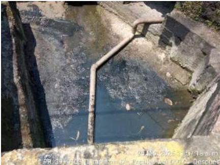
LIMPIEZA DE OBRAS (DESPUES)
