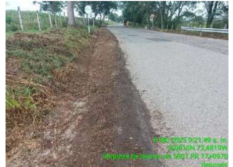
LIMPIEZA DE BERMAS (DESPUES)
