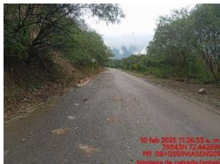
LIMPIEZA DE CALZADA (ANTES)
