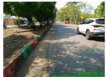
LIMPIEZA DE CUNETAS (DESPUES)
