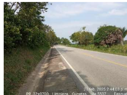
LIMPIEZA DE CUNETAS (DESPUES)
