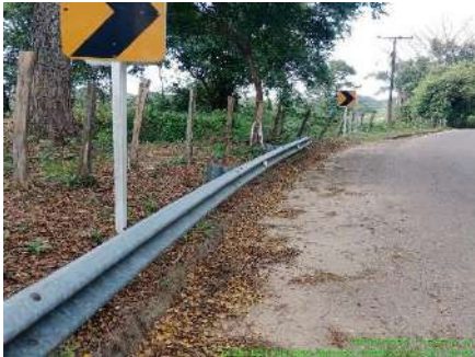
LIMPIEZA DE DEFENSAS METALICAS (ANTES)
