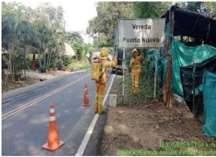
LIMPIEZA DE SEÑALES (DURANTE)
