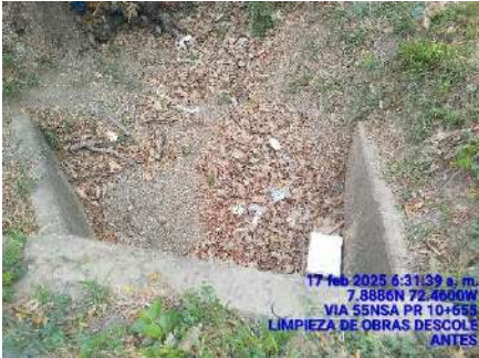
LIMPIEZA DE OBRAS (ANTES)
