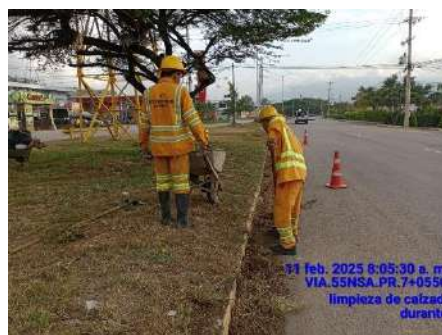
LIMPIEZA DE CALZADA (DURANTE)
