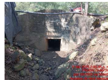
LIMPIEZA DE OBRAS (DESPUES)
