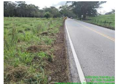
LIMPIEZA DE BERMA (DESPUES)
