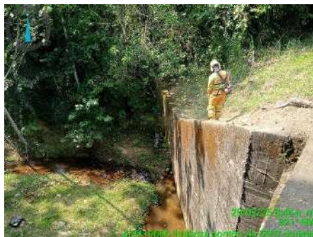
LIMPIEZA DE PONTON (DURANTE)
