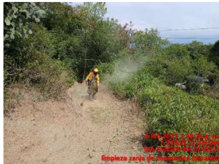
LIMPIEZA DE ZANJA DE CORONACION (DURANTE)
