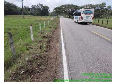
LIMPIEZA DE BERMAS (DESPUES)
