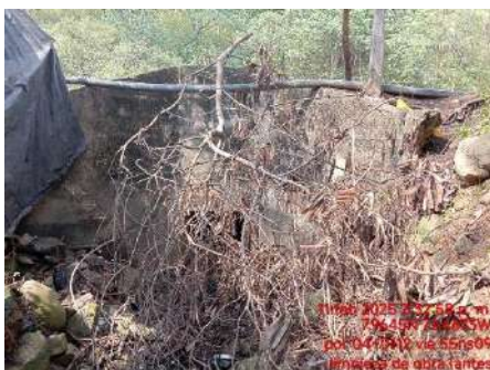
LIMPIEZA DE OBRAS (ANTES)
