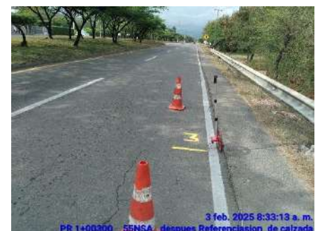
REFERENCIACION DE CALZADA (DESPUES)
