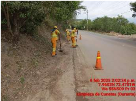
LIMPIEZA DE CUNETAS (DURANTE)
