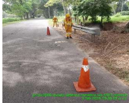
LIMPIEZA DE DEFENSA METALICA (DURANTE)
