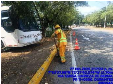
LIMPIEZA DE BERMAS (DURANTE)
