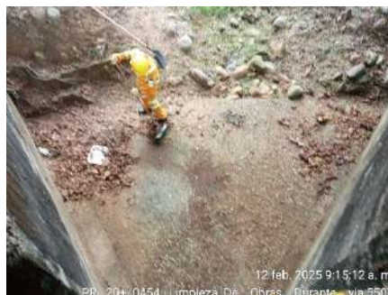
LIMPIEZA DE OBRAS (DURANTE)
