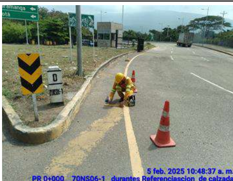
SEGUIMIENTO CORRECTA SEÑALIZACION VIAL
