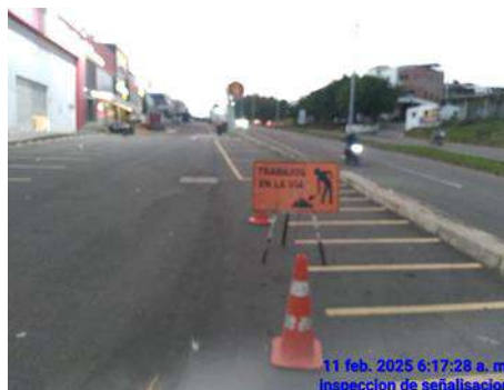
SEGUIMIENTO INSPECCION DE SEÑALES, LIMPIEZA, FUNCIONALIDAD
