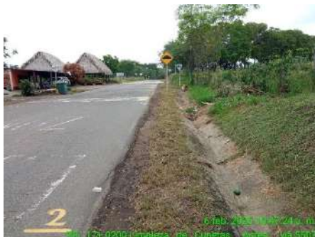
LIMPIEZA DE OBRAS (ANTES)
