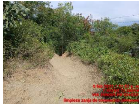
LIMPIEZA DE ZANJA DE CORONACION (DESPUES)
