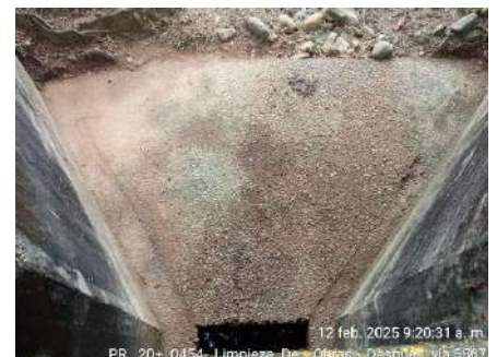
LIMPIEZA DE OBRAS (DESPUES)
