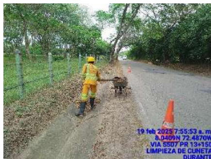
LIMPIEZA DE CUENTAS (DURANTE)
