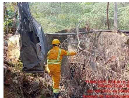
LIMPIEZA DE OBRAS (DURANTE)
