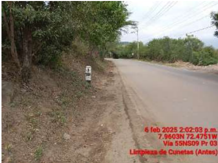
LIMPIEZA DE CUNETAS (ANTES)
