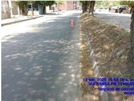
LIMPIEZA DE CALZADAS (ANTES)
