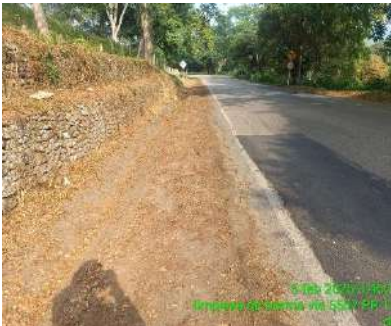
LIMPIEZA DE BERMA (DESPUES)
