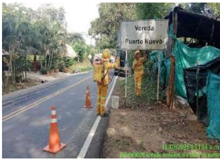
LIMPIEZA DE SEÑALES (DESPUES)
