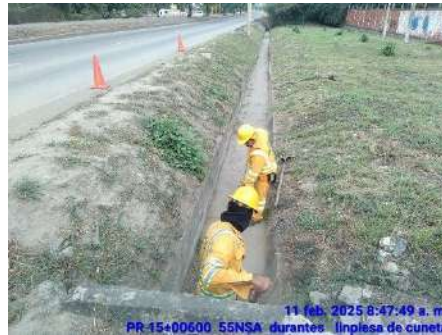
LIMPIEZA DE CUNETAS (DURANTE)
