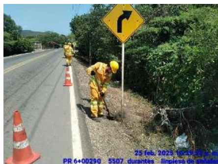
LIMPIEZA DE SEÑALES (DURANTE)
