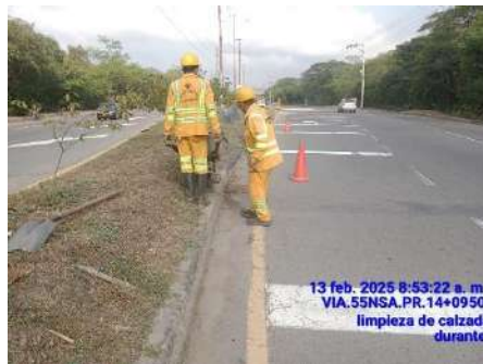
LIMPIEZA DE CALZADAS (DURANTE)
