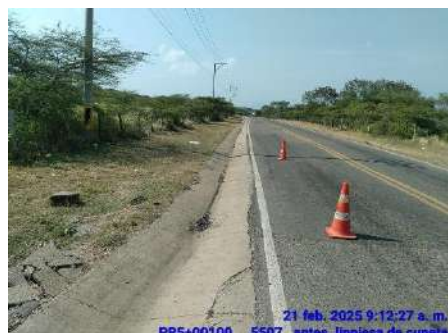
LIMPIEZA DE CUNETAS (ANTES)
