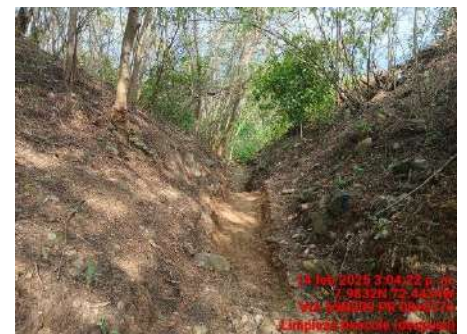
LIMPIEZA DE DESCOLES (DESPUES)
