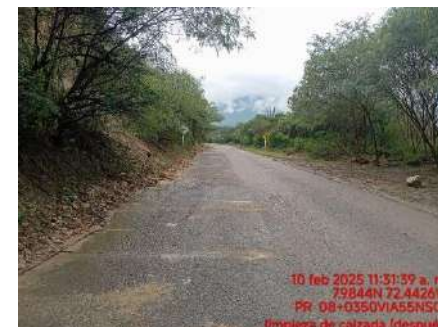
LIMPIEZA DE CALZADA (DESPUES)
