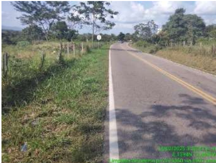
LIMPIEZA DE BERMAS (ANTES)
