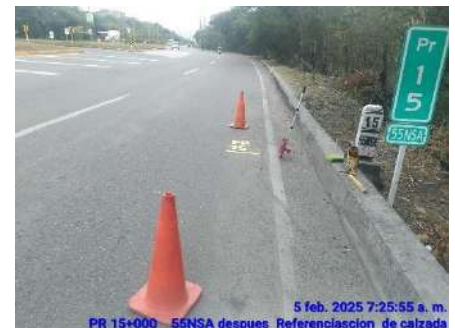
REFERENCIACION DE CALZADA (DESPUES)
