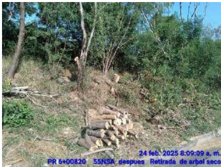
RETIRO DE ARBOL (DESPUES)
