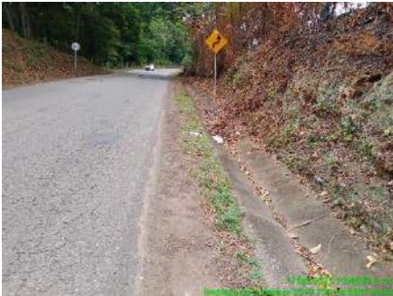
LIMPIEZA DE CUNETAS (ANTES)
