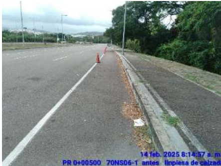
LIMPIEZA DE CALZADAS (ANTES)
