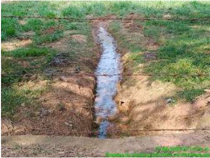
LIMPIEZA DE ENCOLE (DESPUES)
