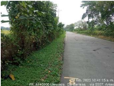
LIMPIEZA DE BERMAS (ANTES)
