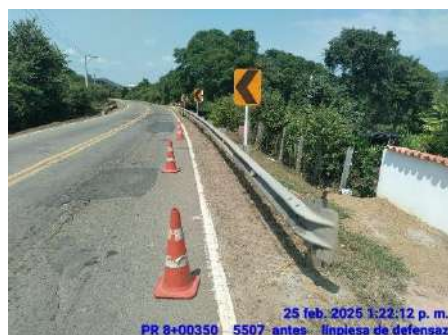
LIMPIEZA DE DEFENSAS METALICAS (ANTES)
