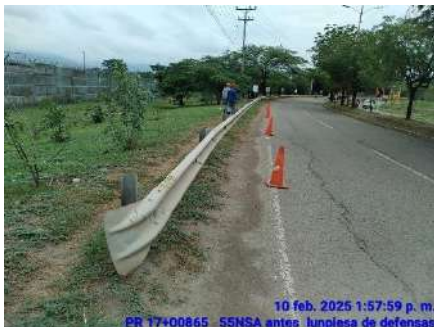
LIMPIEZA DE DEFENSAS METALICAS (ANTES)
