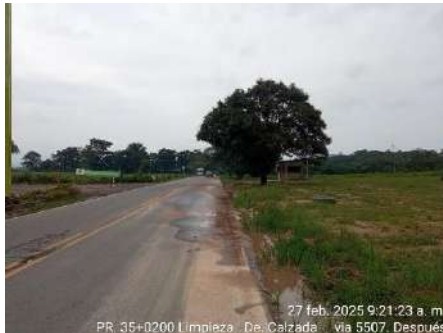
LIMPIEZA DE CALZADA (DESPUES)
