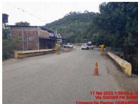
LIMPIEZA DE PONTON (DURANTE)
