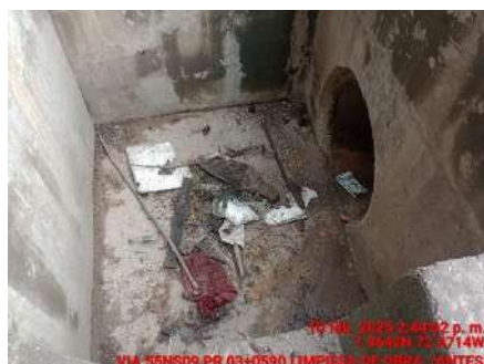
LIMPIEZA DE OBRA (ANTES)
