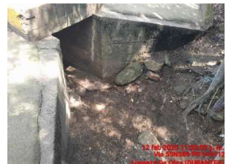
LIMPIEZA DE OBRAS (DESPUES)
