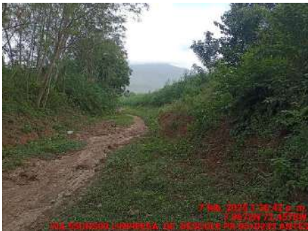
LIMPIEZA DE DESCOLE (ANTES)
