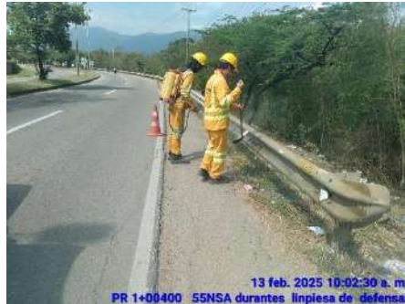
LIMPIEZA DE DEFENSAS METALICAS (DURANTE)
