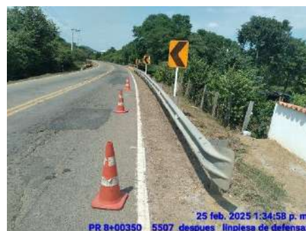
LIMPIEZA DE DEFENSAS METALICAS (DESPUES)
