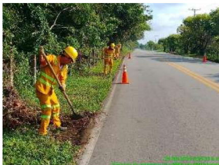
LIMPIEZA DE BERMA (DURANTE)
