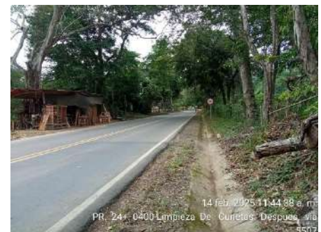
LIMPIEZA DE CUNETAS (DESPUES)
