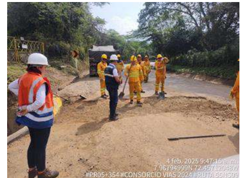
INSPECCION DE SEGURIDAD EN LA VIA
