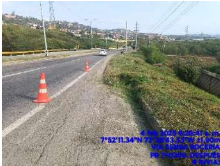
REFERENCIACION DE CALZADA (DESPUES)
