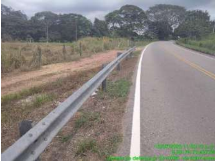
LIMPIEZA DE DEFENSAS METALICAS (ANTES)
