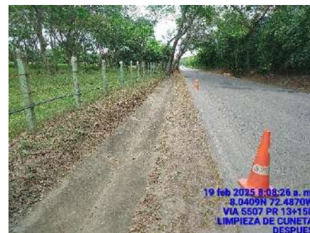
LIMPIEZA DE CUNETAS (DESPUES)
