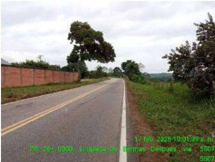
LIMPIEZA DE BERMA (DESPUES)
