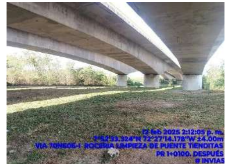
LIMPIEZA DE PUENTES (DESPUES)
