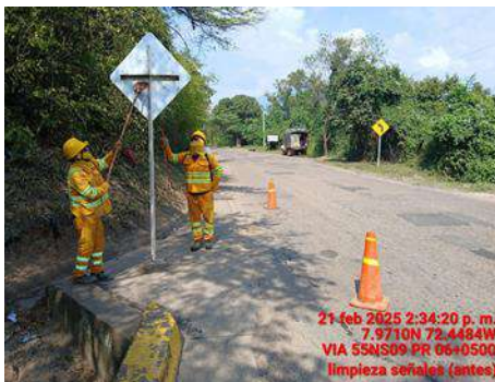
SEGUIMIENTO USO ADECUADO DE EPPS
