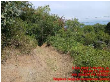
LIMPIEZA DE ZANJA DE CORONACION (ANTES)
