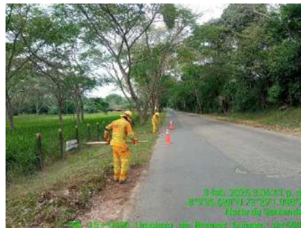
LIMPIEZA DE BERMA (DURANTE)
