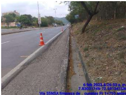
LIMPIEZA DE CUNETAS (ANTES)
