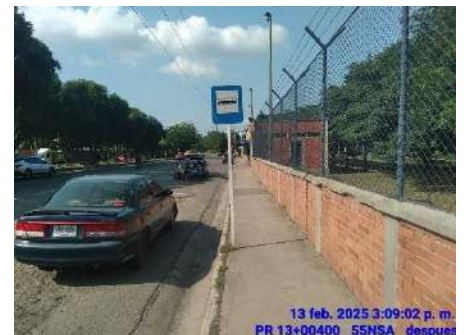
ARREGLO DE SEÑAL (DESPUES)
