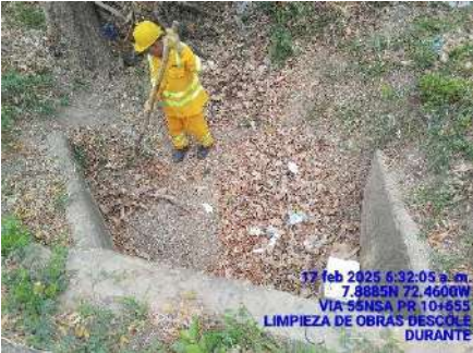
LIMPIEZA DE OBRAS (DURANTE)
