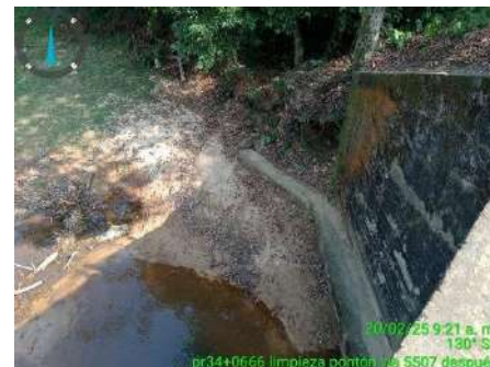
LIMPIEZA DE PONTON (DESPUES)
