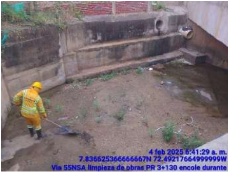
LIMPIEZA DE OBRAS (DURANTE)
