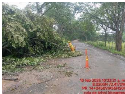
RETIRO DE ARBOL (DURANTE)
