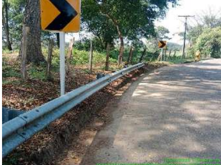
LIMPIEZA DE DEFENSAS METALICAS (DESPUES)
