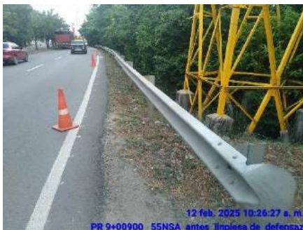
LIMPIEZA DE DEFENSAS METALICAS (ANTES)
