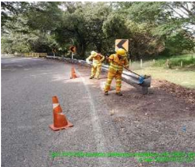
LIMPIEZA DE DEFENSAS METALICAS (DURANTE)
