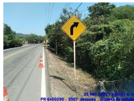
LIMPIEZA DE SEÑALES (DESPUES)
