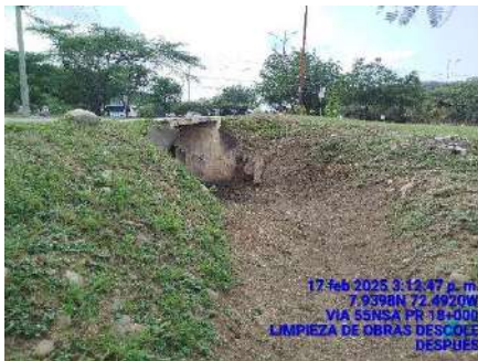
LIMPIEZA DE DESCOLE (DESPUES)
