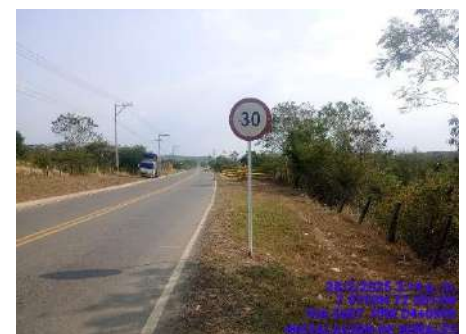
LIMPIEZA DE BERMAS (DESPUES)
