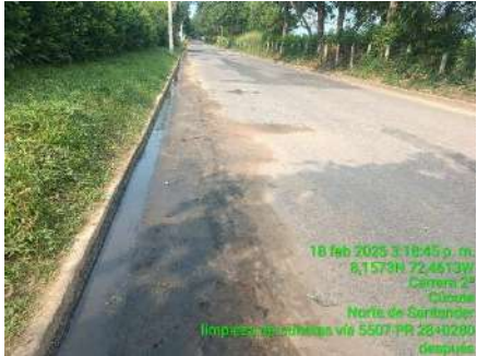
LIMPIEZA DE CUNETAS (DESPUES)
