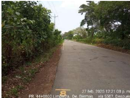
LIMPIEZA DE BERMAS (DESPUES)
