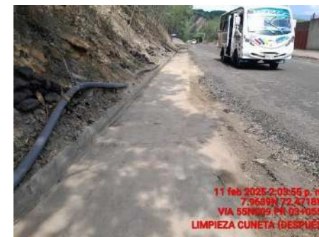
LIMPIEZA DE CUNETAS (DESPUES)
