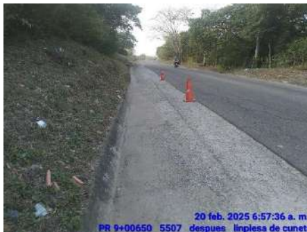
LIMPIEZA DE CUNETAS (DESPUES)
