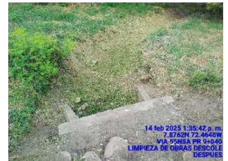
LIMPIEZA DE DESCOLE (DESPUES)
