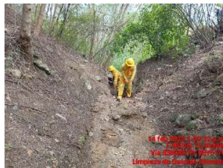
LIMPIEZA DE DESCOLES (DURANTE)
