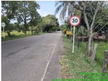
LIMPIEZA DE SEÑALES (DESPUES)
