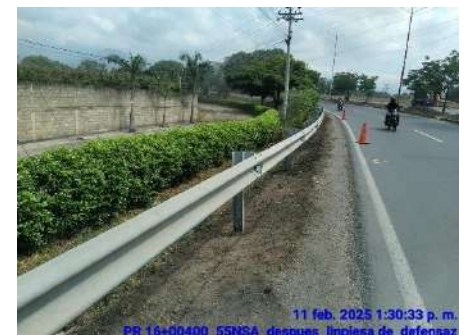
LIMPIEZA DE DEFENSAS (DESPUES)
