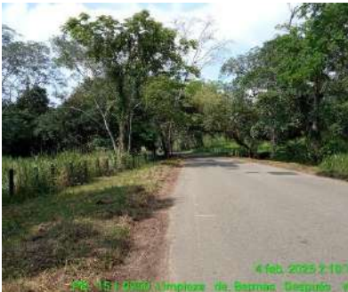
LIMPIEZA DE BERMAS (DESPUES)
