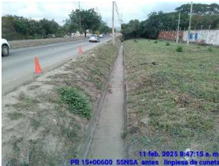
LIMPIEZA DE CUNETAS (ANTES)
