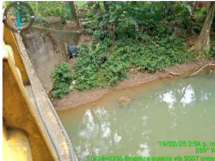
LIMPIEZA DE PUENTES (ANTES)
