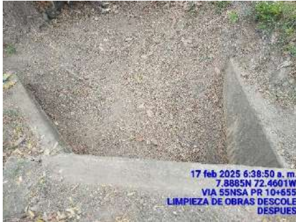
LIMPIEZA DE OBRAS (DESPUES)
