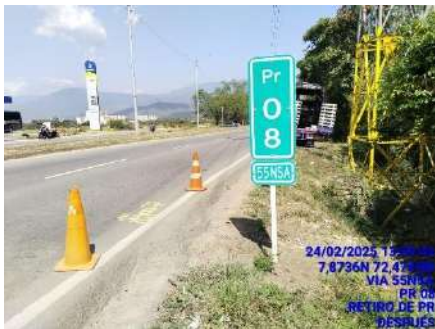
RETIRO DE MOJON DE REFERENCIA (DESPUES)
