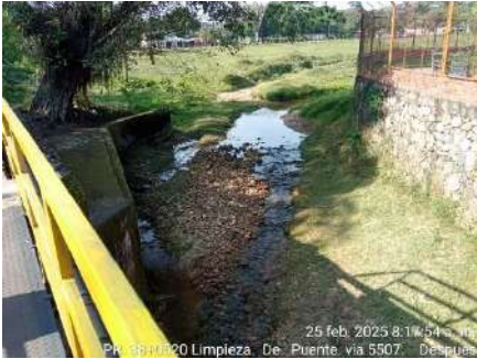
LIMPIEZA DE PUENTES (DESPUES)
