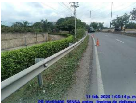
LIMPIEZA DE DEFENSAS (ANTES)
