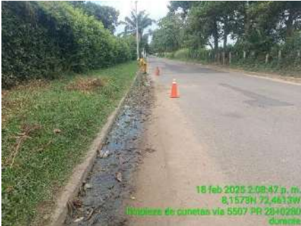
LIMPIEZA DE CUNETAS (DURANTE)
