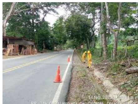
LIMPIEZA DE CUNETAS (DURANTE)
