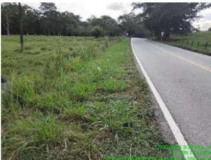
LIMPIEZA DE BERMA (ANTES)
