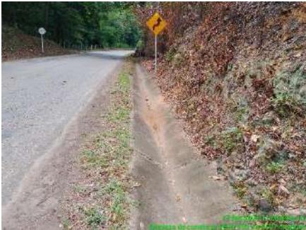
LIMPIEZA DE CUNETAS DESPUES
