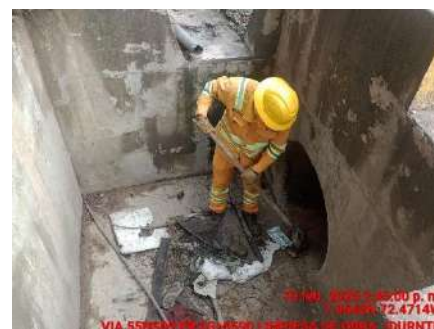
LIMPIEZA DE OBRA (DURANTE)
