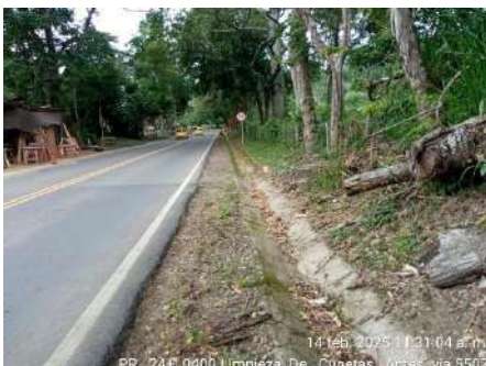
LIMPIEZA DE CUNETAS (ANTES)
