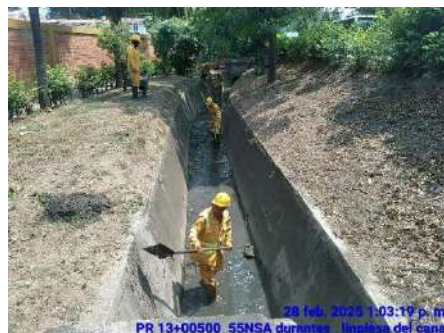
LIMPIEZA DE DESCOLE (DURANTE)
