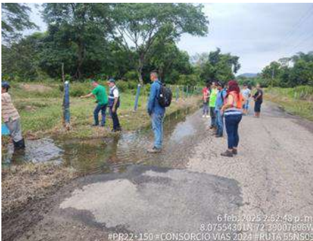
ACOMPAÑAMIENTO Y APOYO, INSPECCION SITIOS CRITICOS
