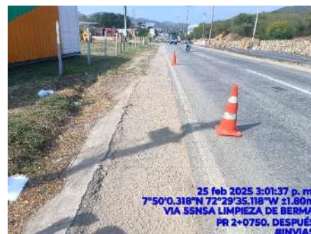
LIMPIEZA DE BERMA (DESPUES)
