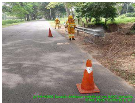
SEGUIMIENTO SEÑALIZACION VIAL ADECUADA
