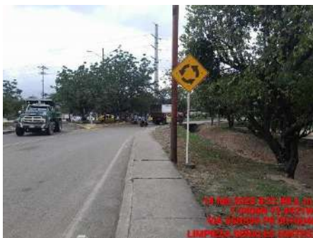
LIMPIEZA DE SEÑALES (ANTES)
