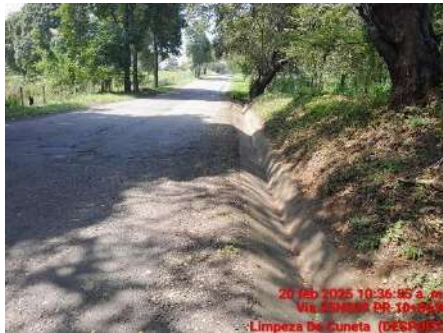
LIMPIEZA DE CUNETAS (DESPUES)
