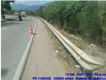
LIMPIEZA DE DEFENSAS METALICAS (ANTES)
