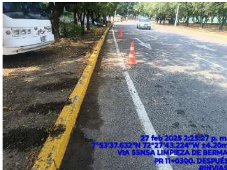
LIMPIEZA DE BERMAS (DESPUES)
