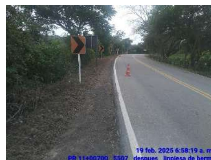
LIMPIEZA DE BERMAS (DESPUES)
