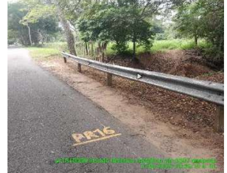
LIMPIEZA DE DEFENSA METALICA (DESPUES)
