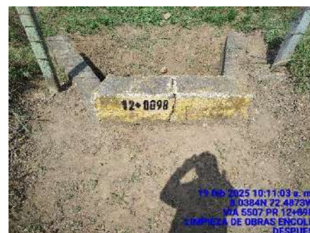
LIMPIEZA DE ENCOLE (DESPUES)
