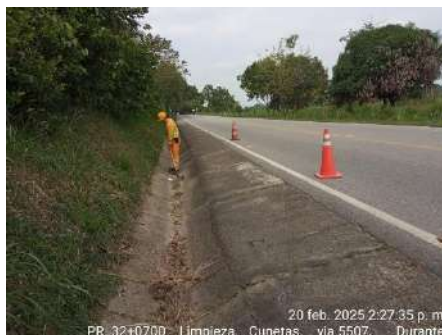
LIMPIEZA DE CUNETAS (DURANTE)
