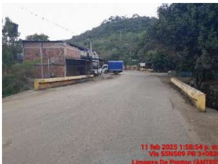
LIMPIEZA DE PONTON (ANTES)
