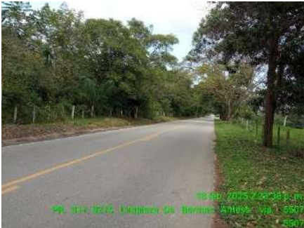
LIMPIEZA DE OBRAS (ANTES)
