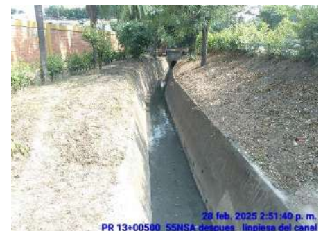
LIMPIEZA DE DESCOLE (DESPUES)
