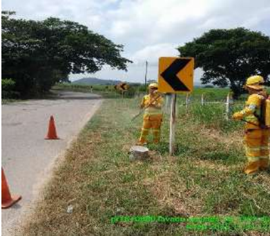
LIMPIEZA DE SEÑALES (DURANTE)
