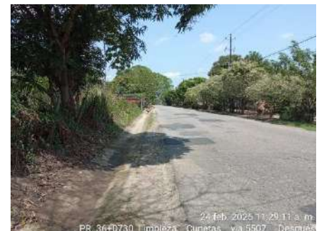
LIMPIEZA DE CUNETAS DESPUES)
