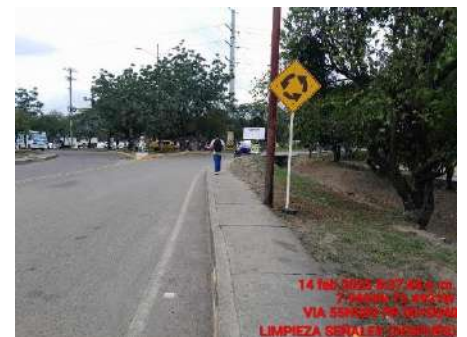
LIMPIEZA DE SEÑALES (DESPUES)
