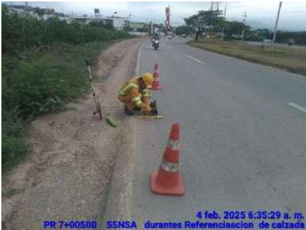
REFERENCIACION DE CALZADA (DURANTE)
