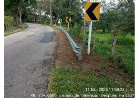
LIMPIEZA DE DEFENSA METÁLICA (DESPUES)
