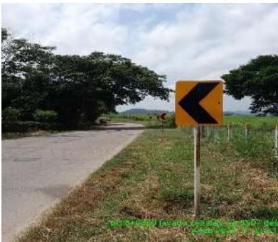
LIMPIEZA DE SEÑALES (DESPUES)
