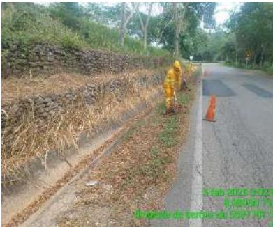
LIMPIEZA DE BERMA (DURANTE)
