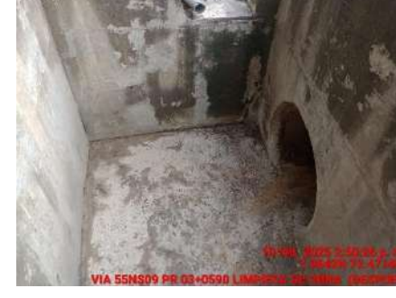
LIMPIEZA DE OBRA (DESPUES)
