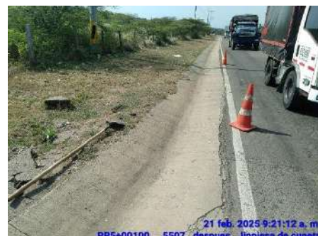
LIMPIEZA DE CUNETAS (DESPUES)
