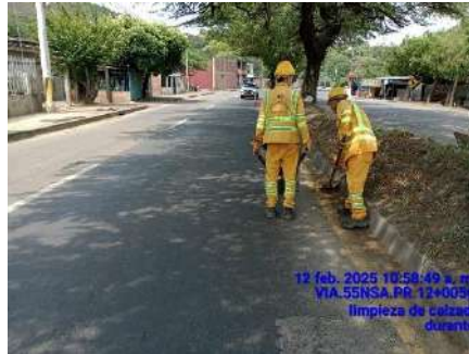
LIMPIEZA DE CALZADAS (DURANTE)
