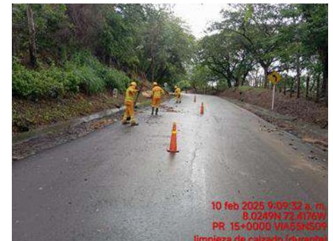
SEGUIMIENTO SEÑALIZACION VIAL ADECUADA
