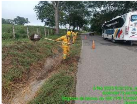
LIMPIEZA DE BERMAS (DURANTE)
