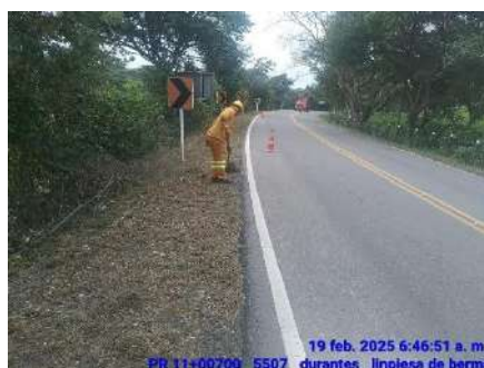
LIMPIEZA DE BERMAS (DURANTE)
