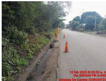
LIMPIEZA DE CUNETAS (DURANTE)
