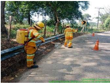
LIMPIEZA DE DEFENSAS METALICAS (DURANTE)
