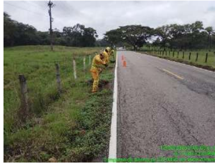
LIMPIEZA DE BERMAS (DURANTE)
