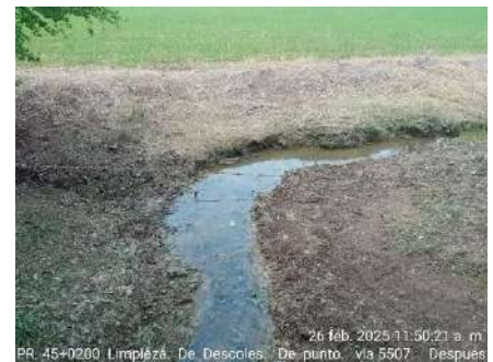
LIMPIEZA DE DESCOLE (DESPUES)
