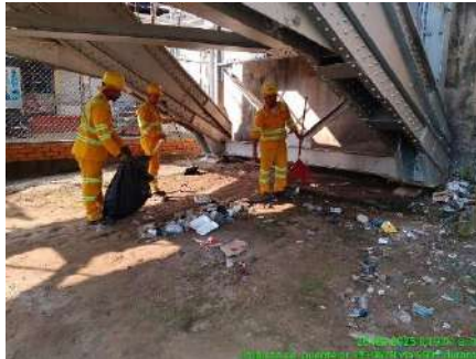
LIMPIEZA DE PUENTES (DURANTE)
