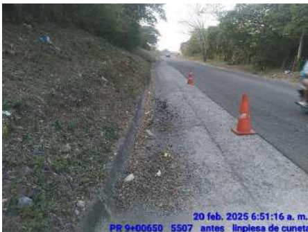
LIMPIEZA DE CUNETAS (DURANTE)
