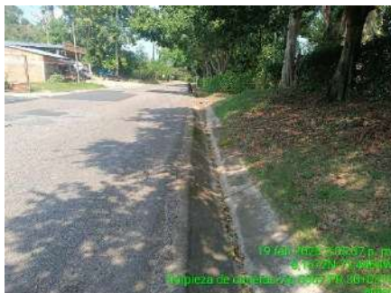
LIMPIEZA DE CUNETAS (ANTES)
