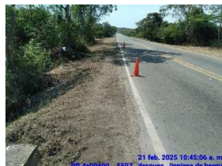
LIMPIEZA DE BERMAS (DESPUES)
