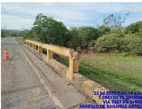
RENOVACION DE BARANDAS (ANTES)
