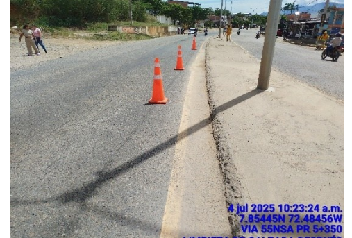
LIMPIEZA DE CALZADA (DESPUES)
