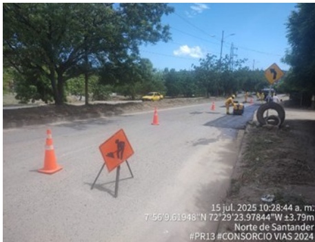
INSPECCION PROTOCOLOS DE SEÑALIZACION VIAL
