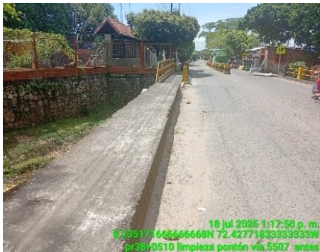
LIMPIEZA DE PONTON (ANTES)
