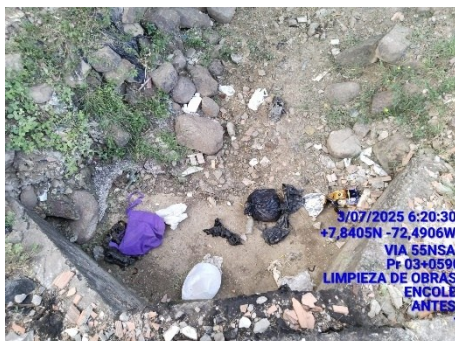
LIMPIEZA DE OBRAS (ANTES)
