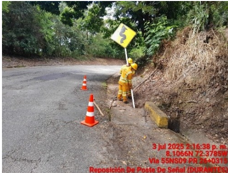
ARREGLO Y DESPEJE DE SEÑALES (DURANTE)
