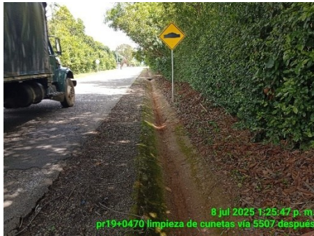
LIMPIEZA DE CUNETAS (DESPUES)
