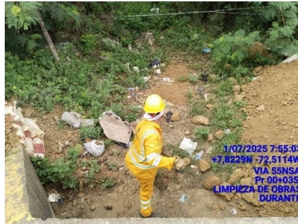
LIMPIEZA DE ENCOLE Y DESCOLE (DURANTE)
