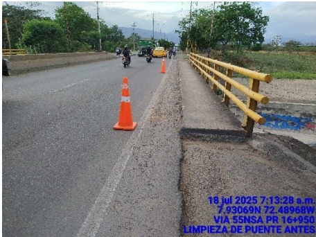
LIMPIEZA DE PUENTE (ANTES)
