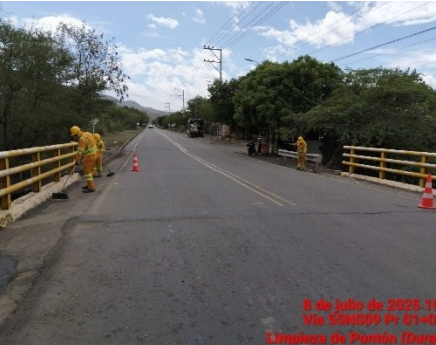
LIMPIEZA DE PONTON (DURANTE)
