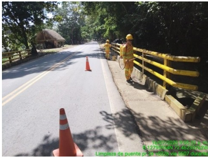
LIMPIEZA DE PUENTE (DURANTE)
