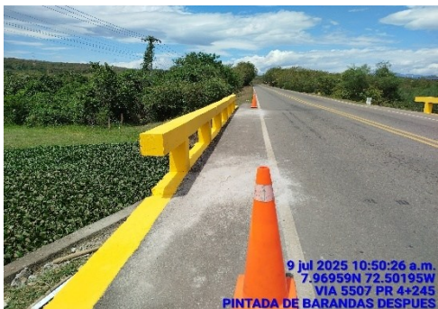
PINTURA DE BARANDAS (DESPUES)
