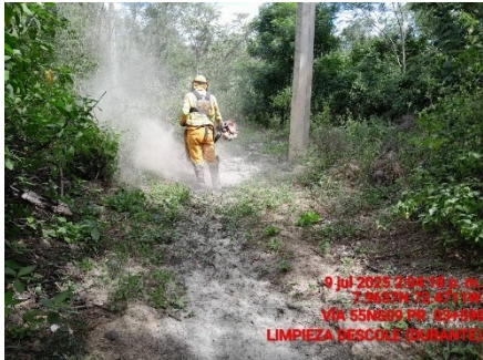
LIMPIEZA DE ENCOLE Y DESCOLE (DURANTE)
