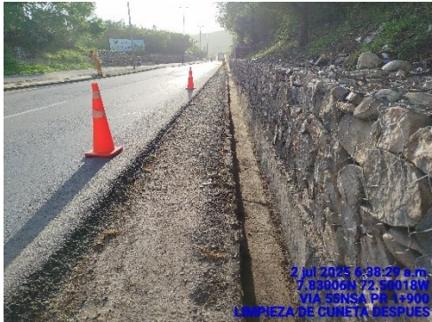
LIMPIEZA DE CUNETA (DESPUES)
