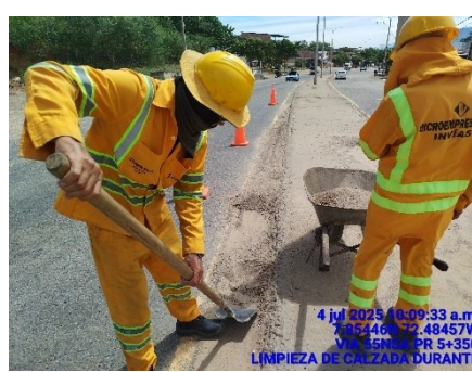
LIMPIEZA DE CALZADA (DURANTE)
