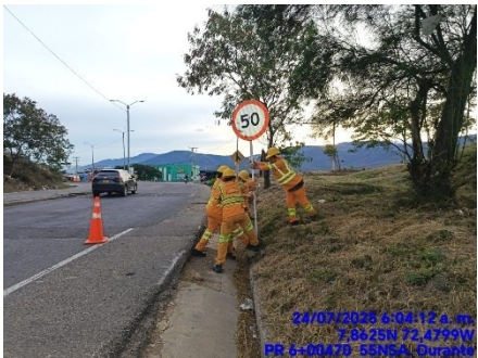
ARREGLO Y DESPEJE DE SEÑALES (DURANTE)
