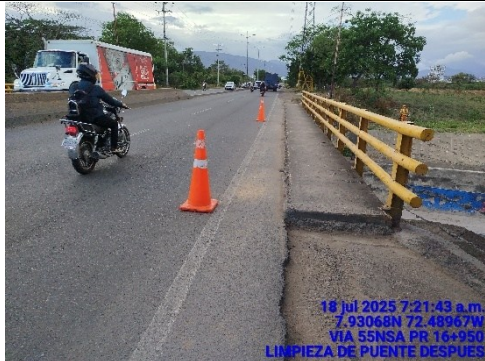
LIMPIEZA DE PUENTE (DESPUES)
