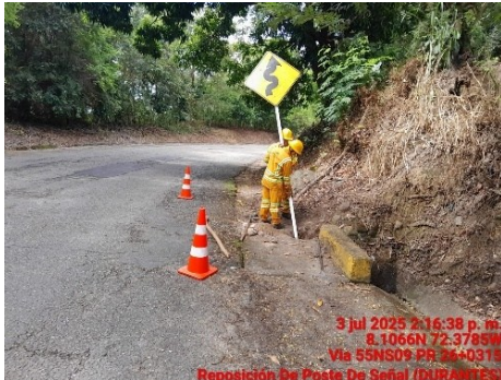
ARREGLO Y DESPEJE DE SEÑALES (DURANTE)
