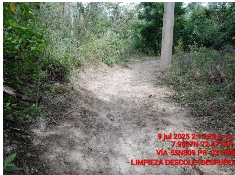
LIMPIEZA DE ENCOLE Y DESCOLE (DESPUES)
