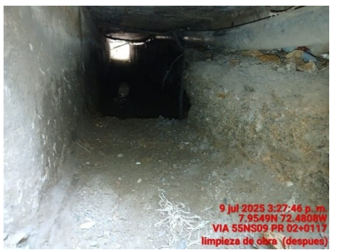
LIMPIEZA DE OBRA (DESPUES)
