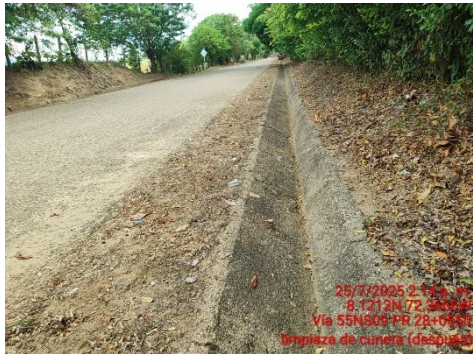
LIMPIEZA DE CUNETAS (DESPUES)
