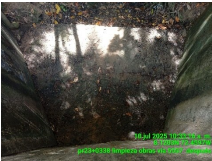
LIMPIEZA DE OBRA (DESPUES)
