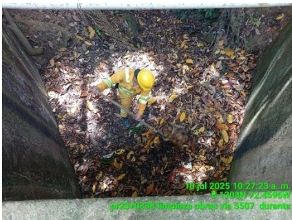
LIMPIEZA DE OBRA (DURANTE)
