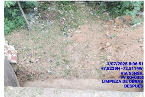
LIMPIEZA DE ENCOLE Y DESCOLE (DESPUES)
