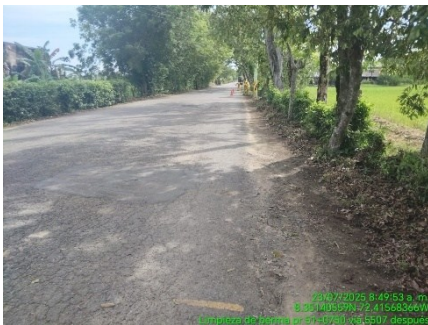
LIMPIEZA DE BERMA (DESPUES)
