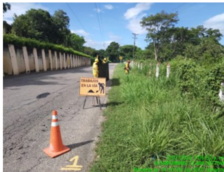
SEGUIMIENTO USO DE BARRERA DE SEGURIDAD
