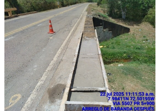
RENOVACION DE BARANDAS (DESPUES)
