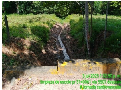
LIMPIEZA DE ENCOLE Y DESCOLE (DESPUES)
