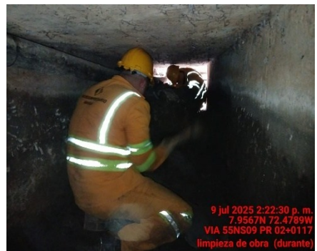
LIMPIEZA DE OBRA (DURANTE)
