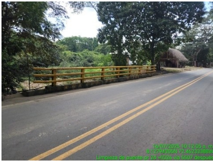
LIMPIEZA DE PUENTE (DESPUES)
