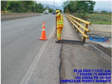
LIMPIEZA DE PUENTE (DURANTE)
