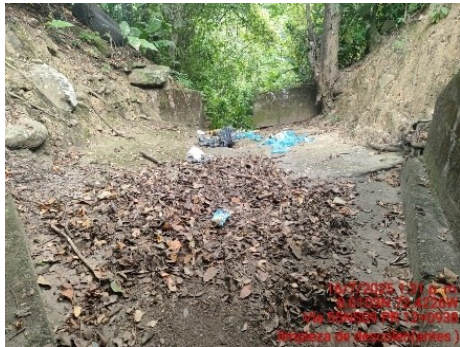
LIMPIEZA DE ZANJAS DE CORONACION (ANTES)
