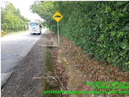
LIMPIEZA DE CUNETAS (ANTES)
