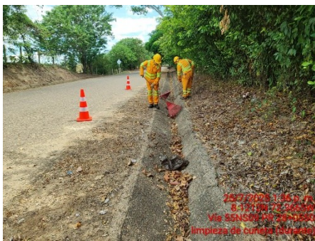
LIMPIEZA DE CUNETAS (DURANTE)
