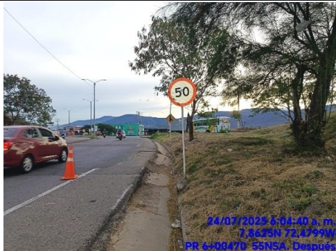
ARREGLO Y DESPEJE DE SEÑALES (DESPUES)
