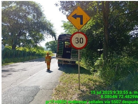
ARREGLO Y DESPEJE DE SEÑALES (DESPUES)
