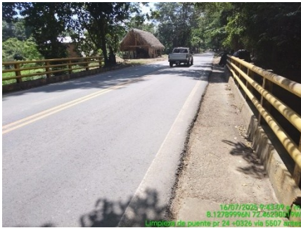
LIMPIEZA DE PUENTE (ANTES)
