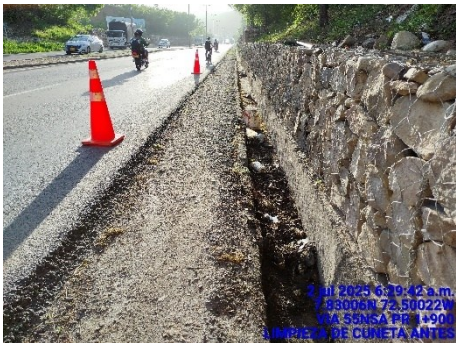
LIMPIEZA DE CUNETA (ANTES)
