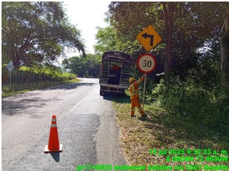
ARREGLO Y DESPEJE DE SEÑALES (DURANTE)
