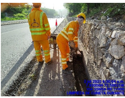
LIMPIEZA DE CUNETA (DURANTE)
