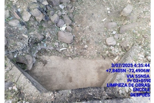
LIMPIEZA DE OBRAS (DESPUES)
