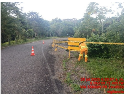
SEÑALIZACION SITIO CRITICO (DURANTE)
