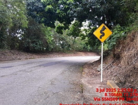
ARREGLO Y DESPEJE DE SEÑALES (DESPUES)
