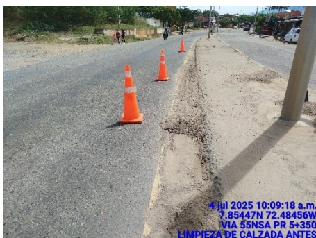
LIMPIEZA DE CALZADA (ANTES)
