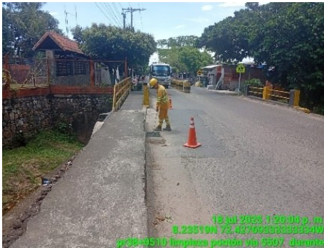
LIMPIEZA DE PONTON (DURANTE)
