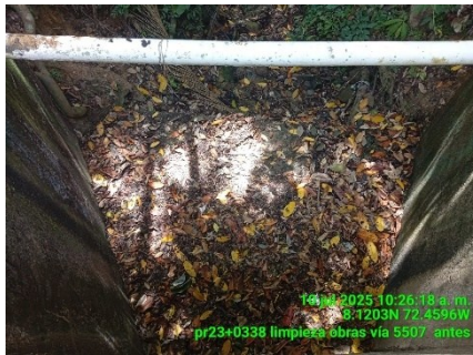
LIMPIEZA DE OBRA (ANTES)
