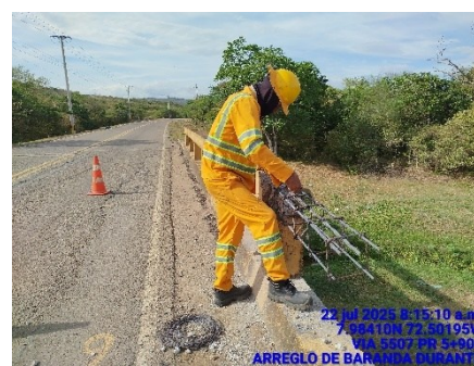
RENOVACION DE BARANDAS (DURANTE)
