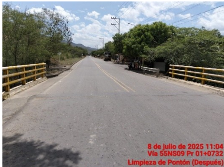
LIMPIEZA DE PONTON (DESPUES)
