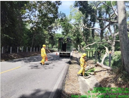
RETIRO DE ARBOL (DURANTE)
