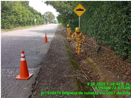
LIMPIEZA DE CUNETAS (DURANTE)
