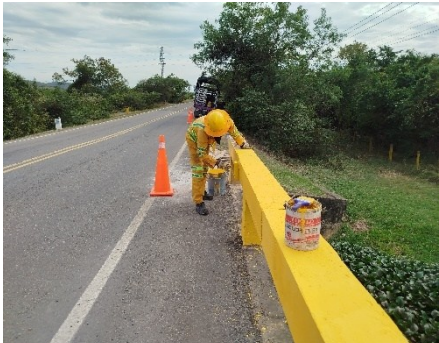
PINTURA DE BARANDAS (DURANTE)
