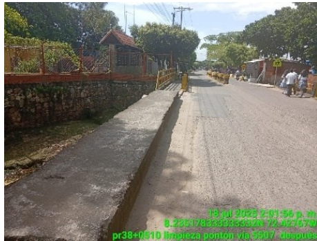
LIMPIEZA DE PONTON (DESPUES)
