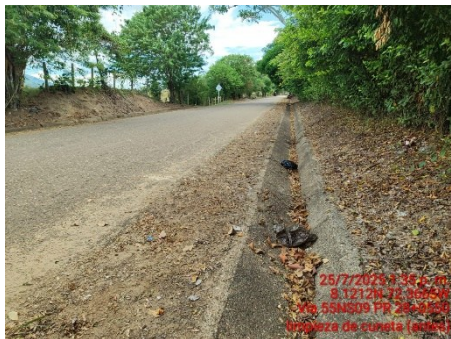
LIMPIEZA DE CUNETAS (ANTES)
