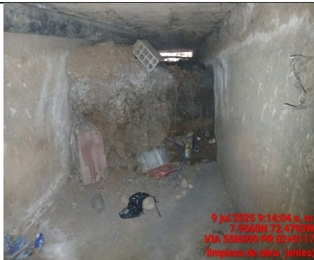
LIMPIEZA DE OBRA (ANTES)
