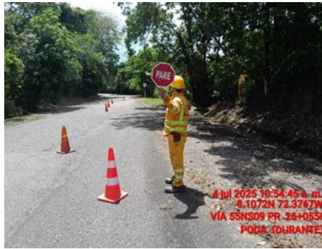
SEGUIMIENTO CORRECTA SEÑALIZACION VIAL
