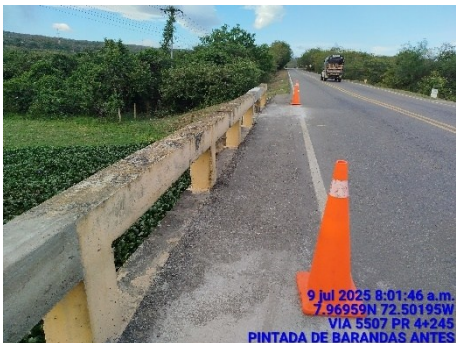
PINTURA DE BARANDAS (ANTES)
