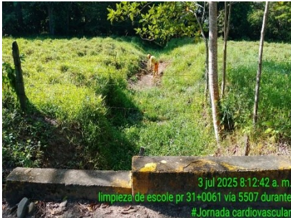
LIMPIEZA DE ENCOLE Y DESCOLE (DURANTE)
