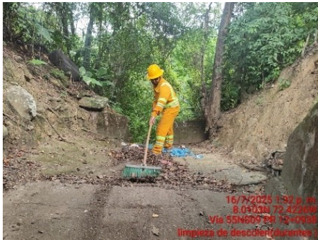
LIMPIEZA DE ZANJAS DE CORONACION (DURANTE)
