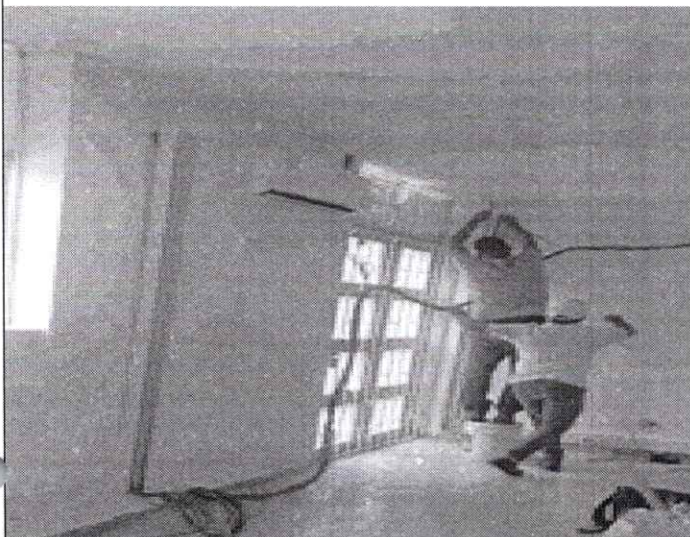
Reparacion de cielo raso en drywall. Incluye pintura
