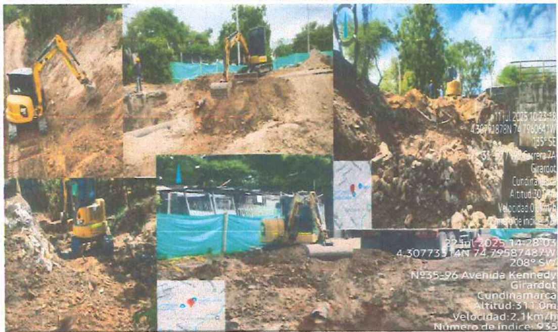
INSPECCION EN TAREAS DE EXCAVACION
