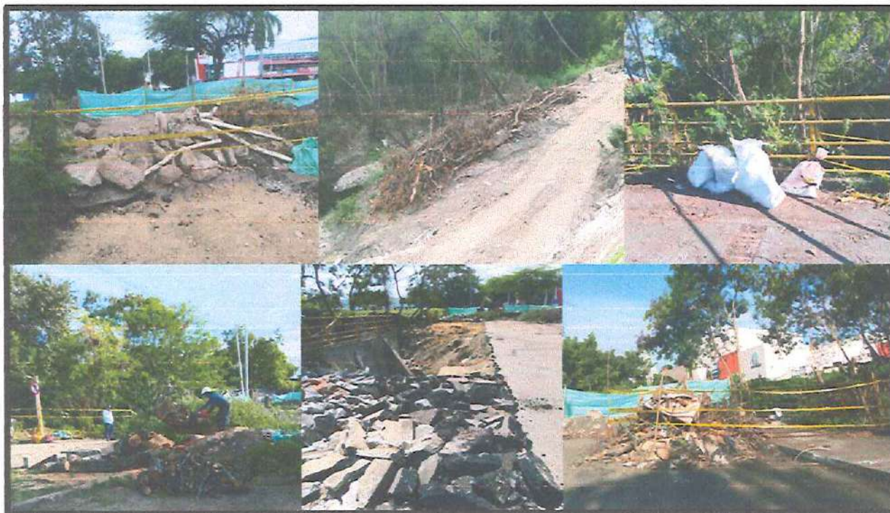
SITIOS DE ACOPIO PROVISIONAL DE DESECHOS ORGANICOS Y RESIDUOS DE CONSTRUCCIÓN Y DEMOLICIÓN RCD.
