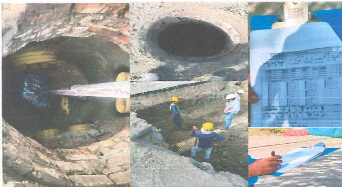
INSPECCIONES EN INGRESOS Y ACTIVIDADES EN ESPACIOS CONFINADOS DENOMINADA TAREA DE ALTO RIESGO
