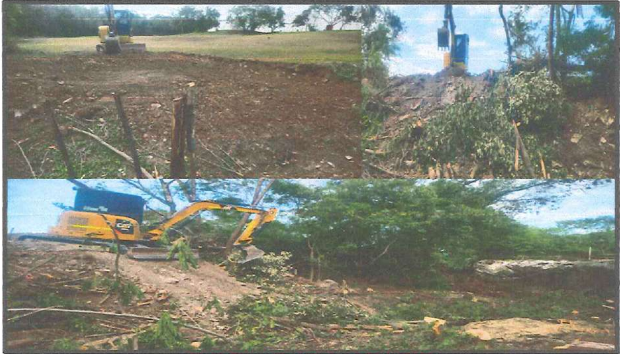
DESPEJE Y APERTURA DE CAMINOS
