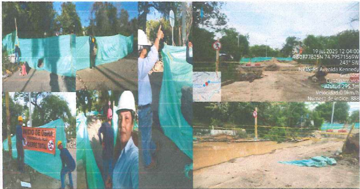
MANTENIMIENTO EN LA SEÑALIZACION- DEMARCACION Y BALIZACION DE AREAS CRITICAS
