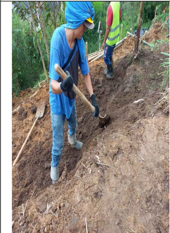
Conformación de taludes
