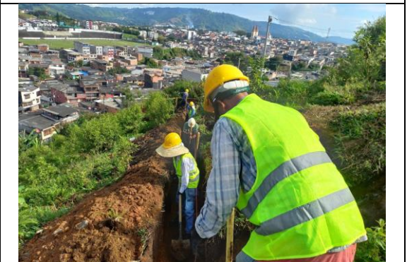
Excavaciones para instalación de tuberías
