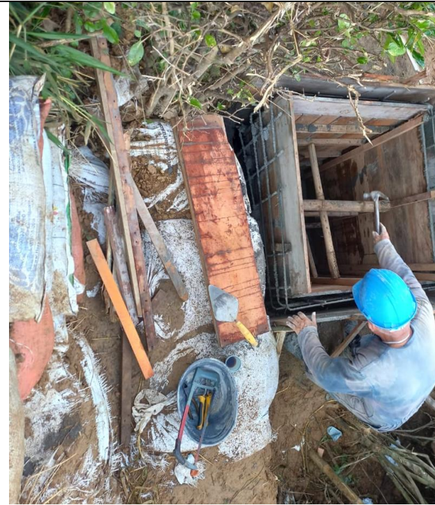
Construcción cámaras de inspección sección cuadrada
