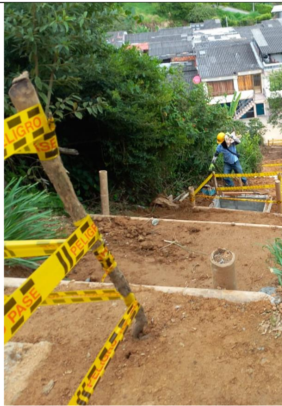
Cámaras de inspección en concreto, taludes conformados
