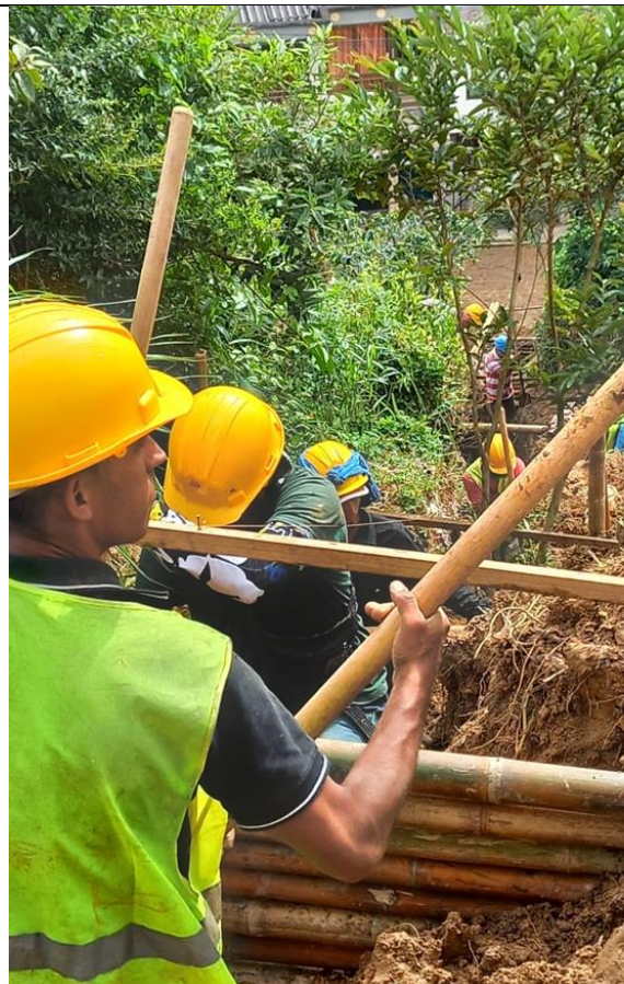
Construcción de trinchos
