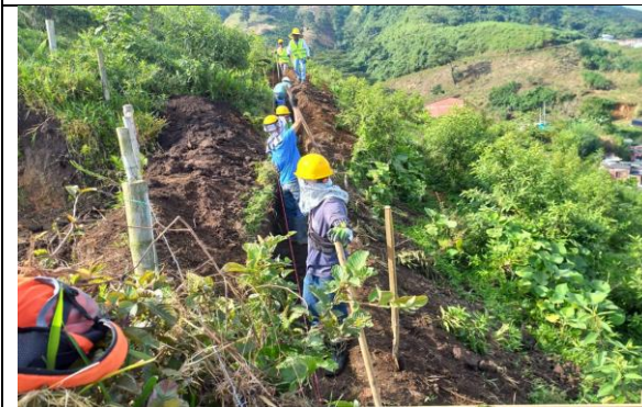
Excavaciones para instalación de tuberías
