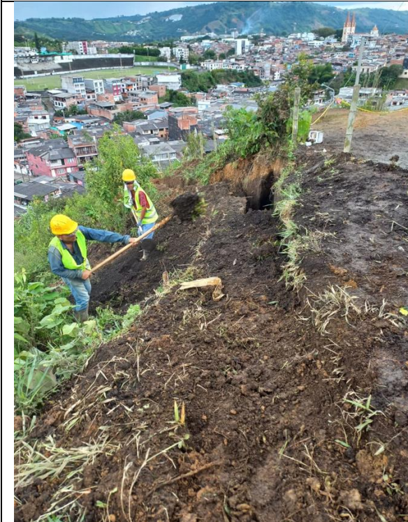
Conformación de taludes en tierra
