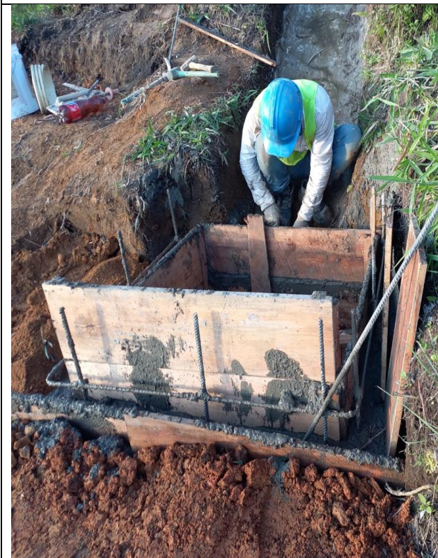
Armado acero de refuerzo cámaras de inspección
