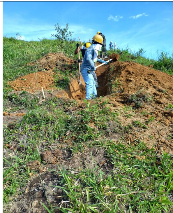
Instalación de tubería de 12"
