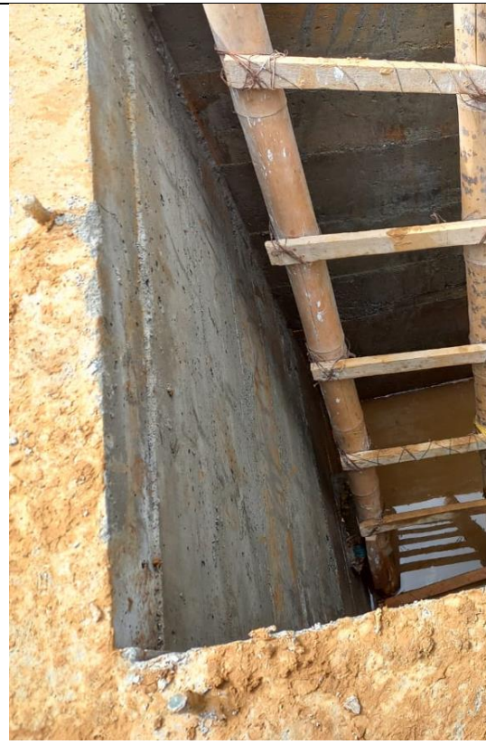
Construcción cámaras de inspección sección cuadrada
