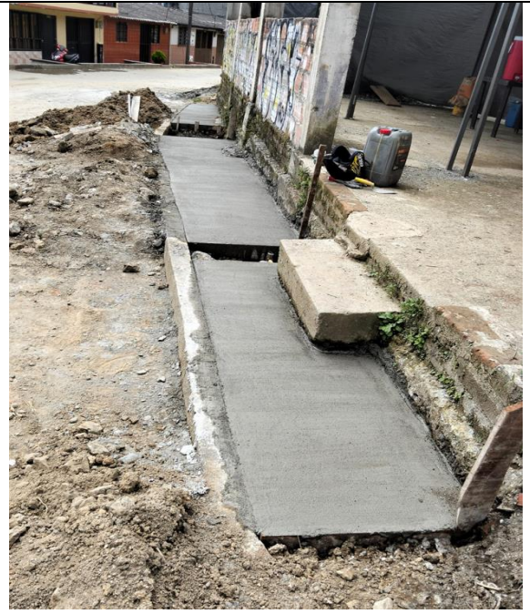
Construcción de andén
