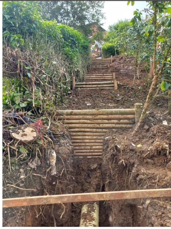
Construcción de trinchos y conformación de taludes
