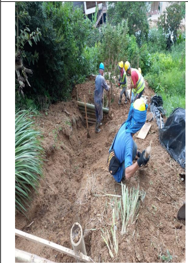
Conformación de taludes y trinchos
