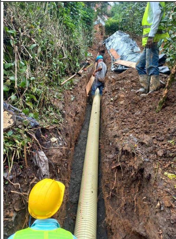
Instalación de arena para base y atraque de tubería
