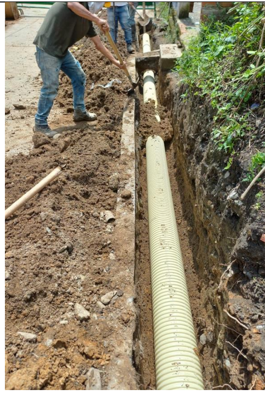
Excavaciones para construcción de andenes y protección de tubería instalada manual para replanteo y toma de niveles
