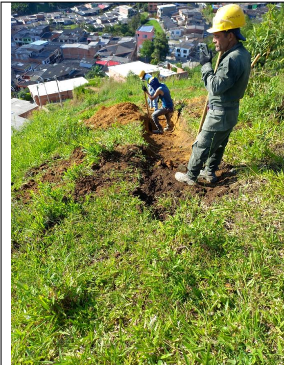
Excavaciones para construcción de canal colectora
