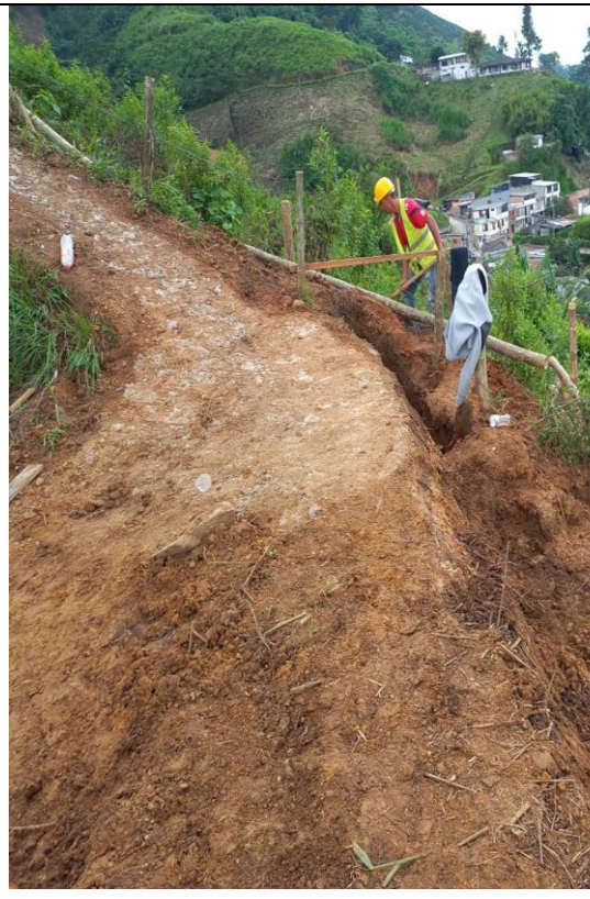
Conformación de taludes
