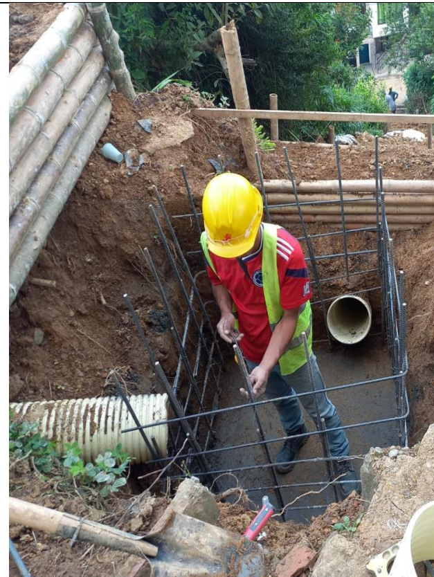
Construcción cámaras de inspección sección cuadrada
