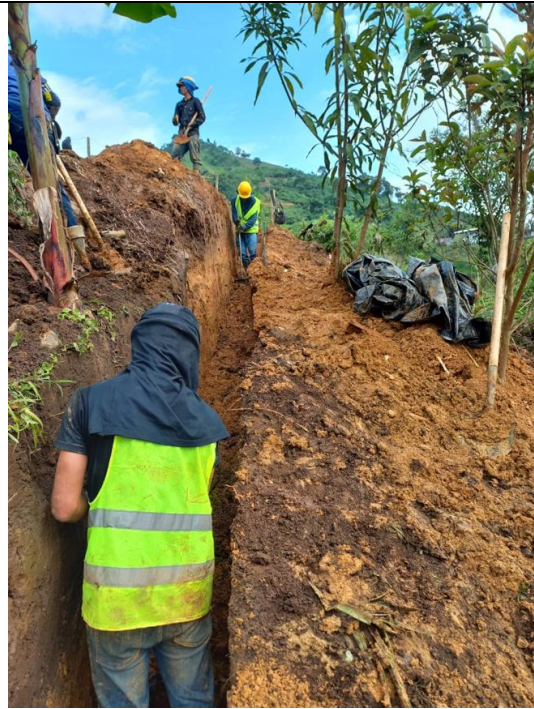
Relleno con material proveniente de la excavación
