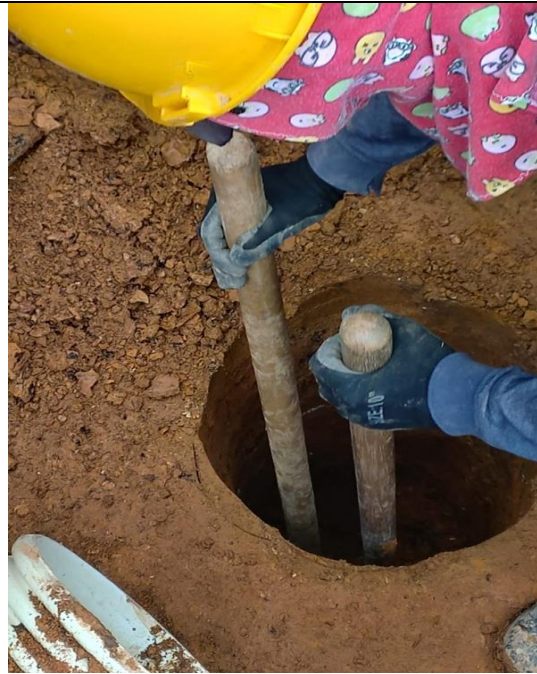
Excavaciones para pilotes cimentación cámaras
