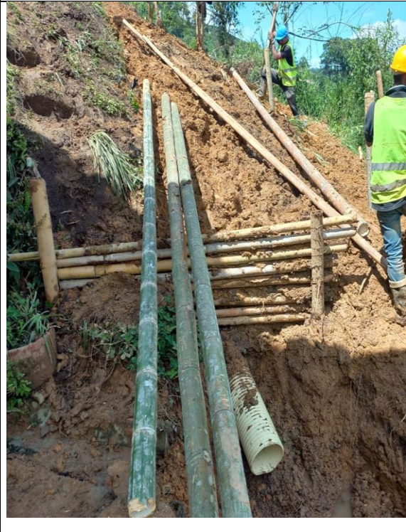
Conformación de taludes en tierra
