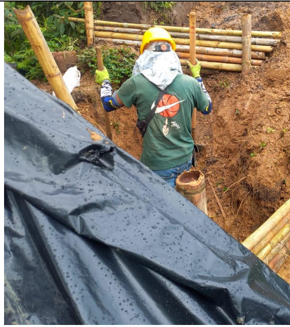
Construcción de trinchos
