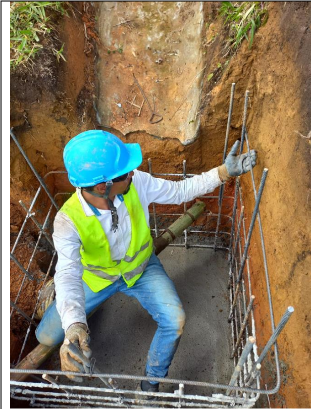
Armado acero de refuerzo cámaras de inspección
