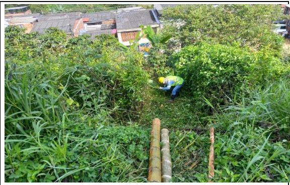
Trazado, localización, replanteo, rocería y limpieza.
