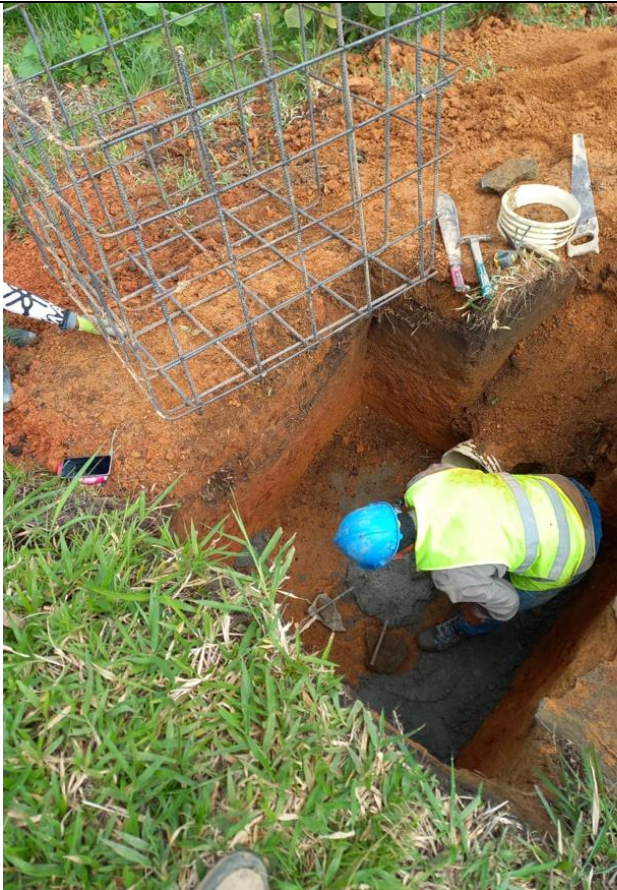
Construcción de pilotes
