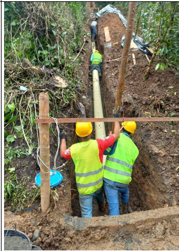
Instalación de arena para base y atraque de tubería
