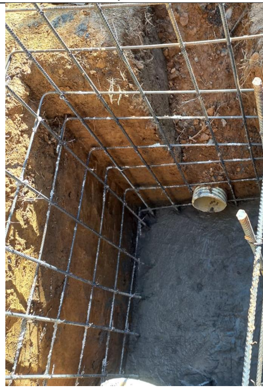
Armado acero de refuerzo cámaras de inspección
