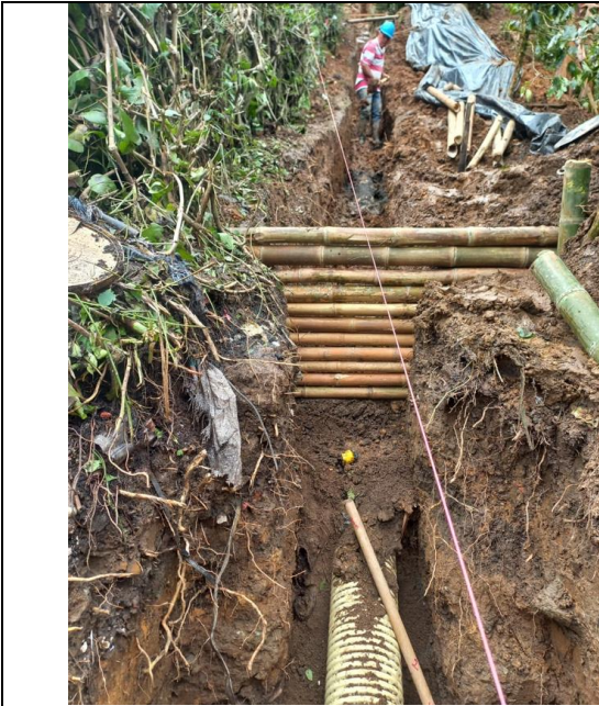
Construcción de trinchos
