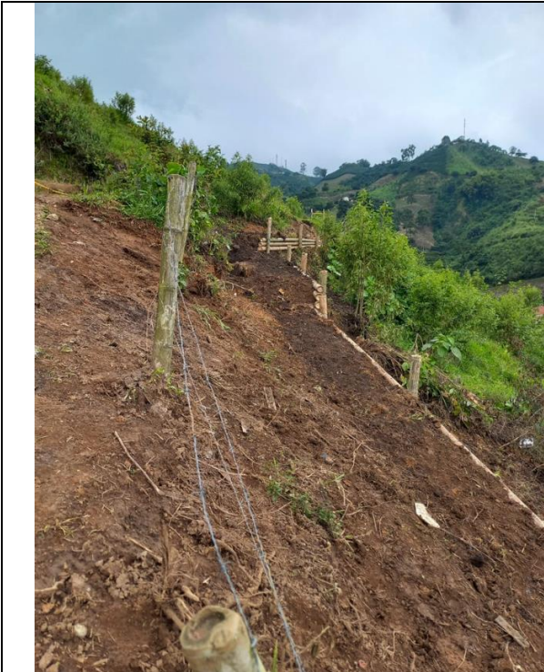
Conformación de taludes
