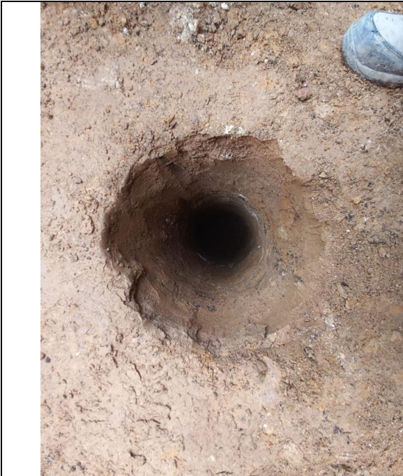
Excavaciones para pilotes cimentación cámaras
