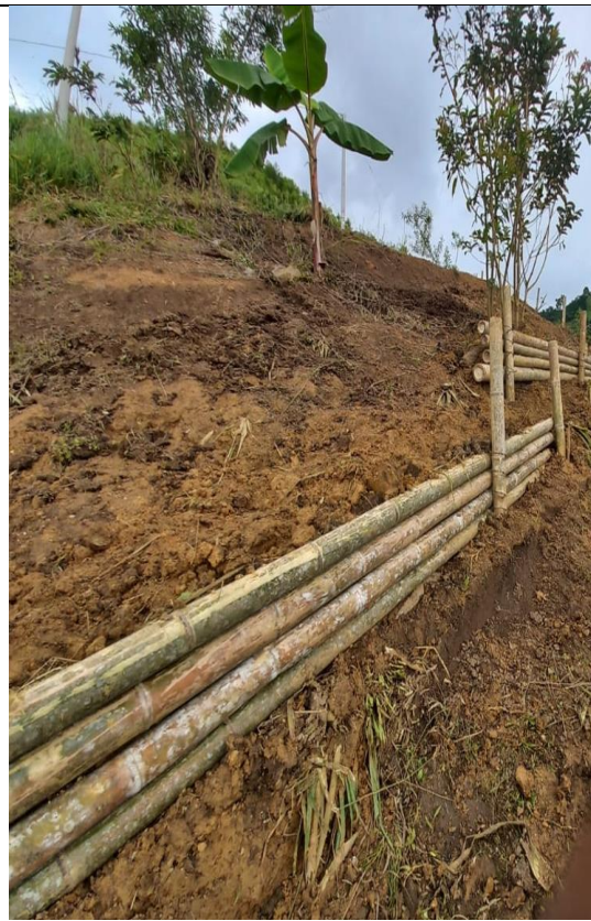
Conformación de taludes y trinchos
