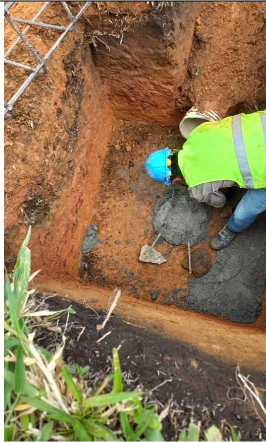
Construcción de pilotes
