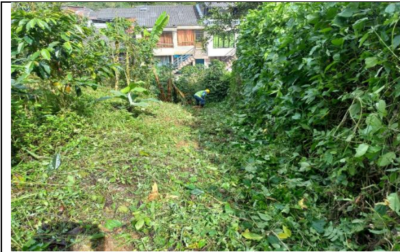
Trazado, localización, replanteo, rocería y limpieza.
