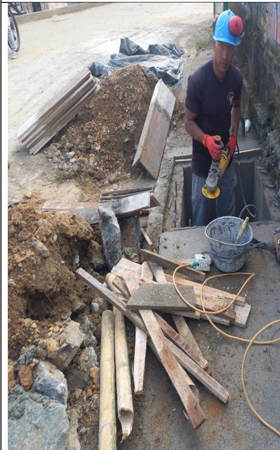
Construcción de cámara de concreto y andén
