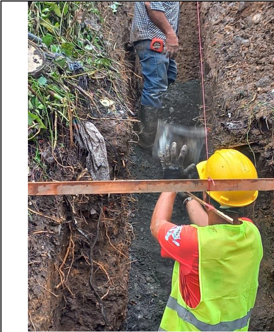
Instalación de arena para base y atraque de tubería
