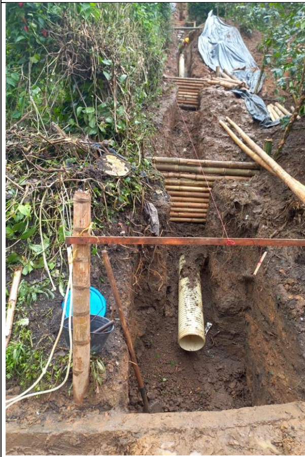
Construcción de trinchos
