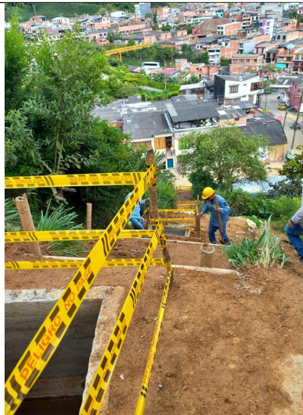
Cámaras de inspección en concreto, taludes conformados
