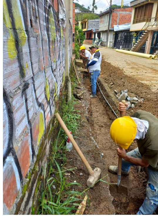
Excavaciones para construcción de andenes y protección de tubería instalada manual para replanteo y toma de niveles
