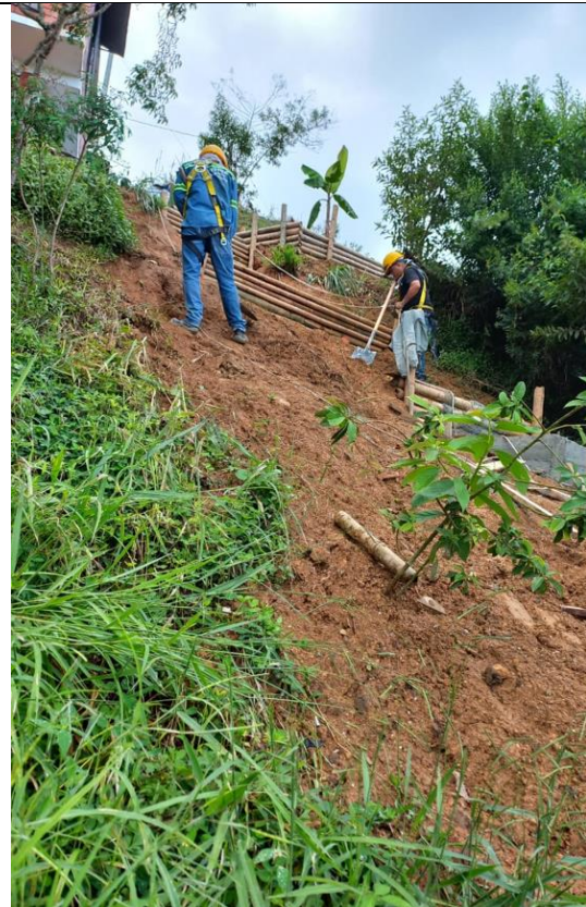
Conformación de taludes, uso de elementos de protección, arnés y línea de vida
