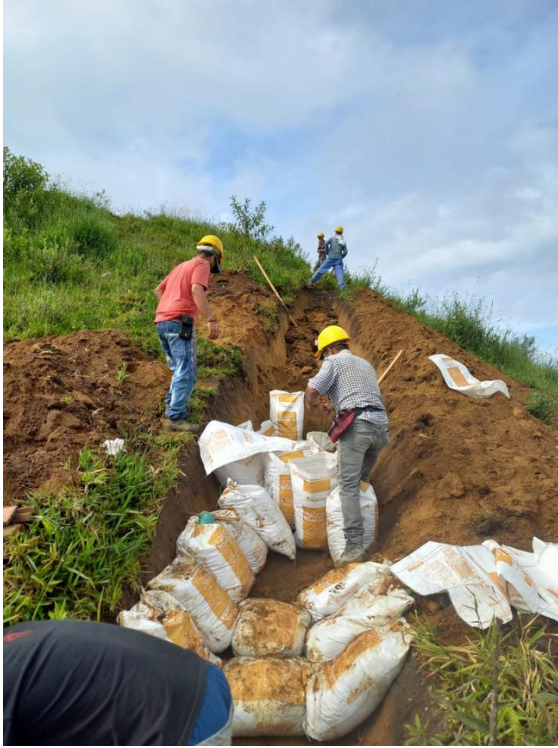
Construcción de canales en costales de suelo cemento
