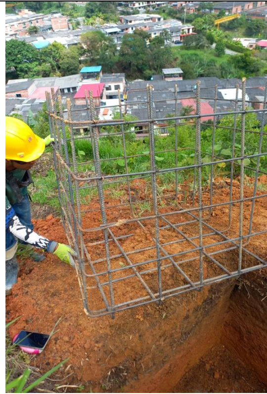
Armado acero de refuerzo cámaras de inspección
