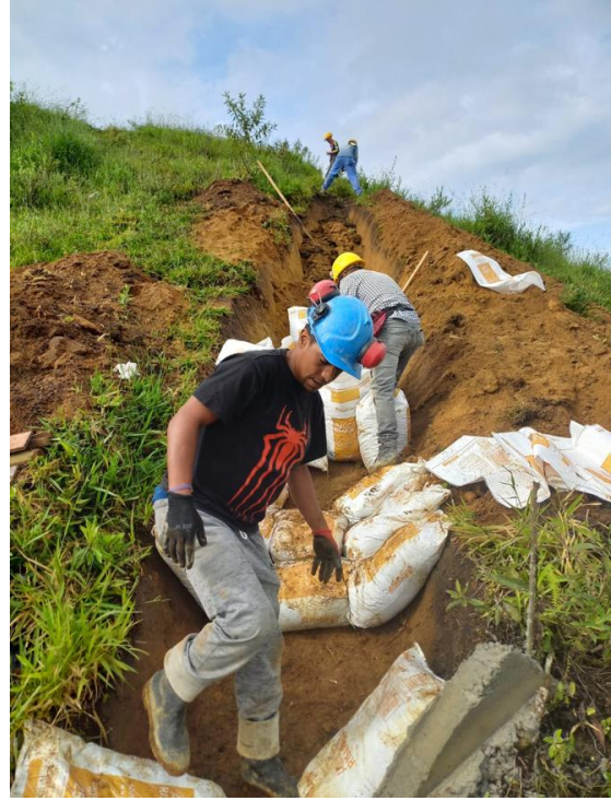
Construcción de canales en costales de suelo cemento
