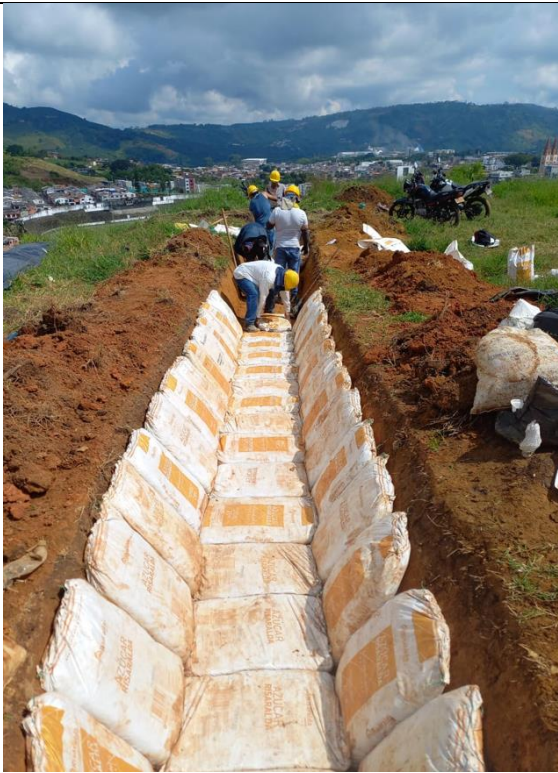
Construcción de canales en costales de suelo cemento
