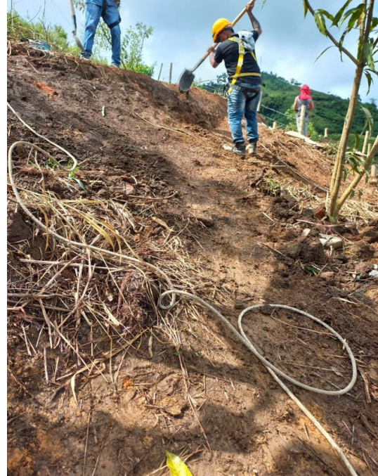
Conformación de taludes, uso de elementos de protección, arnés y línea de vida
