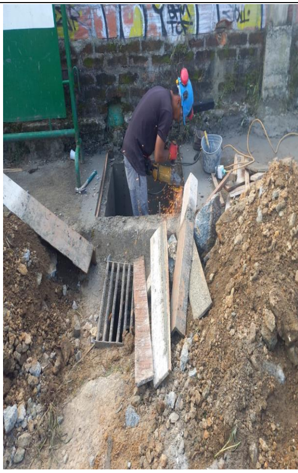
Construcción de cámara de concreto y andén
