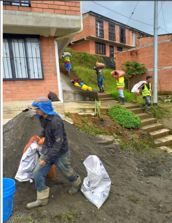
Sobre acarreo de materiales al hombro, fuerte pendiente y escalas
