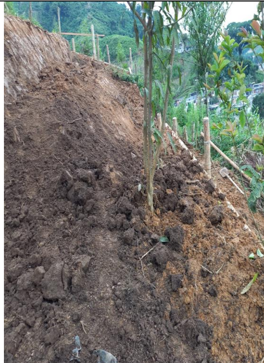
Conformación de taludes
