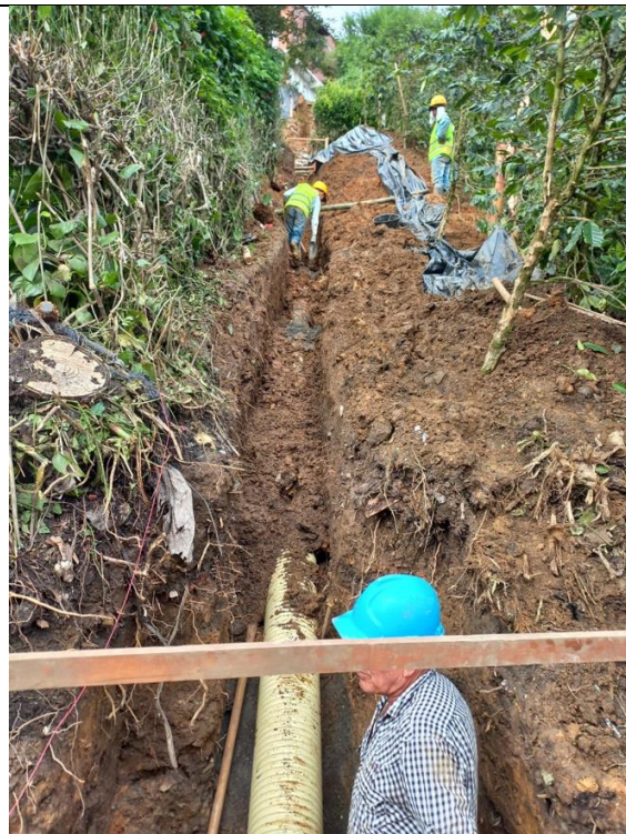
Instalación de tuberías y relleno con material proveniente de la excavación
