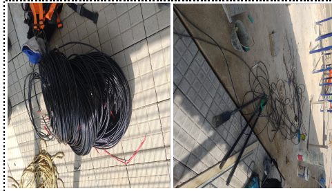
DESCRIPCIÓN: Suministro e instalación de acometida subterránea en cable de cobre encauchetado 3x#10 awg, para alimentación de sistema de iluminación de pérgolas y cubierta.
