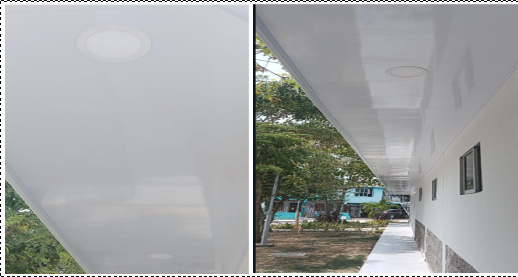
DESCRIPCIÓN: Suministro e instalación de luces tipo ojo de buey de 12W.
