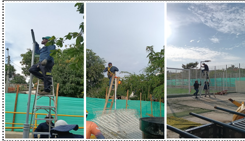
DESCRIPCIÓN: Suministro e instalación de luminaria solar autónoma 40w autónoma batería litio po4 - 6000lm ip 66 ik 08. 3 años de garantía.
