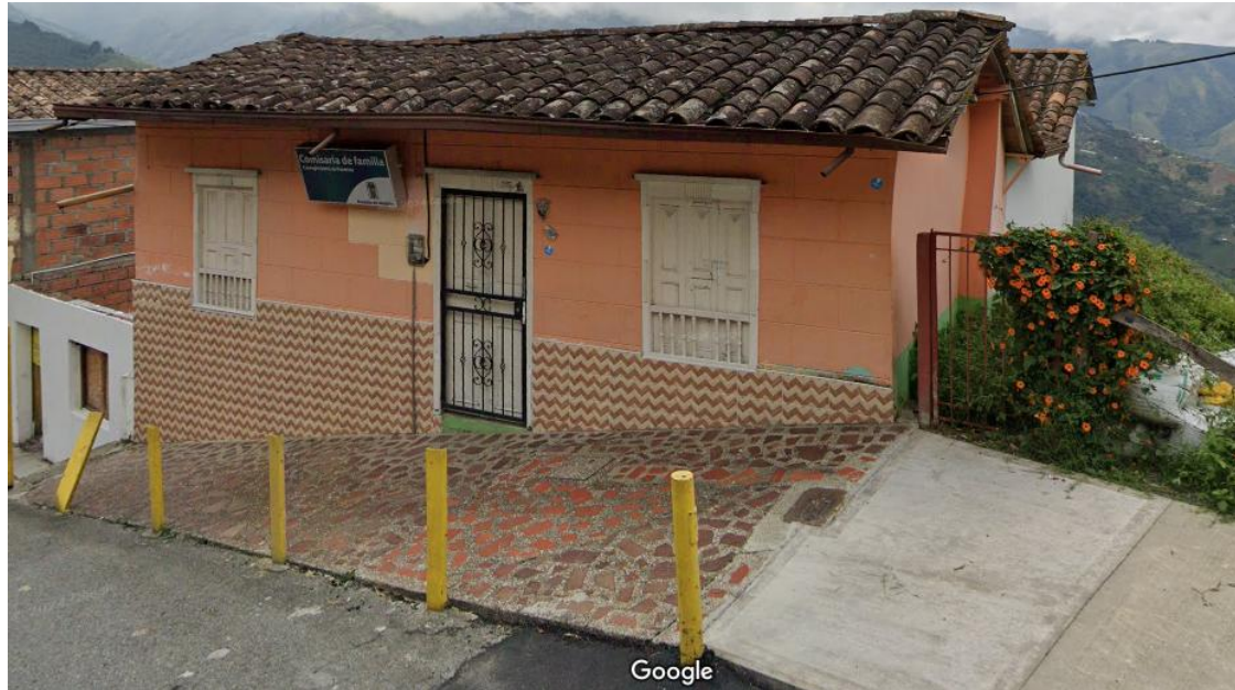
Imagen N° 1: Fachada de edificación existente (A demoler) Fuente: Fotografía propia.
