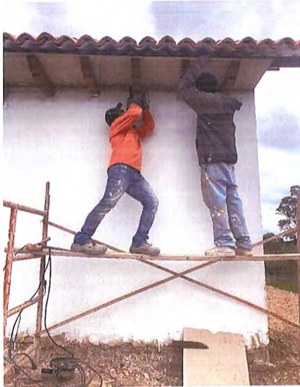
INSTALACIÓN COMPLETA BASES DE ESTRIBOS DE MADERA
