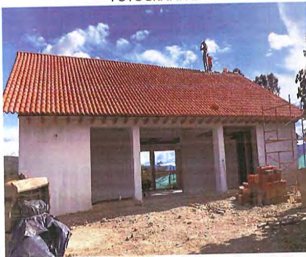
Instalación teja en techo
