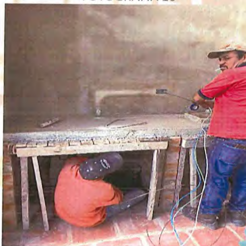
Instalación cableado eléctrico para tomacorriente
