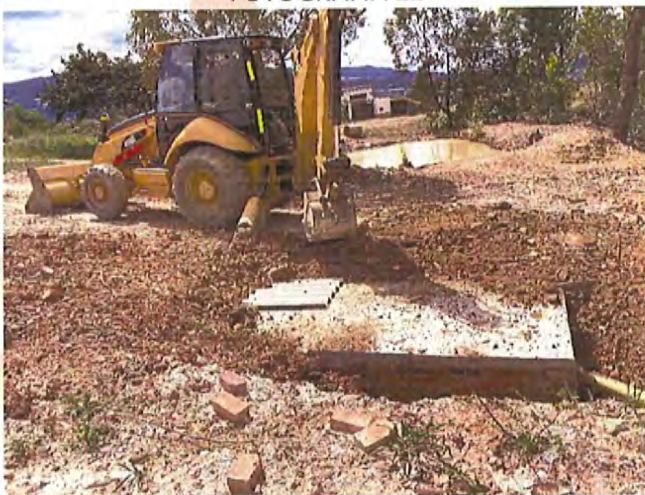
Relleno de material particular en caja de inspección
