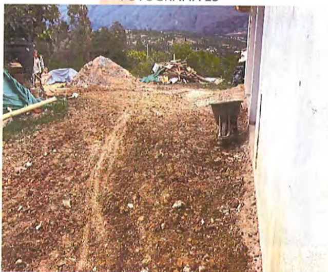
Relleno y disposición de material particular en el terreno
