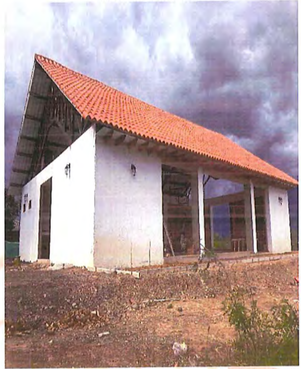
Inicio implementación sistema de encofrado en madera
