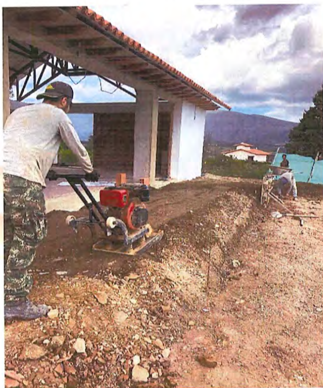
Compactación de material particular agregado para asentamiento del suelo
