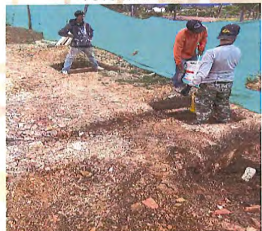
Formación de la caja de inspección en mampostería
