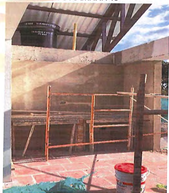
INSTALACIÓN RED ELECTRICA
