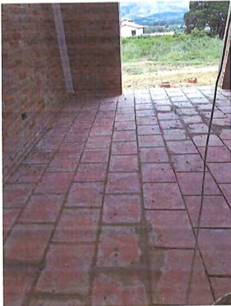
Fijación y endurecimiento de concreto de BALDOZA TIPO CUCUTA
