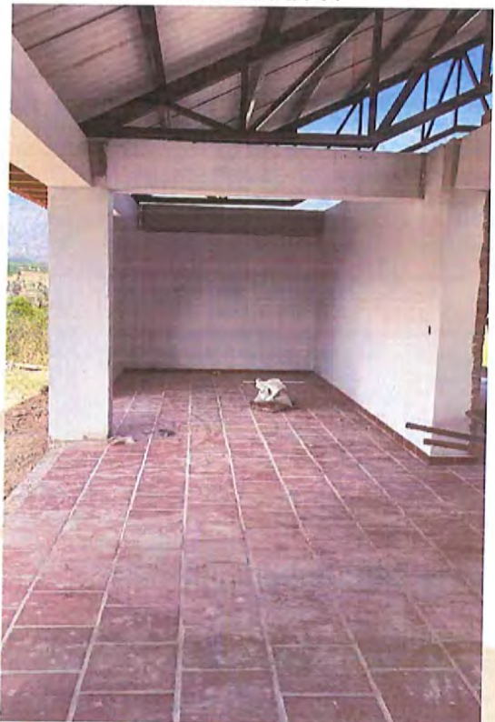
Pintura en estuco general muros, vigas y columnas
