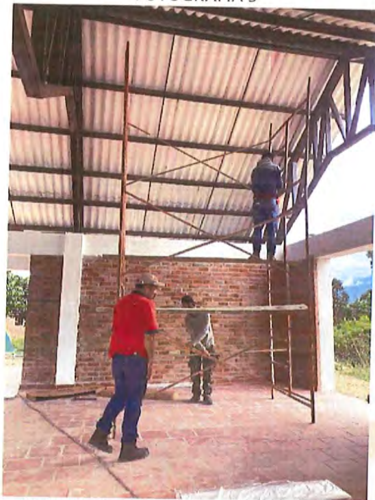
Acabado instalación de techo en drywalll
