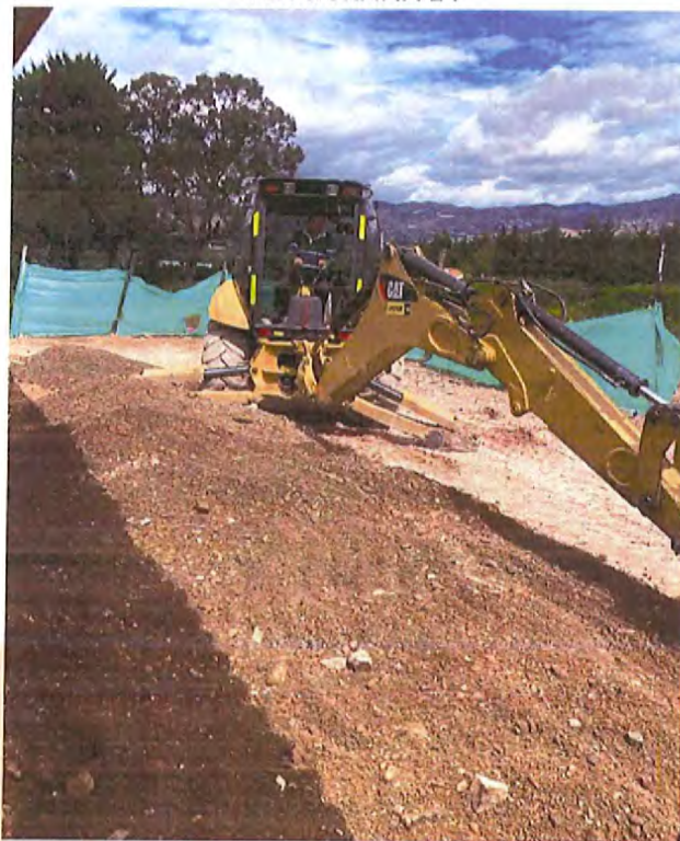
Relleno y nivelación de terreno con retroexcavadora
