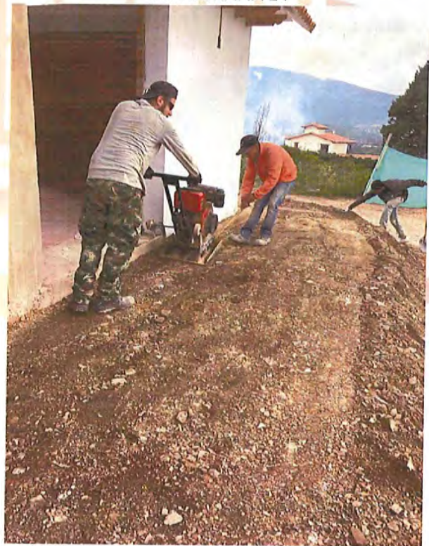
Compactación con vibro material de agregado sección 2
