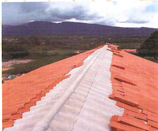
Proceso de recubrimiento de teja en drywall con teja tipo barro
