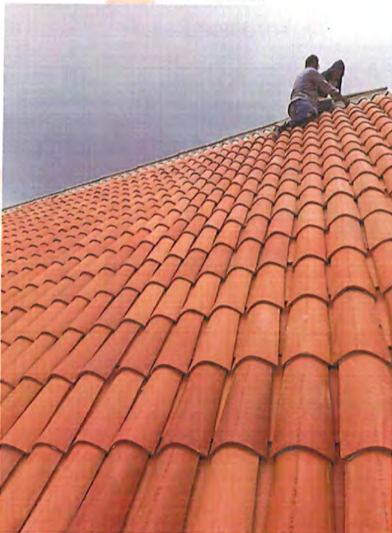
Proceso de recubrimiento de teja en drywall con teja tipo barro
