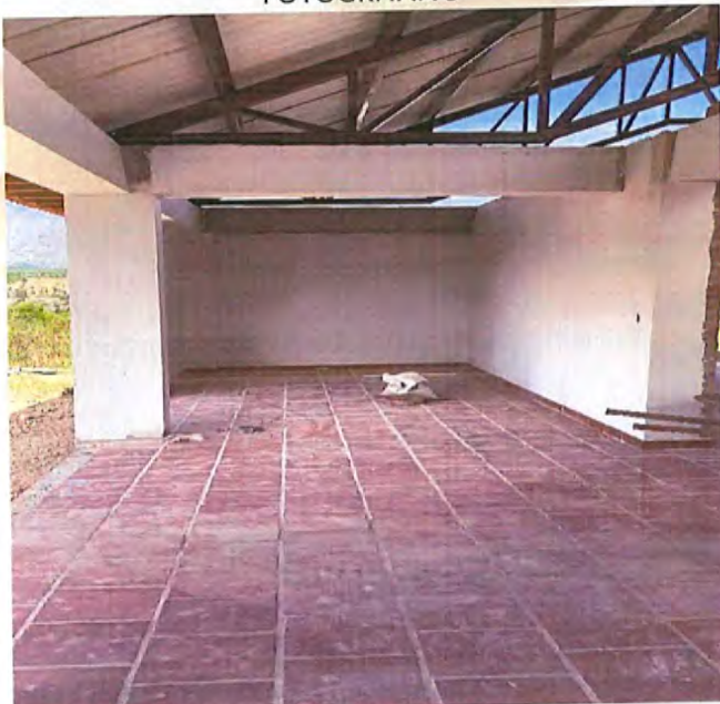
INSTALACIÓN BALDOZA TIPO CUCUTA
