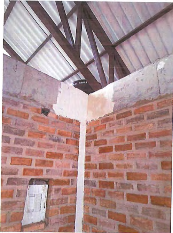
Pintura en estuco en columnas y vigas
