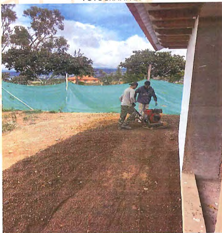
Compactación de material particular agregado para asentamiento del suelo
