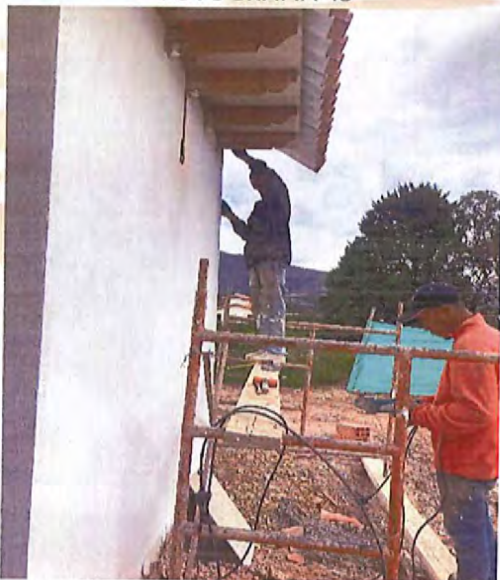
INSTALACIÓN DE RED ELECTRICA PARTE EXTERNA
