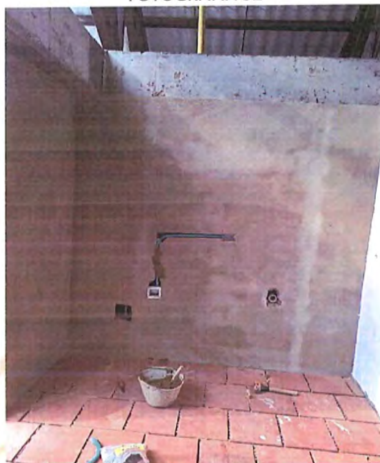
Instalación tubería pvc eléctrica tomacorriente en muros
