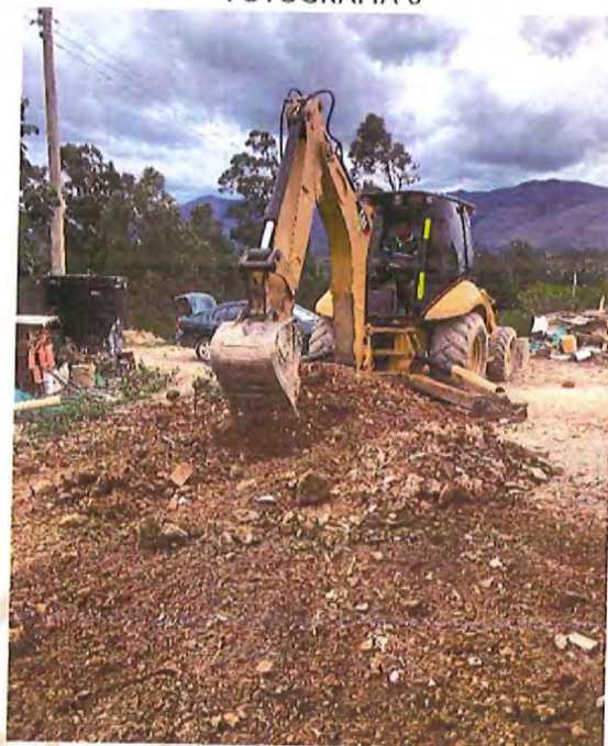
Excavación y nivelación del terreno
