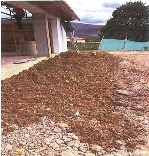
Relleno de material particular en el terreno
