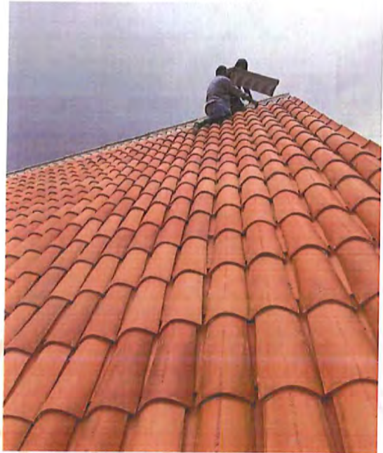
Proceso de recubrimiento de teja en drywall con teja tipo barro
