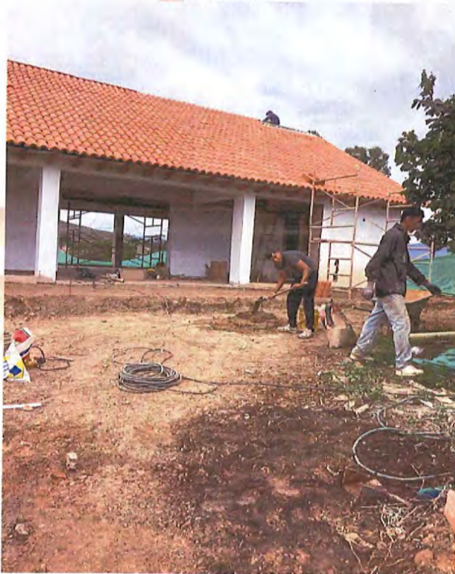
Relleno de material agregado sección 2
