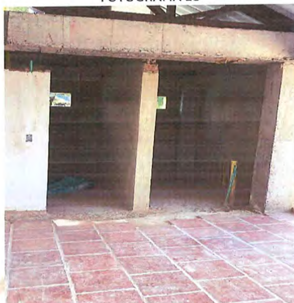
Instalación Tubería PVC sanitaria y eléctrica interior
