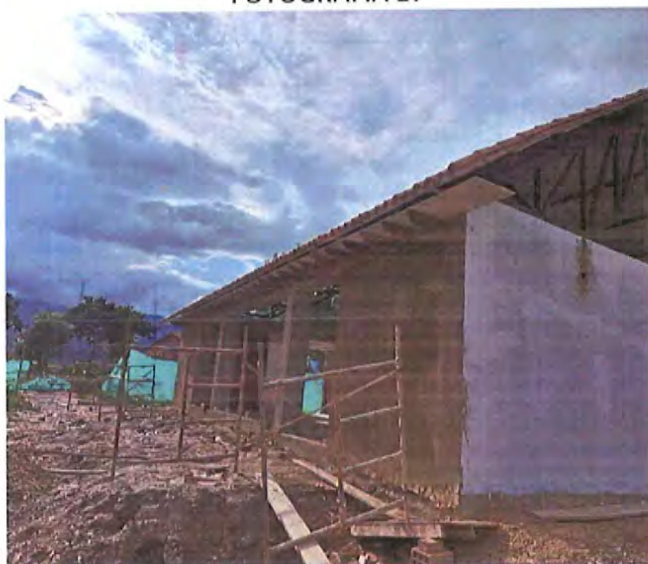
Instalación general bases estribos en madera
