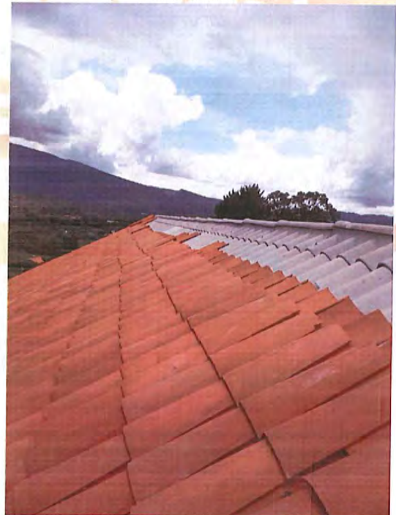
Proceso de recubrimiento de teja en drywall con teja tipo barro
