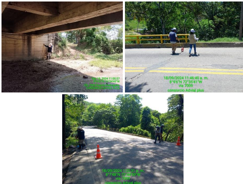
Imagen 8.37, 8.38 y 8.39 Inspección e inventario de puentes vía 7009
