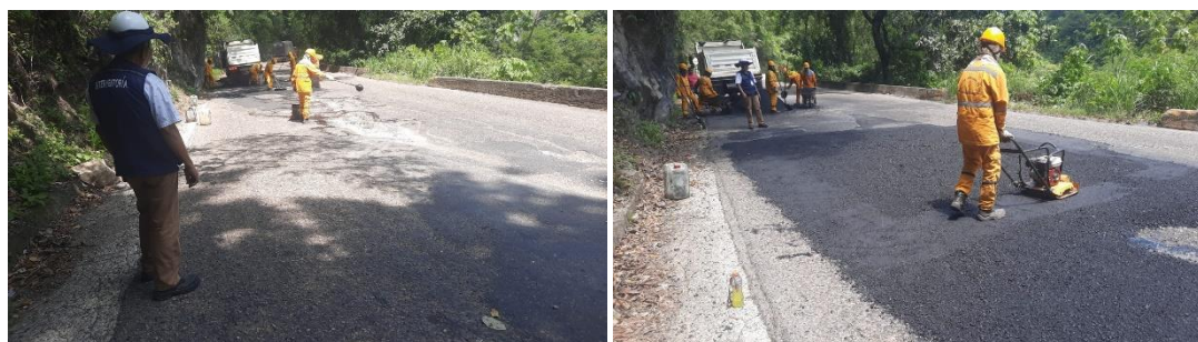
Imagen 8.35 y 8.36 Parcheo vía 7008 PR 116+514.
