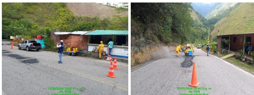
Imagen 3.10 y 3.11. Jornada de tapahuecos PR 91+000 al PR 95+000 de la vía 7008
