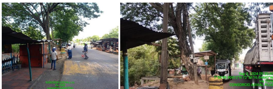
Imagen 8.13 y 8.14 PR 55+0570 vía 7009 poste de luz inclinado
