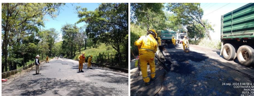
Imagen 8.50 y 8.51 Parcheo vía 7009 PR 14+500, PR17+000 y placa del puente la Chacona PR9+000
