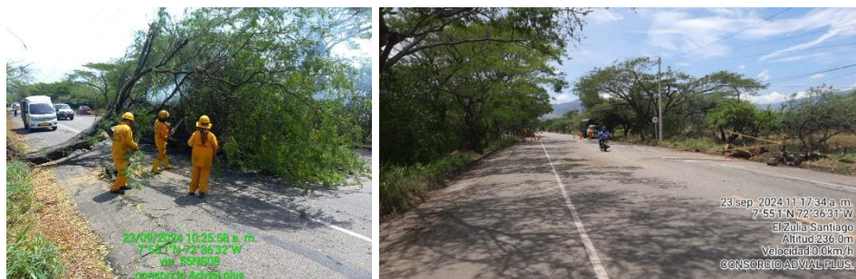
Imagen 6.5 y 6.6. Día 23 de septiembre emergencia en la vía 70NSA apoyo Cootrazuyepal
