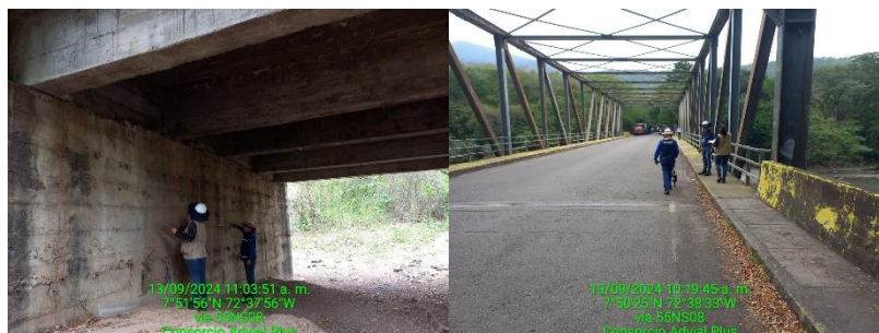
Imagen 8.29 y 8.30 Levantamiento inventario e inspección puentes
