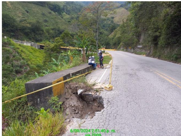
Imagen 8.3. Puente Quebrada la Quinta PR 93+000 vía 7009
