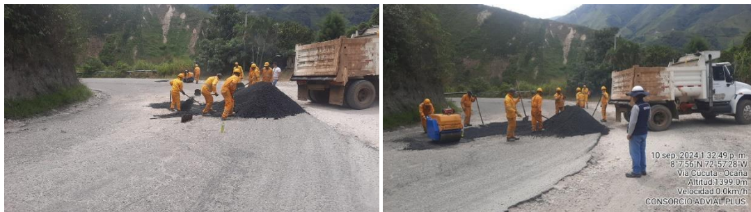
Imagen 3.4 y 3.5. Jornada de tapahuecos PR 90+000 al PR 93+000 sector Alto el Pozo vía 7008
