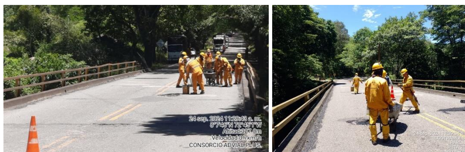
Imagen 5.12 y 5.13. Condición inicial, y actividad de bacheo en el PR 9+000
