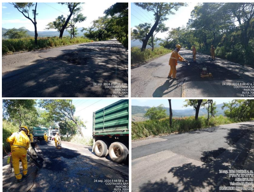
Imagen 5.8, 5.9, 5.10 y 5.11. Condición antes y después del bacheo PR 14+500 al PR 17+000
