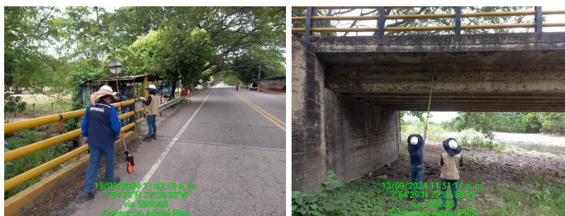
Imagen 8.27 y 8.28 Levantamiento inventario e inspección puentes
