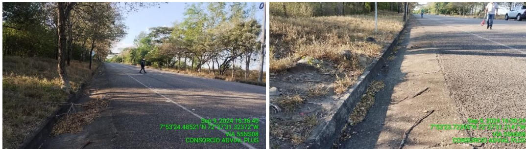
Imagen 8.7 y 8.8 PR 31+100 vía 55NS08 cuneta
