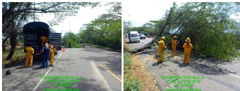
Imagen 8.44 y 8.45 Vía 55NS08 poda y tala de arboles
