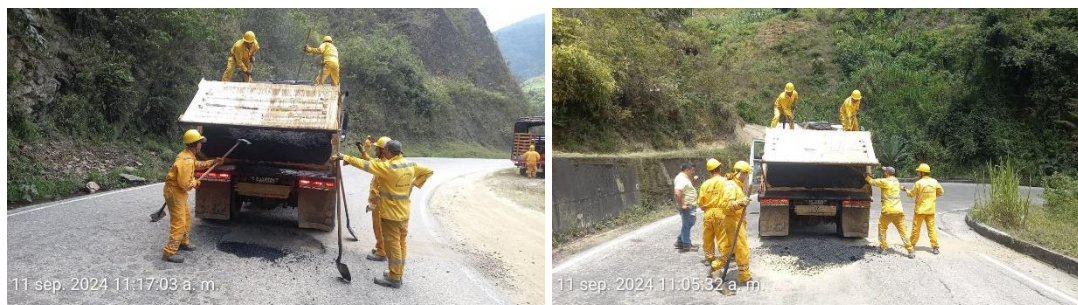
Imagen 3.8 y 3.9. Jornada de tapahuecos PR 79+000 al PR 91+000 de la vía 7008
