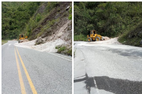
Imagen 8.52 y 8.53 PR100+180 vía 7008 retiro de pequeños derrumbes
