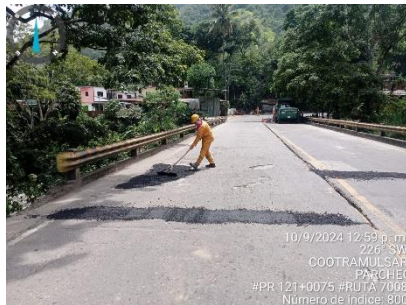
Imagen 8.18, 8.19 y 8.20 Vía 7008 PR 121+000 y tramo del PR 90+000 al PR 93+000 jornada de parcheo
