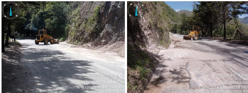
Imagen 8.46 y 8.47 PR101+600 vía 7008 retiro derrumbe
