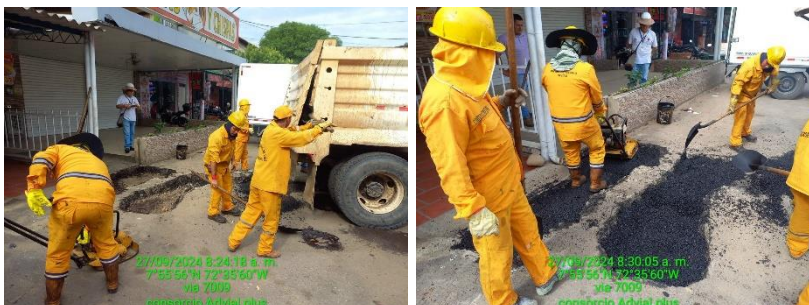
Imagen 8.56 y 8.57 Parcheo PR 57+600 vía 7009
