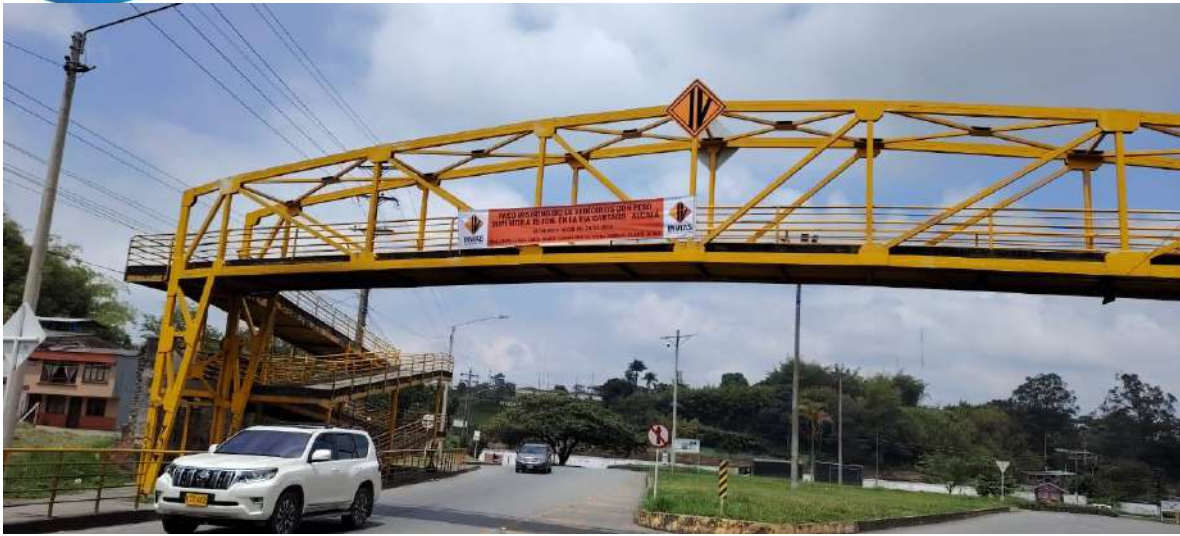
11-10-2024 Ruta 40QN05 PR 0+0000 Instalación Pasacalle
