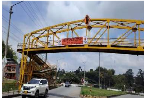
Imagen 1 y 2 Instalacion de vallas informativas PR 3+0900 RUTA 4003 y PR 0+000 RUTA 25VL07
