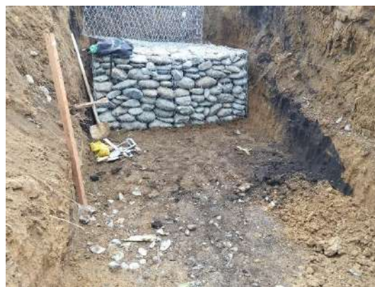
Imagen 1 y 2 PR 5+0450 RUTA 40QN05 Construcción de Muro en gaviones
