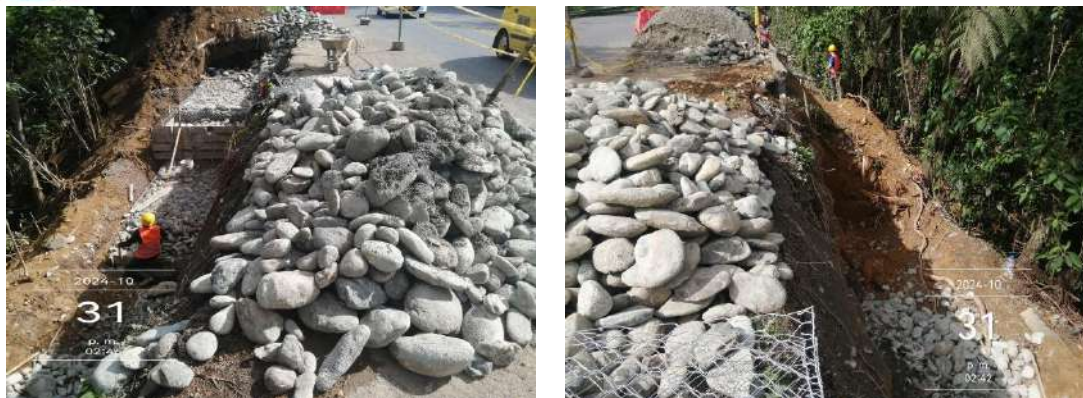
Imagen 3 y 4 PR 5+0450 RUTA 40QN05 Construcción de Muro en gaviones
