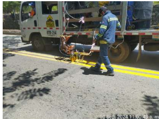
Imagen 7 y 8. Actividades de demarcación horizontal PR 0+000 a PR 10+0150 RUTA 25VL07
