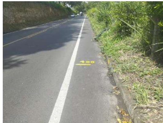
Imagen 6,7 y 8 PR 9+0400 Demarcación de Abscisado RUTA 2901B
