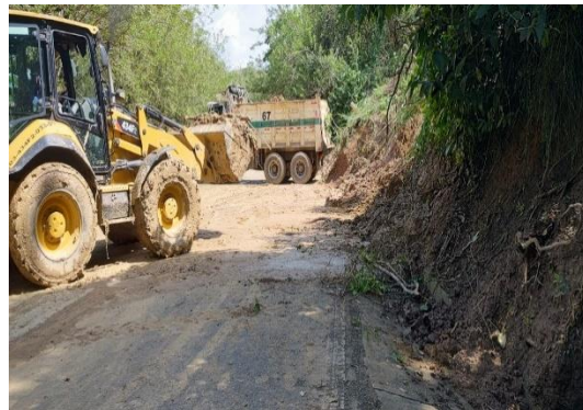
Imágenes. 3 y 4 RUTA 25VL07 PR 4 +0750 labores de remoción de derrumbe
