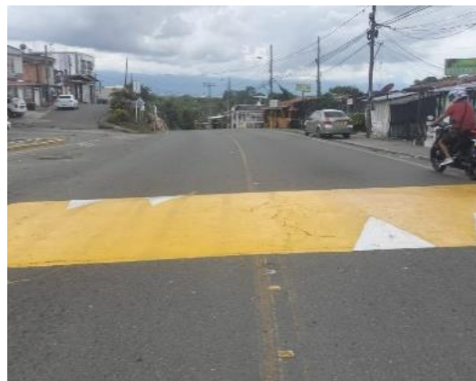
Imagen 8 labores de pintura de resaltos
