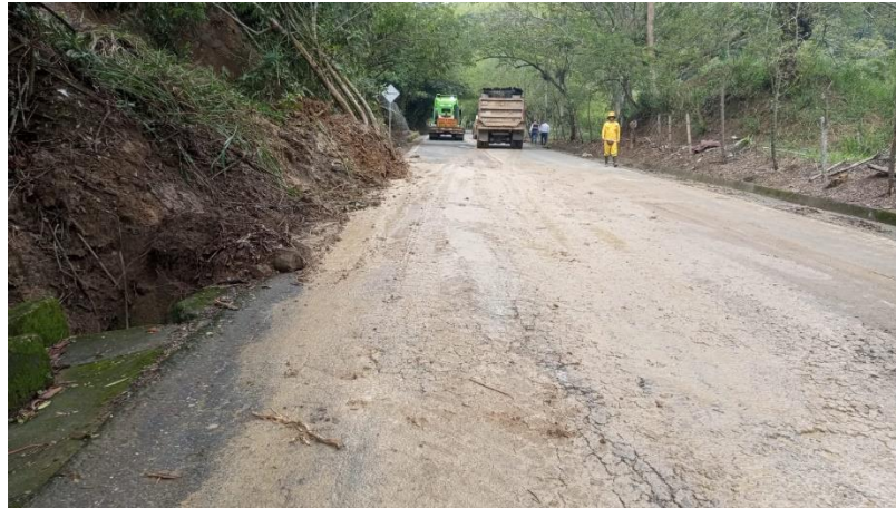
Imágenes. 8 RUTA 25VL07 PR 8 +0250 habilitación de la vía
