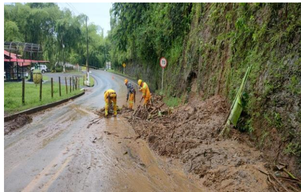
Imágenes. 1 y 2 RUTA 2901B PR 15 +0500 labores de Remoción de derrumbe
