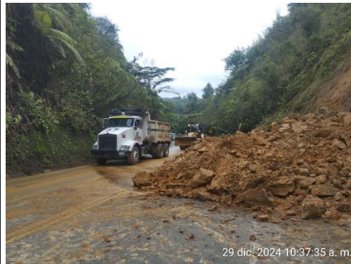
Imágenes. 1 y 2 RUTA 40QN05 PR 3 +0100 labores de Remoción de derrumbe
