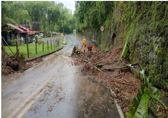
Imágenes. 1 y 2 RUTA 2901B PR 15 +0500 labores de Remoción de derrumbe
