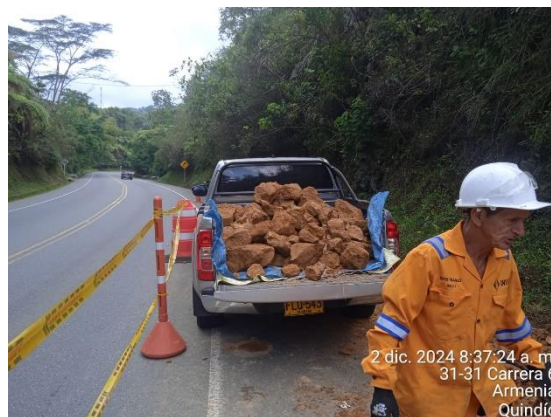
Imagen 1, 2 y 3 Remoción material de derrumbe Ruta 40QN05
