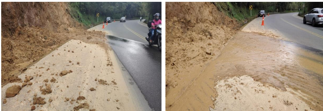
Imágenes. 1 y 2 RUTA 40QN05 PR 3 +0100 limpieza de calzada
