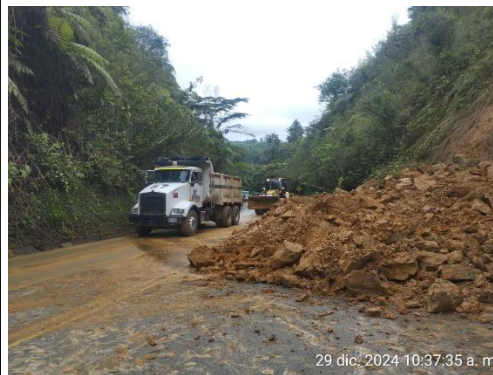
Imágenes. 1 y 2 RUTA 40QN05 PR 3 +0100 labores de Remoción de derrumbe
