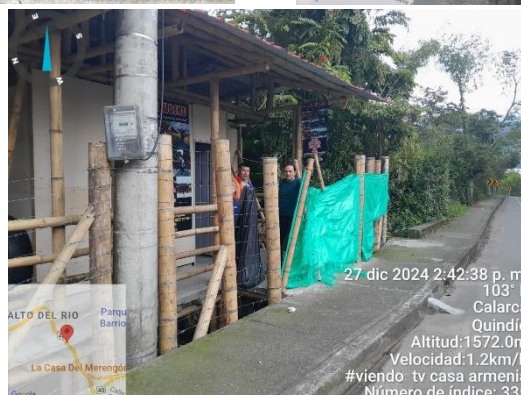
Imagen 64, 65 y 66 Inspección y verificación alcantarillado Pr 2+0616 ruta 4003.
