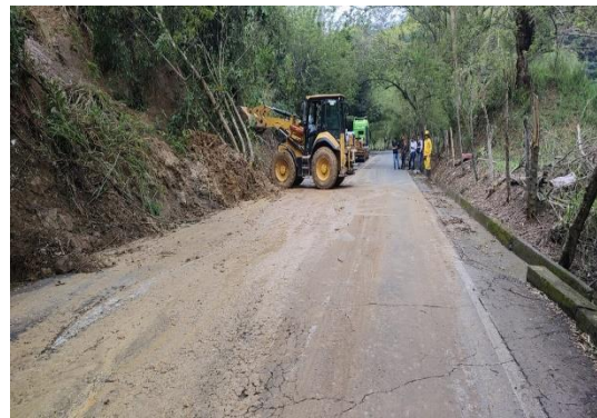
Imágenes. 6 y 7 RUTA 25VL07 PR 8 +0250 Remoción de derrumbes
