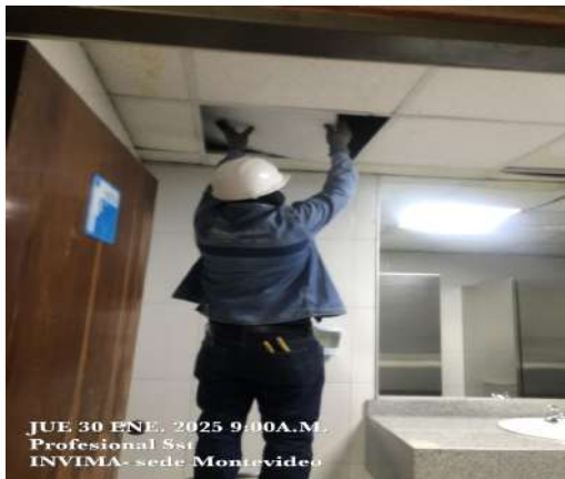
Edificio Montevideo cambio de iluminarias
