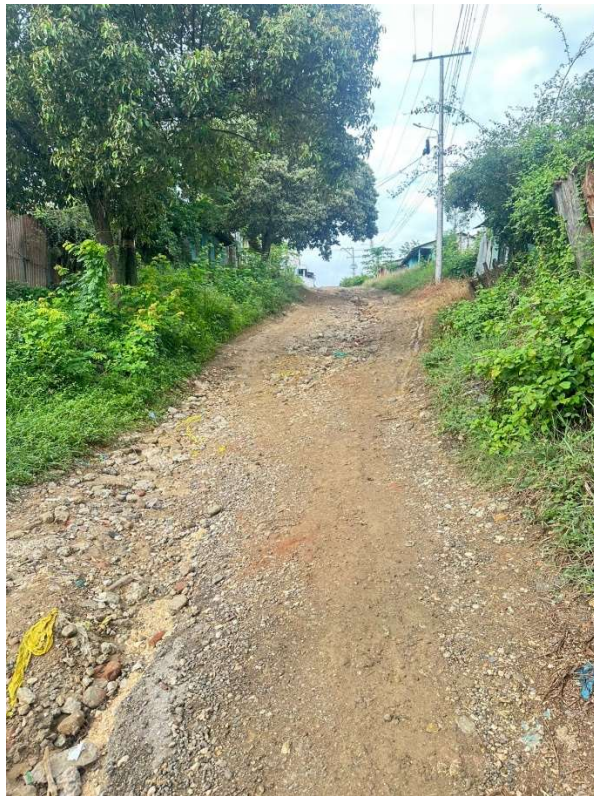
Ilustración 5. Estado inicial tramo 2
