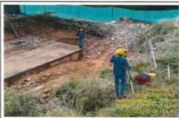
Fotografía 69: Verificación topográfica de las cotas de la viga cabezal.
