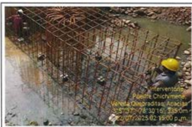
Fotografía 67: Uso de EPPs por el personal operativo de obra.
