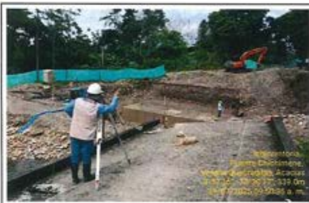
Fotografía 71: Inspección topográfica y verificación de cotas de los aceros y la viga cabezal margen Quebraditas.
