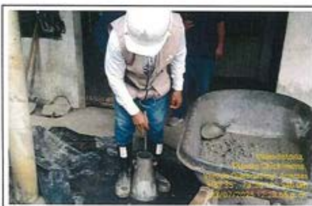
Fotografía 49: Control de Concreto mediante Ensayo de Asentamiento para viga cebazal margen Quebraditas.
