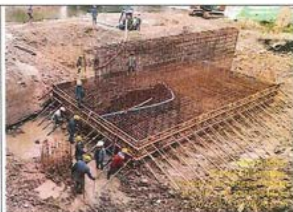
instalación de formaletas para encofrado de la viga cabezal del costado Quebraditas.
