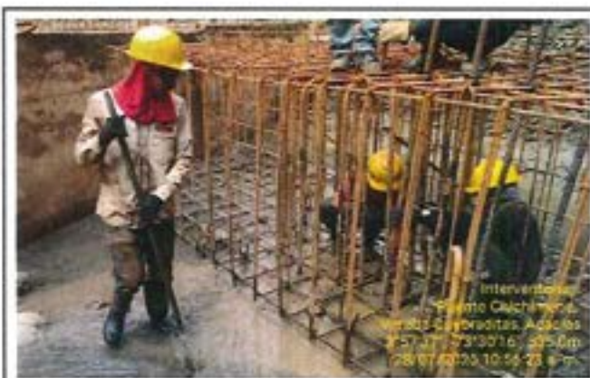
Fotografía 06: Armado de aceros para la viga cabezal estribo Palomas.
