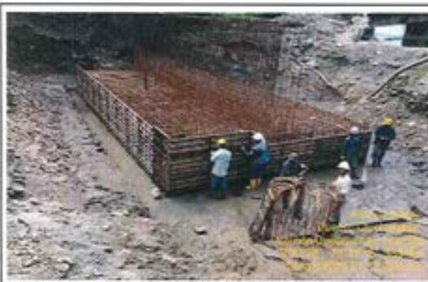
Fotografía 09: Instalación de formaletas para encofrado del dado de la viga cabezal en estribo Quebraditas.
