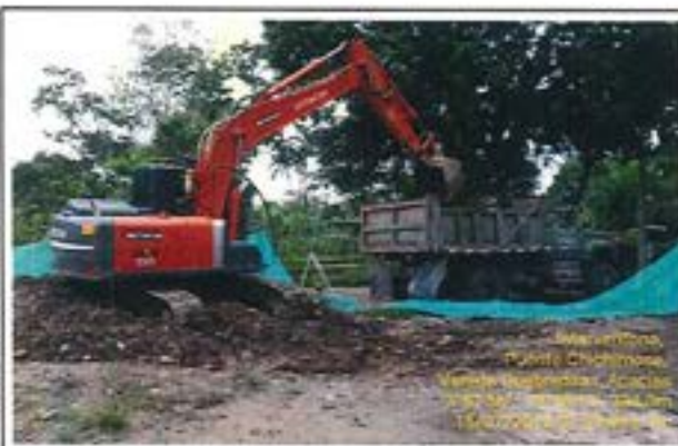
Fotografía 55: Cargue y transporte de material sobrante de la excavación.
