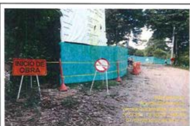
Fotografía 25: Verificación señalización preventiva.
