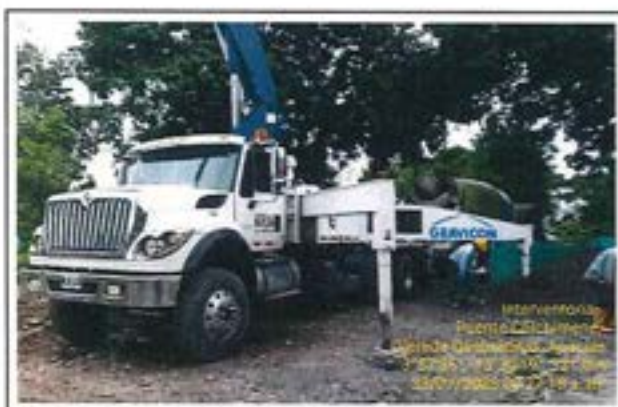
Fotografía 41: Vaciado de concreto de 4.000 PSI para el dado de la viga cabezal en estribo Quebraditas.
