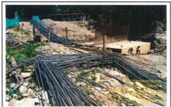
Fotografía 14: Acopio de aceros de refuerzo para estribos.
