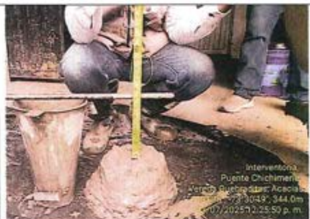
Verificación del "slump" o asentamiento.
