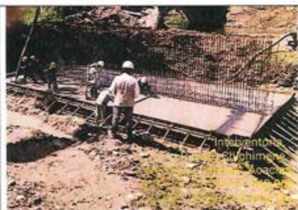
Verificación de vaciado de concreto para viga cabezal margen Quebraditas.
