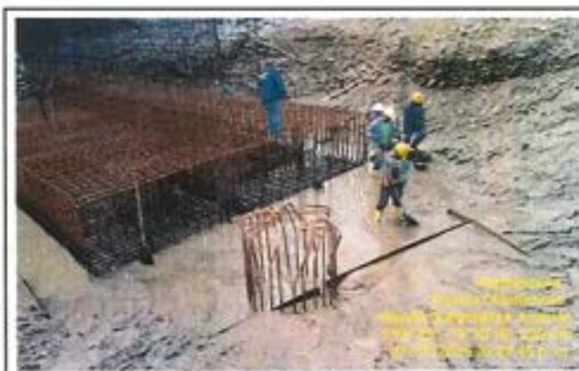
Fotografía 08: Limpieza y preparación de acero para encofrado de la viga cabezal margen Quebraditas.
