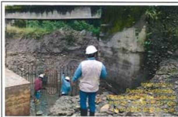
Fotografía 47: Inspección de armado de aceros para la muro aletas de margen Palomas.
