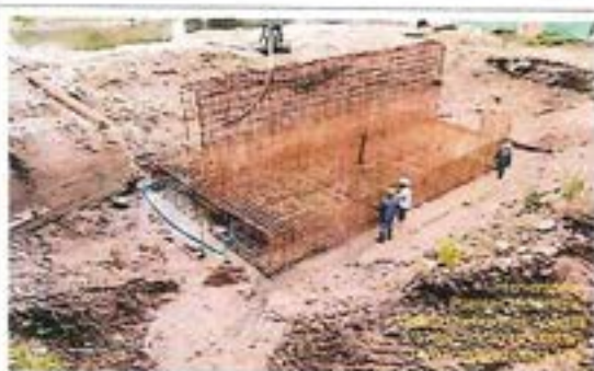
FECHA FOTO: 14-Julio-2025 DESCRIPCIÓN: Inicio de encofrado del dado viga Quebraditas
