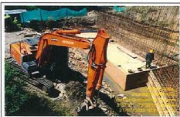
Fotografía 54: Excavación con Retroexcavadora para Relleno Perimetral de Viga Cabezal – Margen Palomas
