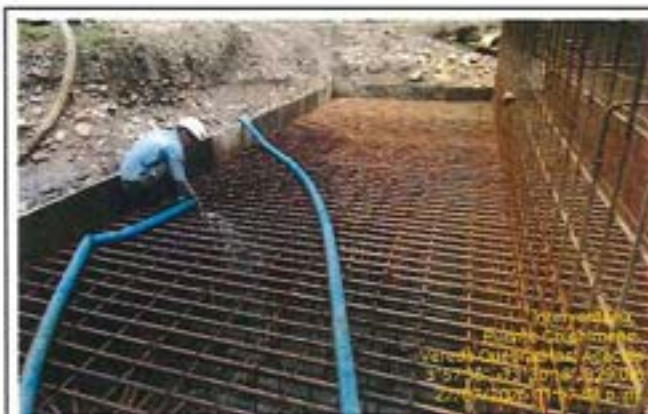
Fotografía 40: Limpieza de los aceros y lavado de lodos sedimentados
