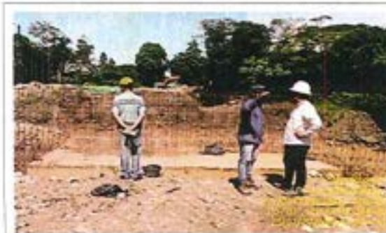
FECHA FOTO: 25-Julio-2025 DESCRIPCIÓN: Visita de control de obra por parte de la supervisión
