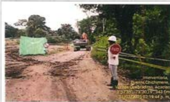
FECHA FOTO: 21-Julio-2025 DESCRIPCIÓN: Control vial para las actividades de obra.
