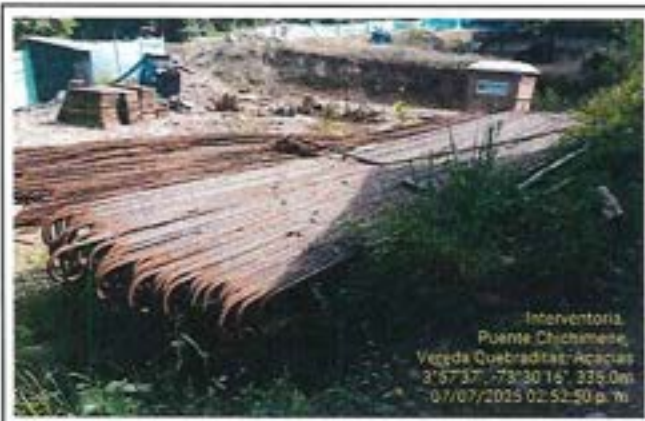
Fotografía 13: Acopio de aceros de refuerzo para estribos.
