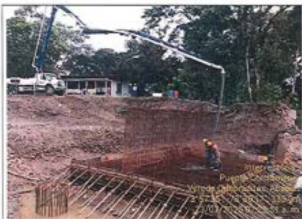
Vaciado de concreto para viga cabezal del costado Quebraditas.
