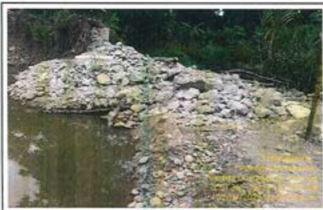
Fotografía 15: Demolición de una sección del puente antiguo.
