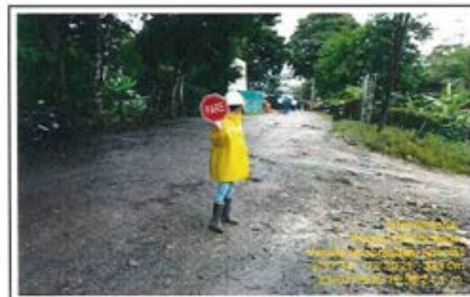
Fotografía 36: Verificación del control vial.
