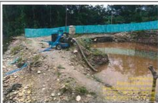
Fotografía 21: Manejo de aguas mediante bombeo mecánico.
