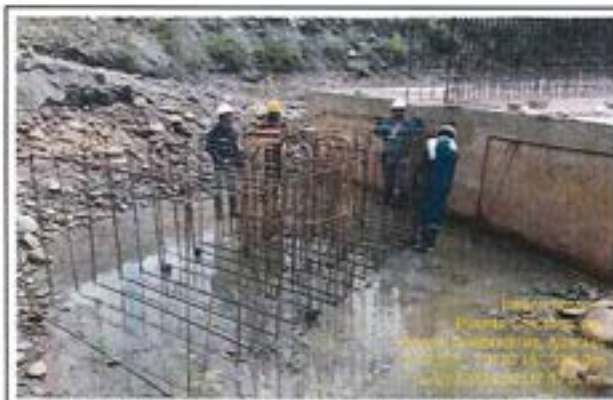
Fotografía 03: Armado de acero para la zapata aletas margen Palomas.
