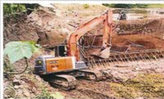
FECHA FOTO: 21-Julio-2025 DESCRIPCIÓN: Reforzamiento del encofrado para viga cabezal costado Quebraditas.
