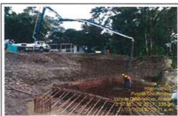
Fotografía 42: Vaciado de concreto de 4.000 PSI para el dado de la viga cabezal en estribo Quebraditas.
