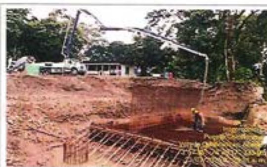
FECHA FOTO: 19-Julio-2025 DESCRIPCIÓN: Vaciado de concreto para viga cabezal costado Quebraditas.
