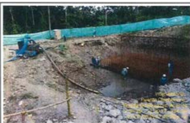
Fotografía 07: Limpieza y preparación de acero para encofrado de la viga cabezal margen Quebraditas.
