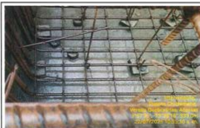
Fotografía 38: Instalación de separadores de acero.
