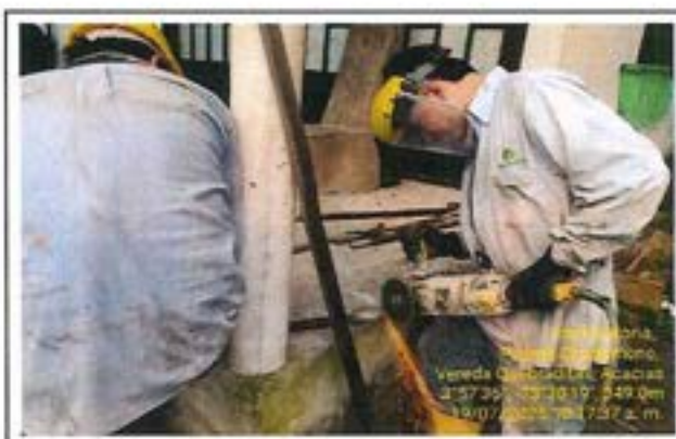
Fotografía 68: Uso de EPPs por el personal operativo de obra.
