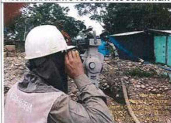
Verificación de cotas para colocación de aceros de la viga cabezal por parte de interventoría.
