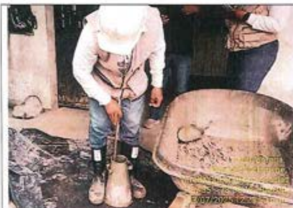
Verificación del "slump" o asentamiento.
