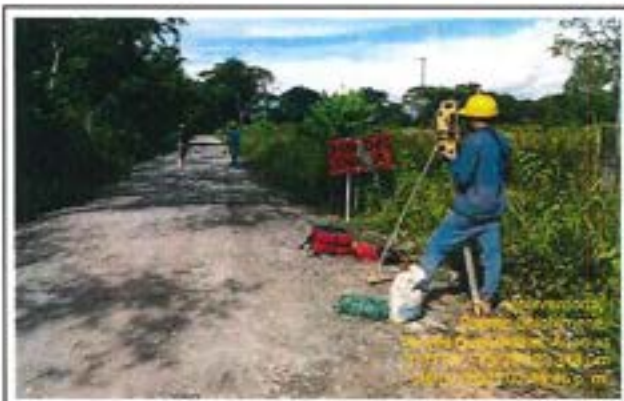
Fotografía 70: Replanteo topográfico del componente vial.
