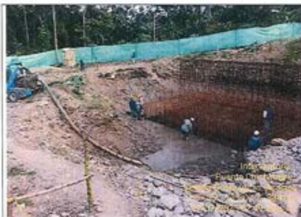
Armado de aceros para la viga cabezal del costado Quebraditas.
