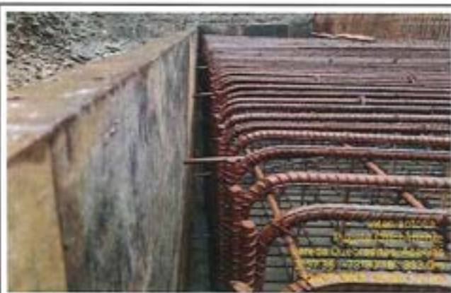
Fotografía 37: Instalación de separadores de acero.
