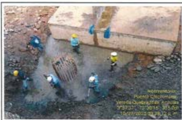
Fotografía 01: Limpieza y preparación del área para armado de acero para la zapata aletas margen Palomas.
