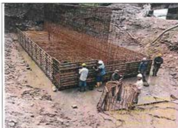
Instalación de formaletas para encofrado de la viga cabezal del costado Quebraditas.
