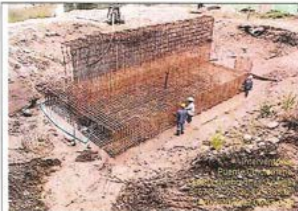
Armado de aceros para la viga cabezal.
