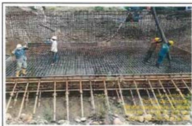
Fotografía 43: Vaciado de concreto de 4.000 PSI para el dado de la viga cabezal en estribo Quebraditas.
