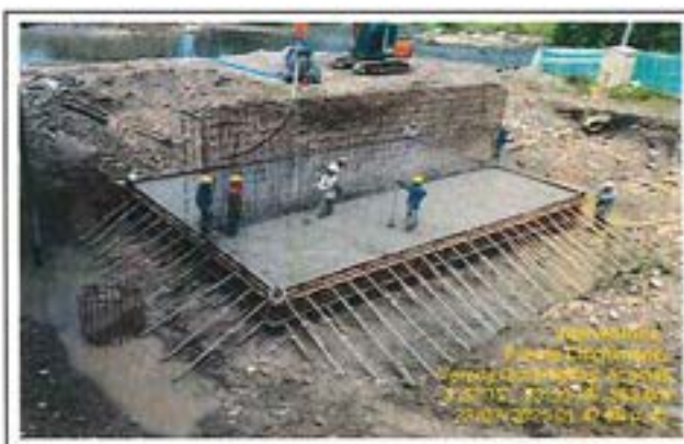
Fotografía 44: Vaciado de concreto de 4.000 PSI para el dado de la viga cabezal en estribo Quebraditas.
