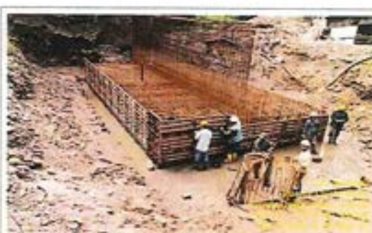
FECHA FOTO: 15-Julio-2025 DESCRIPCIÓN: Inicio de encofrado del dado viga Quebraditas
