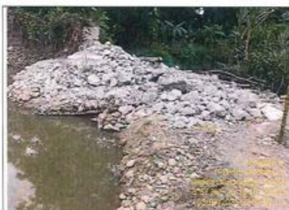
Puente existente en proceso de demolición.
