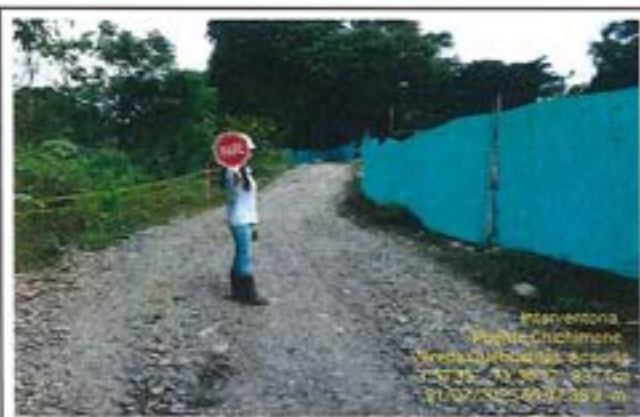
Fotografía 35: Verificación del control vial.
