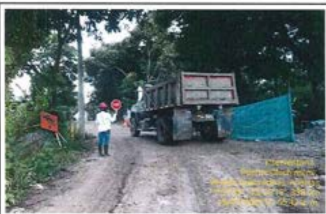
Fotografía 33: Verificación del control vial.
