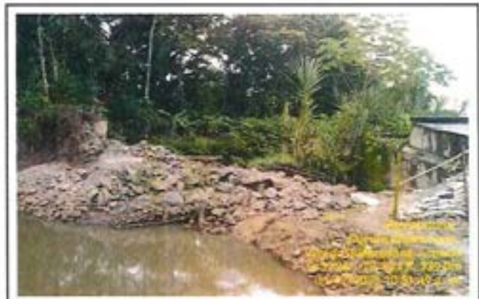
Fotografía 16: Demolición de una sección del puente antiguo.
