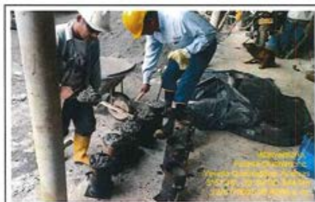
Fotografía 52: Toma de Muestra de Concreto Fresco para Ensayo de Laboratorio de viga cebazal margen Quebraditas.
