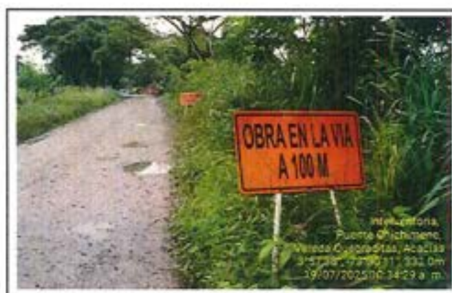
Fotografía 26: Verificación señalización preventiva.
