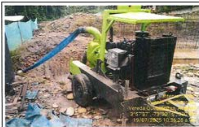
Fotografía 22: Manejo de aguas mediante bombeo mecánico.
