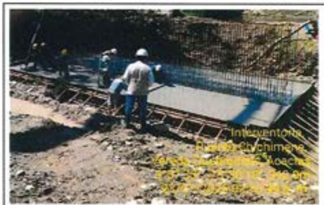
Fotografía 46: Inspección vaciado de concreto de 4.000 PSI para el dado de la viga cabezal en estribo Quebraditas.
