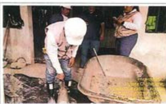
FECHA FOTO: 23-Julio-2025 DESCRIPCIÓN: Ensayo de asentamiento para control de calidad del concreto para la viga cabezal costado Quebraditas.
