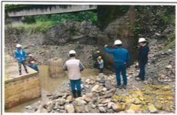
Fotografía 63: Cargue y transporte de material sobrante de la excavación.
