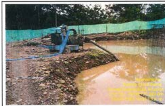
Fotografía 24: Manejo de aguas mediante bombeo mecánico.
