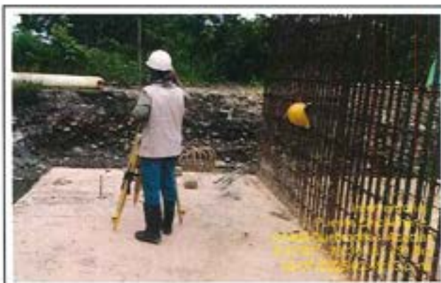
Fotografía 72: Inspección topográfica y verificación de cotas de los aceros y la viga cabezal margen Palomas.
