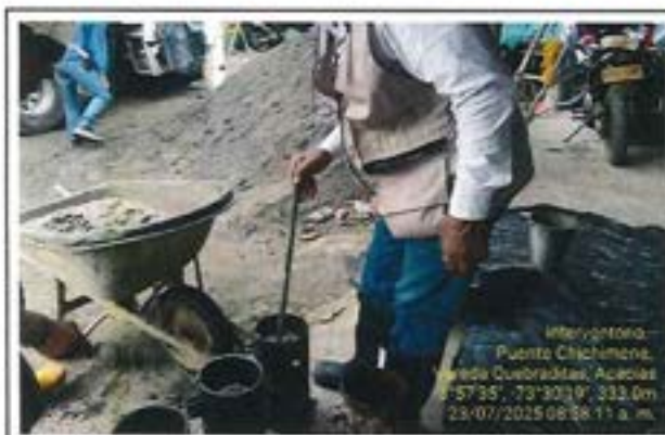
Fotografía 51: Toma de Muestra de Concreto Fresco para Ensayo de Laboratorio de viga cebazal margen Quebraditas.
