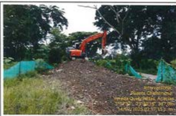
Fotografía 53: Excavación con Retroexcavadora para Plataforma de Trabajo de Vigas Metálicas.
