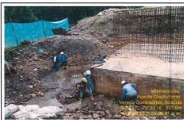
Fotografía 02: limpieza y preparación del área para armado de acero para la zapata aletas margen Palomas.
