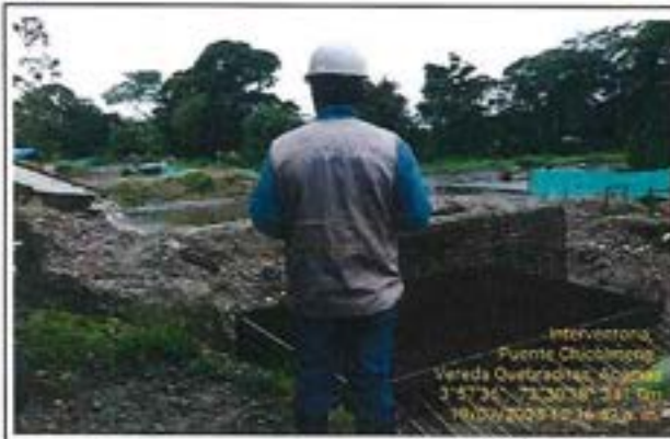
Fotografía 45: Inspección de armado de aceros para la viga cabezal margen Quebraditas.
