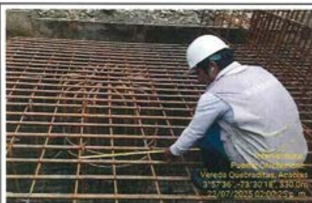
Fotografía 39: Verificación de la distribución, separación y traslape de aceros en viga cabeza margen Quebraditas.
