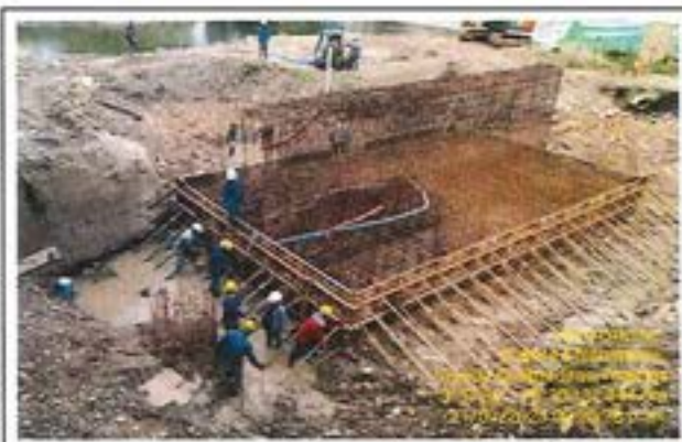
Fotografía 12: Instalación de formaletas para encofrado del dado de la viga cabezal en estribo Quebraditas.
