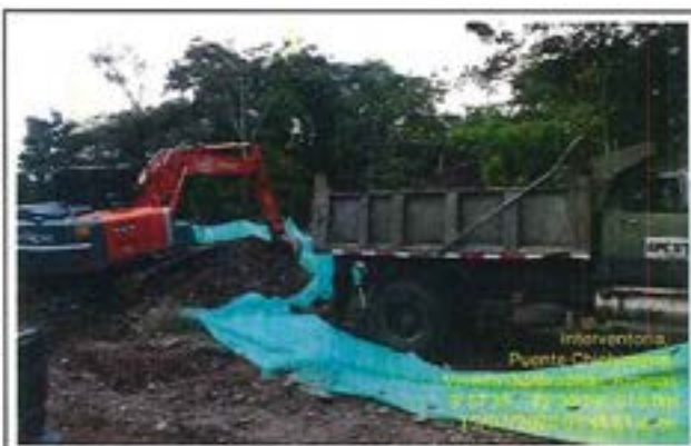
Fotografía 56: Cargue y transporte de material sobrante de la excavación.
