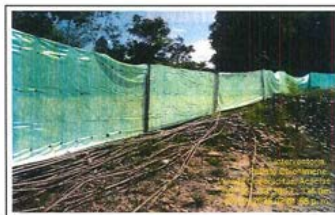
Fotografía 28: Verificación señalización preventiva.
