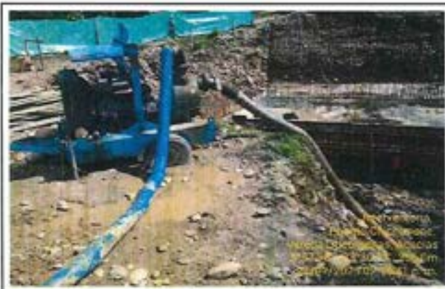
Fotografía 23: Manejo de aguas mediante bombeo mecánico.
