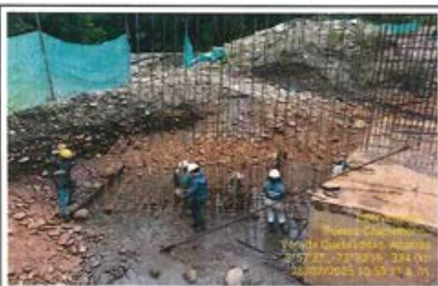
Fotografía 05: Armado de aceros para la viga cabezal estribo Palomas.
