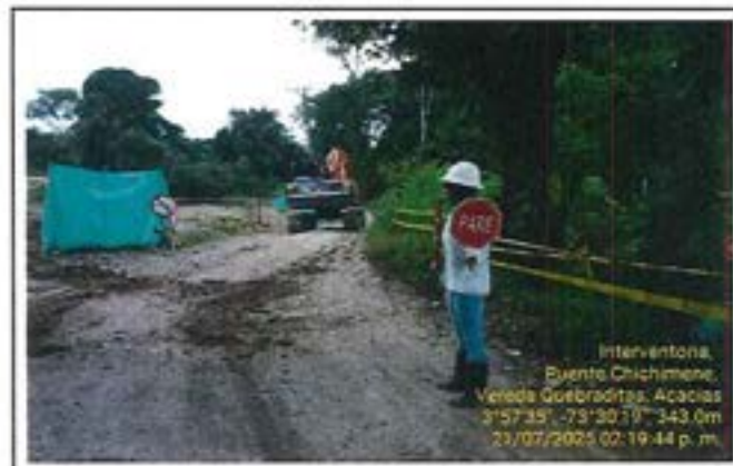
Fotografía 34: Verificación del control vial.
