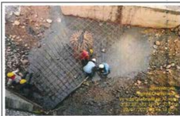
Fotografía 04: Armado de acero para la zapata aletas margen Palomas.
