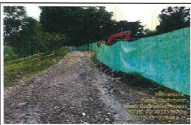
Fotografía 27: Verificación señalización preventiva.
