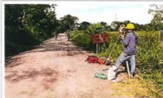
FECHA FOTO: 24-Julio-2025 DESCRIPCIÓN: Replanteo topográfico preliminar de las actividades del componente vial.
