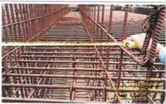
FECHA FOTO: 19-Julio-2025 DESCRIPCIÓN: Verificación de la distribución de los aceros para viga cabezal costado Quebraditas.
