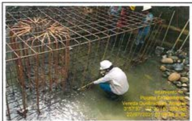
Fotografía 48: Verificación de la distribución, separación y traslape de aceros en muro aletas margen Palomas.
