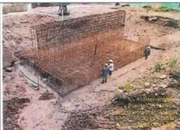
Armado de aceros para la viga cabezal del costado Quebraditas.
