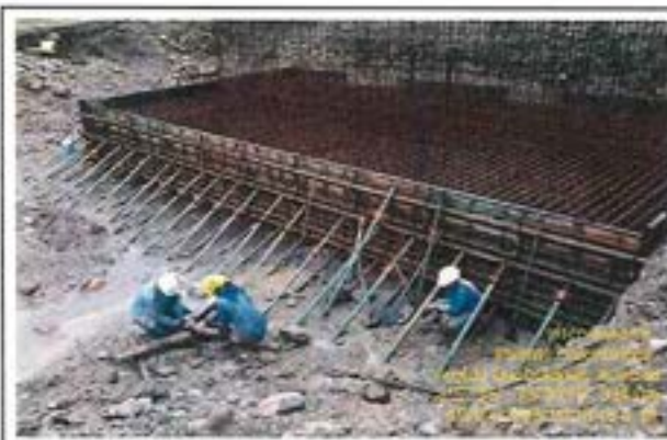
Fotografía 11: Instalación de formaletas para encofrado del dado de la viga cabezal en estribo Quebraditas.
