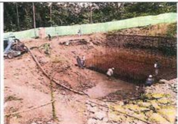
Armado de aceros para la viga cabezal.
