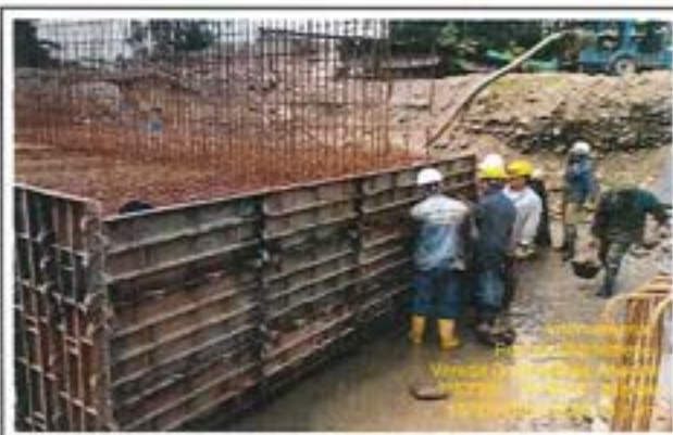
Fotografía 10: Instalación de formaletas para encofrado del dado de la viga cabezal en estribo Quebraditas.
