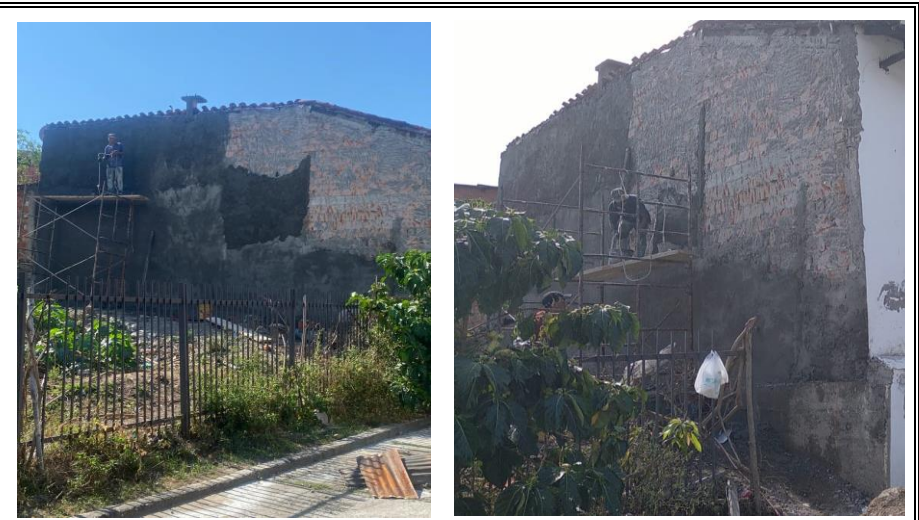
Comentario: Actividades de pañetado de muro posterior fachada.
