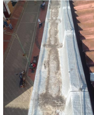
Limpieza vigacanal y sondeo bajantes
