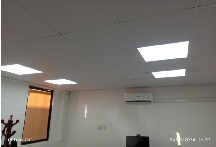
Cambio de luminarias- Luminarias Led 60x60
