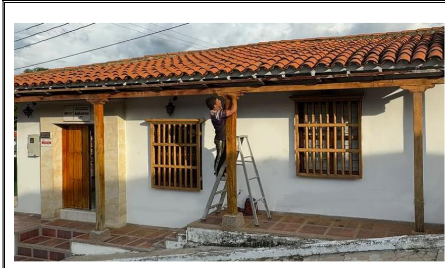
Comentario: estucado de areas afectadas, internas y externas.
