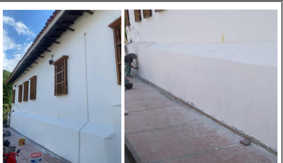
Comentario: estucado de areas afectadas, internas y externas.
