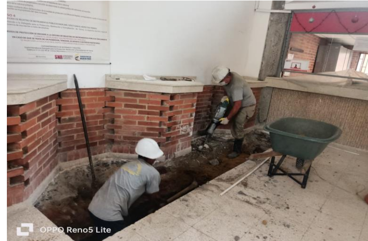
Demolicion y excavacion en zona de atencion al publico
