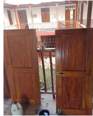
Mantenimiento ventanas en madera (Barniz)
