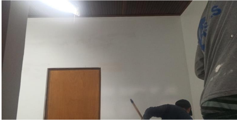
Pintura en vinilo muros interiores piso 2
