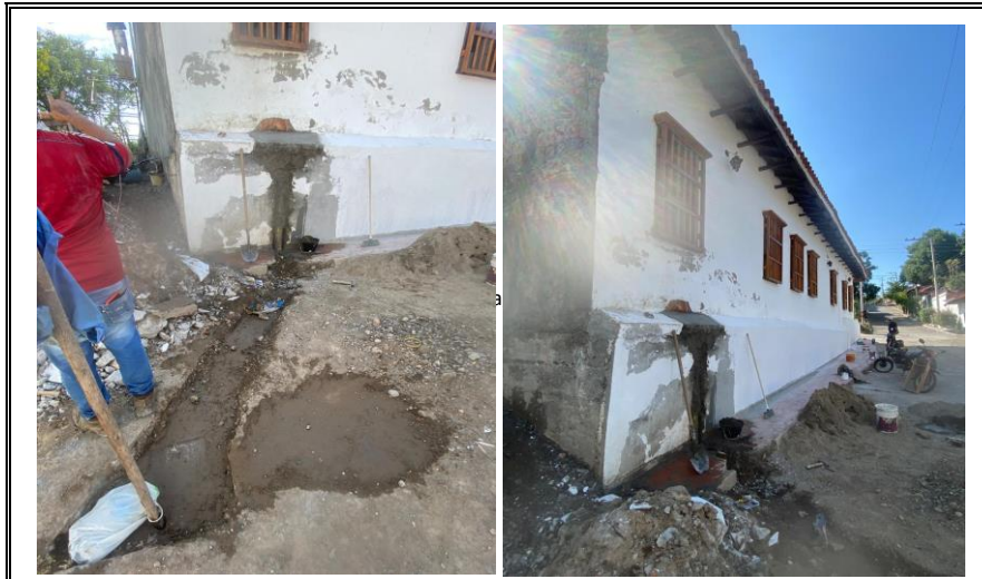
Comentario: relleno en recebo y concreto común rotura de calle
