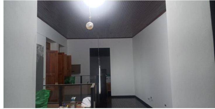
Pintura en vinilo muros interiores piso 2
