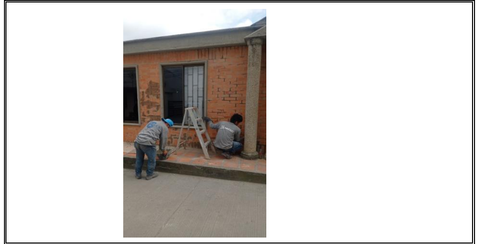
Reemboquille mortero ladrillos fachada
