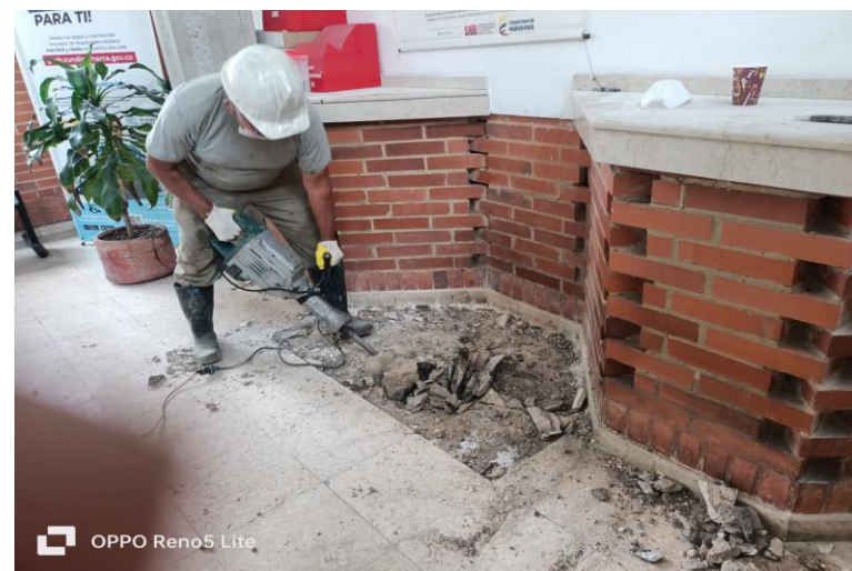
Demolicion en zona de atencion al publico
