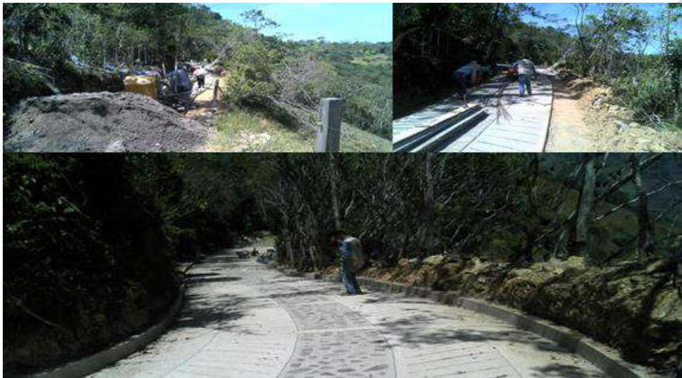
Fotografía 1. Construcción de placa huella
