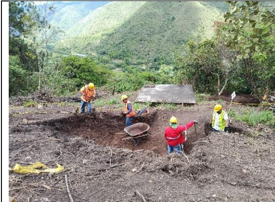
Ilustración 42. Excavación para Cámara de Lavado de Arenas
