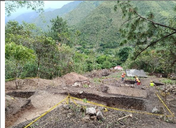
Ilustración 43. Excavaciones Manuales Cámara de Lavado de Arenas
