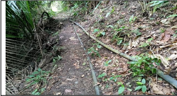
Ilustración 5. Localización en sitio de estructura llegada a PTAP
