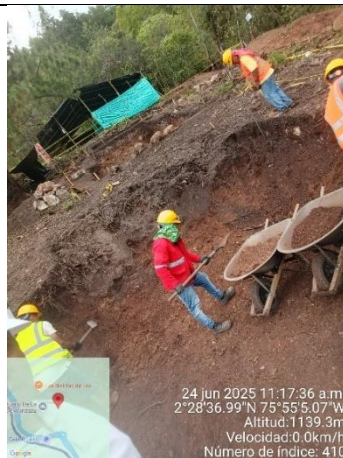
Ilustración 45. Excavaciones en Roca en Seco
