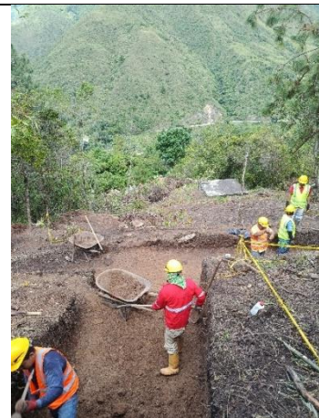
Ilustración 46. Excavaciones en Zona de Cámaras
