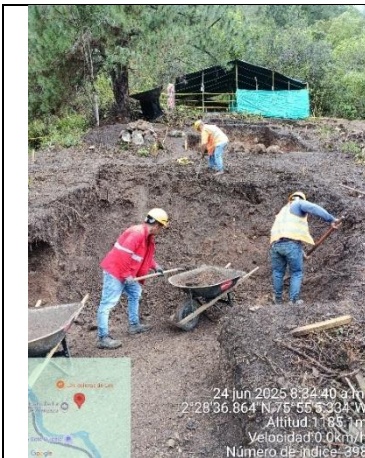
Ilustración 44. Excavación en Material Rocoso Cámaras
