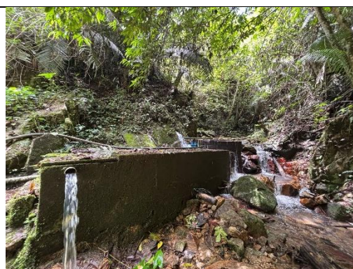
Ilustración 4. Localización en sitio de estructura llegada a PTAP
