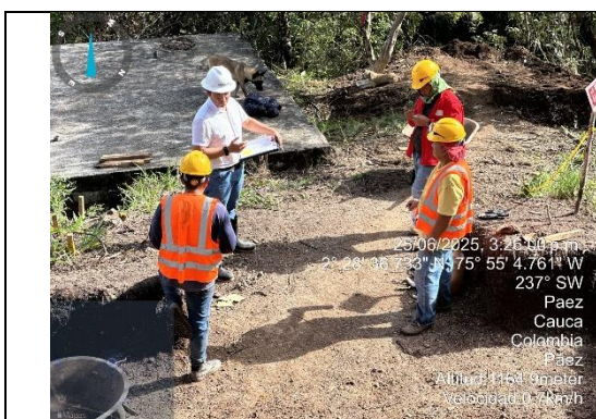
Ilustración 13. Charla de SST del Personal de Obra
