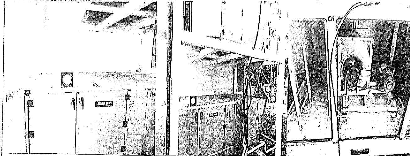
ACTIVIDADES DEL MANTENIMIENTO
