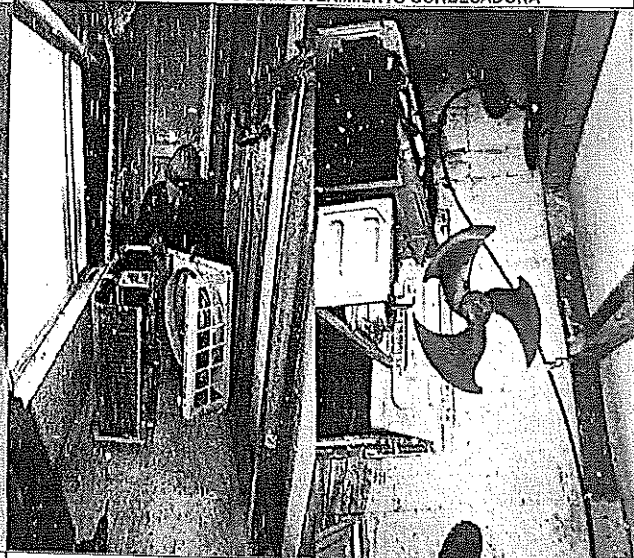
EQUIPO DESPUES DEL MANTENIMIENTO CONDESADORA
