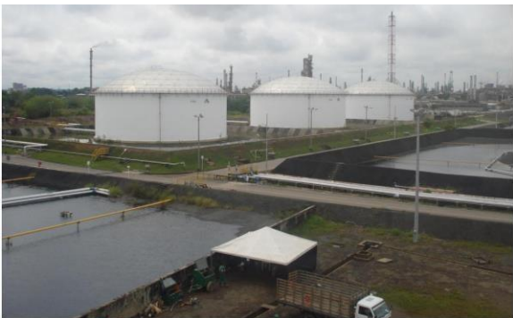
Foto 5. Tanque de Techo Geodésico o Domo
