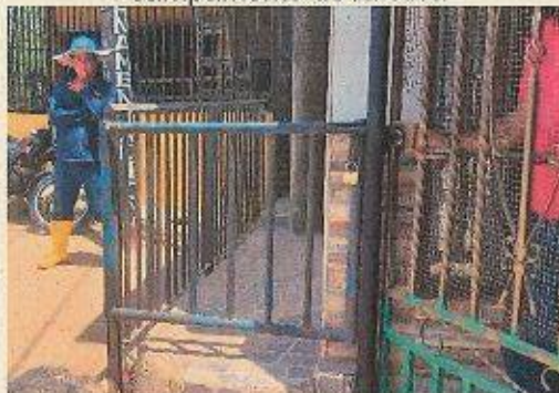
Arreglo a reja afectada por volqueta de la obra a vivienda de propiedad del Señor Yefferson Daniel Mejía Rodríguez
