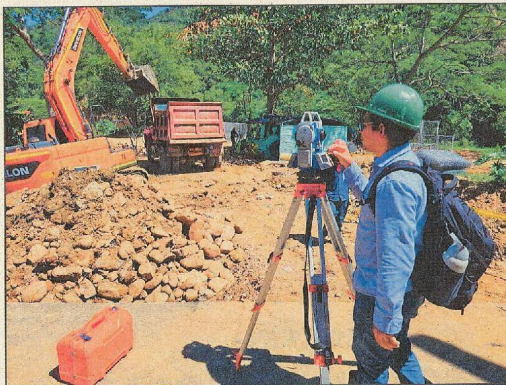
Trabajos de topografía.
