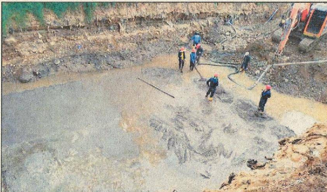
Suministro de concreto para solado.
