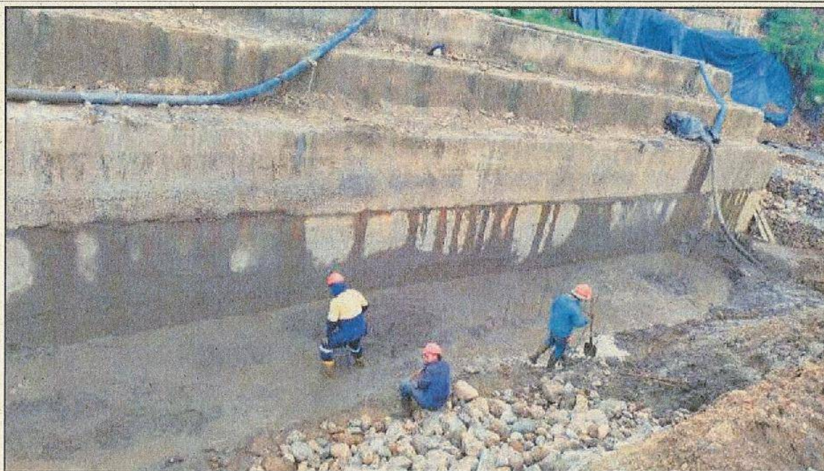
Suministro y colocación de concreto ciclópeo
