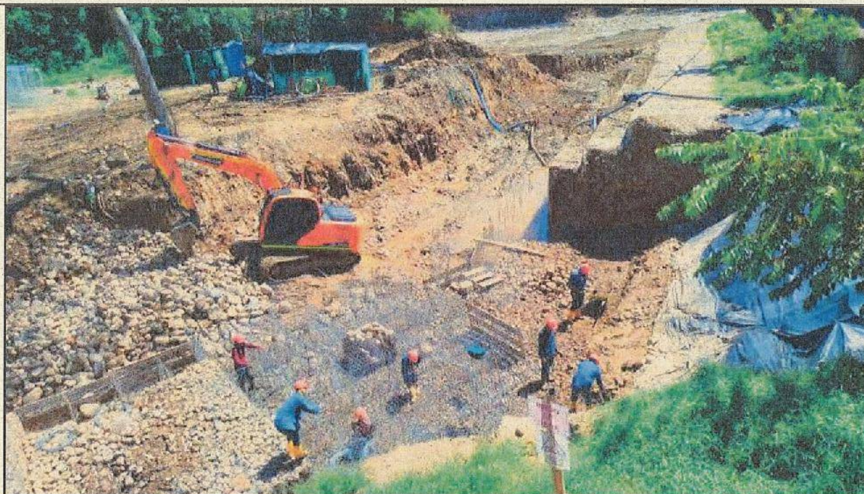
Trabajos en la margen derecha del río de oro
