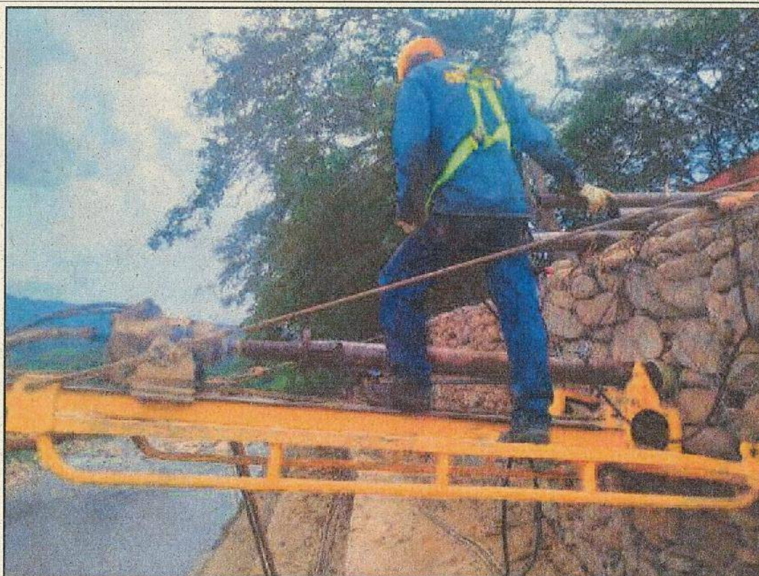
Ejecución de perforación horizontal para anclajes mayores a 15,00 m
