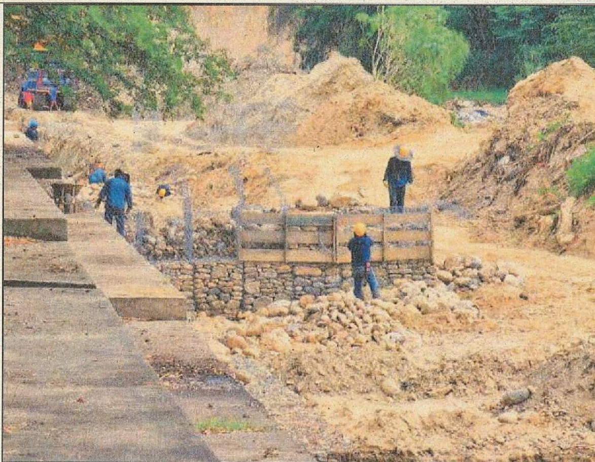
Gaviones con malla electrosoldada
