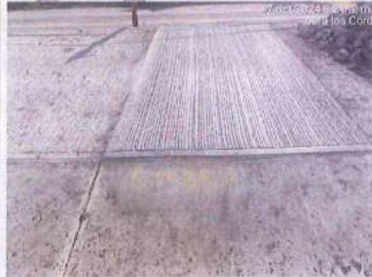
Abs K2+251,2: Se realiza corte a 1,50 m para que coincida con a la junta de la cuneta, demolición y reparación
