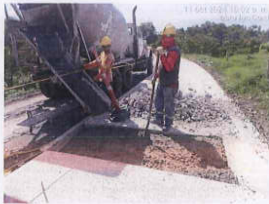
Abs K2+071,98: Se realiza corte a 1.10 m, demolición y reparación.
