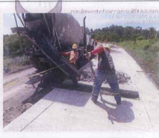
Abs K2+060.58: Se realiza corte a 0.5 m, demolición y reparación.
