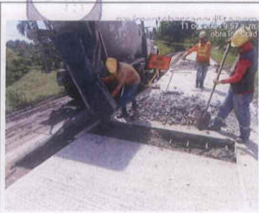
Abs K2+098,08: Se realiza corte a 0,6 m, demolición y reparación
