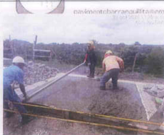
Abs K1+862.38: Se realiza reparación losa completa,
