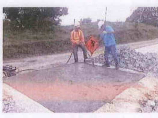
Abs K1+912.58: Se realiza corte de losa completa, demolición y reparación.
