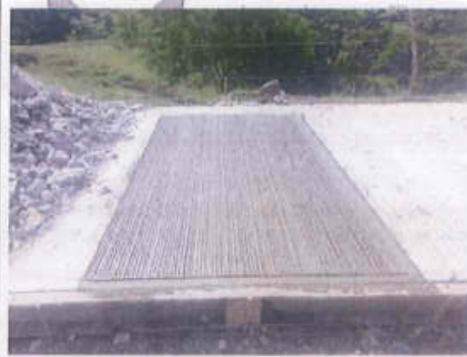
Abs K2+292: Se realiza corte a 1,50 m para que coincida con a la junta de la cuneta, demolición y reparación
