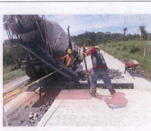
Abs K2+050.58: Se realiza corte a 0.5 m, demolición y reparación.
