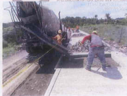
Abs K2+040.88: Se realiza corte a 1,50 m para que coincida con a la junta de la cuneta, demolición y reparación.
