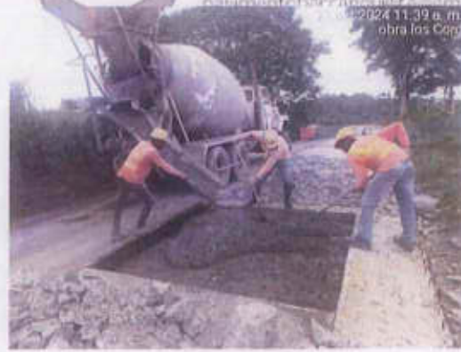
Abs K1+943.05: Se realiza corte de losa completa, demolición y reparación.
