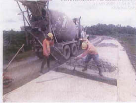
Abs K2+017.58: Se realiza corte a 0.5 m, demolición y reparación.
