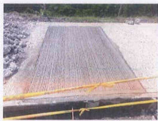
Abs K2+282,7: Se realiza corte a 1,50 m para que coincida con a la junta de la cuneta, demolición y reparación
