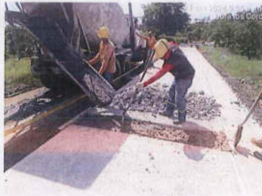
Abs K2+108,28: Se realiza corte a 0,50 m, demolición y reparación
