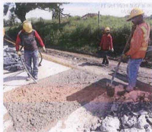
Abs K2+161,72: Se realiza corte a 1,50 m para que coincida con a la junta de la cuneta, demolición y reparación
