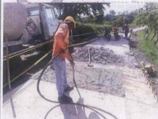
Abs K2+137,78: Se realiza corte a 1,50 m para que coincida con a la junta de la cuneta, demolición y reparación
