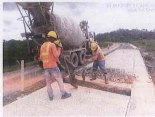
Abs K2+026.68: Se realiza corte a 0.5 m, demolición y reparación.
