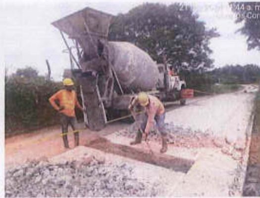
Abs K1+947.88: Se realiza corte a 0.5 m, demolición y reparación.
