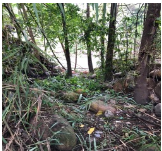
Fotografía 10. Área en donde se presentan deslizamientos de tierra y piedras que generan taponamiento del desagüe impidiendo que el agua discurra al río Apulo
