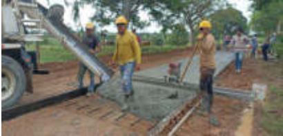
Construcción de pavimento rígido MR38 premezclado. Abscisa K1+850.
