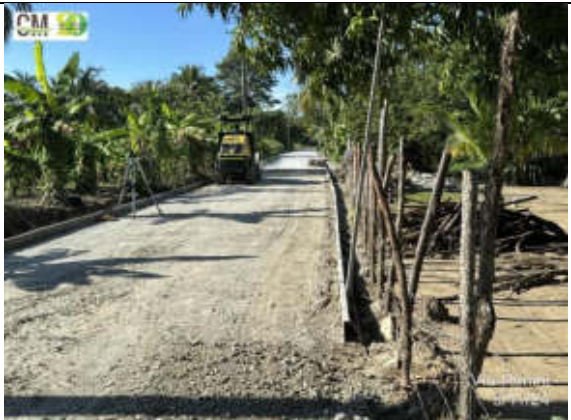
Foto 24. Compactación sub base – entre abscisas k0+075 a k0+000.
