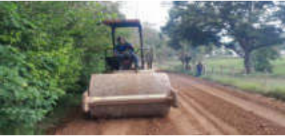
Suministro, extensión y compactación de subbase granular. Abscisa K2+100.
