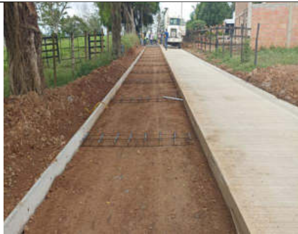
Foto 7. Construcción de Bermacunetas premezclado. Abscisa K1+980.
