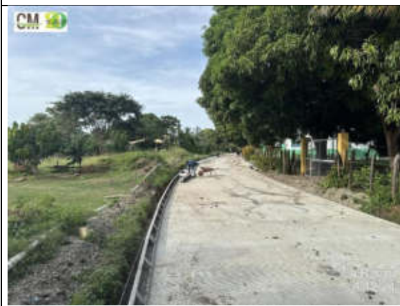
Foto 19 Instalación formaleta bordillo – abscisa k0+255 a k0+170
