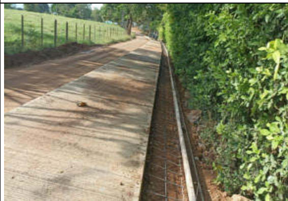
Foto 8. Construcción de Bermacunetas premezclado. Abscisa K1+840.
