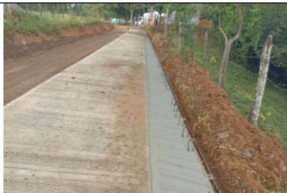
Foto 7. Construcción de Bermacunetas premezclado. Abscisa K1+980.
