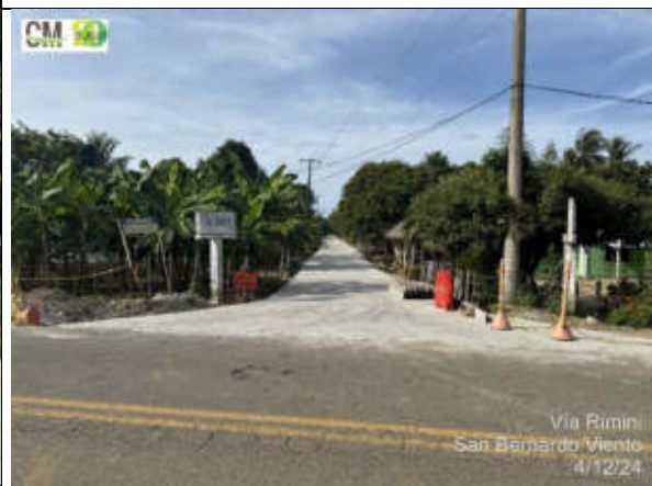
Foto 20. Vista general pavimento – abscisas k0+000
