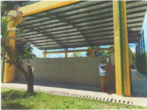
Verificación de condiciones adecuada Polideportivo el Turbay
