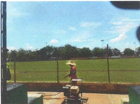
Adecuación muros alrededor del estadio municipal
