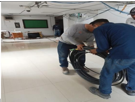
Tensido cable acometida electrica desde subestacion a TGA
