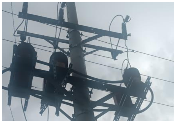
Montaje herrajes transformador de 150 KVA y sus protecciones
