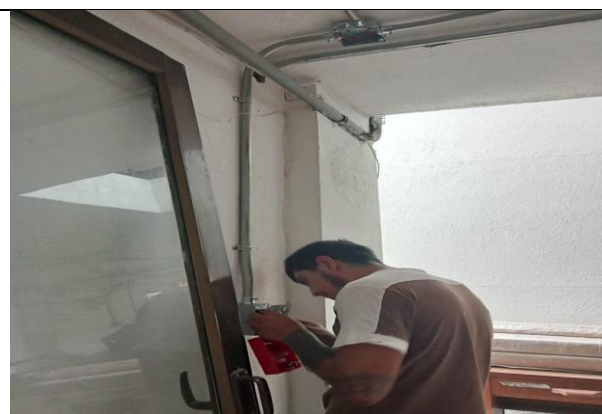
Instalación cable alarma contra incendio
