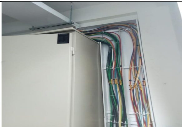
Instalación de acometidas de tableros de distribución
