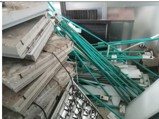
Desmante de lamparas y tuberia pvc existente
