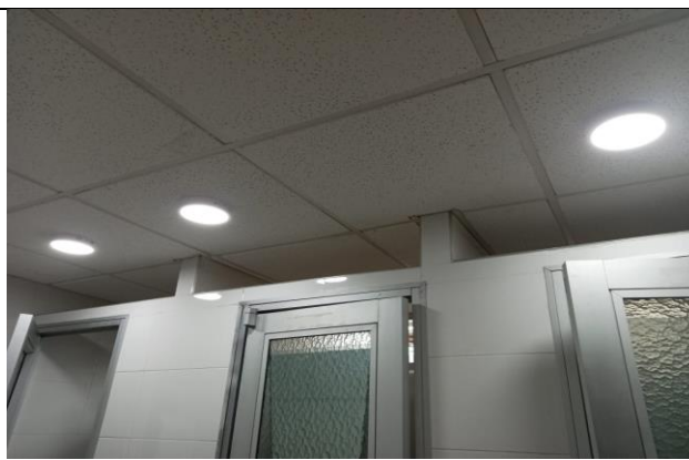
Instalación luminaria Led de 12W
