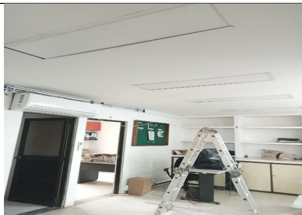
Instalación luminaria panel Led de 40W
