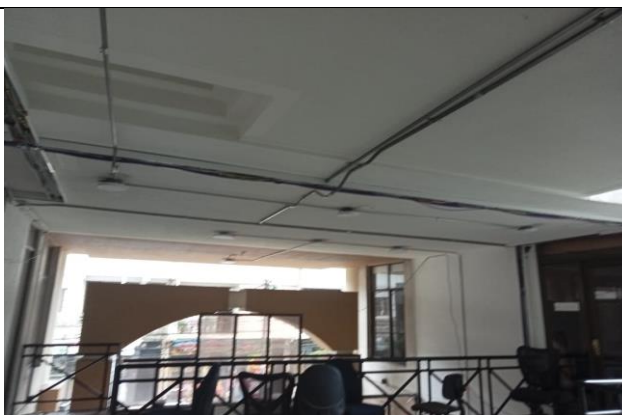
Instalación luminaria led de 18W
