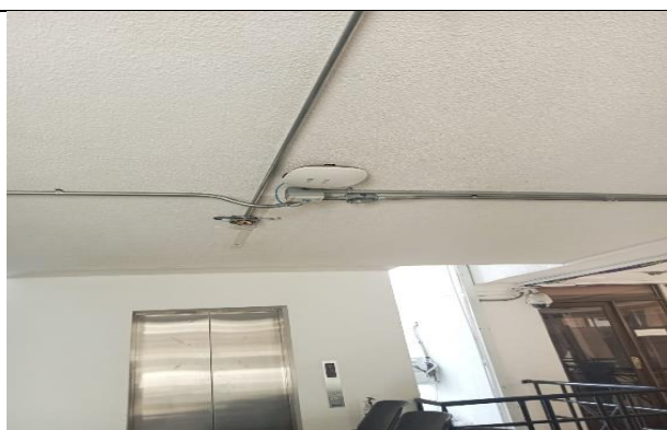
Instalación detector de humo
