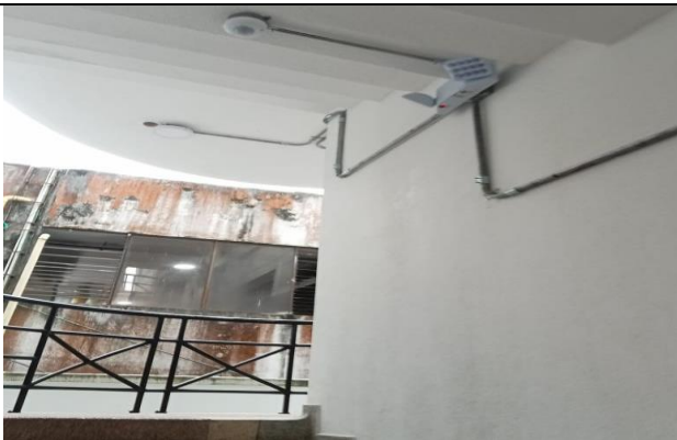
Instalación luminaria de emergencia
