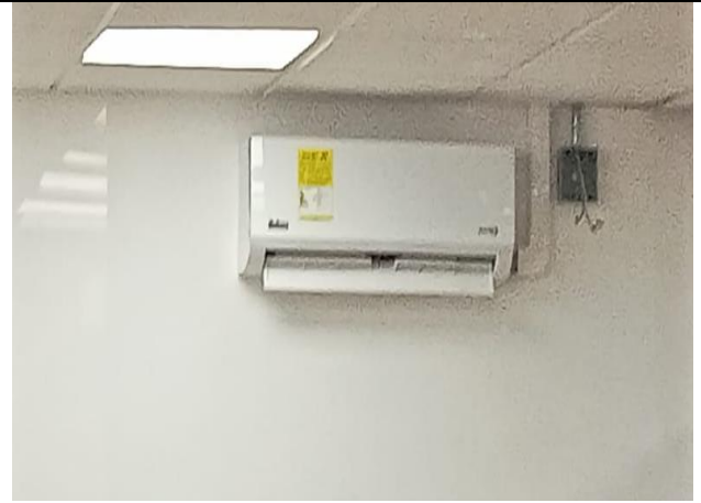
Instalación punto toma aire acondicionado
