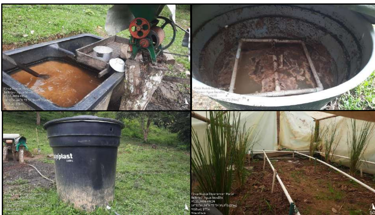
Fotografía 89. Componentes filtros verdes de la finca Nueva Esperanza
