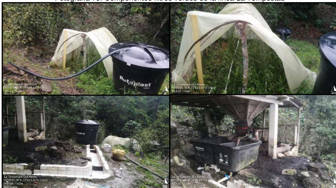
Fotografía 79. Componentes filtros verdes de la finca La Tempestad
