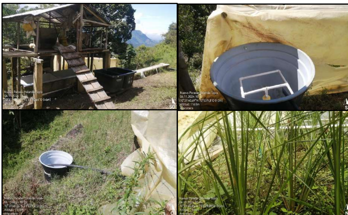
Fotografía 91. Componentes filtros verdes de la finca Nueva Parada
