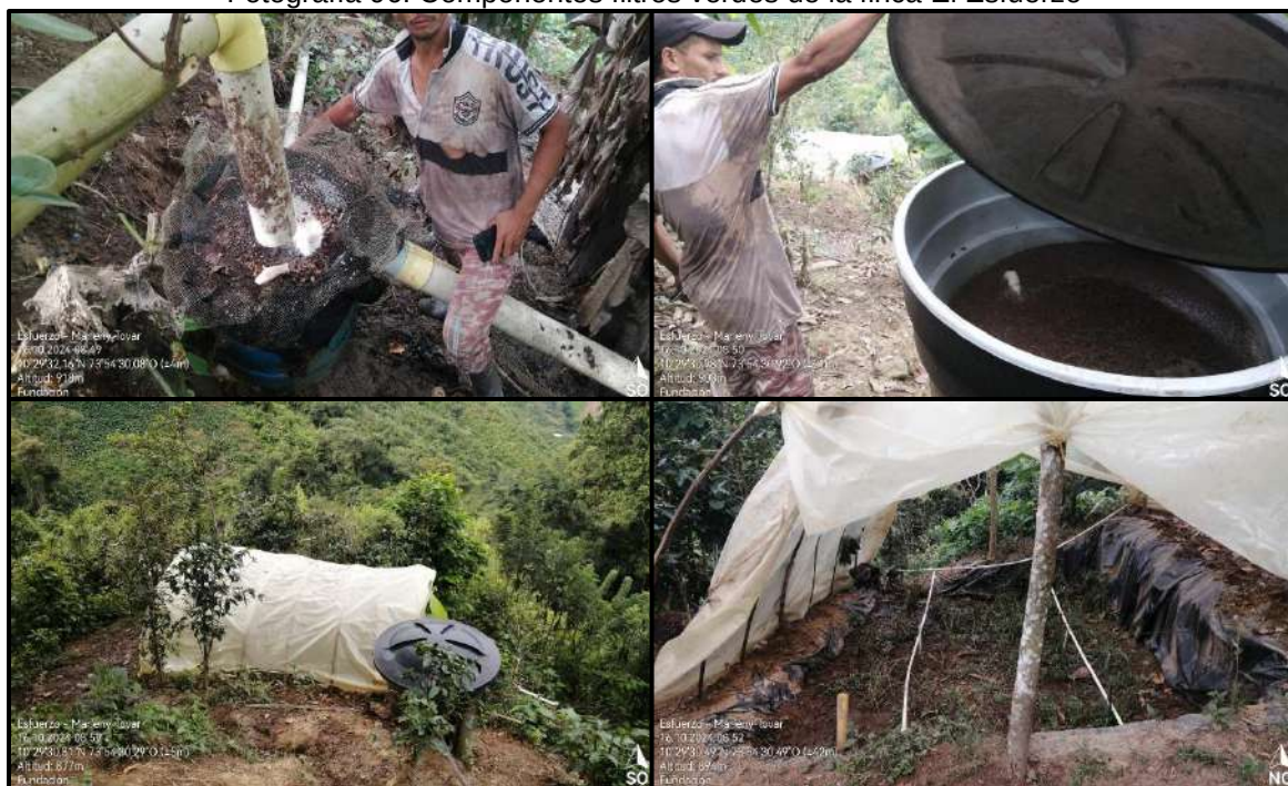
Fotografía 96. Componentes filtros verdes de la finca El Esfuerzo
