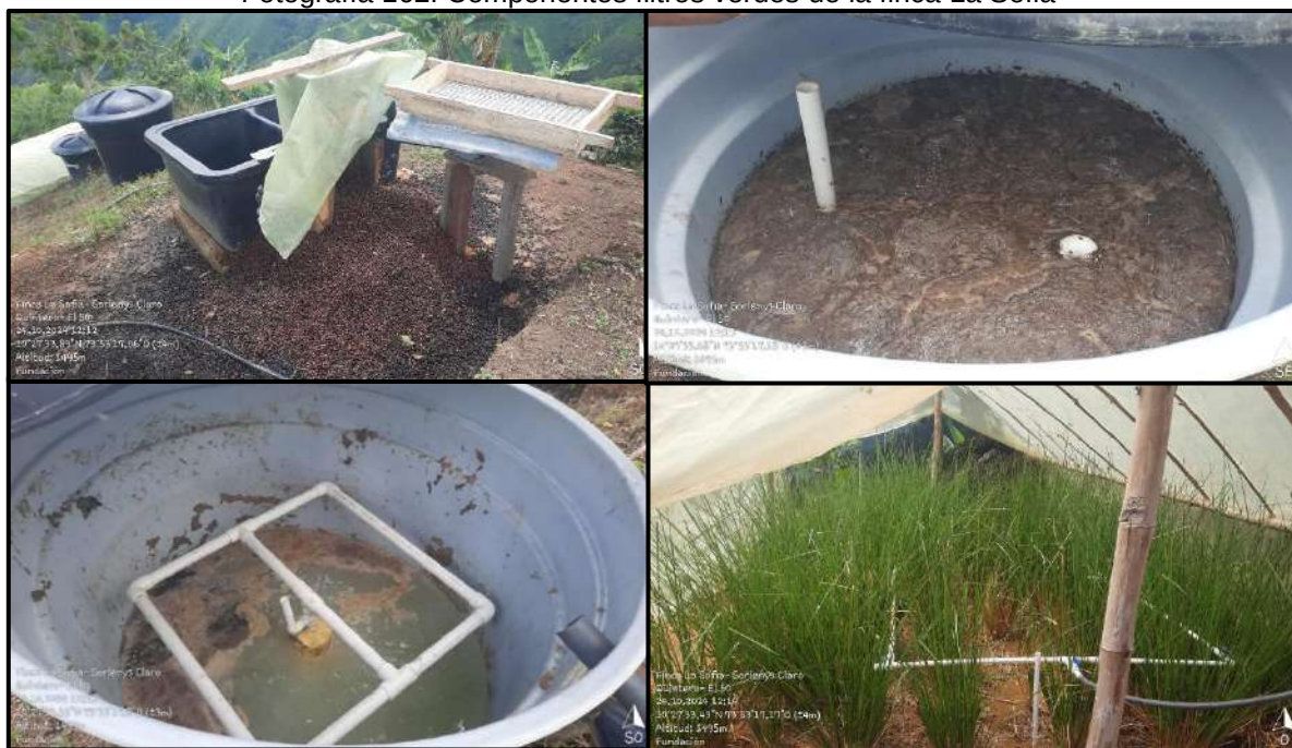
Fotografía 162. Componentes filtros verdes de la finca La Sofia
