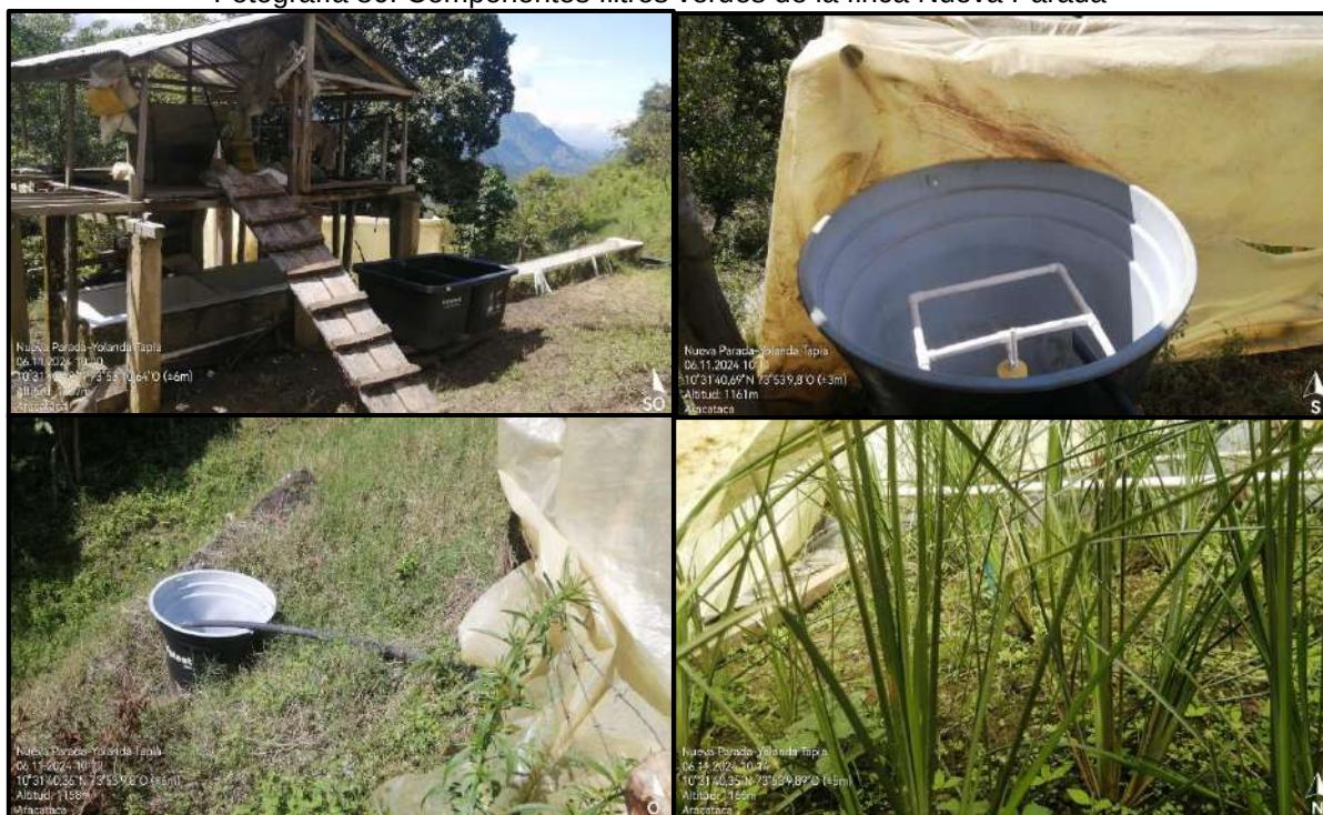
Fotografía 80. Componentes filtros verdes de la finca Nueva Parada
