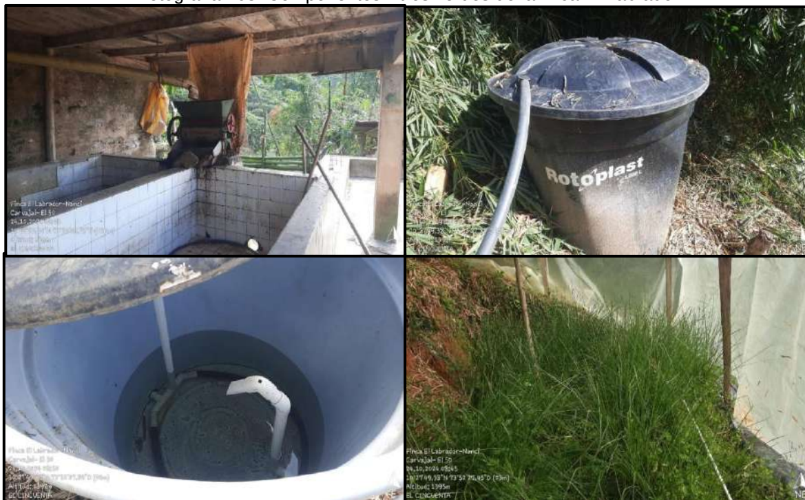
Fotografía 163. Componentes filtros verdes de la finca El Labrador
